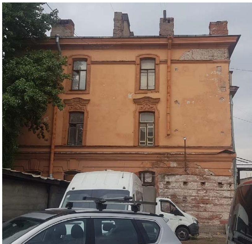
Фото 10. Южный фасад здания.
