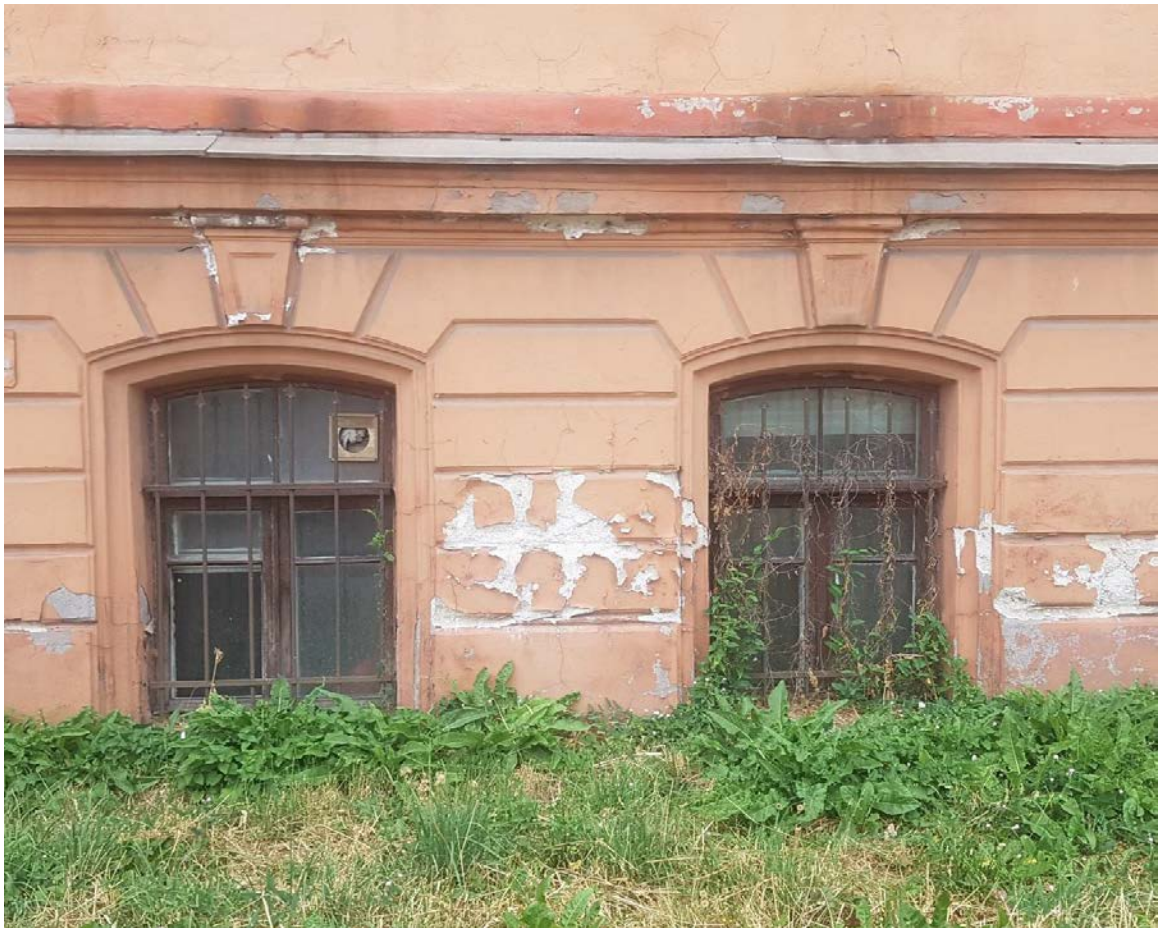
Фото 5. Лицевой фасад памятника. Оформление окон цокольного этажа.
