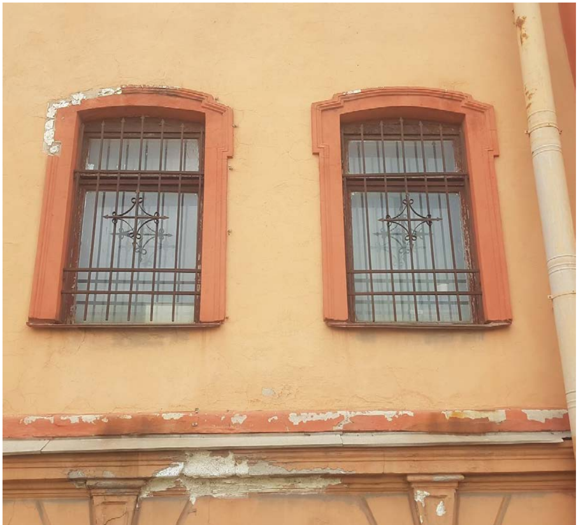
Фото 4. Лицевой фасад памятника. Оформление окон 2-го этажа.
