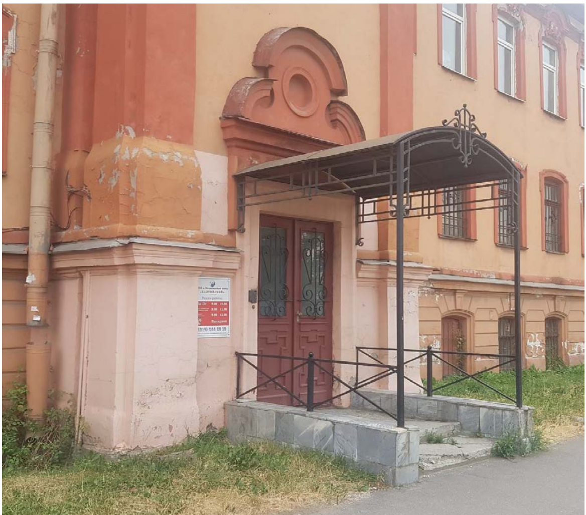
Фото 2. Лицевой фасад памятника. Крыльцо по центральной оси здания.
