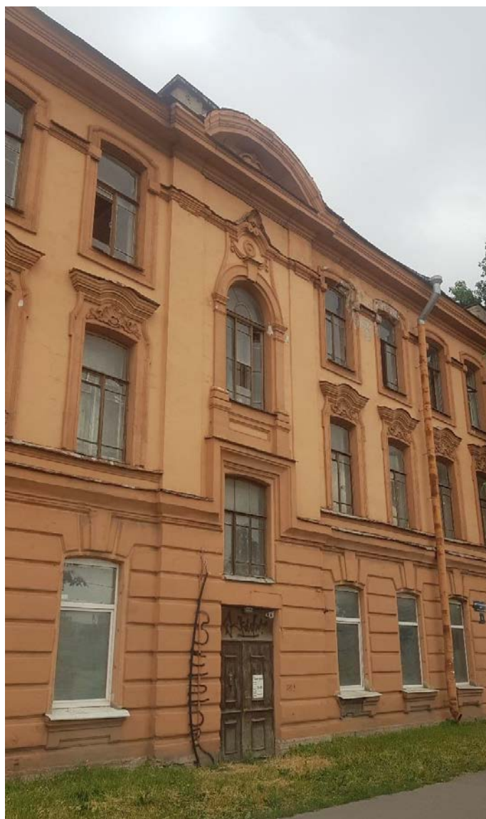
Фото 2. Лицевой фасад памятника. Ризалит по центральной оси.
