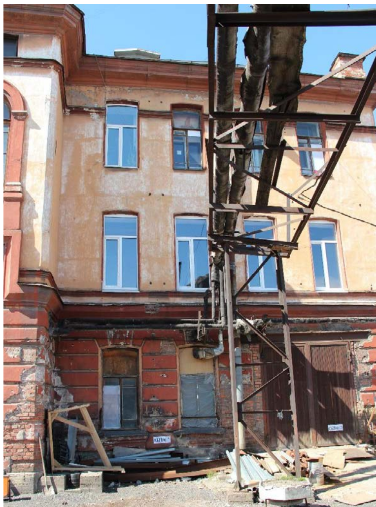
Фото 9. Правое крыло здания со стороны двора.
