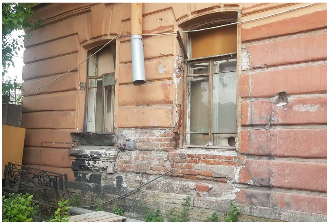
Фото 12. Южный фасад здания. Оформление окон 1-го этажа.
