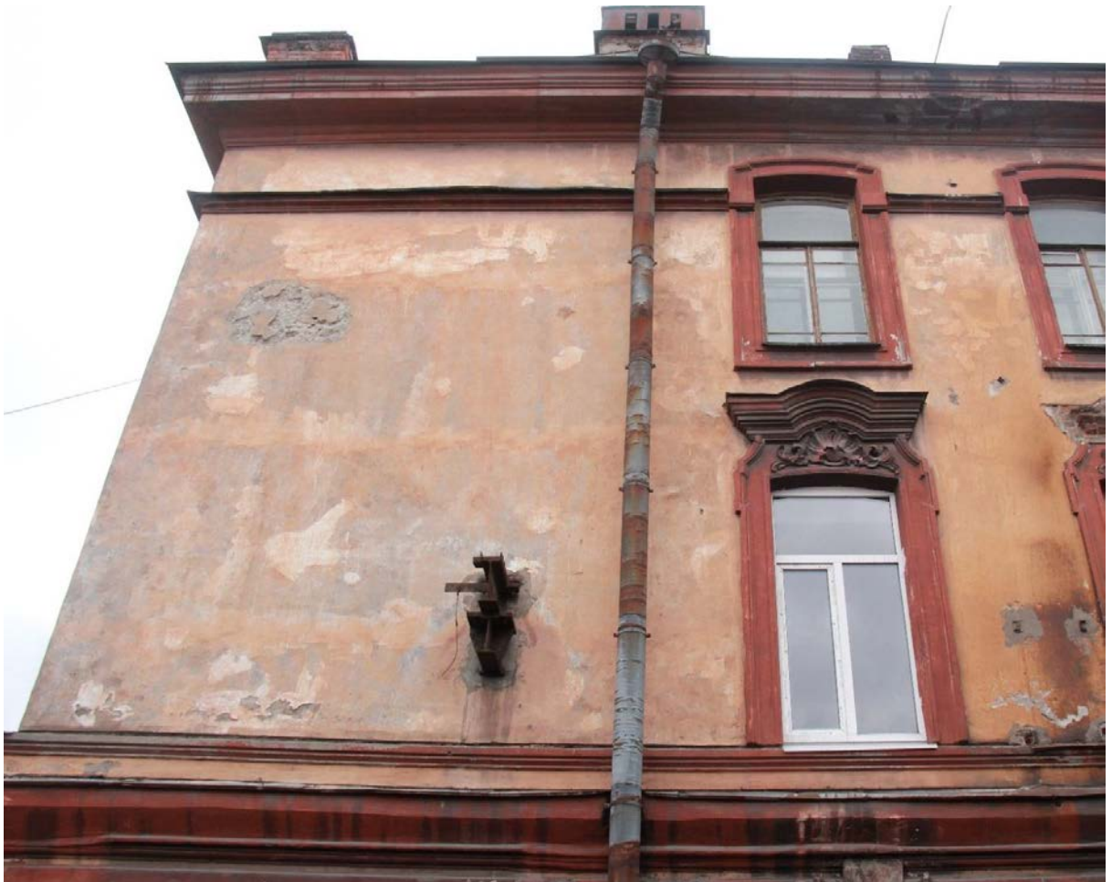
Фото 13. Северный фасад здания. Второй и третий этажи.
