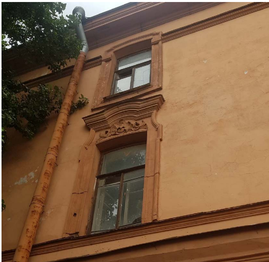
Фото 11. Южный фасад здания. Оформление окон 2-го и 3-го этажа.
