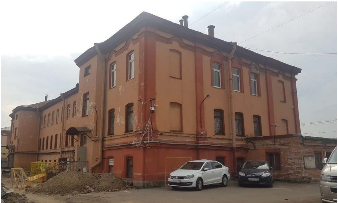
Фото 6. Северный и западный фасады памятника.
