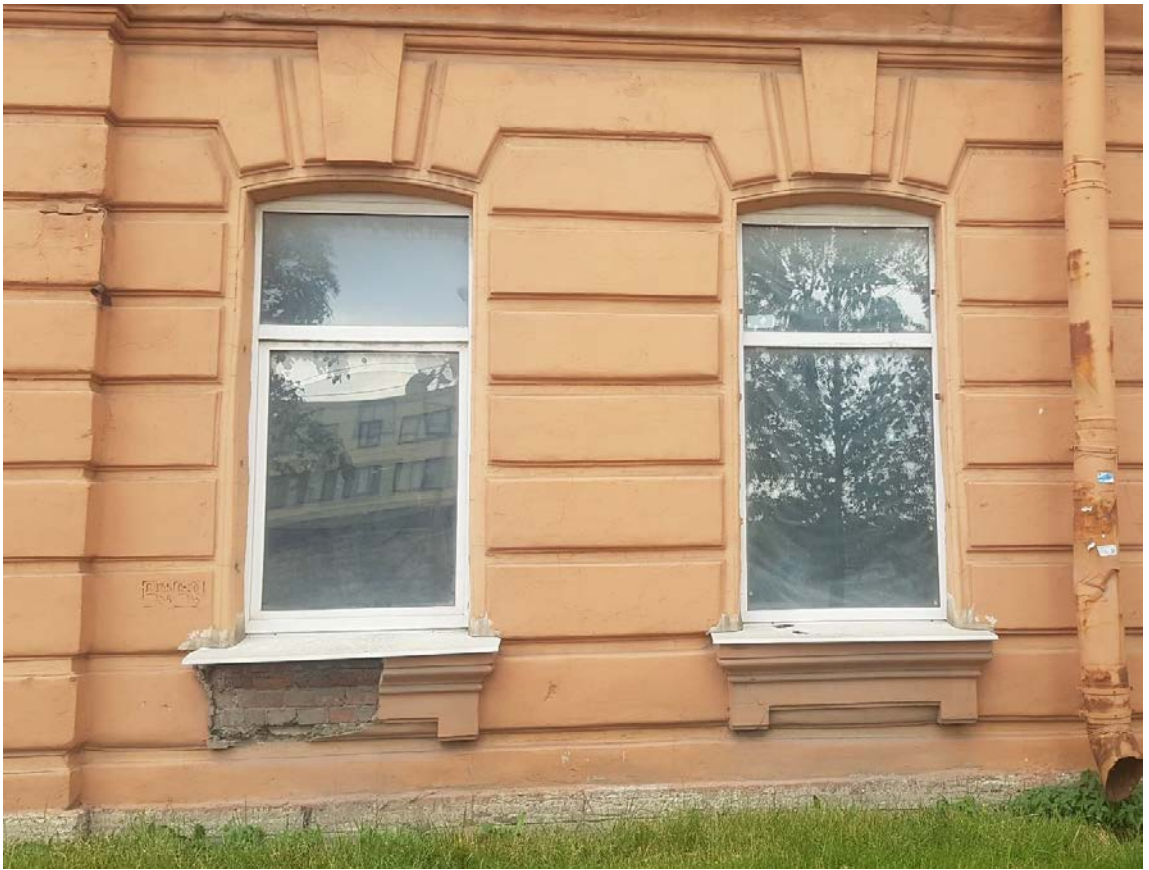
Фото 3. Лицевой фасад памятника. Оформление окон 1-го этажа.
