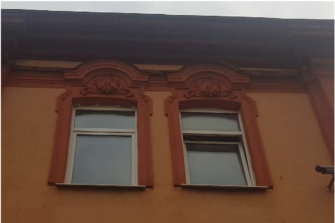
Фото 3. Лицевой фасад памятника. Оформление окон 3-го этажа.
