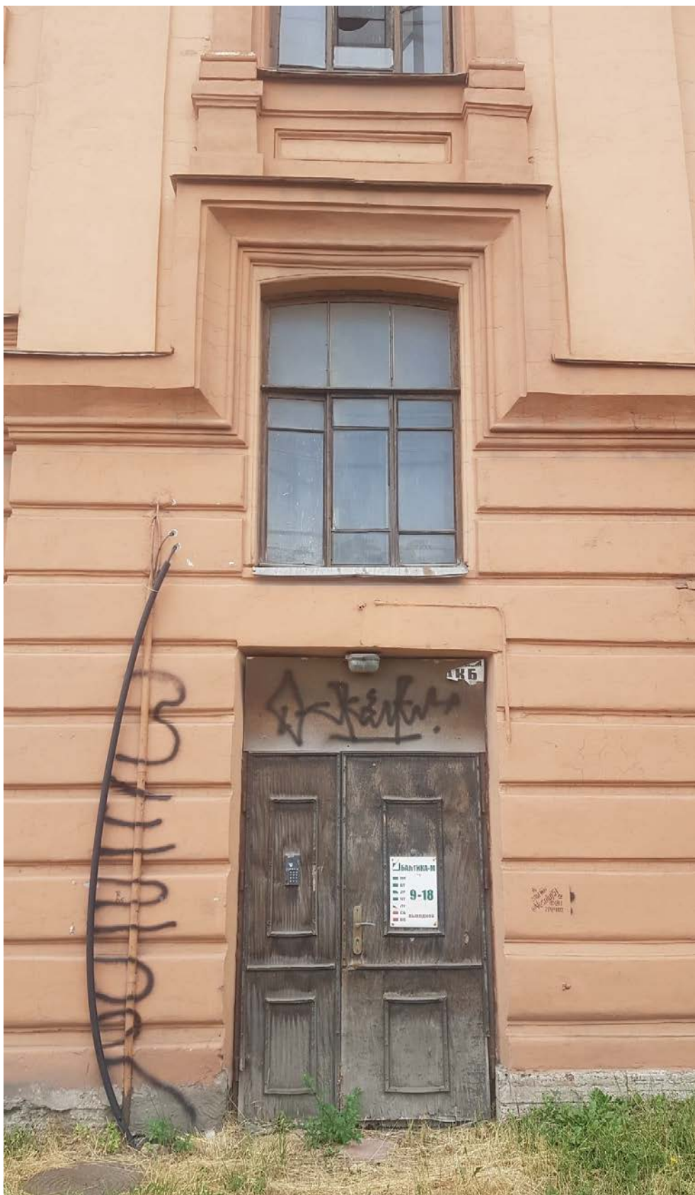
Фото 5. Лицевой фасад памятника. Дверное и оконное заполнения в ризалите.
