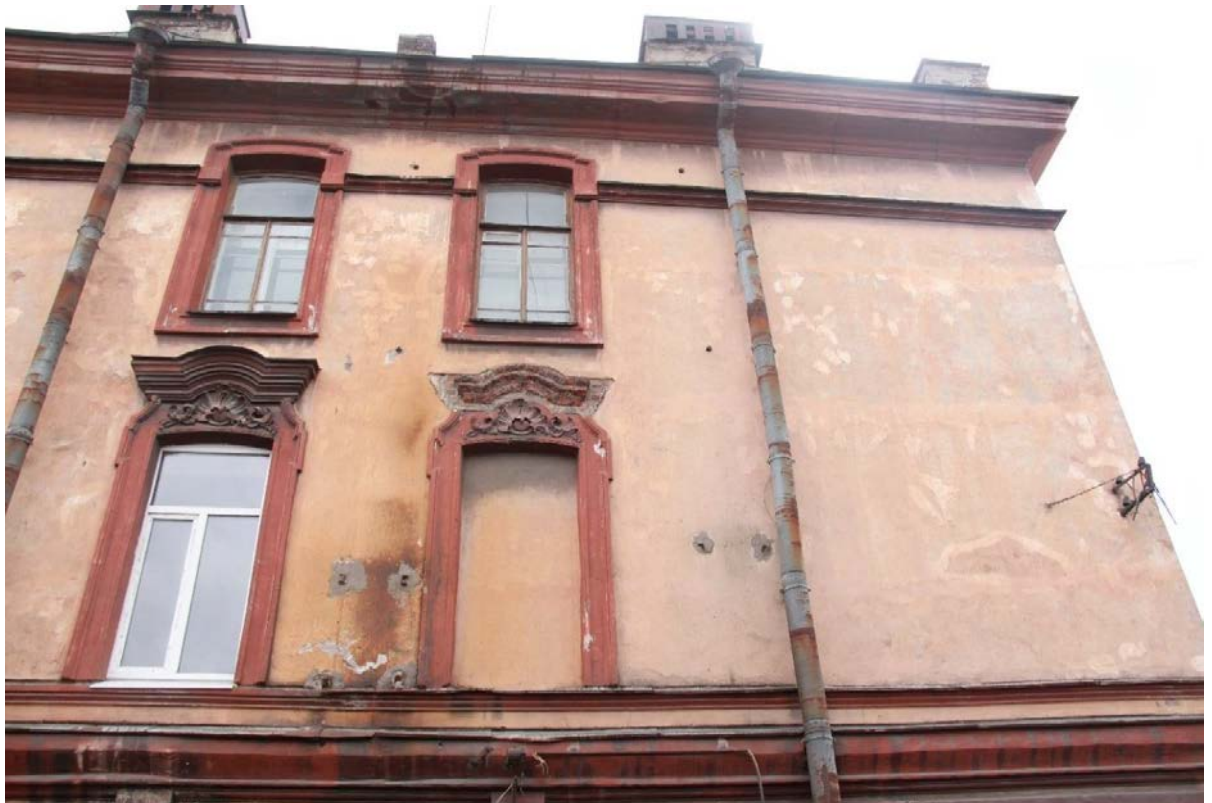
Фото 14. Северный фасад здания. Второй и третий этажи.
