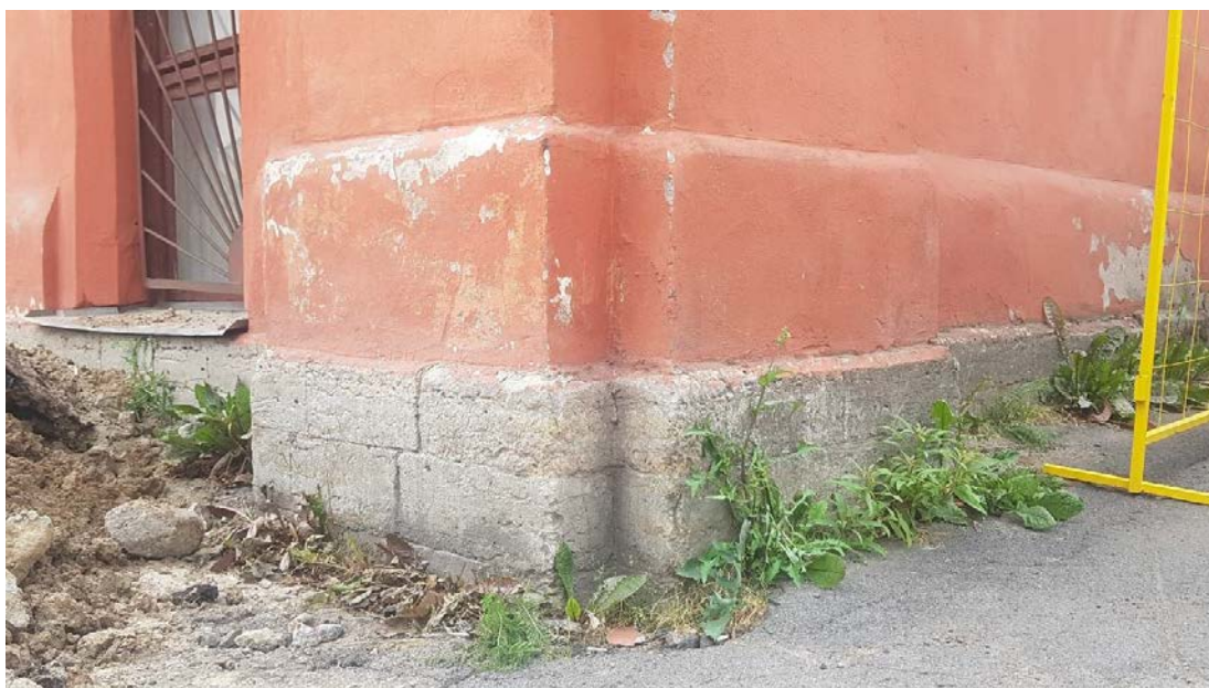
Фото 12. Дворовой и северный фасады. Цоколь.
