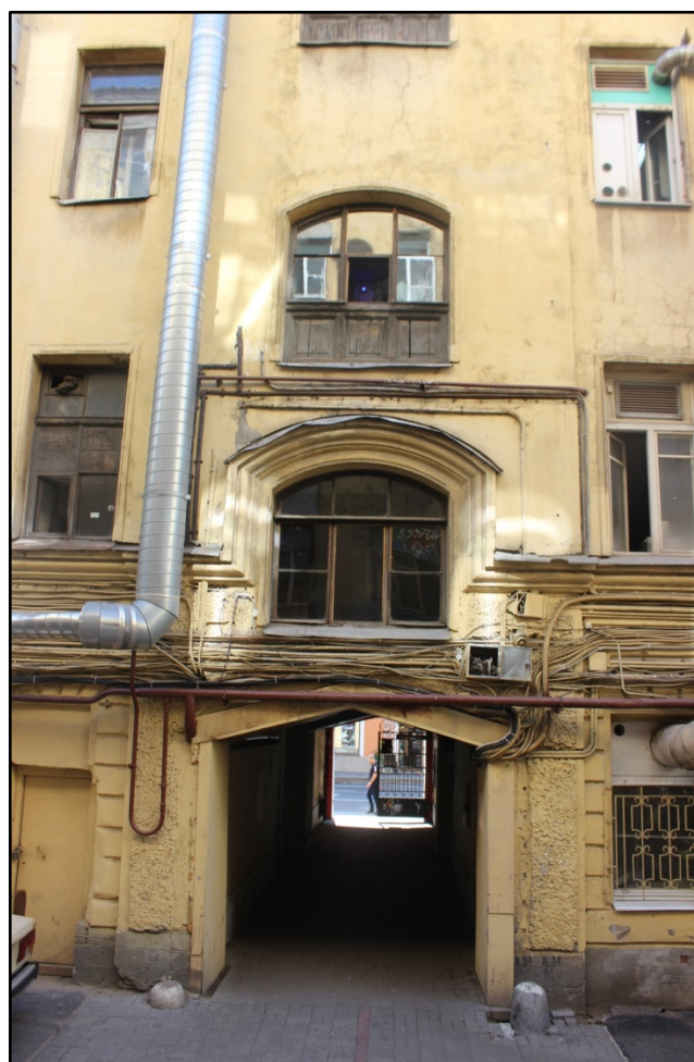
9. Здание по адресу: СПб, Загородный пр., д. 9 Лит. А. Вид дворового фасада со стороны двора.
