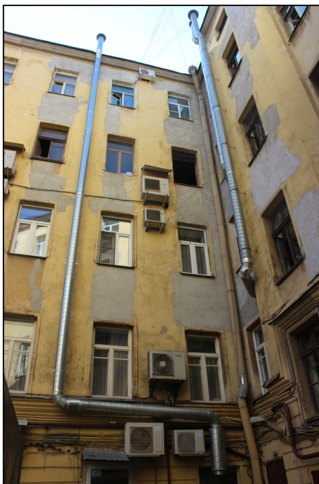
12. Здание по адресу: СПб, Загородный пр., д. 9 Лит. А. Вид дворового фасада со стороны двора.
