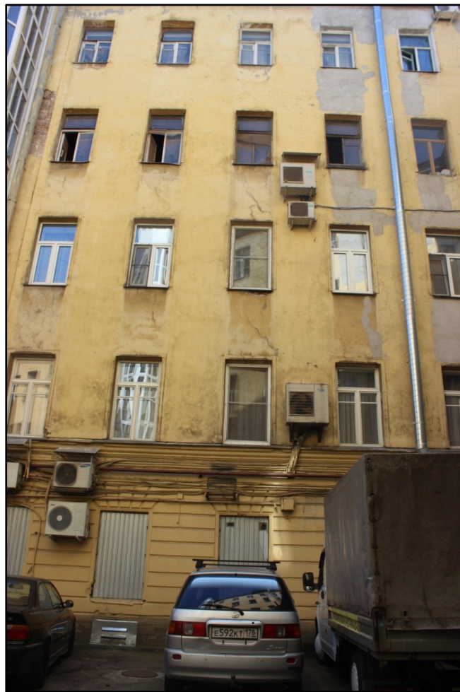
14. Здание по адресу: СПб, Загородный пр., д. 9 Лит. А. Вид дворового фасада со стороны двора.
