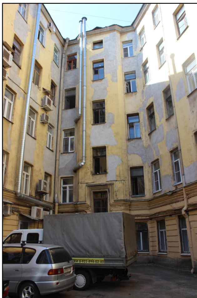
13. Здание по адресу: СПб, Загородный пр., д. 9 Лит. А. Вид дворового фасада со стороны двора.
