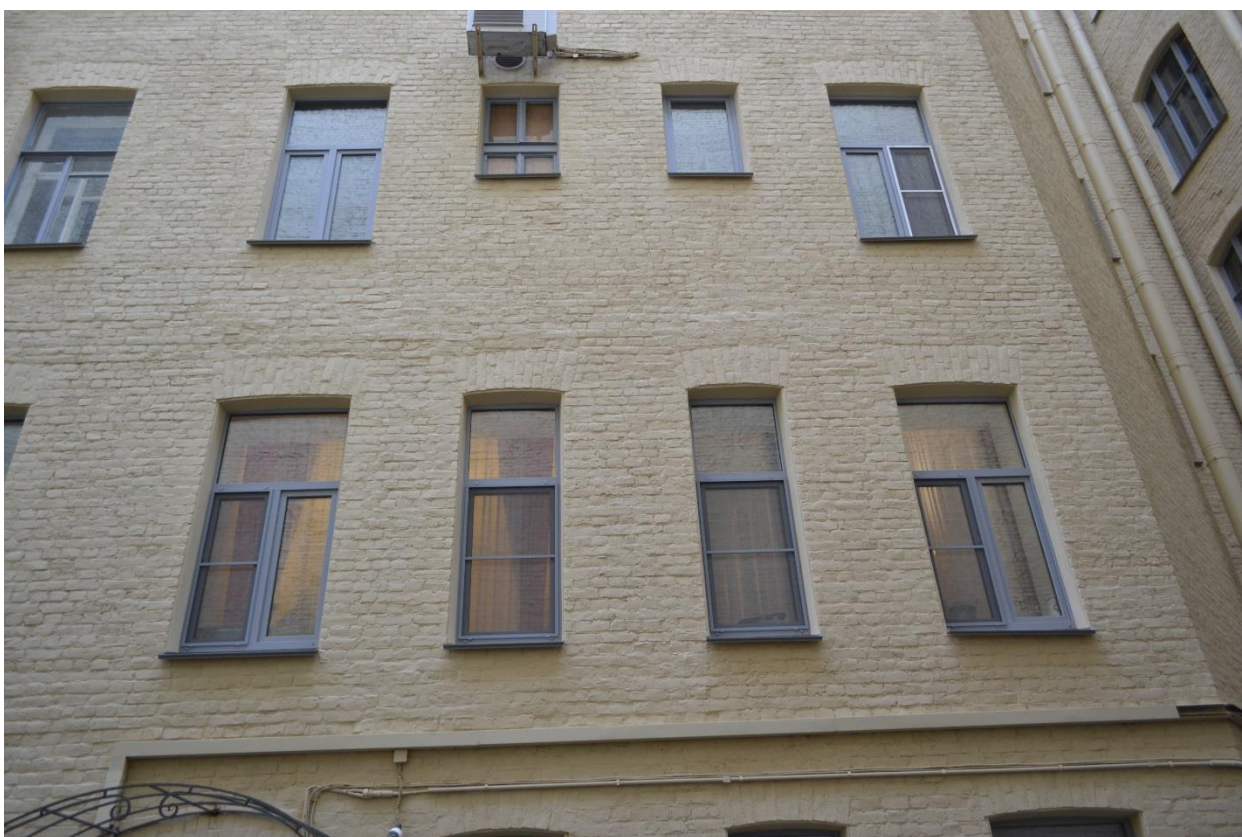
Фото 5. Окна квартиры №33 на юго-западном дворовом фасаде. Вид с юго-запада.
