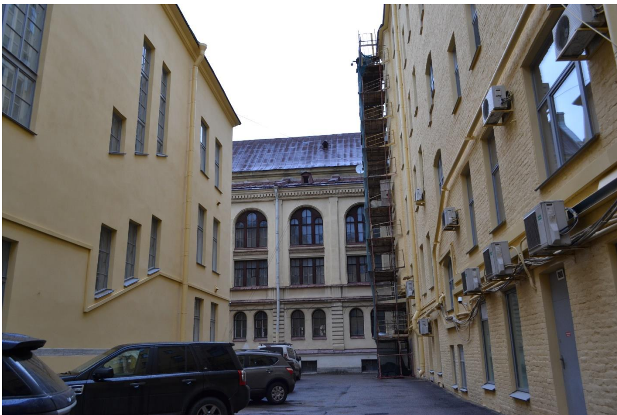
Фото 3. Пространство северного двора. Вид с юго-запада.
