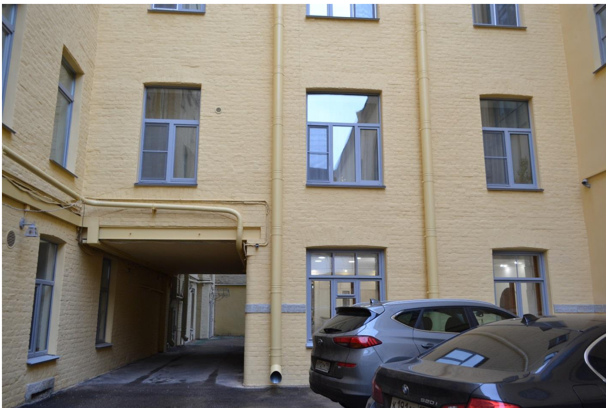
Фото 2. Северо-восточный фасад. Вид с северо-востока.
