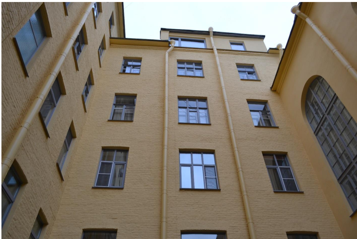
Фото 1. Северо-восточный фасад. Вид с северо-востока.
