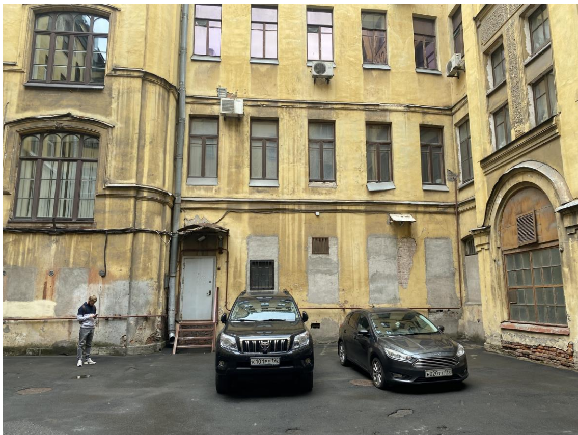
5. Фрагмент дворового фасада.
