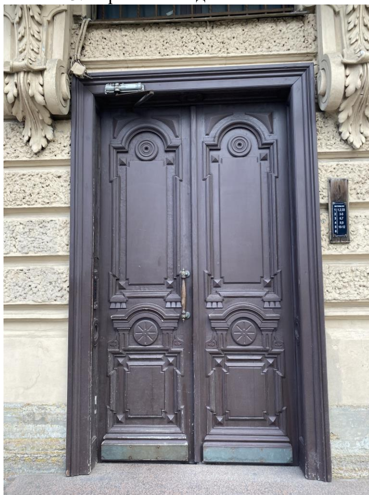
4. Главные входные двери.
