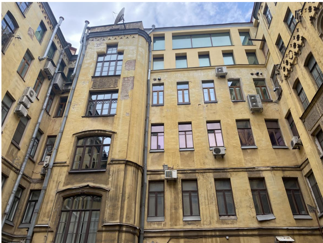
8. Фрагмент дворового фасада.
