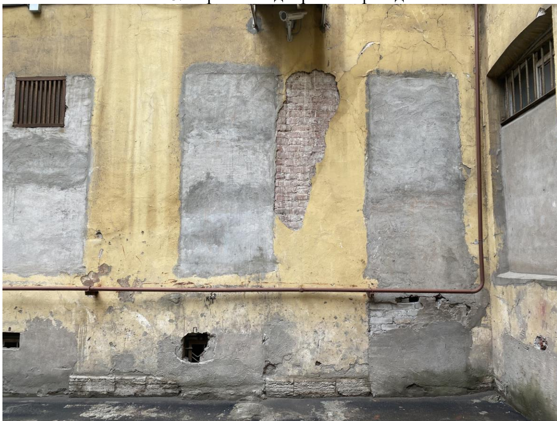
9. Фрагмент дворового фасада.
