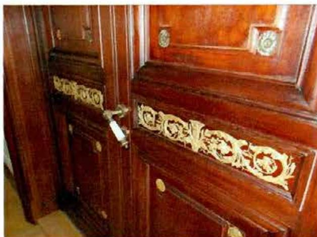
заполнение проемов – материал (дуб), конструкция (двери двустворчатые), оформление со стороны зала (профилированные филенки, по три на каждом полотне, разного размера; верхние и нижние – с «выпуклыми» углами, с латунными розетками; центральные – с накладными композициями в виде акантовых волют с виноградными гроздьями (?) и цветами и факела в центре;
