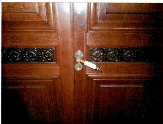
оформление дверных заполнений – профилированные филленки, по три на каждой створке, разных размеров, центральные – с резными фризами из розетт;
