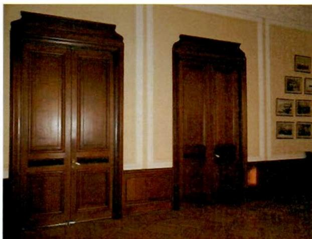
исторические дверные проемы – местоположение (по южной стене – к приемной и пом. № 3, по западной – к парадной лестнице, по восточной – к пом. № 12), габариты, конфигурация (прямоугольные), оформление (профилированные наличники с десюдепортами в виде фризов с линейным сандриком, фланкированных волпатами);
