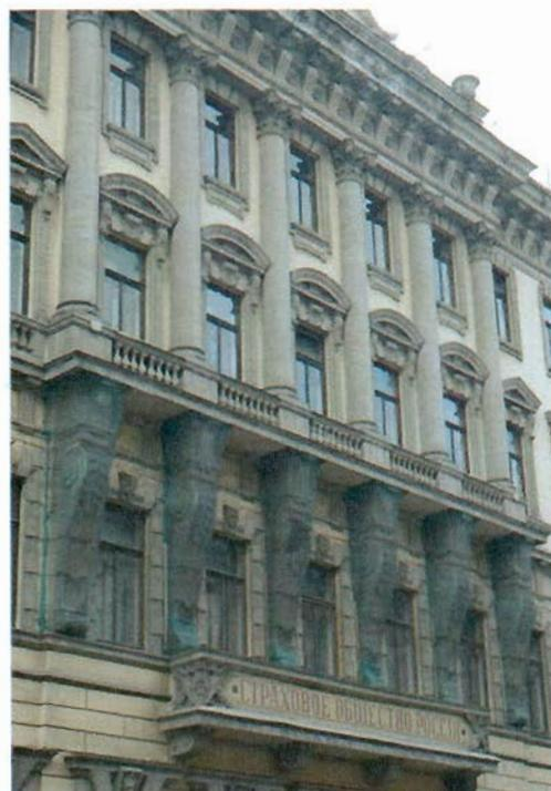
парапетные тумбы ограждения; капители поддерживают антаблемент: стилизованный триглифо-метопный фриз в виде цветочных розеток и каннелированных консолей, которые поддерживают акантовые кронштейны профилированного карниза с порезкой иоников; профилированный край карниза, декорирован горельефными львиными маскаронами (является раскреповкой венчающего карниза всего фасада);
