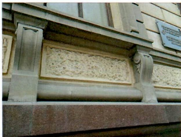
профилированный раскрепованный венчающий карниз, решенный в виде антаблемента: стилизованный триглифо-метопный фриз в виде цветочных розеток и канелированных консолей, которые поддерживают акантовые кронштейны профилированного карниза с порезкой иоников; профилированный край карниза, декорирован горельефными львиными маскаронами;
