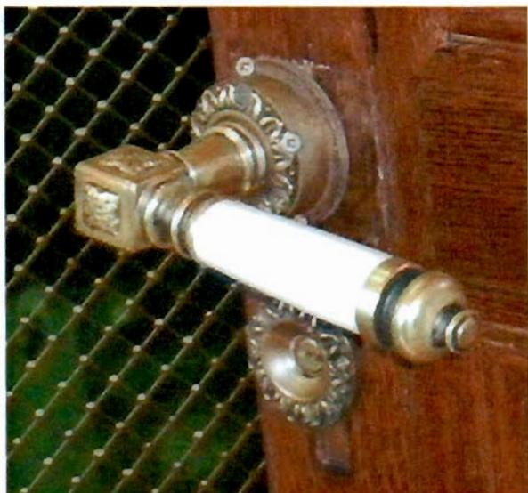
оформление проема по северной стене – профилированные филенки, две на полотне; откосы – обшиты деревянными филенчатыми панелями; приборы дверные – ручка-фаль, латунная в виде изогнутого завитка, завершеного овалом; ключевина латунная, круглая, без орнамента; время: кон. XIX–нач. XX в.; размер: длина – 13 см;
