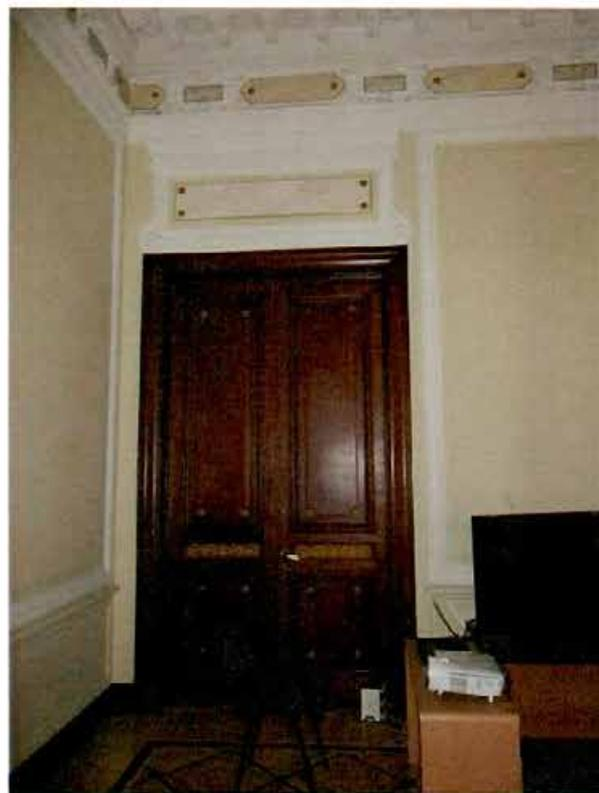
исторические дверные проемы (4) – местоположение (по северной стене – в пом. № 12 (коридор), по восточной стене – к пом. № 3, по западной стене – к пом. № 6), габариты, конфигурация (прямоугольные), оформление (профилированные дубовые наличники; в десюдепортах лепные панно, фланкированные акантовыми волютами, увенчанные линейными орнаментированными сандриками; в центральных частях композиций прямоугольные вставки искусственного мрамора, закрепленных латунными розетками);
