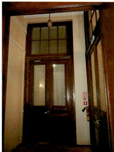
к 4-ЛК – конструкция (двери двустворчатые, с боковыми нестворными частями, полусветлые, с остекленной фрамугой, с геометрической расстекловкой, с коробовым завершением);
