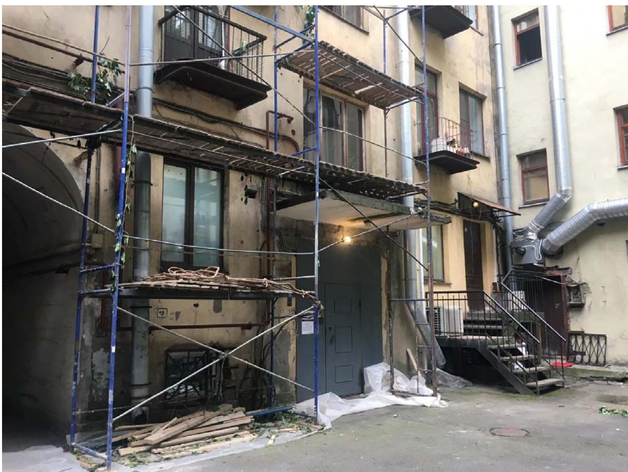
**Фото №15.** Дворовой фасад. Справа поздние металлические конструкции крыльца, ведущие к входу, устроенному на месте исторического оконного проема.
