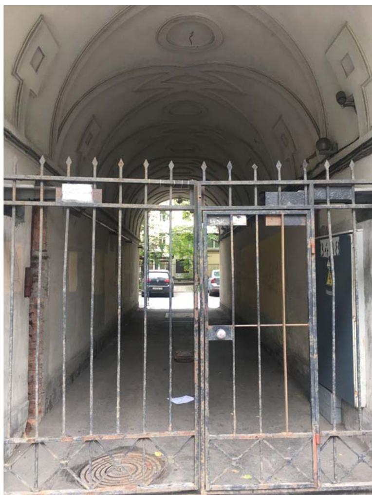
**Фото №21.** Позднее металлическое заполнение воротного проезда.
