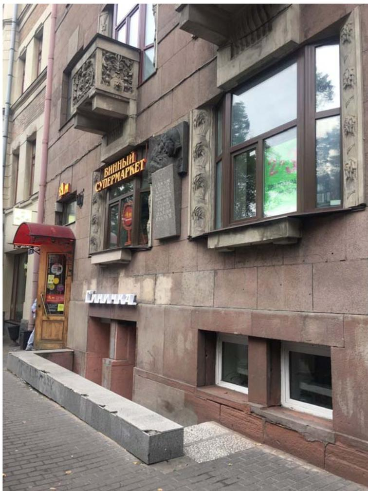
**Фото №5.** Лицевой (северо-восточный) фасад по Каменноостровскому проспекту, поздний прямик. На месте двух оконных проемов подвала устроено два дверных.
