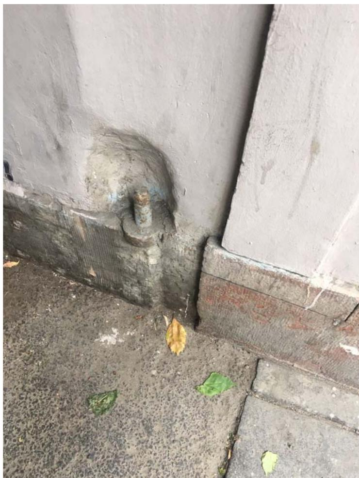
**Фото №13.** Воротный проезд, исторические конструкции для крепления створок воротных заполнений.
