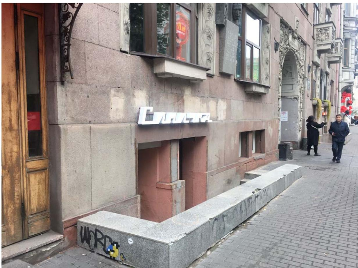
**Фото №6.** Лицевой (северо-восточный) фасад по Каменноостровскому проспекту, поздний приемок. На месте двух оконных проемов подвала устроено два дверных.
