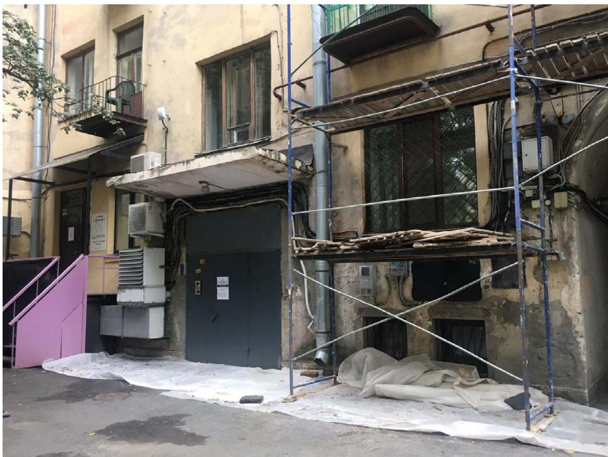
**Фото №14.** Дворовой фасад. Слева поздние металлические конструкции крыльца, ведущие к входу, устроенному на месте исторического оконного проема. Исторический бетонный козырек.
