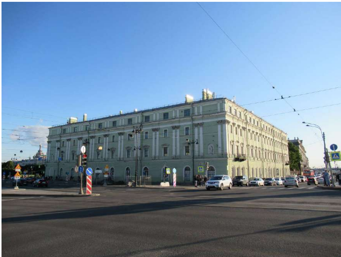
Илл. 09. Объект культурного наследия федерального значения «Корпус служебный». Вид с Дворцовой наб. с восточной стороны. Съемка 05.07.2021 г. Трушковский В. Э.
