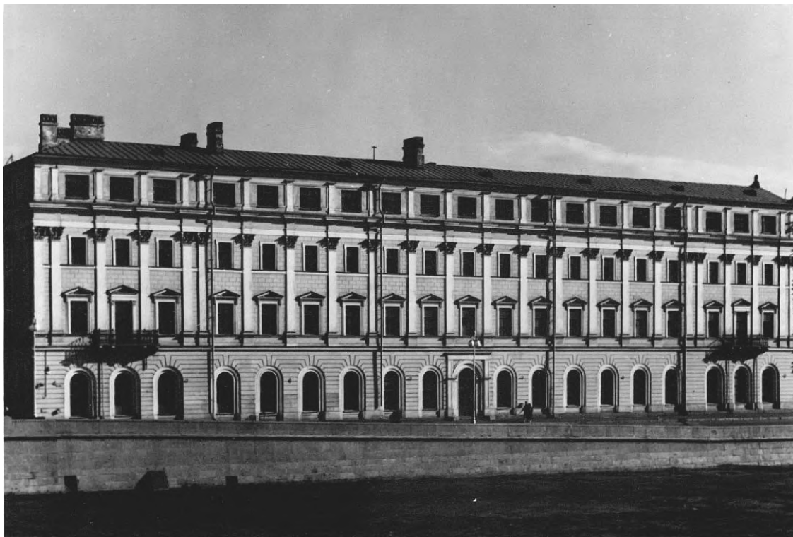
Илл. 29. Служебный корпус Мраморного дворца. Северный фасад со стороны р. Невы. 1953 г. КГИОП. 3.2.(4.1.) – 1.29.1.
