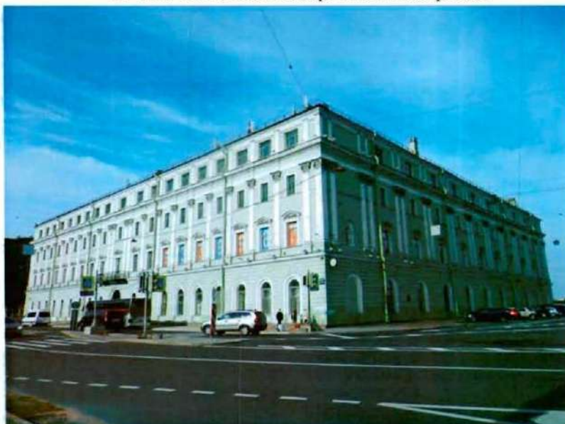
2. Юго-восточный и северо-восточный фасады
