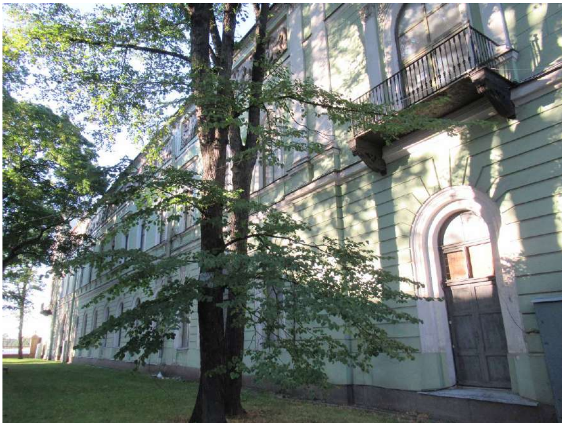
Илл. 05. Объект культурного наследия федерального значения «Корпус служебный». Западный лицевой фасад. Съемка 05.07.2021 г. Трушковский В. Э.
