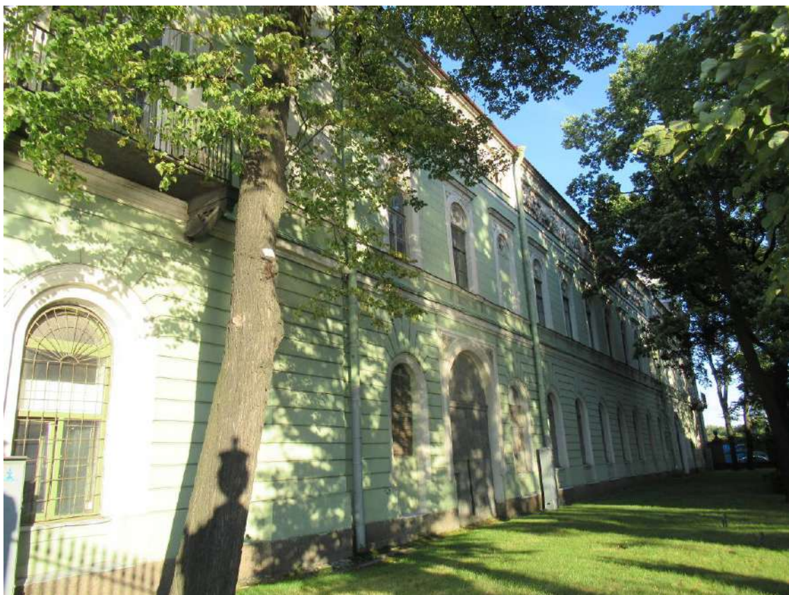
Илл. 06. Объект культурного наследия федерального значения «Корпус служебный». Западный лицевой фасад. Съемка 05.07.2021 г. Трушковский В. Э.
