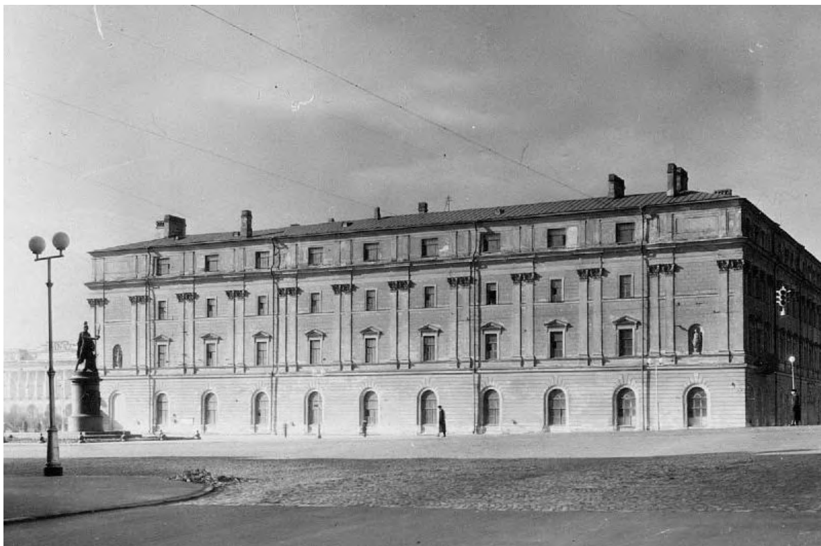
Илл. 27. Служебный корпус Мраморного дворца. Восточный фасад со стороны Суворовской площади. 1952 г. КГИОП. 3.2.(4.1.) – 1.29.1.
