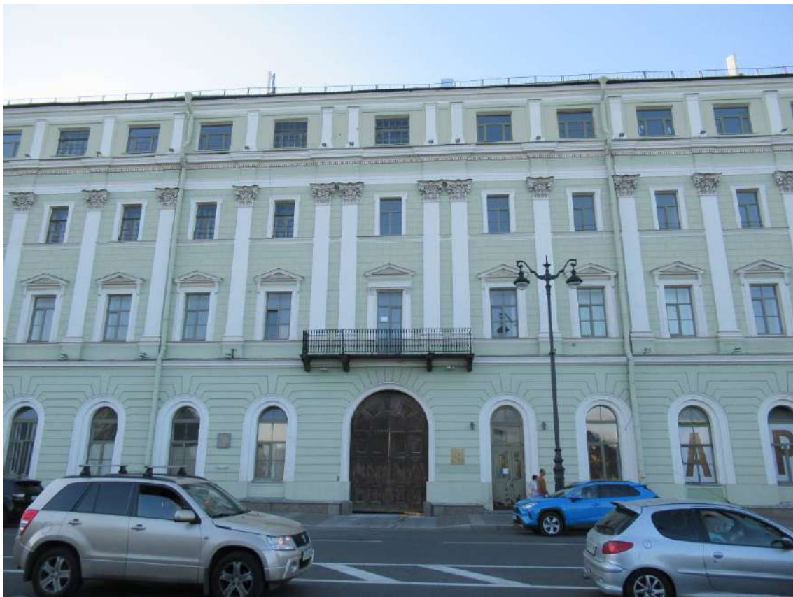
Илл. 03. Объект культурного наследия федерального значения «Корпус служебный». Лицевой фасад по Миллионной ул. Фрагмент. Съемка 05.07.2021 г. Трушковский В. Э.
