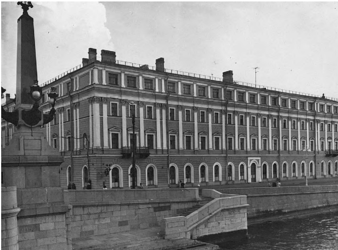
Илл. 31. Служебный корпус Мраморного дворца. Северный фасад со стороны р. Невы. 1968 г. КГИОП. 3.2.(4.1.) – 1.29.1.
