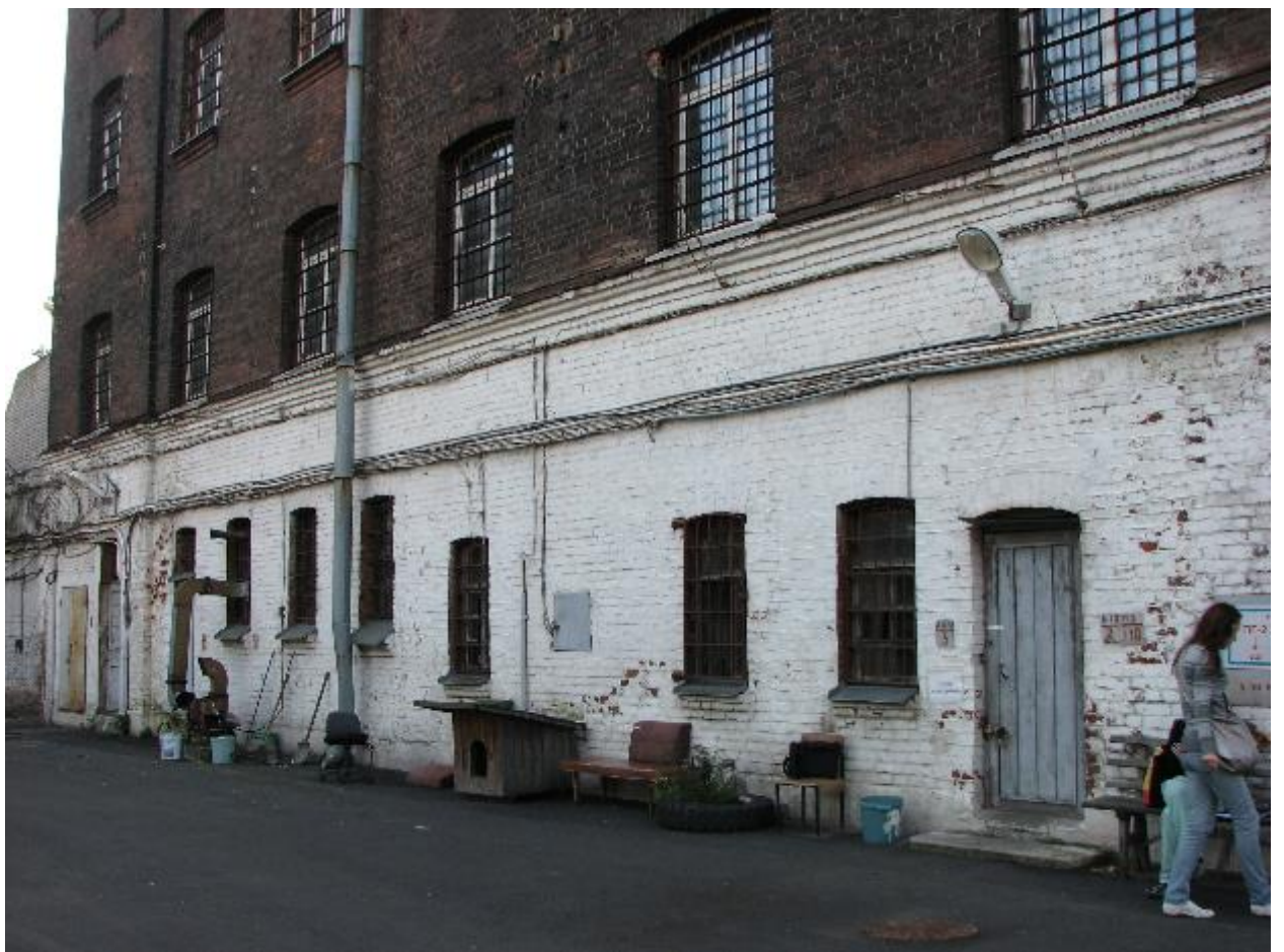
3. Северо-западный фасад выявленного объекта культурного наследия «Комплекс Санкт-Петербургской женской исправительной тюрьмы. Служительский корпус», расположенного по адресу: г. Санкт-Петербург, Арсенальная улица, дом 9, литера Д. Фрагмент. 24.08.2021.
