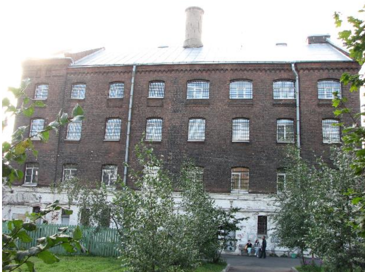
1. Северо-западный фасад выявленного объекта культурного наследия «Комплекс Санкт-Петербургской женской исправительной тюрьмы. Служительский корпус», расположенного по адресу: г. Санкт-Петербург, Арсенальная улица, дом 9, литера Д. 24.08.2021.
