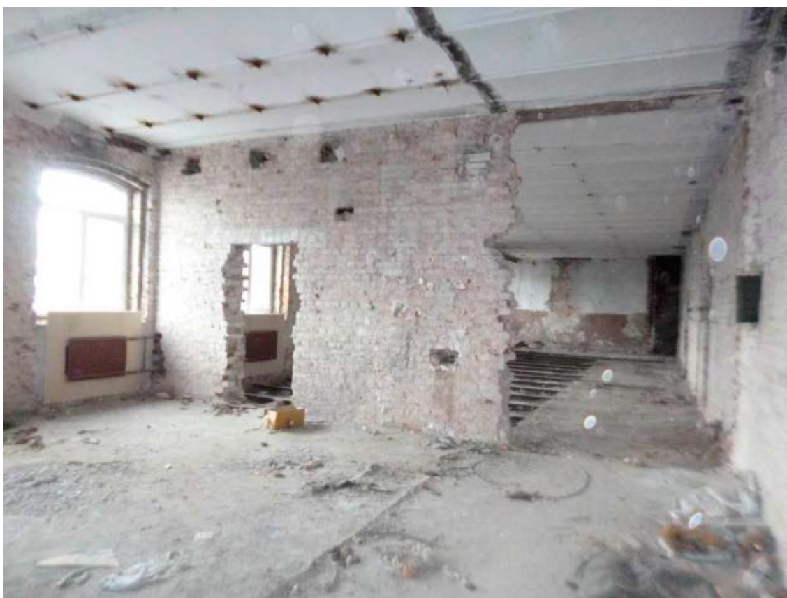
17. Помещение №2 в уровне 3-го этажа выявленного объекта культурного наследия «Комплекс Санкт-Петербургской женской исправительной тюрьмы. Служительский корпус», расположенного по адресу: г. Санкт-Петербург, Арсенальная улица, дом 9, литера Д. 24.08.2021.
