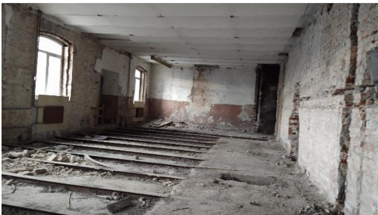
16. Помещение №2 в уровне 3-го этажа выявленного объекта культурного наследия «Комплекс Санкт-Петербургской женской исправительной тюрьмы. Служительский корпус», расположенного по адресу: г. Санкт-Петербург, Арсенальная улица, дом 9, литера Д. 24.08.2021.
