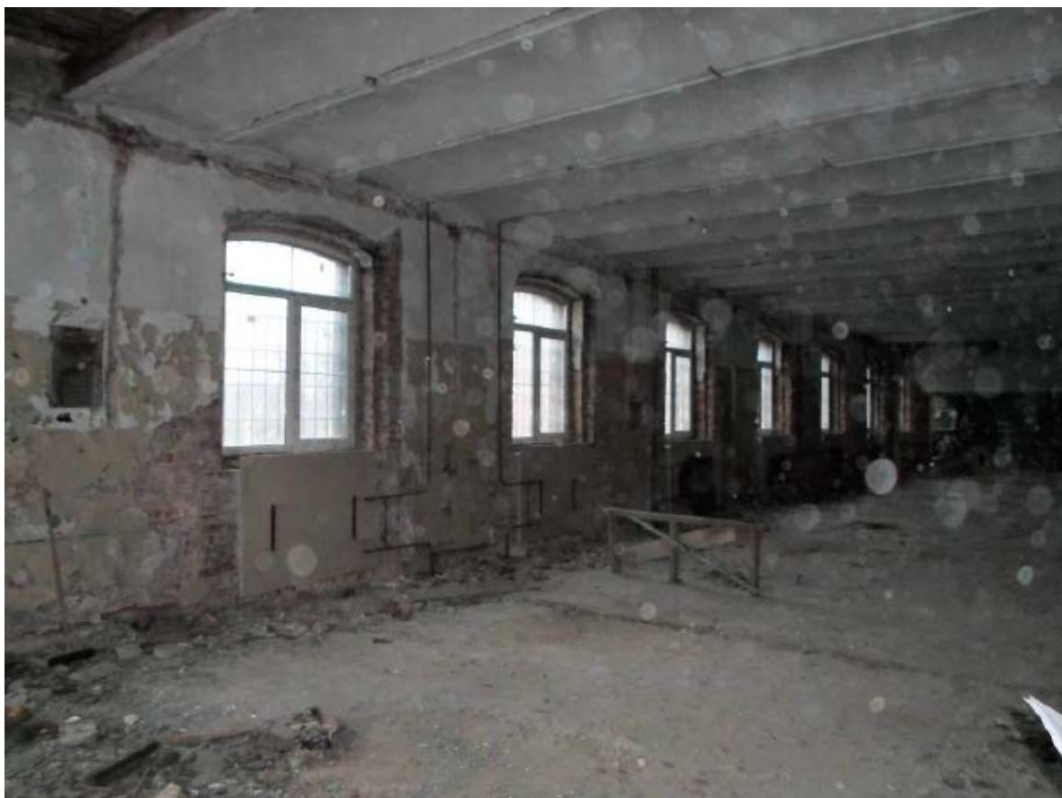
18. Помещение №3 в уровне 3-го этажа выявленного объекта культурного наследия «Комплекс Санкт-Петербургской женской исправительной тюрьмы. Служительский корпус», расположенного по адресу: г. Санкт-Петербург, Арсенальная улица, дом 9, литера Д. 24.08.2021.
