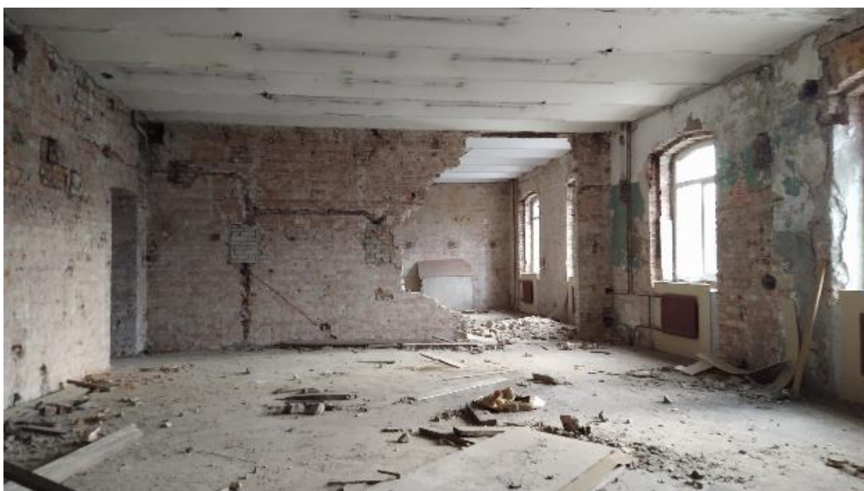
15. Помещение №3 в уровне 2-го этажа выявленного объекта культурного наследия «Комплекс Санкт-Петербургской женской исправительной тюрьмы. Служительский корпус», расположенного по адресу: г. Санкт-Петербург, Арсенальная улица, дом 9, литера Д. 24.08.2021.
