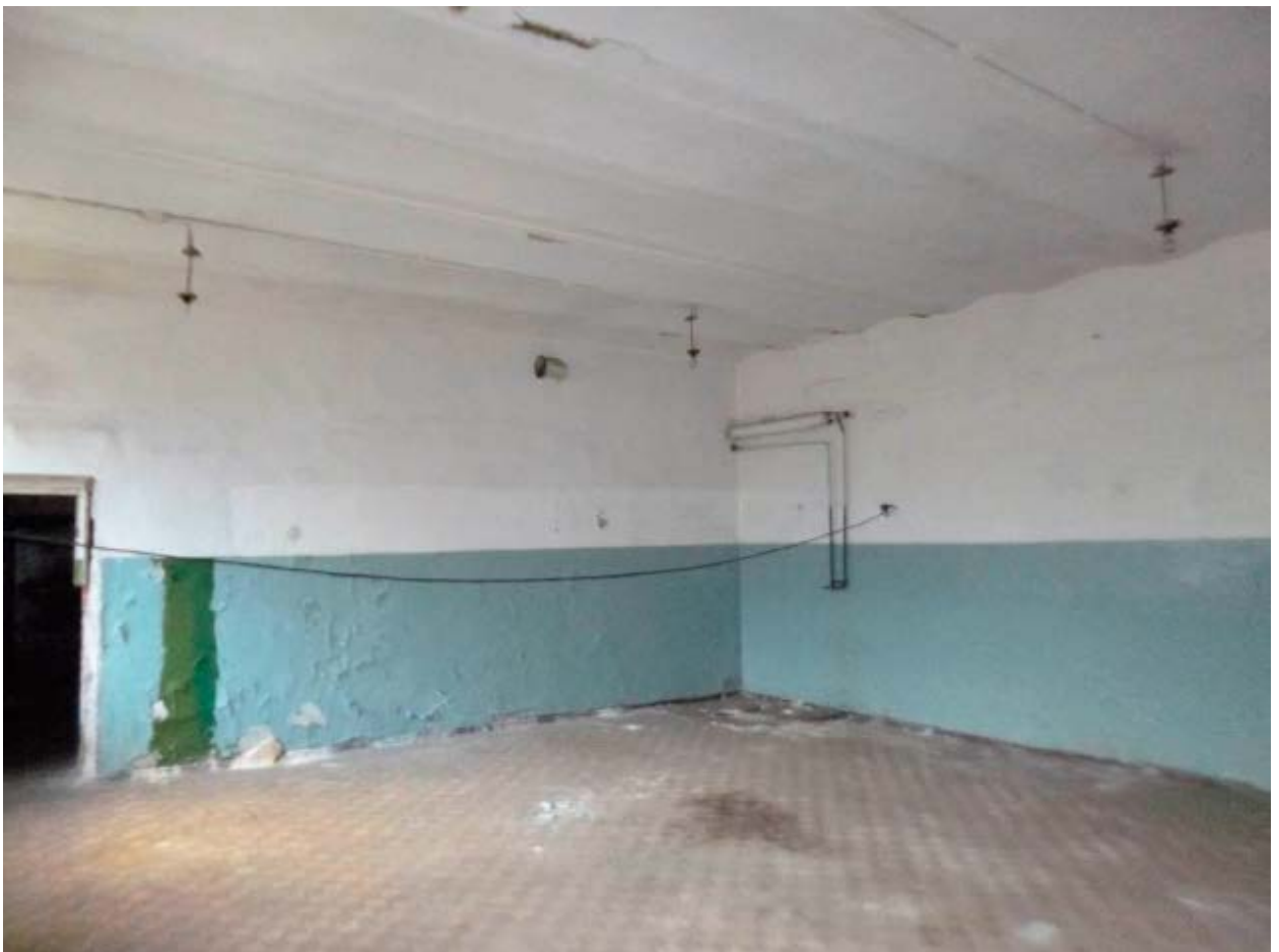
13. Помещение №6 в уровне 1-го этажа выявленного объекта культурного наследия «Комплекс Санкт-Петербургской женской исправительной тюрьмы. Служительский корпус», расположенного по адресу: г. Санкт-Петербург, Арсенальная улица, дом 9, литера Д. 24.08.2021.
