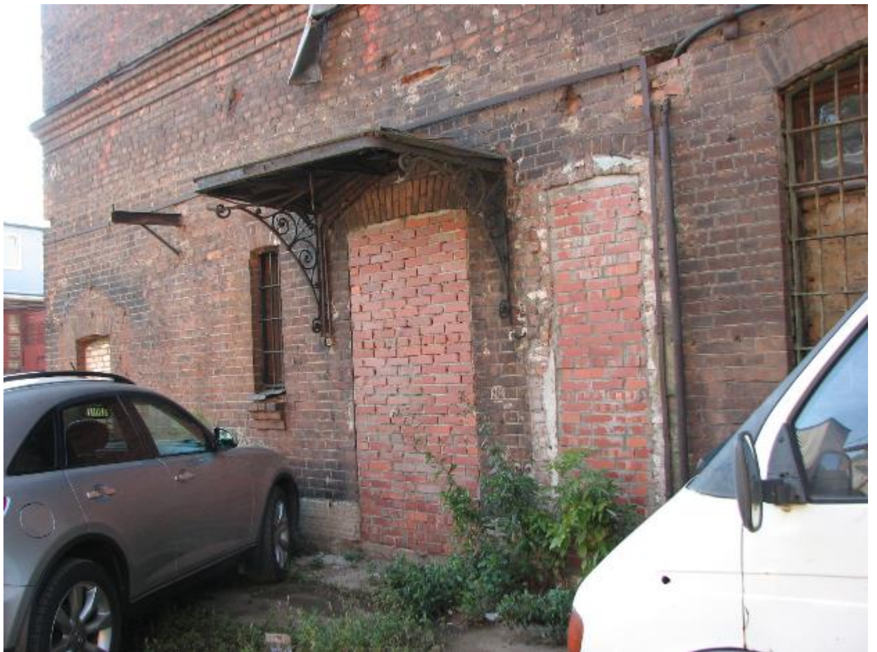
9. Северо-восточный фасад выявленного объекта культурного наследия «Комплекс Санкт-Петербургской женской исправительной тюрьмы. Служительский корпус», расположенного по адресу: г. Санкт-Петербург, Арсенальная улица, дом 9, литера Д. Фрагмент. 24.08.2021.
