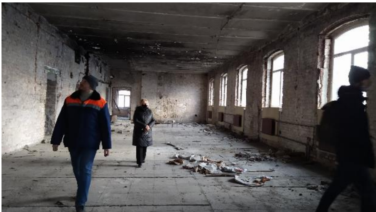
11. Помещение №6 в уровне 1-го этажа выявленного объекта культурного наследия «Комплекс Санкт-Петербургской женской исправительной тюрьмы. Служительский корпус», расположенного по адресу: г. Санкт-Петербург, Арсенальная улица, дом 9, литера Д. 24.08.2021.
