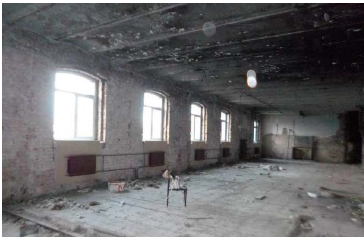
19. Помещение №1 в уровне 4-го этажа выявленного объекта культурного наследия «Комплекс Санкт-Петербургской женской исправительной тюрьмы. Служительский корпус», расположенного по адресу: г. Санкт-Петербург, Арсенальная улица, дом 9, литера Д. 24.08.2021.
