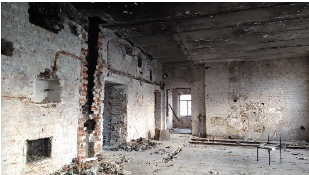
12. Помещение №6 в уровне 1-го этажа выявленного объекта культурного наследия «Комплекс Санкт-Петербургской женской исправительной тюрьмы. Служительский корпус», расположенного по адресу: г. Санкт-Петербург, Арсенальная улица, дом 9, литера Д. 24.08.2021.
