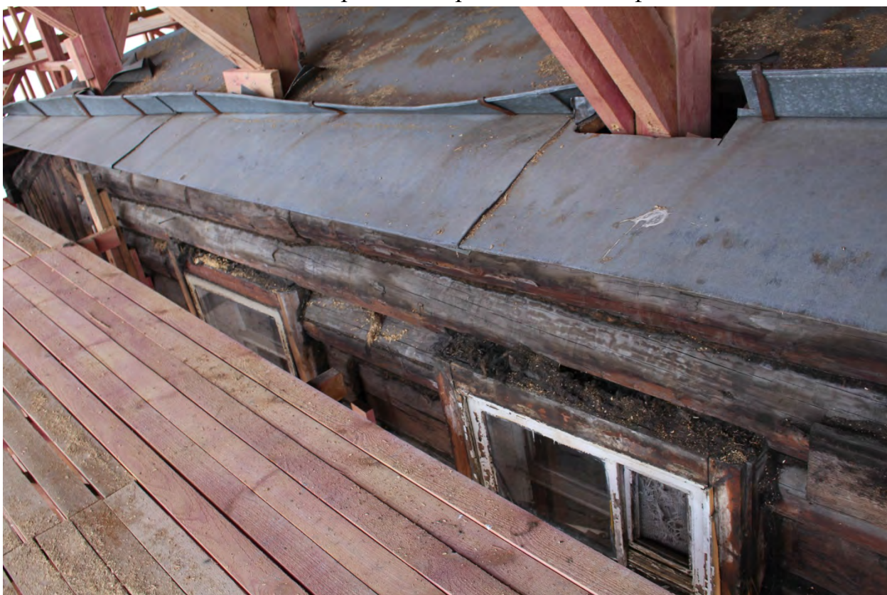
Фото 76. Вид на юго-восточный карниз.
