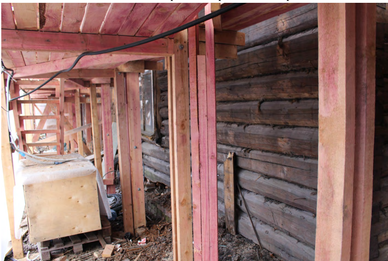
Фото 18. Вид вдоль северо-западного фасада.
