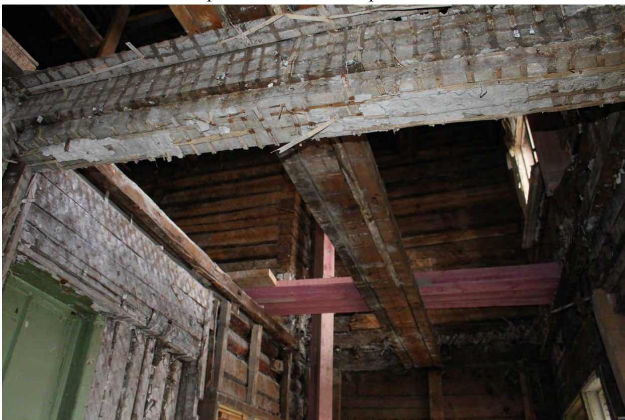
Фото 26. Элементы перекрытия над первым этажом.
