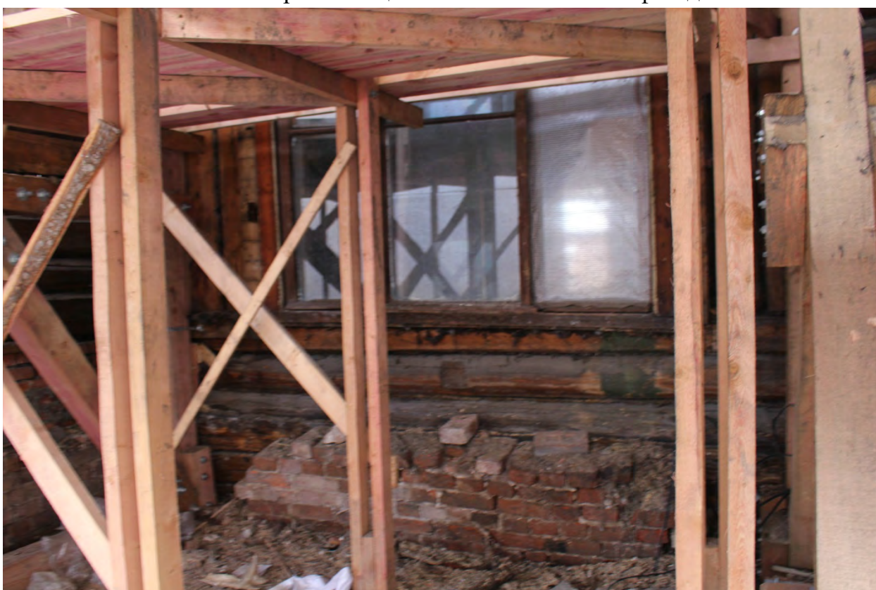
Фото 12. Центральная часть юго-восточного фасада.
