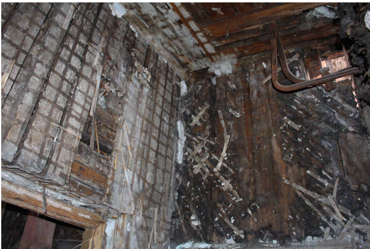
Фото 25. Фрагмент стены в северном помещении.
