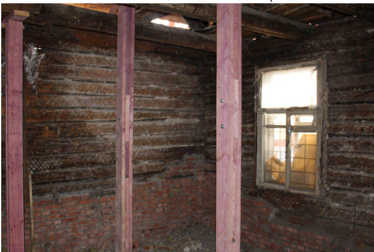
Фото 32. Южный угол здания.
