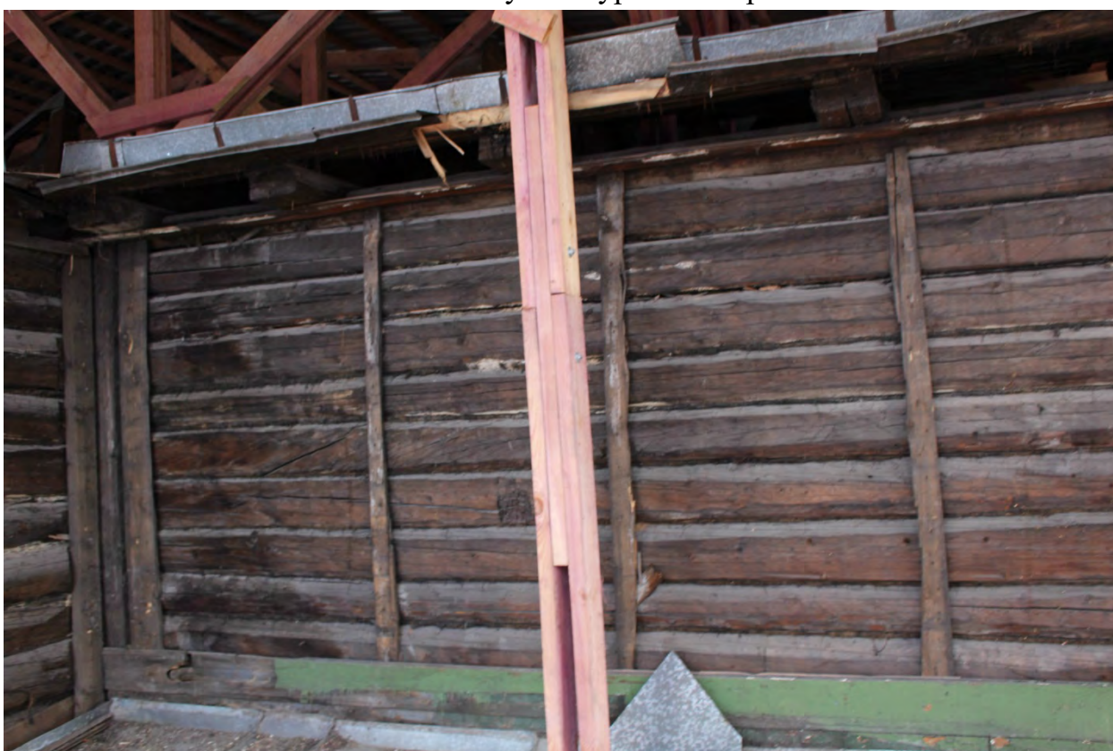
Фото 68. Вид на северную стену лицевого мезонина.
