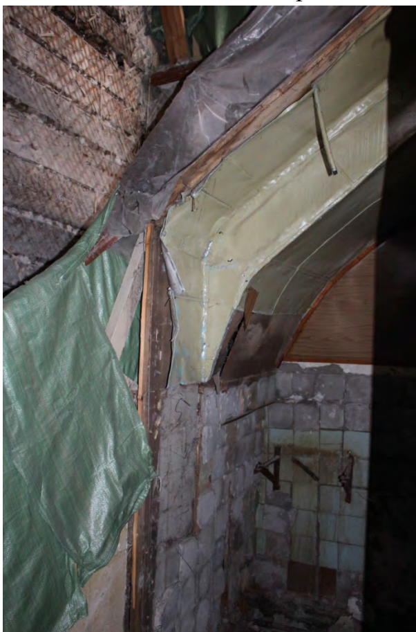
Фото 42. Фрагмент косоуров лестницы и помещения под ней.
