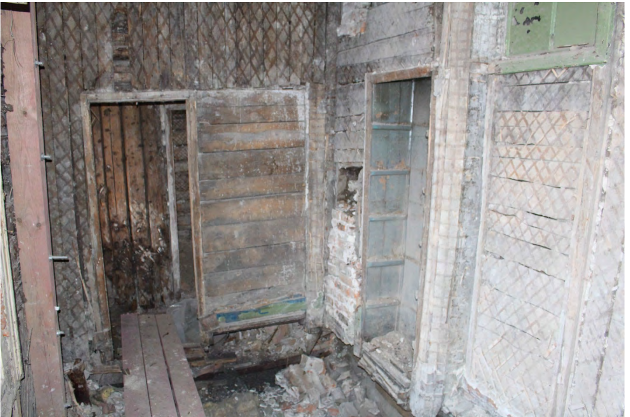
Фото 22. Помещения на северо-западе.
