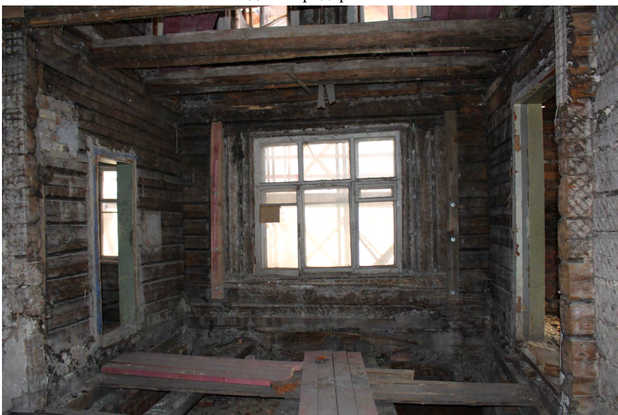
Фото 36. Вид на центральную часть юго-восточного фасада.
