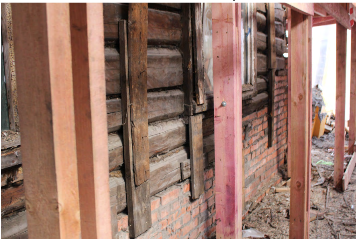
Фото 14. Фрагмент юго-западного фасада.
