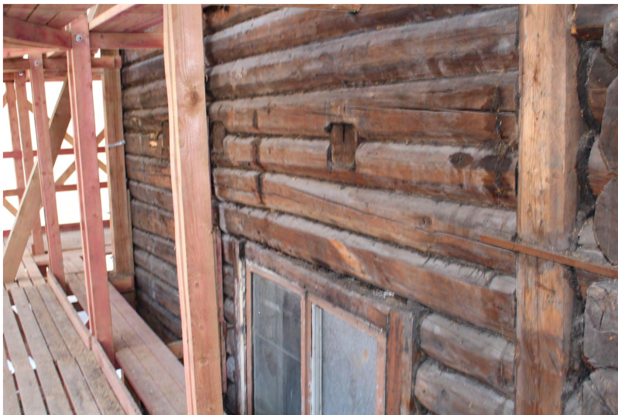
Фото 61. Фрагмент фасада восточного угла второго этажа.
