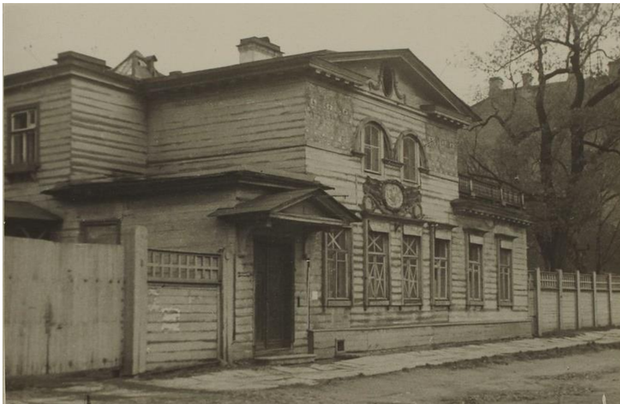
Илл. 49. Перспектива с 12й линии. Обмеры 1942 г. Кроки. Жилой дом № 37 по 12-й линии Васильевского Острова (источник: https://kgiop.gov.spb.ru/ ).
