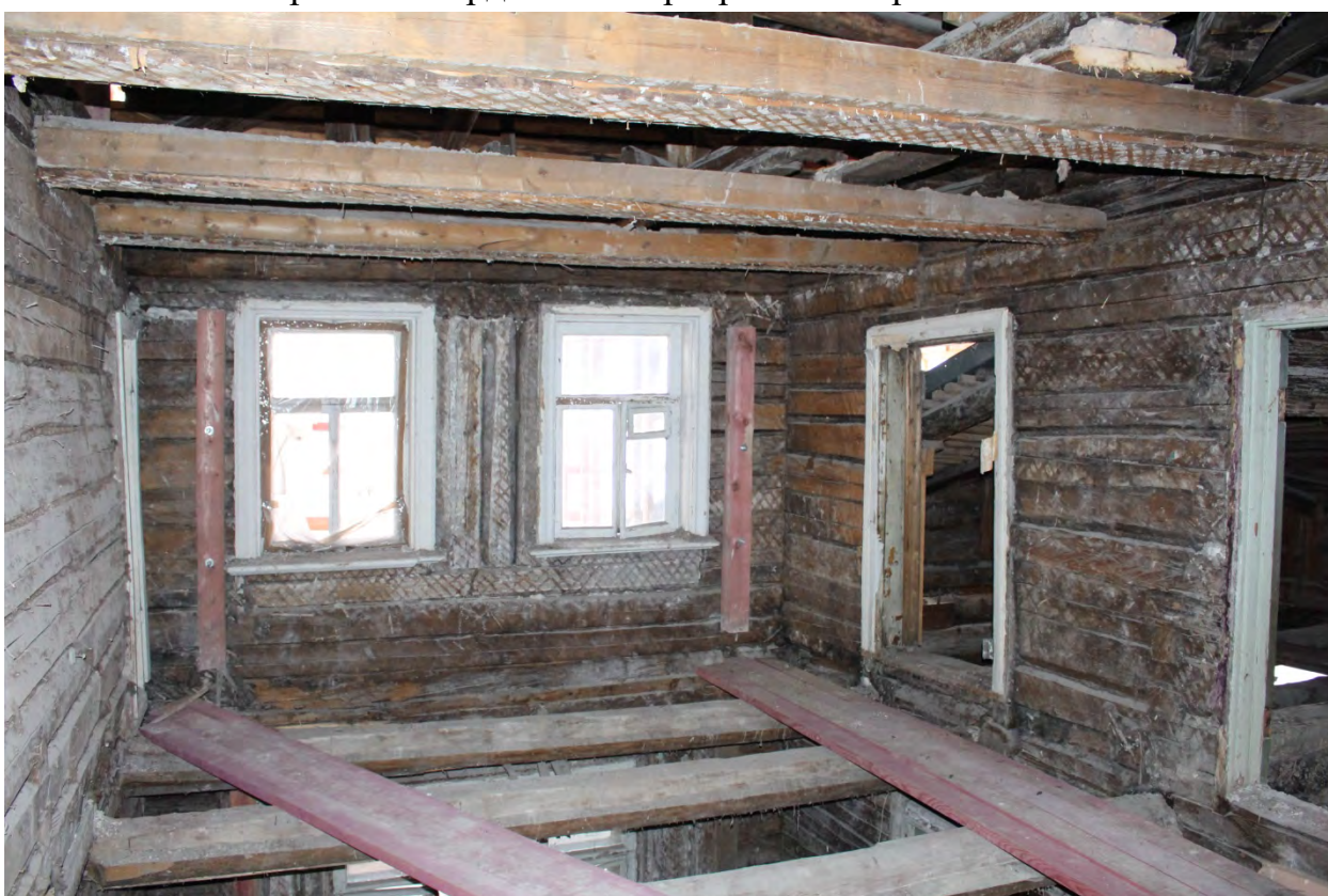
Фото 46. Вид помещения на юго-востоке второго этажа.
