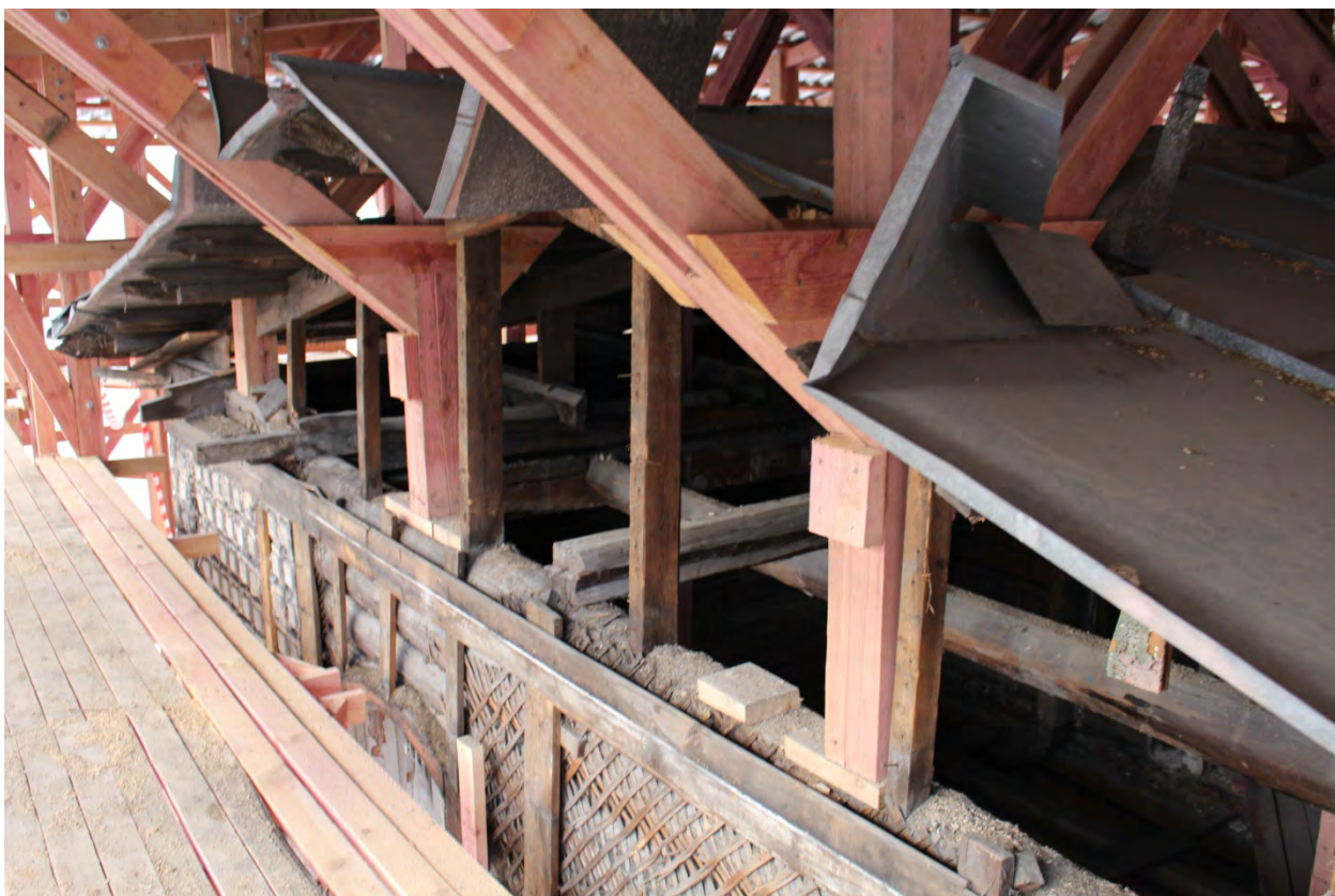
Фото 75. Вид кровли и карниза лицевого фасада.
