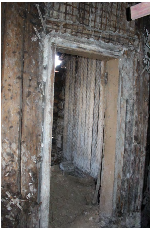
Фото 23. Вид в северное помещение.
