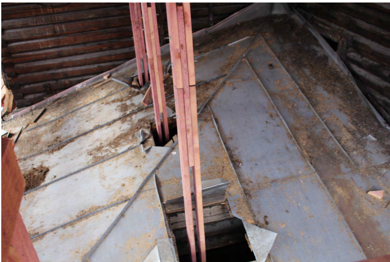
Фото 73. Вид на южную часть кровли.
