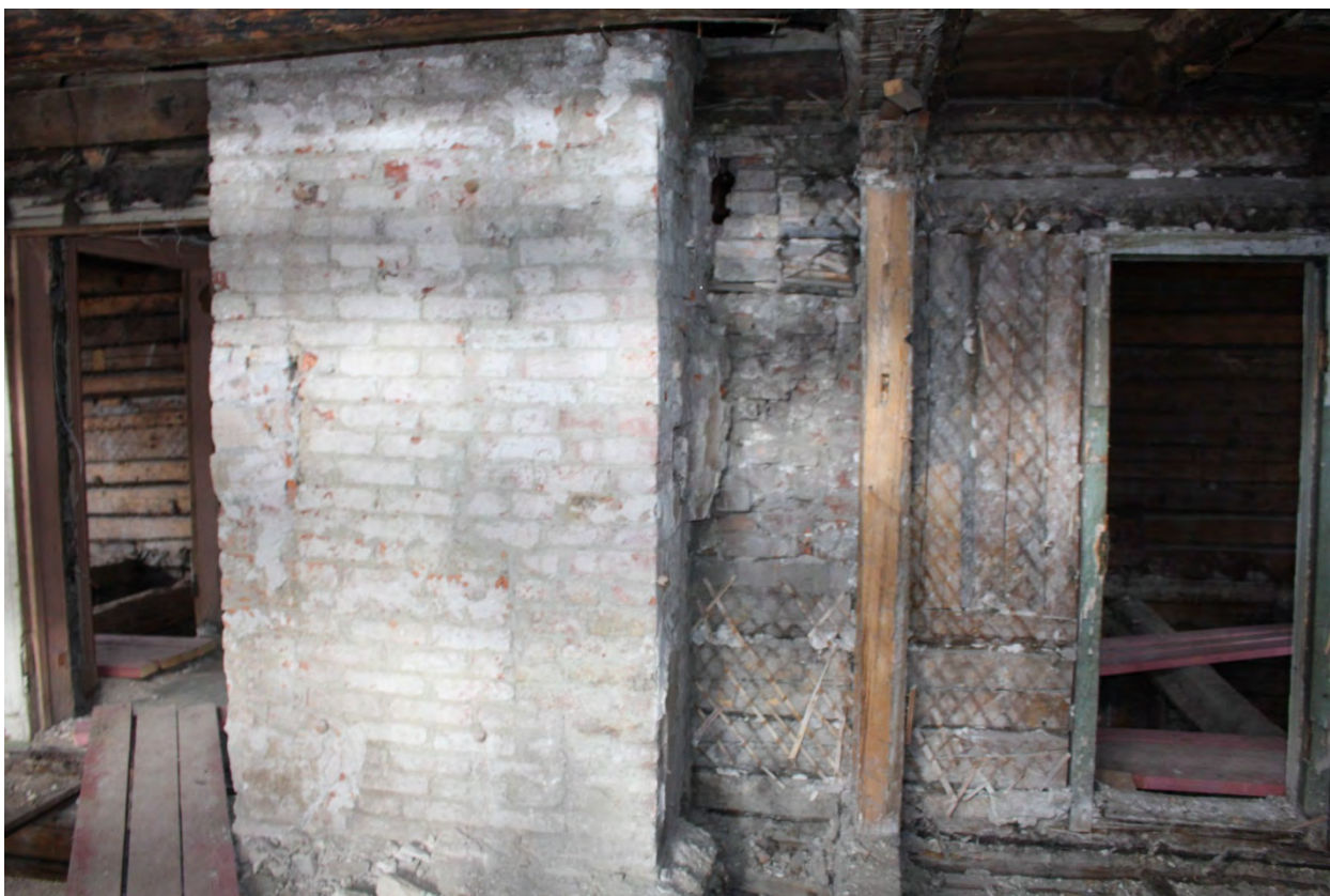
Фото 49. Стена и дымоход вдоль юго-западных помещений второго этажа.
