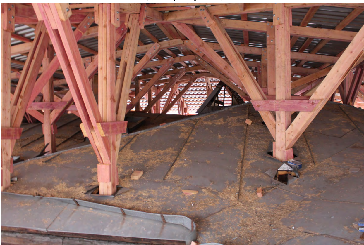
Фото 72. Вид на центральную часть кровли и фонарь.
