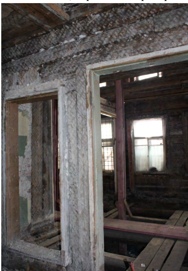
Фото 28. Вид на входы в юго-западные помещения.
