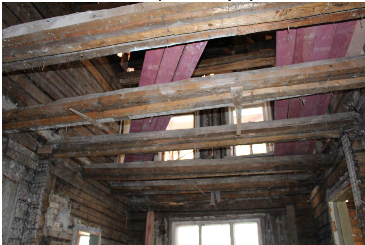
Фото 34. Элементы перекрытий над коридором.
