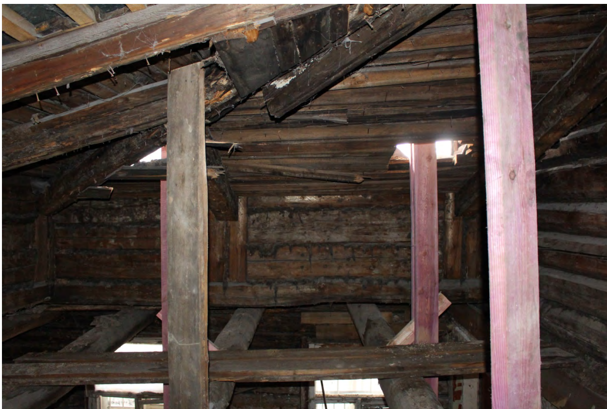
Фото 51. Чердак в южной части.
