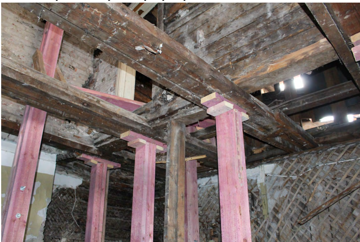
Фото 40. Фрагмент перекрытия в юго-восточной части.
