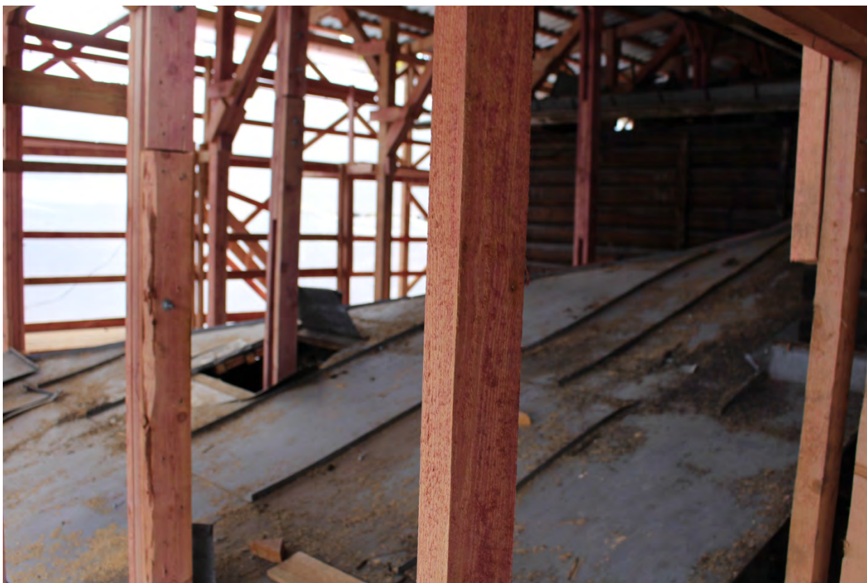
Фото 71. Вид на крышу западной части.
