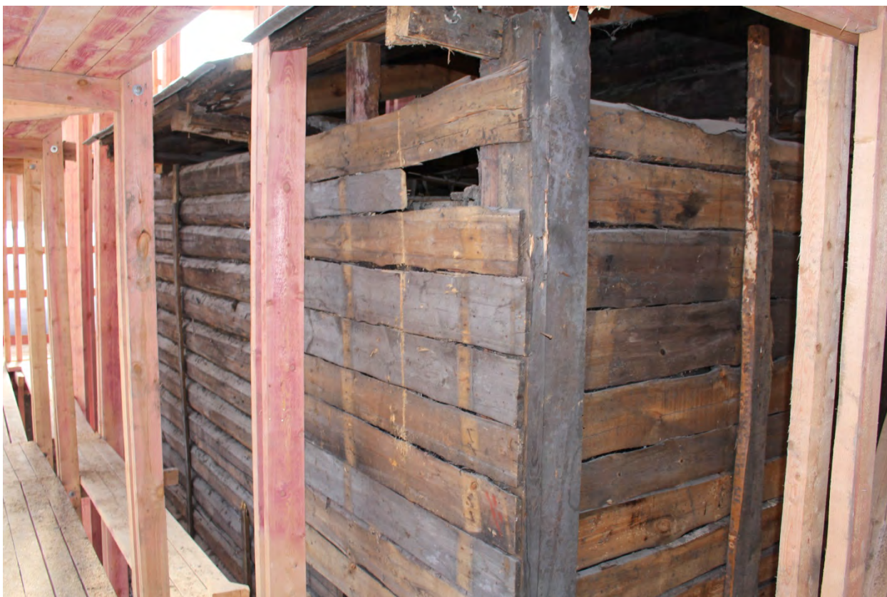
Фото 63. Вид на южную часть здания с востока.
