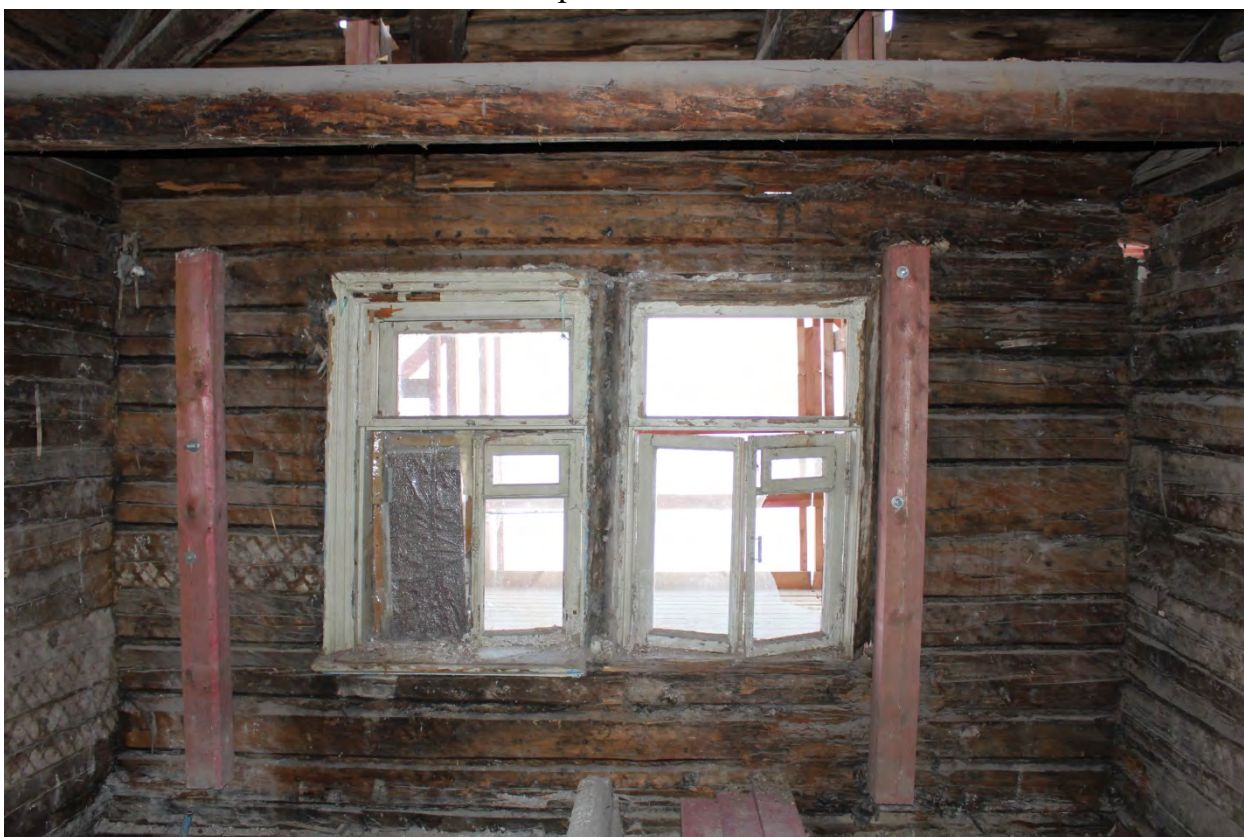
Фото 52. Проемы на северо-востоке второго этажа.
