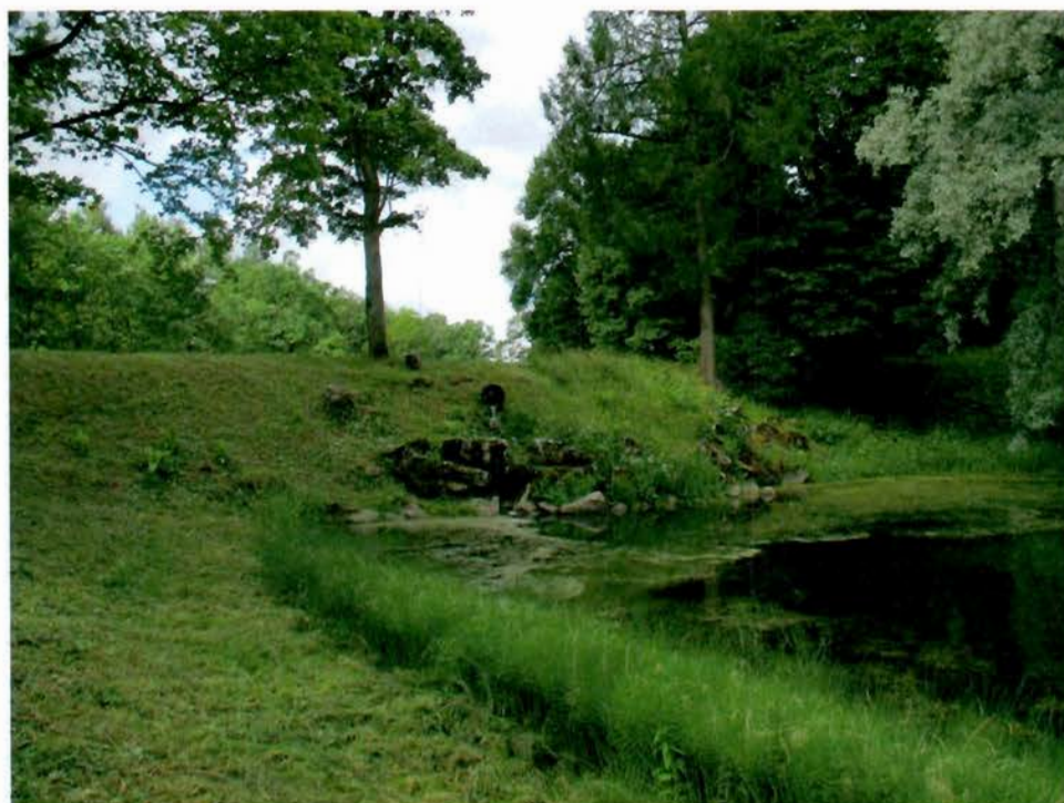
1. Вид со стороны нижнего бьефа
