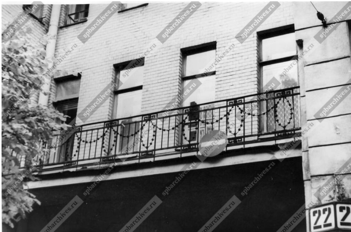
35. Вид балконных ограждений центрального фасада жилого дома №22 по улице Скороходова (архитектор А.И.Балинский, 1908 год). Дата съёмки: 06 октября 1985 г. Архивный шифр: ЦГАКФФД СПб Ар 225268
