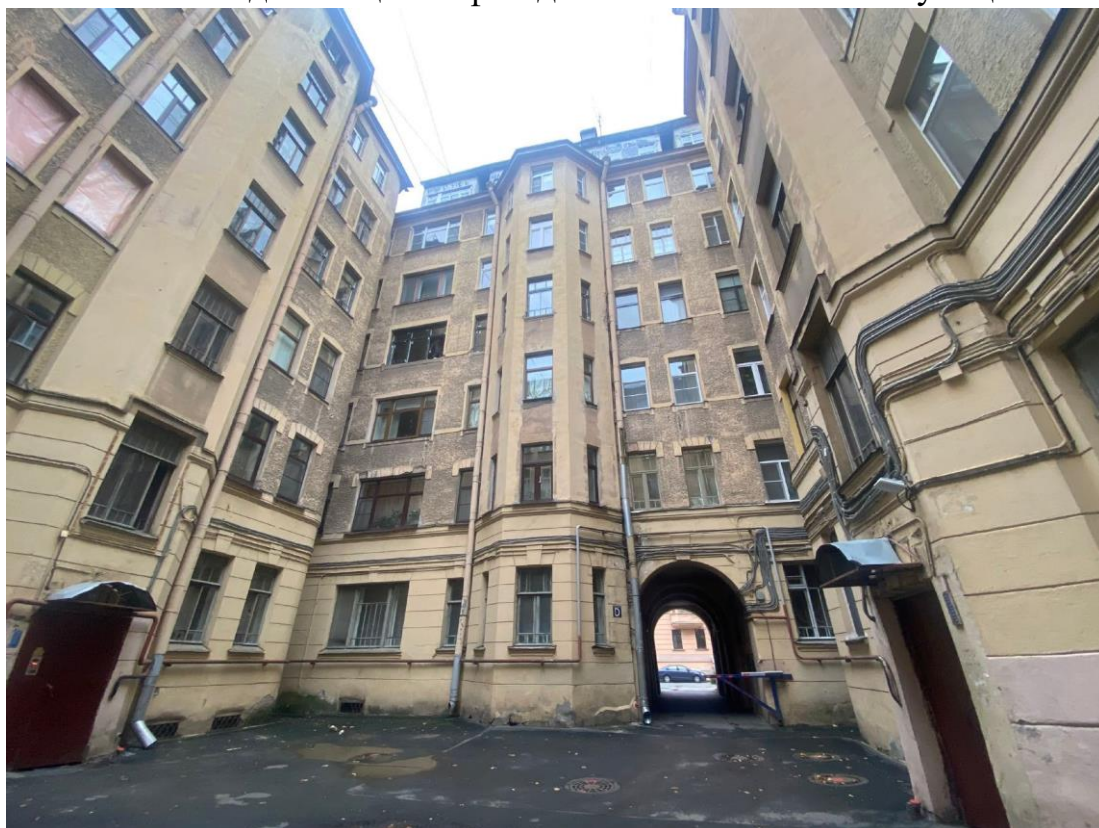
2. Вид на дворовые фасады
