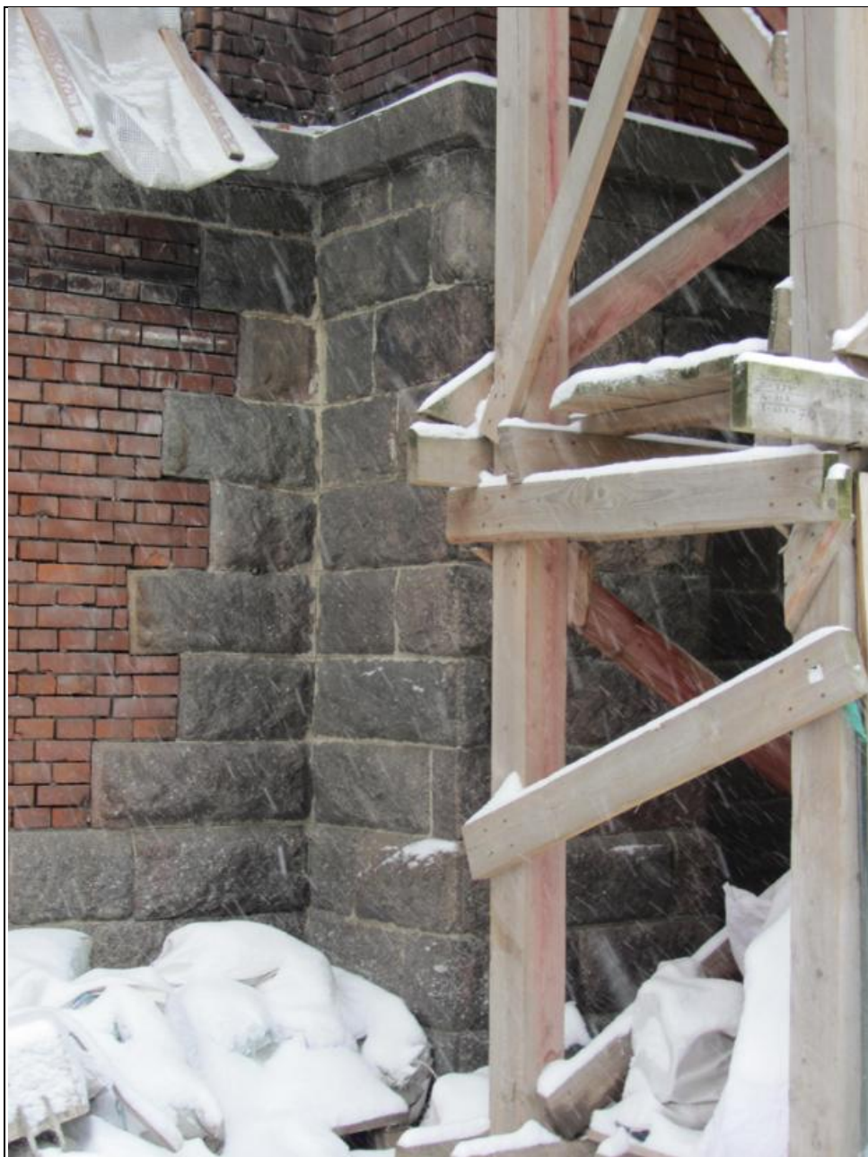
56. Объект культурного наследия федерального значения «Храм римско-католический Святого Сердца Господа Иисуса». Фрагмент восточного фасада.
