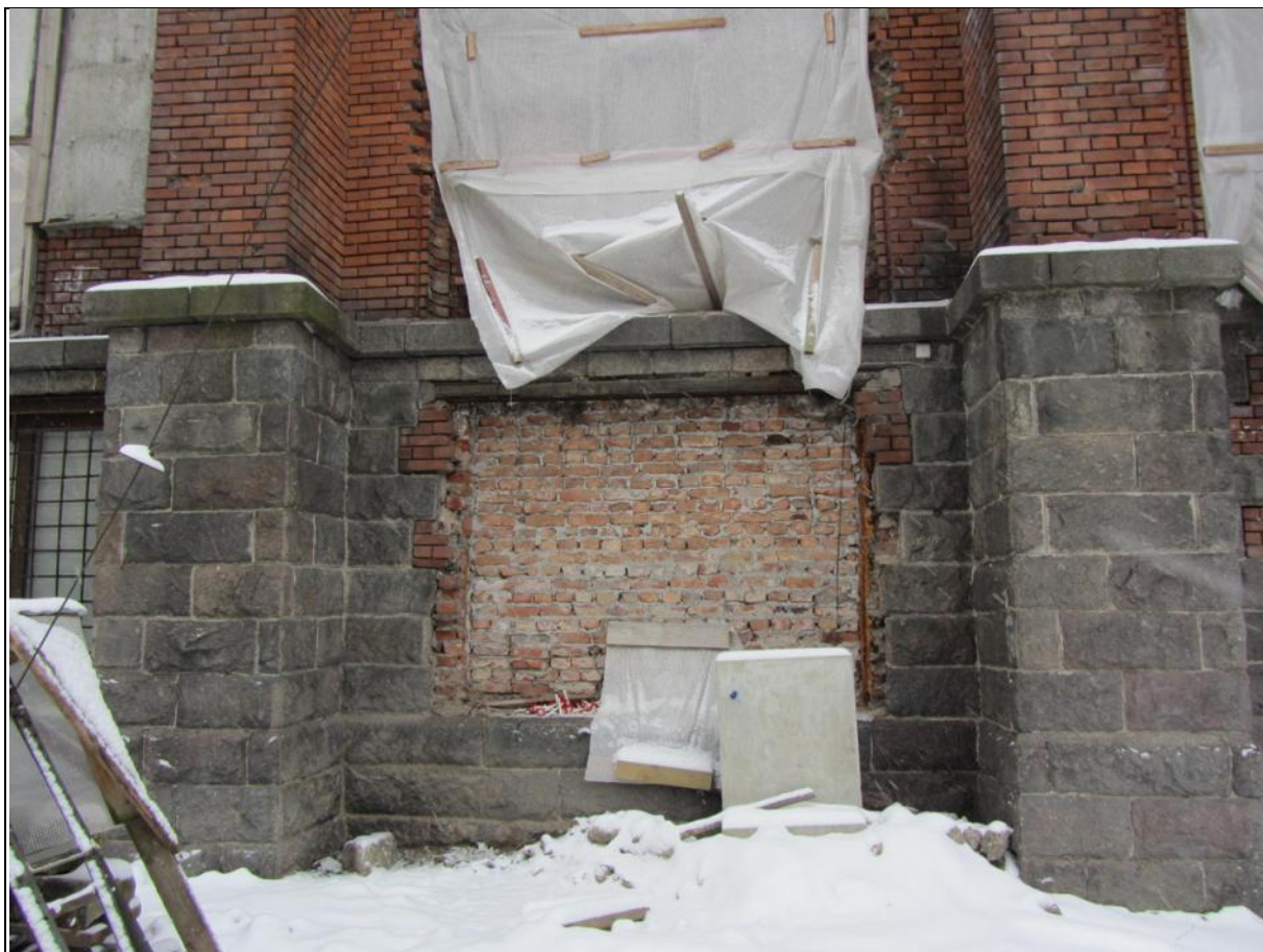
53. Объект культурного наследия федерального значения «Храм римско-католический Святого Сердца Господа Иисуса». Фрагмент восточного фасада.
