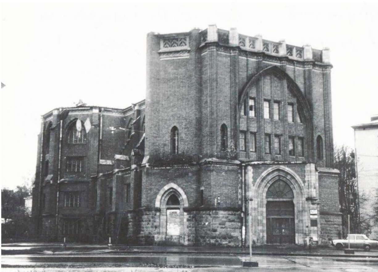
Илл. 26. Лицевой фасад. Фотография. 1995 г. Архив старых фотографий. https://pastvu.com/p/1018420 .
