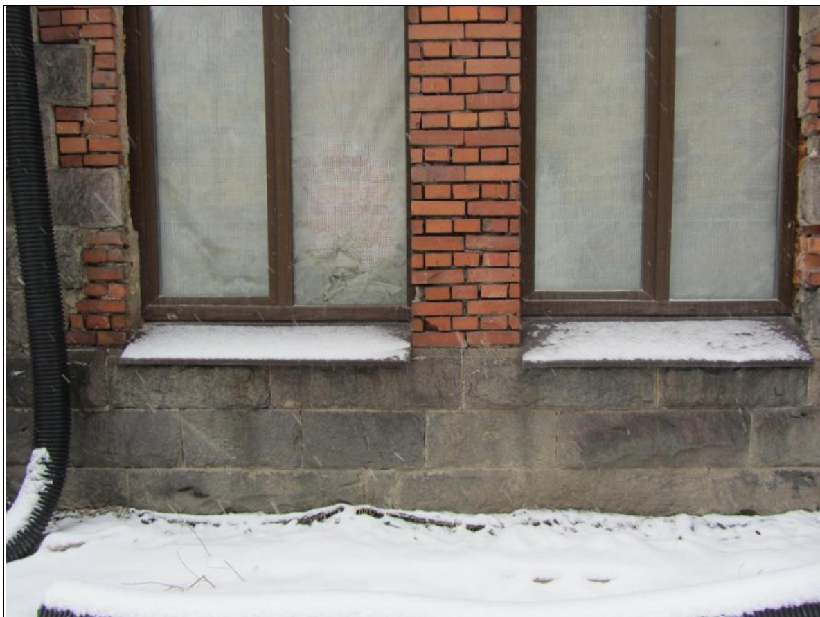
47. Объект культурного наследия федерального значения «Храм римско-католический Святого Сердца Господа Иисуса». Фрагмент восточного фасада.
