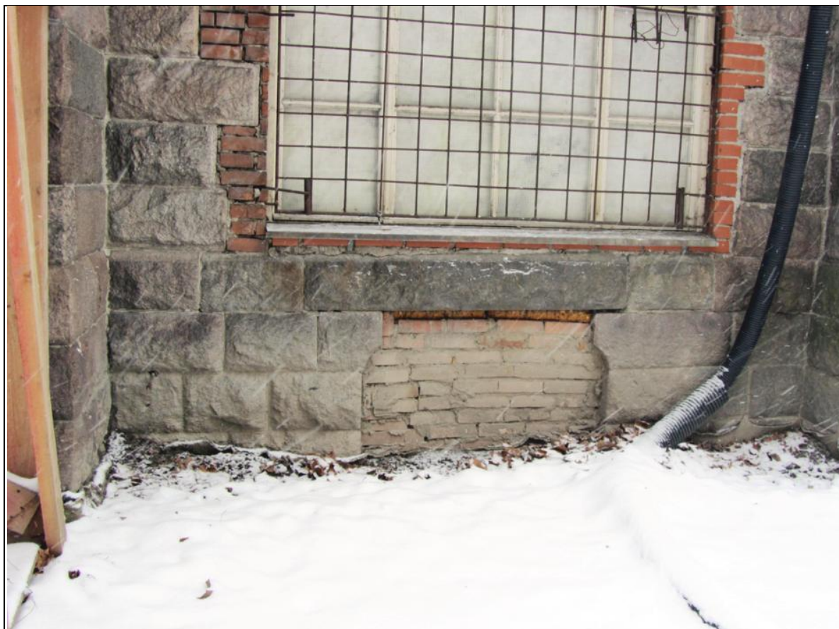
18. Объект культурного наследия федерального значения «Храм римско-католический Святого Сердца Господа Иисуса». Фрагменты цокольного этажа западного фасада.
