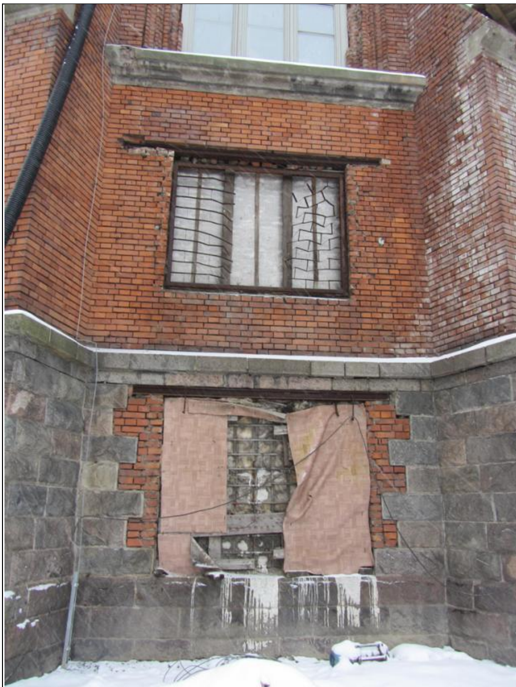
49. Объект культурного наследия федерального значения «Храм римско-католический Святого Сердца Господа Иисуса». Фрагмент восточного фасада.
