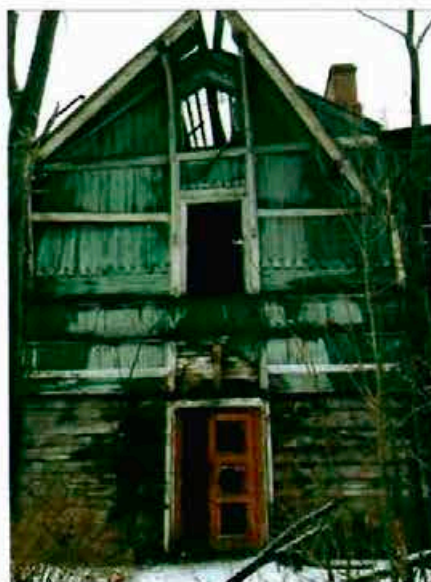
Фото 2. Часть западного фасада.
