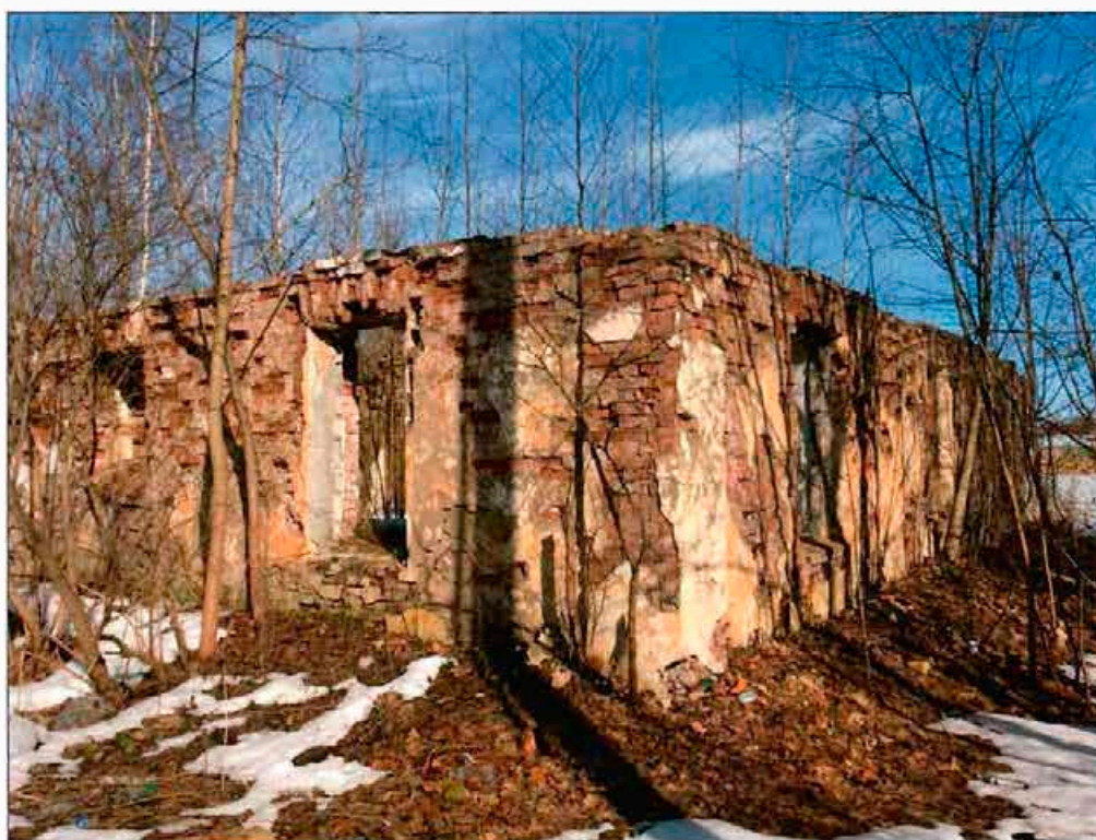
Фото 1. Общий вид с юго-запада.
