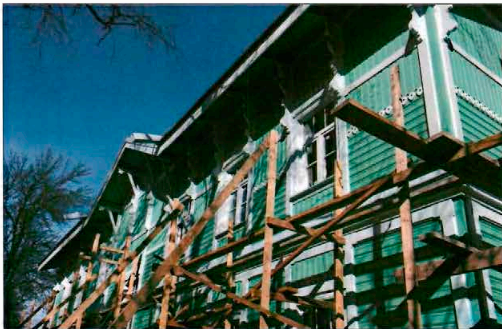
Фото 1. Восточный фасад. Общий вид.
