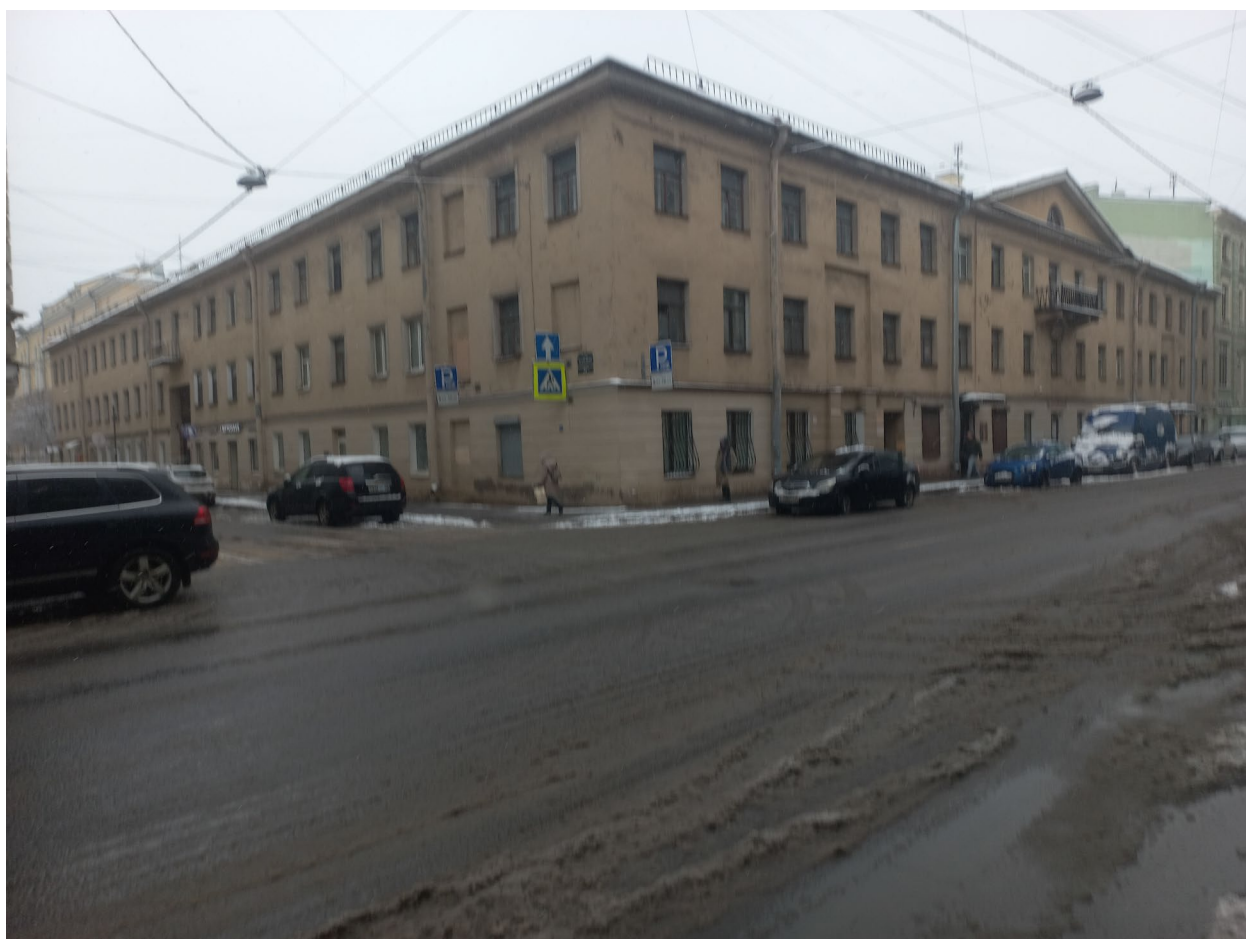
Фото 1. Общий вид здания (лицевые фасады)
