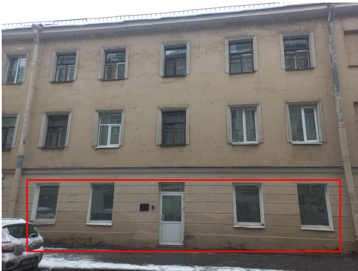
Фото 3. Фрагмент фасада по пер. Антоненко. Окна, вход в помещение 13-Н.
