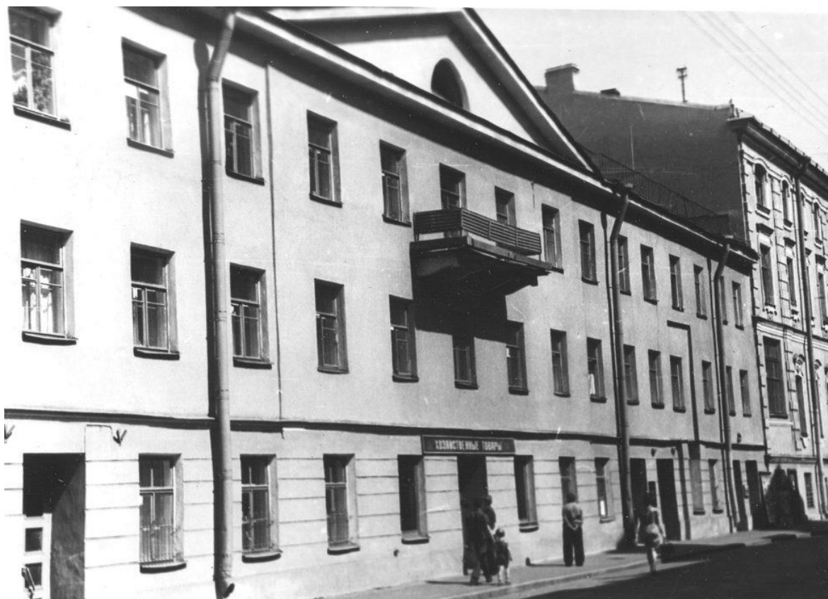
Рис.11. Лицевые фасады здания по Казанской улице. Фото 1965-1975 годов.
