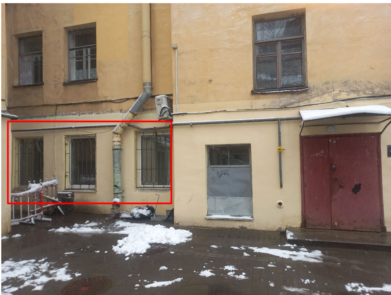
Фото 6. Северо-восточный дворový фасад. Окна помещения 13-Н.
