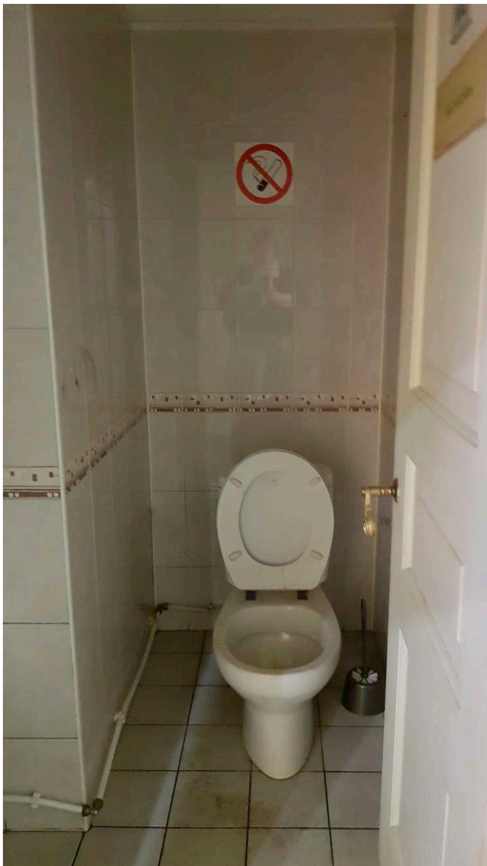
Фото 51. Общий вид части пом. 26-Н (№ 48 по ПИБ).
