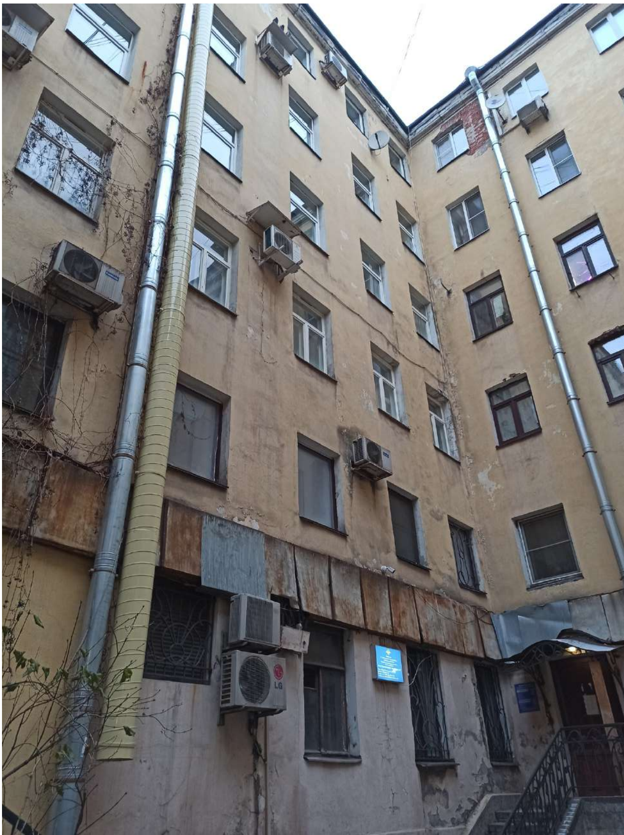
Фото 9. Вид на часть дворового фасада, наблюдается установка дополнительного оборудования, замена оконных заполнений.
