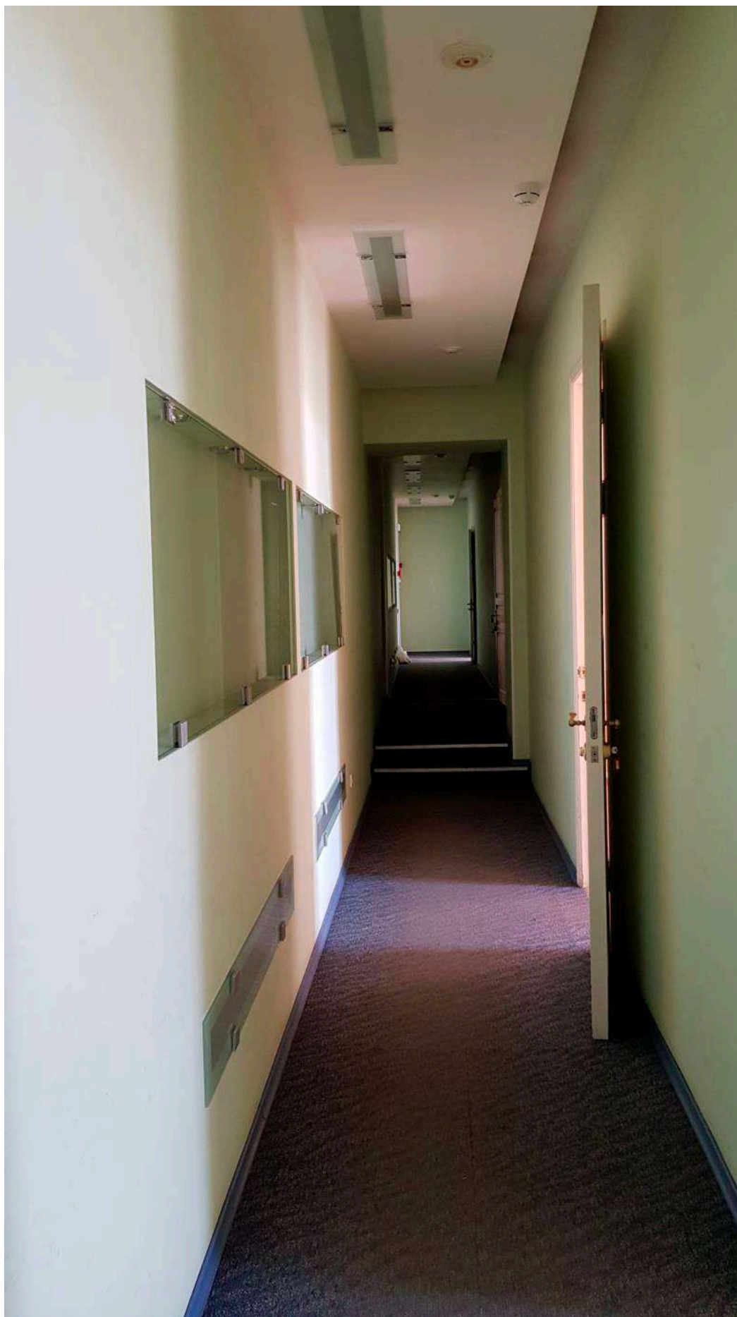
Фото 27. Общий вид части пом. 26-Н (№ 33 по ПИБ), элементы ДПИ отсутствуют.
