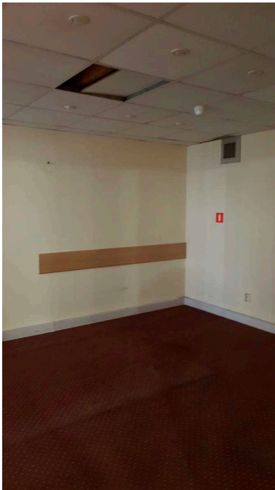
Фото 4. Общий вид части пом. 26-Н (№ 4 по ПИБ). Подсобное помещение, элементы ДПИ отсутствуют.
