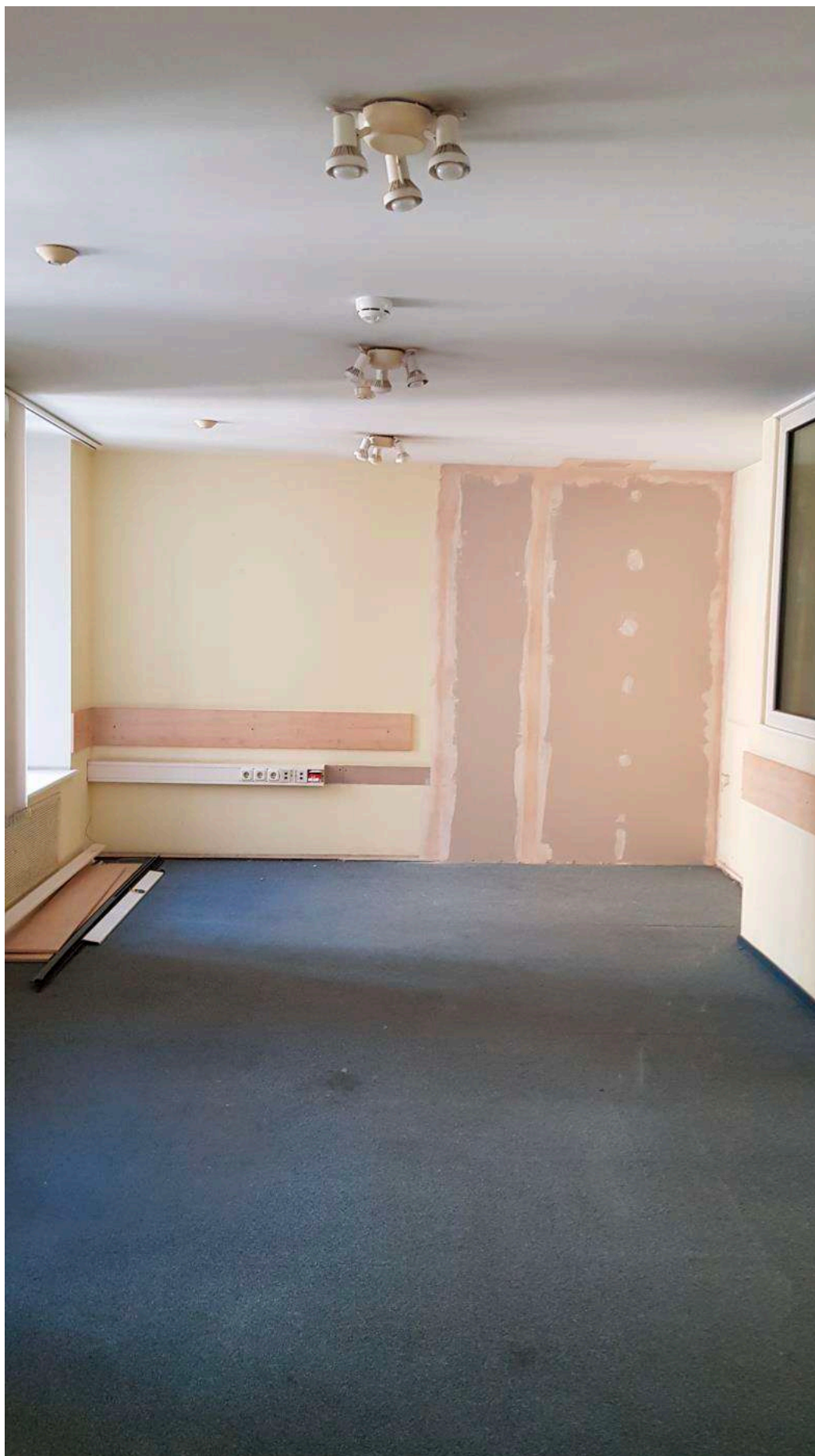
Фото 20. Общий вид части пом. 26-Н (№ 29 по ПИБ), элементы ДПИ отсутствуют.
