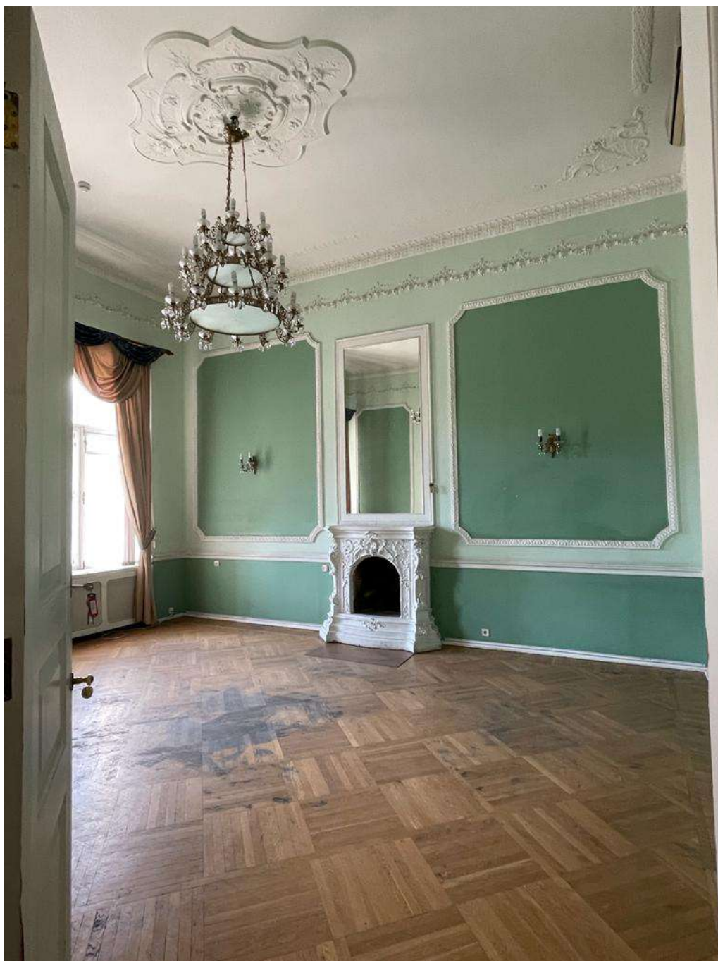
Фото 40. Общий вид части пом. 26-Н (№ 43 по ПИБ). Нижняя часть стен отделена профилированным карнизом; стены разбиты лепными орнаментированными тягами на филенки прямоугольной формы с вырезанными углами; в верхней части стен лепной пояс в виде цветочных гирлянд с лентами; потолок по периметру оформлен лепным орнаментальным поясом; в углах потолка лепные композиции, включающие изображение раковины, рога изобилия и птиц; в центре потолка лепная фигурная орнаментированная розетка.
