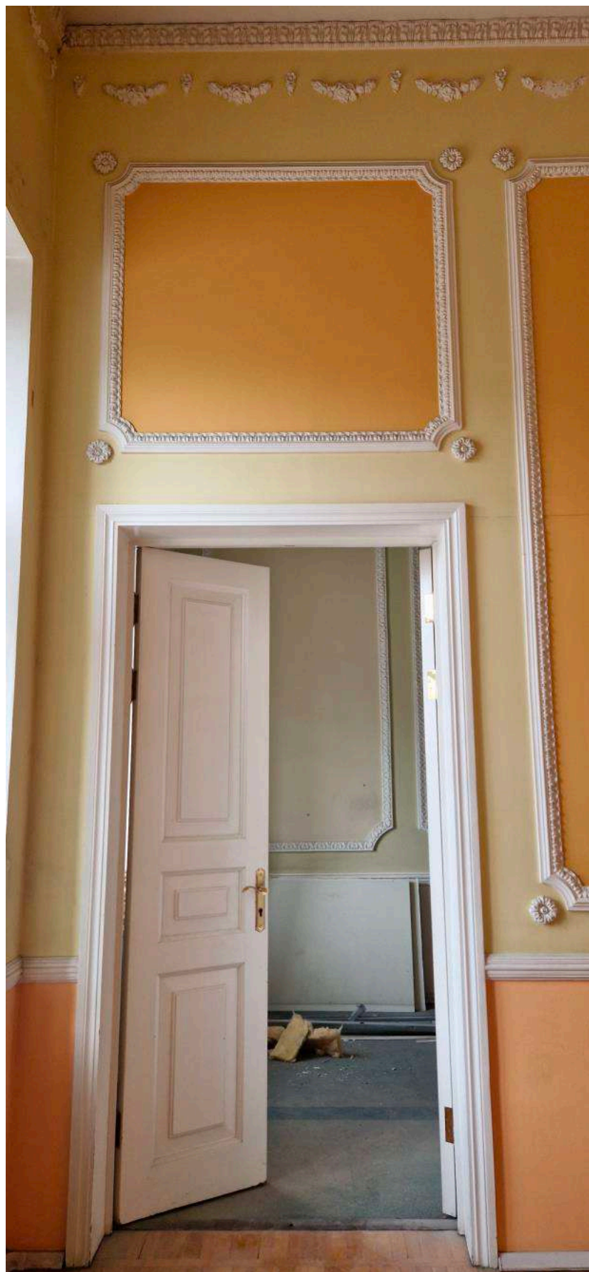
Фото 39. Общий вид части помещения 26-Н (№42 по ПИБ).
