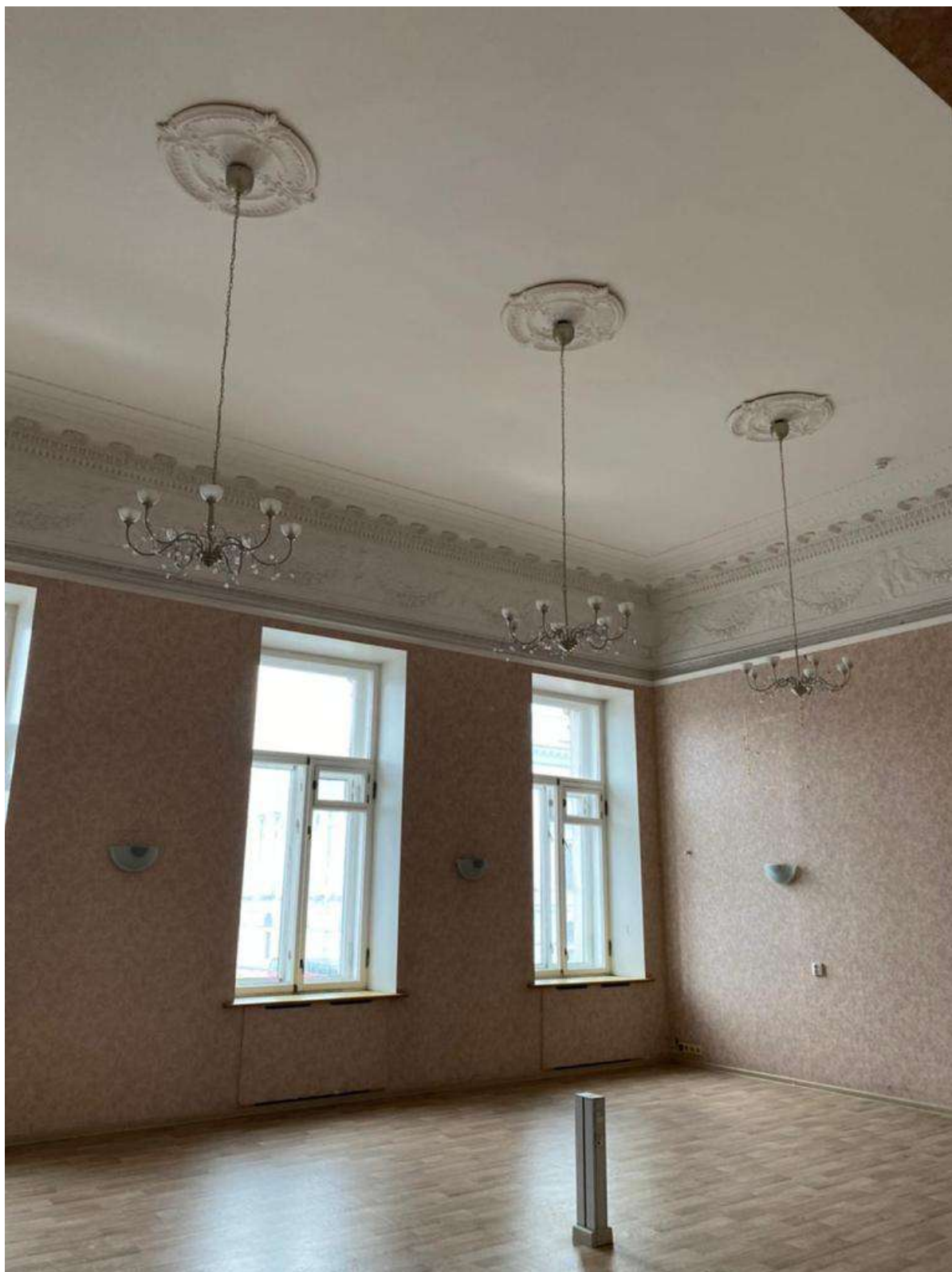
Фото 87. Общий вид части пом. 29-Н (№ 11 по ПИБ). Лепной рельефный фриз (путти, поддерживающие цветочные гирлянды); лепные орнаментированные тяги по периметру потолка; три лепные орнаментированные розетки на потолке.
