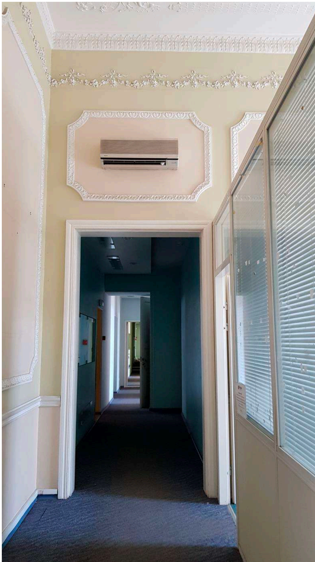
Фото 34. Общий вид части пом. 26-Н (№ 40 по ПИБ), нижняя часть стен отделена профилированным карнизом, стены разбиты лепными орнаментированными тягами на филенки прямоугольной формы с вырезанными углами, в верхней части стен лепной пояс в виде цветочных гирлянд с лентами, потолок по периметру оформлен лепным орнаментальным поясом, в углах потолка лепные композиции, включающие изображение раковины, рога изобилия и птиц; в центре потолка лепная фигурная орнаментированная розетка.
