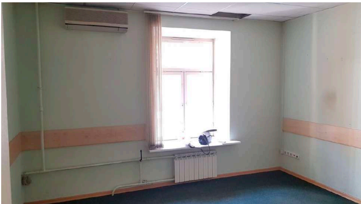
Фото 10. Общий вид части пом. 26-Н (№ 15 по ПИБ), элементы ДПИ отсутствуют.
