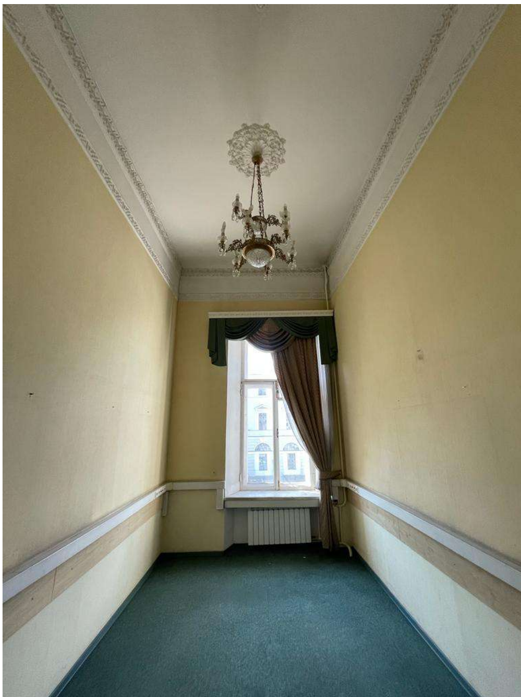
Фото 61. Общий вид части пом. 26-Н (№ 56 по ПИБ).
