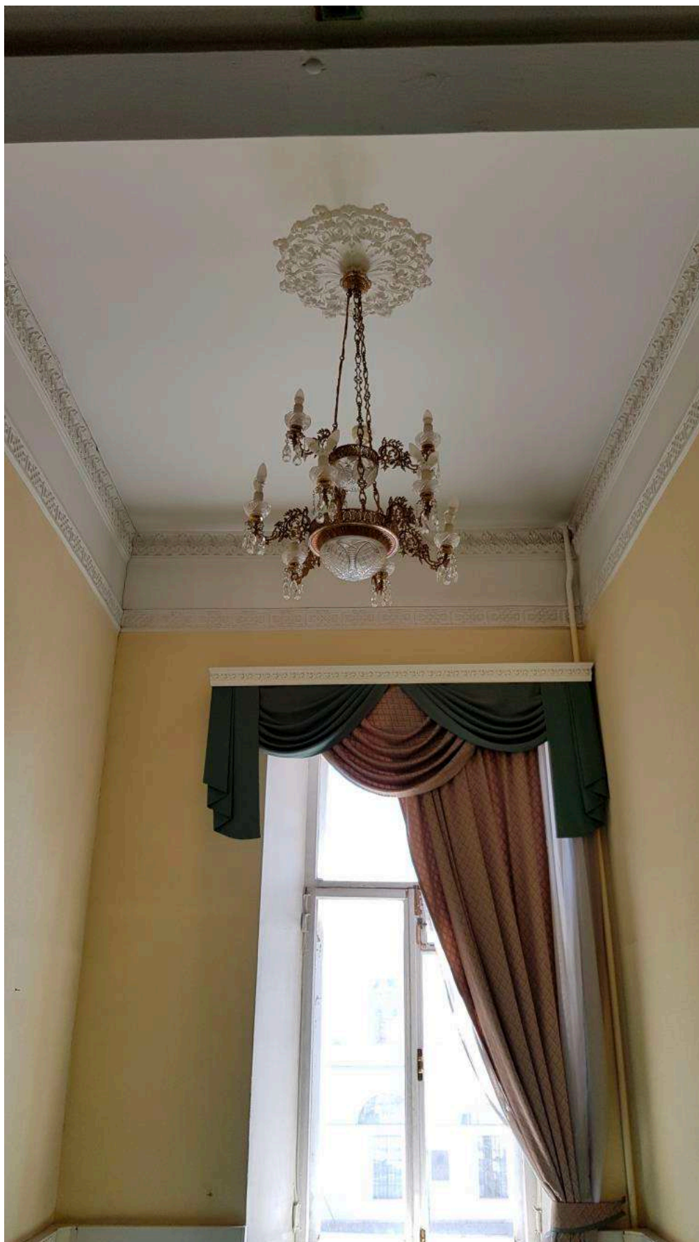
Фото 62. Общий вид части пом. 26-Н (№ 56 по ПИБ). Лепная орнаментированная розетка на потолке, лепной орнаментированный фриз.
