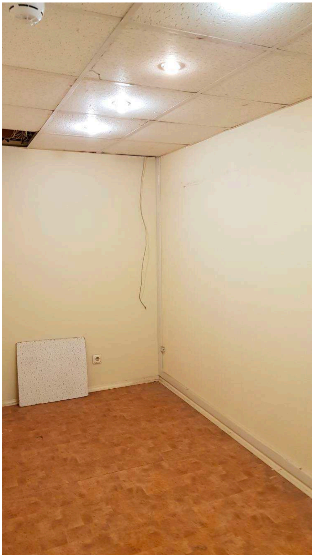
Фото 89. Общий вид на помещение 30-Н (№1 по ПИБ).
