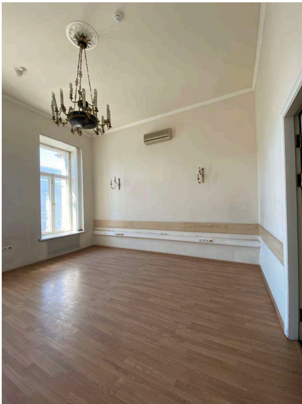
Фото 24. Общий вид части пом. 26-Н (№ 32 по ПИБ), лепная орнаментированная розетка на потолке и орнаментированная потолочная тяга.
