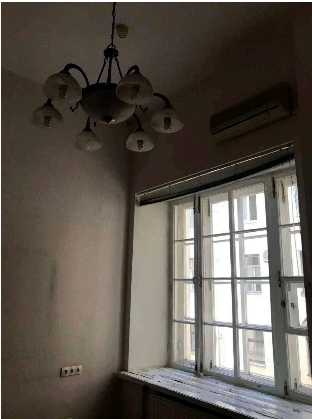
Фото 53. Общий вид части пом. 26-Н (№ 49 по ПИБ).
