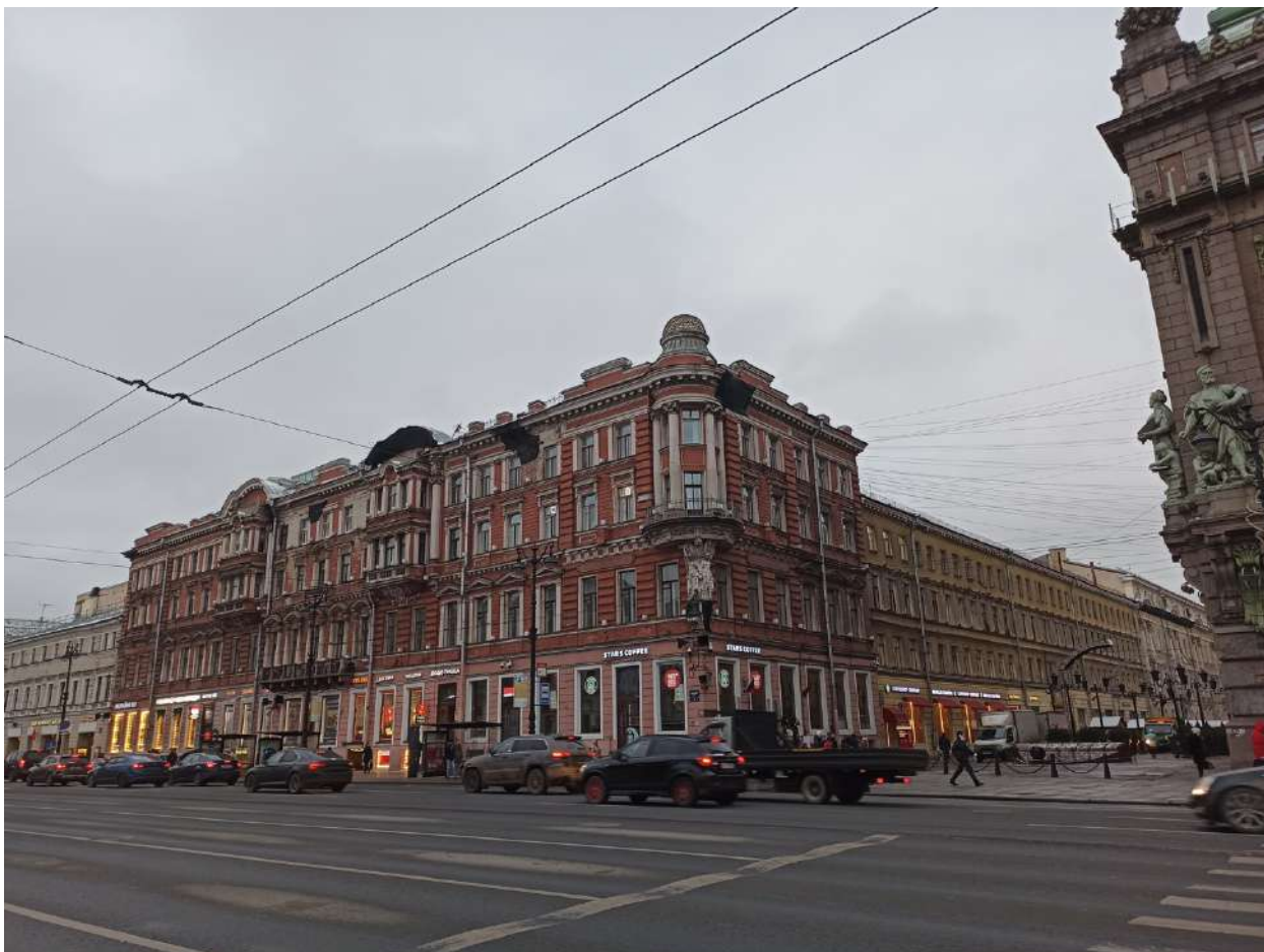
Фото 5. Общий вид на лицевые фасады объекта.
