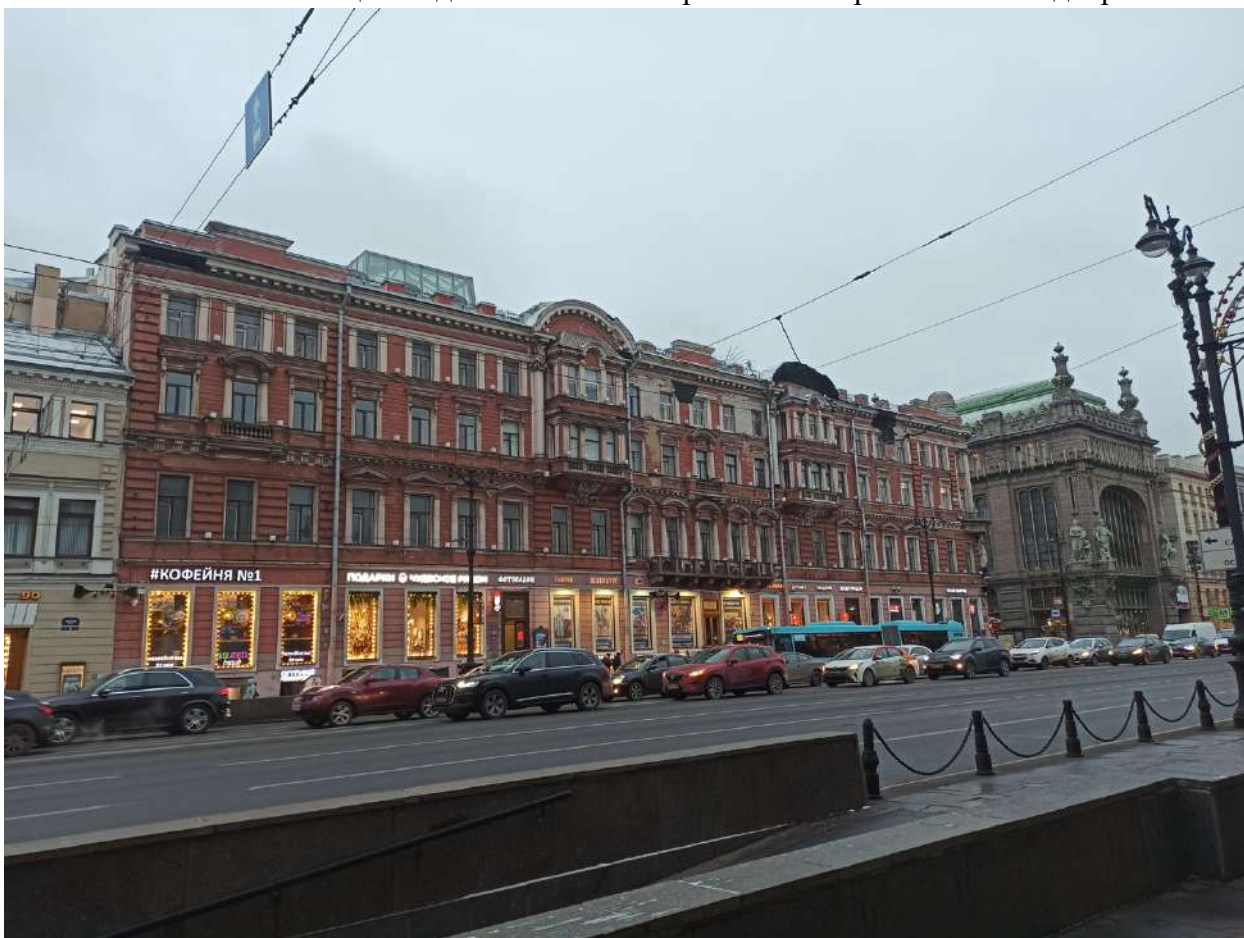
Фото 2. Общий вид на фасад здания, выходящий на Невский пр.
