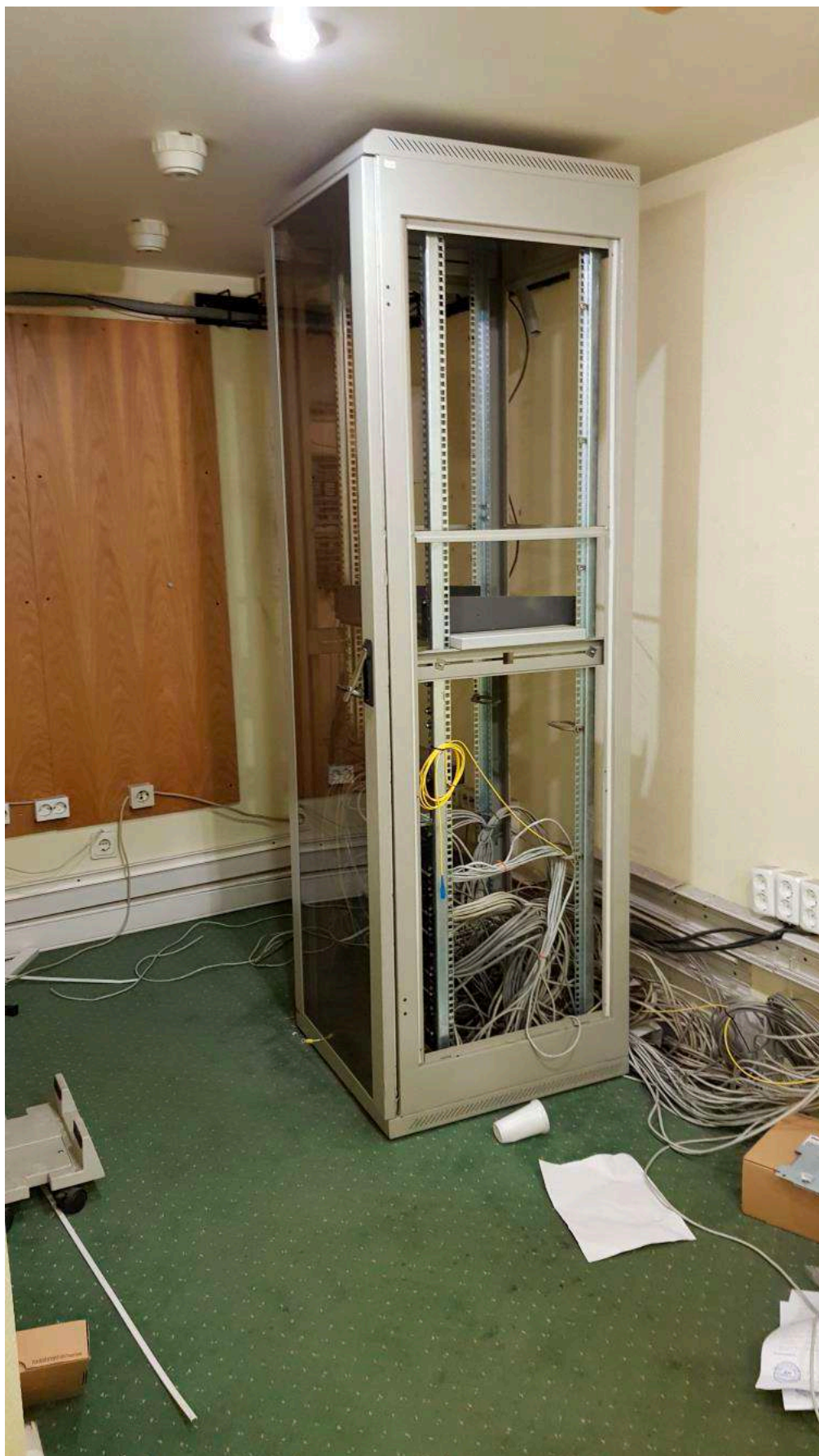
Фото 69. Общий вид части пом. 26-Н (№ 60 по ПИБ).
