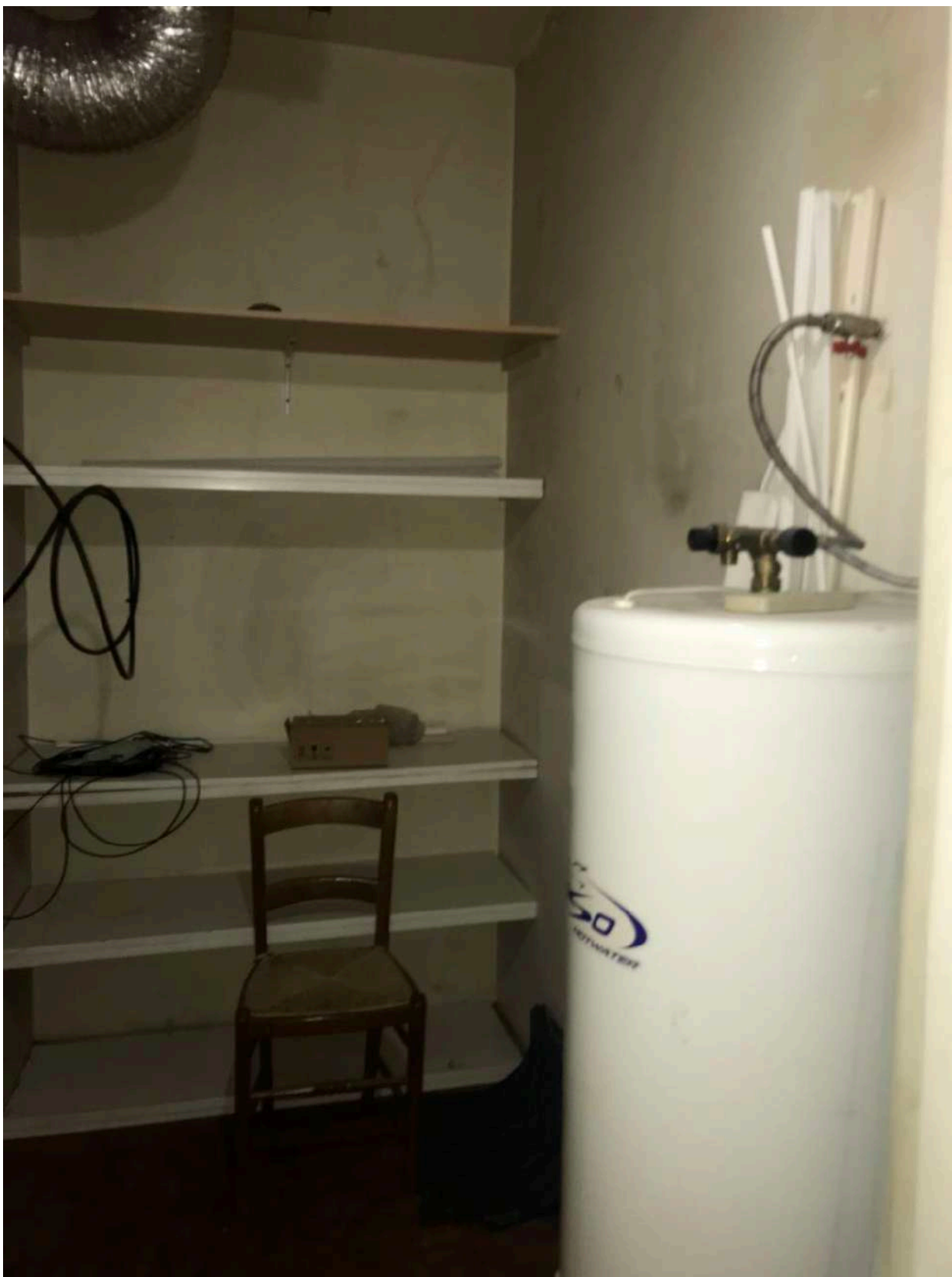
Фото 56. Общий вид части пом. 26-Н (№ 51 по ПИБ).
