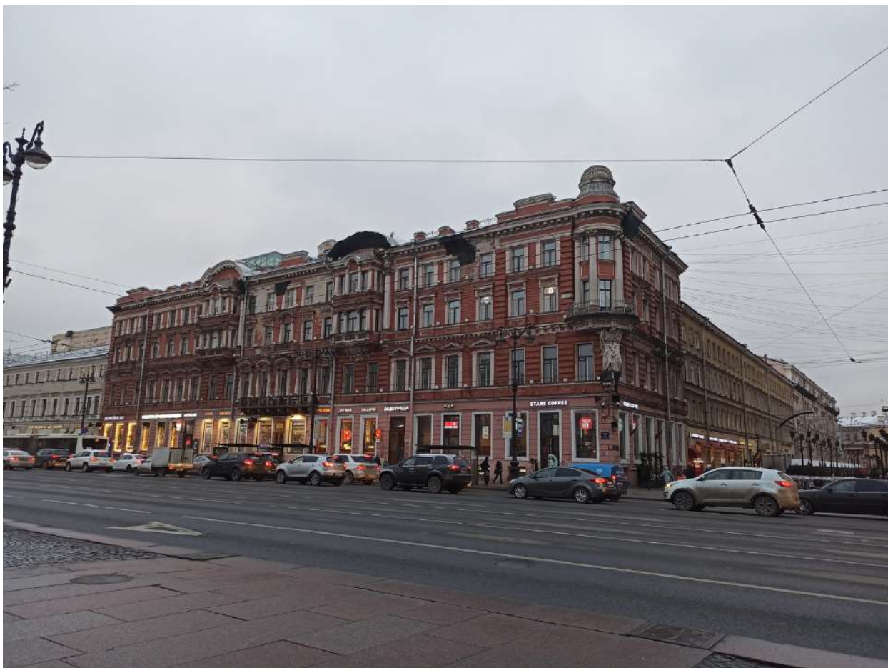
Фото 3. Общий вид на лицевые фасады объекта.
