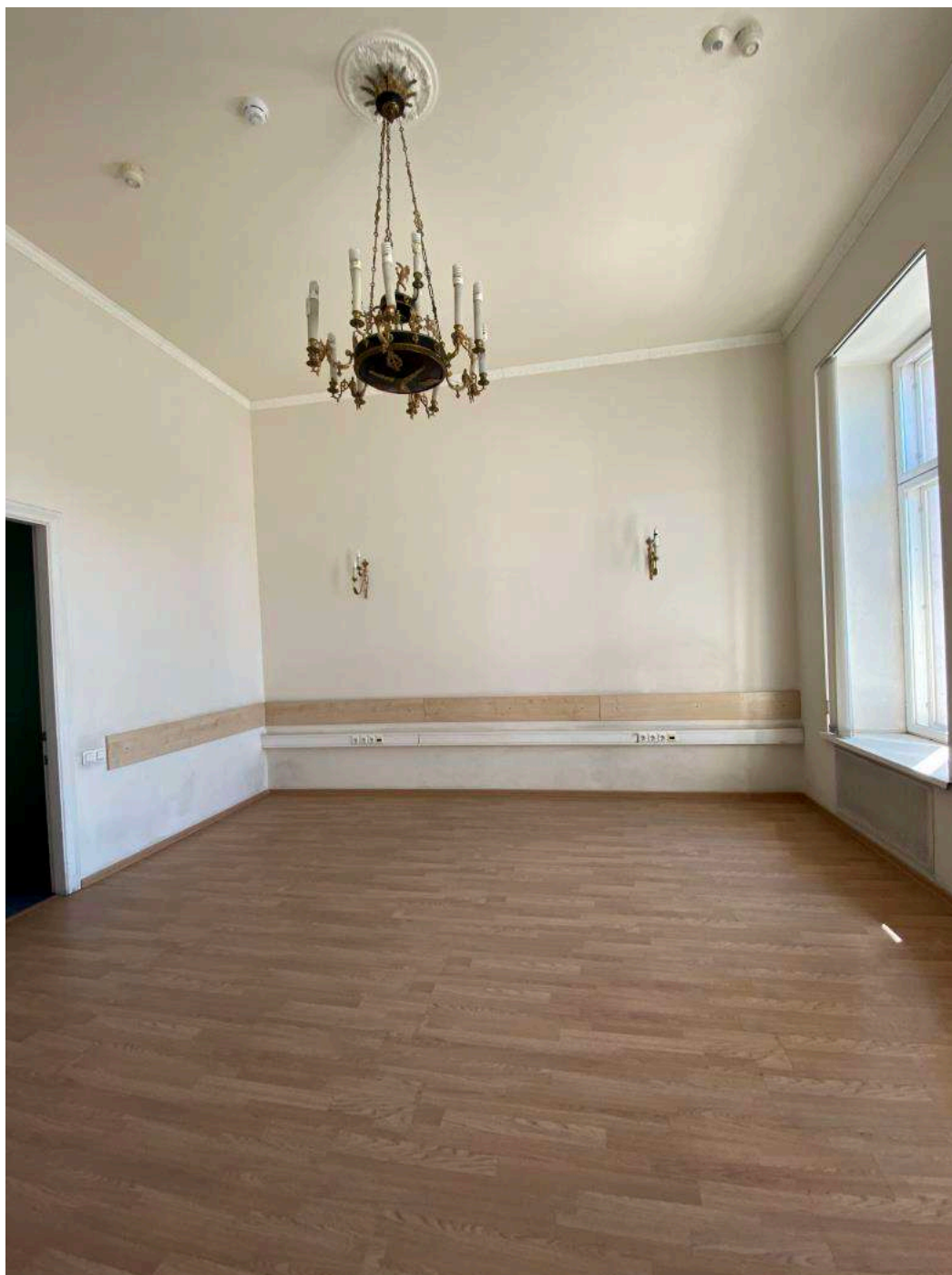
Фото 25. Общий вид части пом. 26-Н (№ 32 по ПИБ), лепная орнаментированная розетка на потолке и орнаментированная потолочная тяга.
