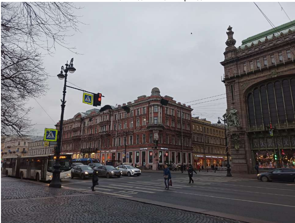
Фото 4. Общий вид на лицевые фасады объекта.
