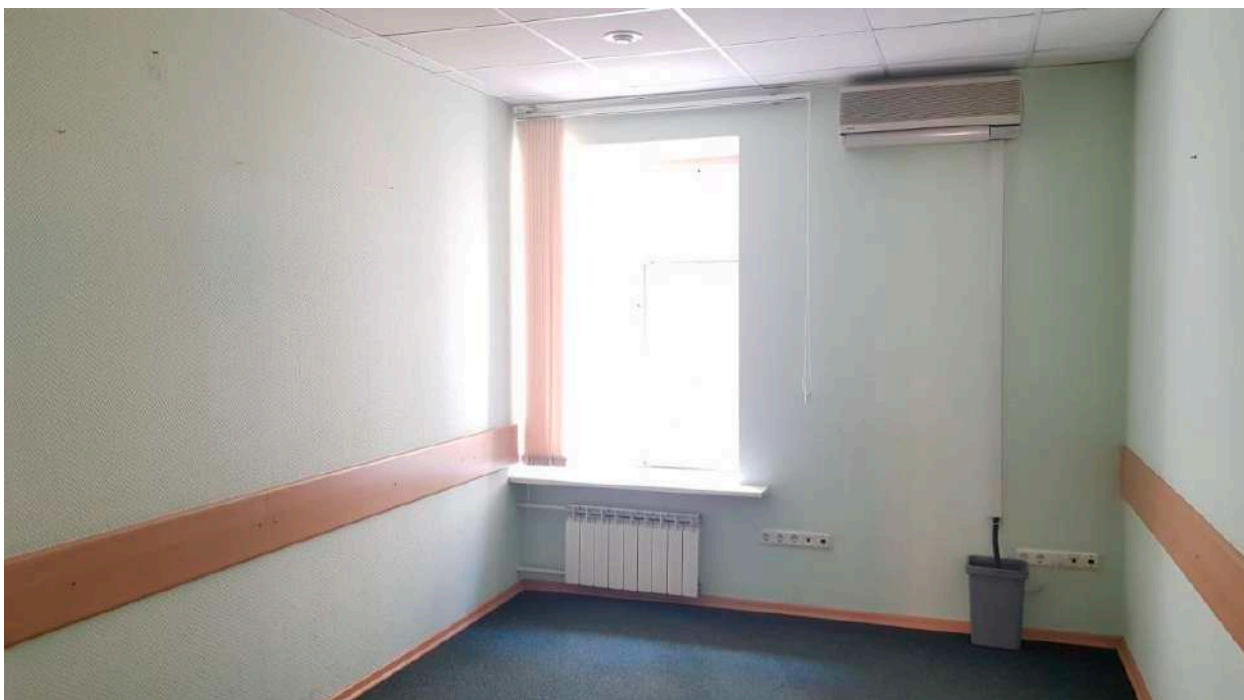
Фото 8. Общий вид части пом. 26-Н (№ 13 по ПИБ), элементы ДПИ отсутствуют.
