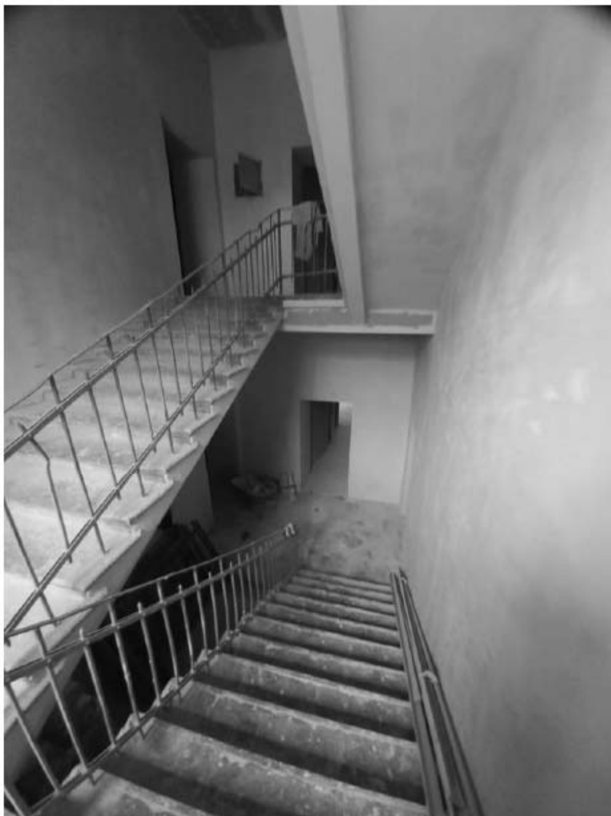
Фото 26. Лестничная клетка 2. Фото 13.03.2023 г.
