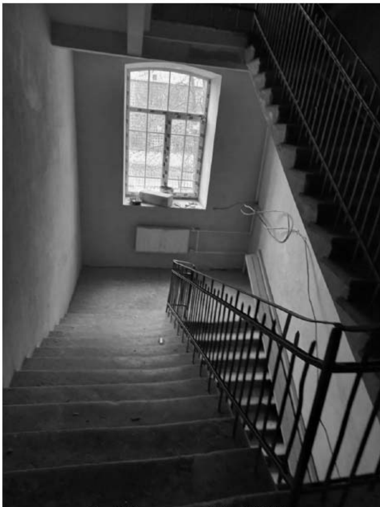
Фото 25. Лестничная клетка 1. Фото 13.03.2023 г.
