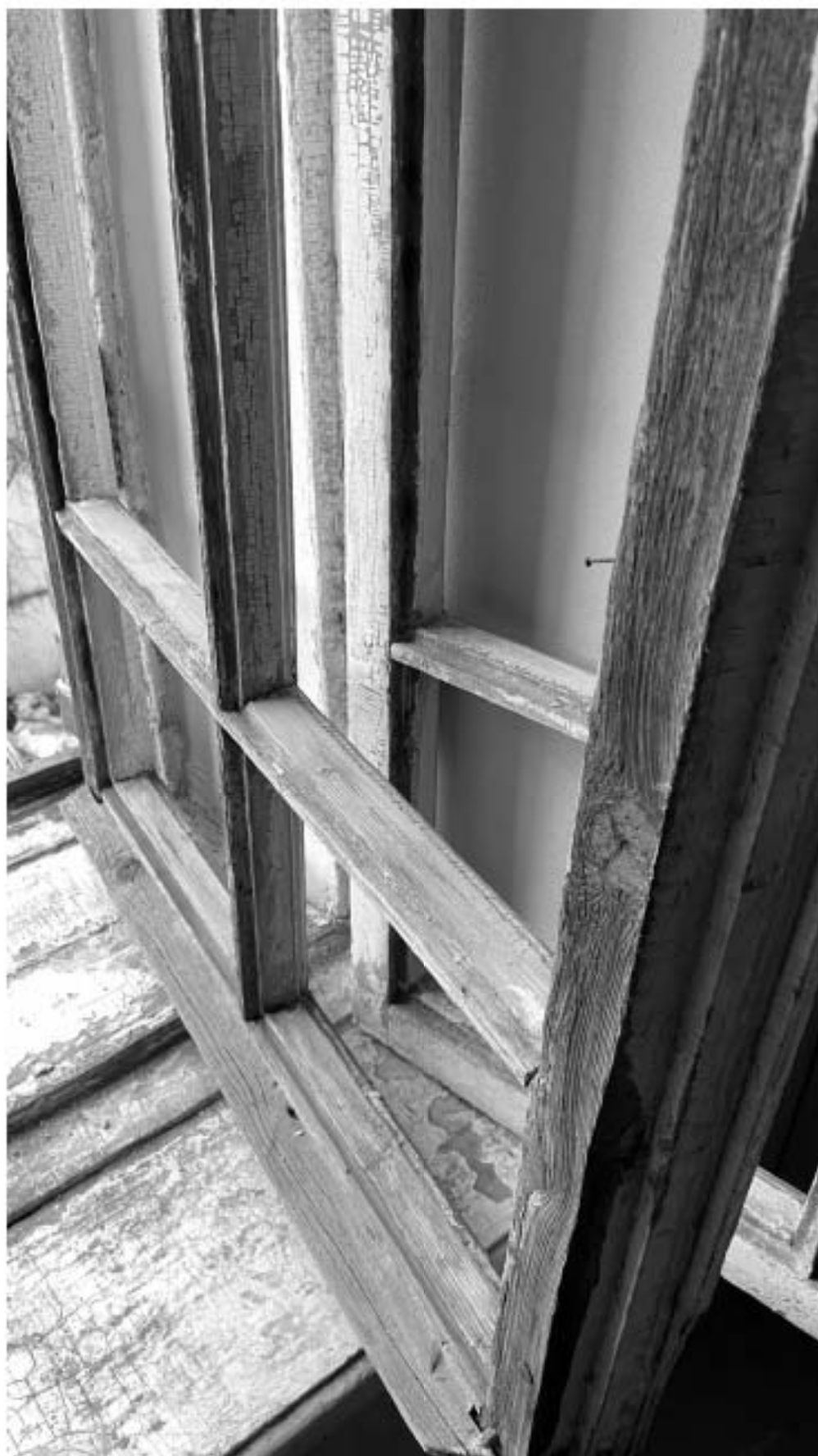
Фото 15. Фото оконного заполнения в помещении кв. 10. Фото 13.03.2023 г.
