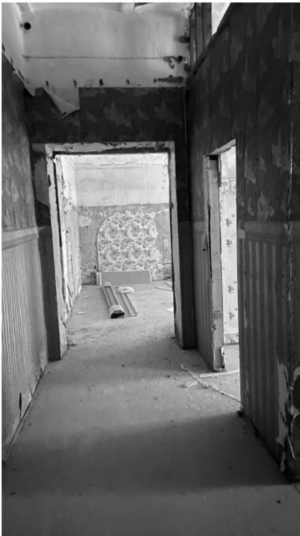
Фото 9. Вид на помещение кв. 11. Фото 13.03.2023 г.
