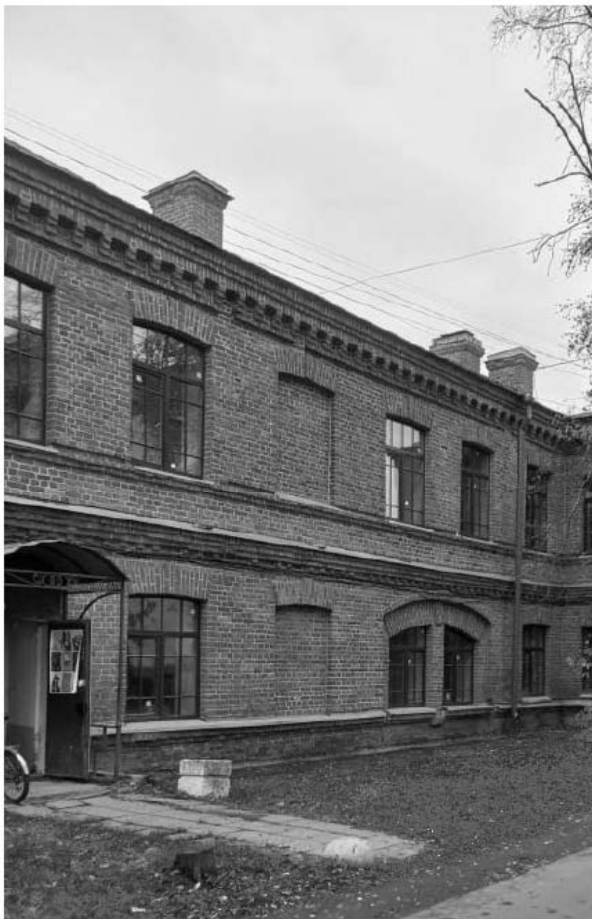
Фото 4. Общий вид здания с северной стороны. Фото 13.03.2023 г.
