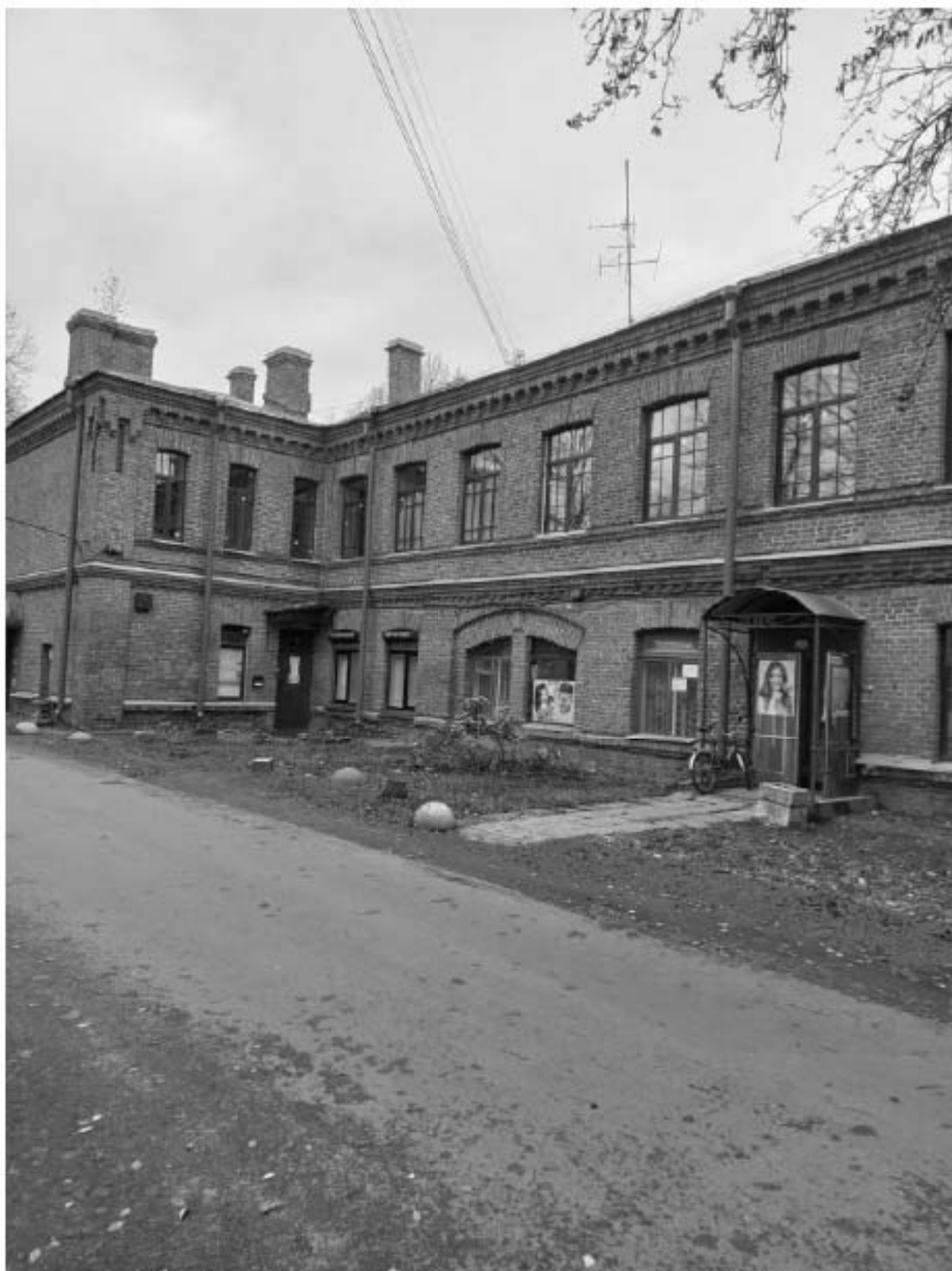
Фото 3. Общий вид здания с северной стороны. Фото 13.03.2023 г.
