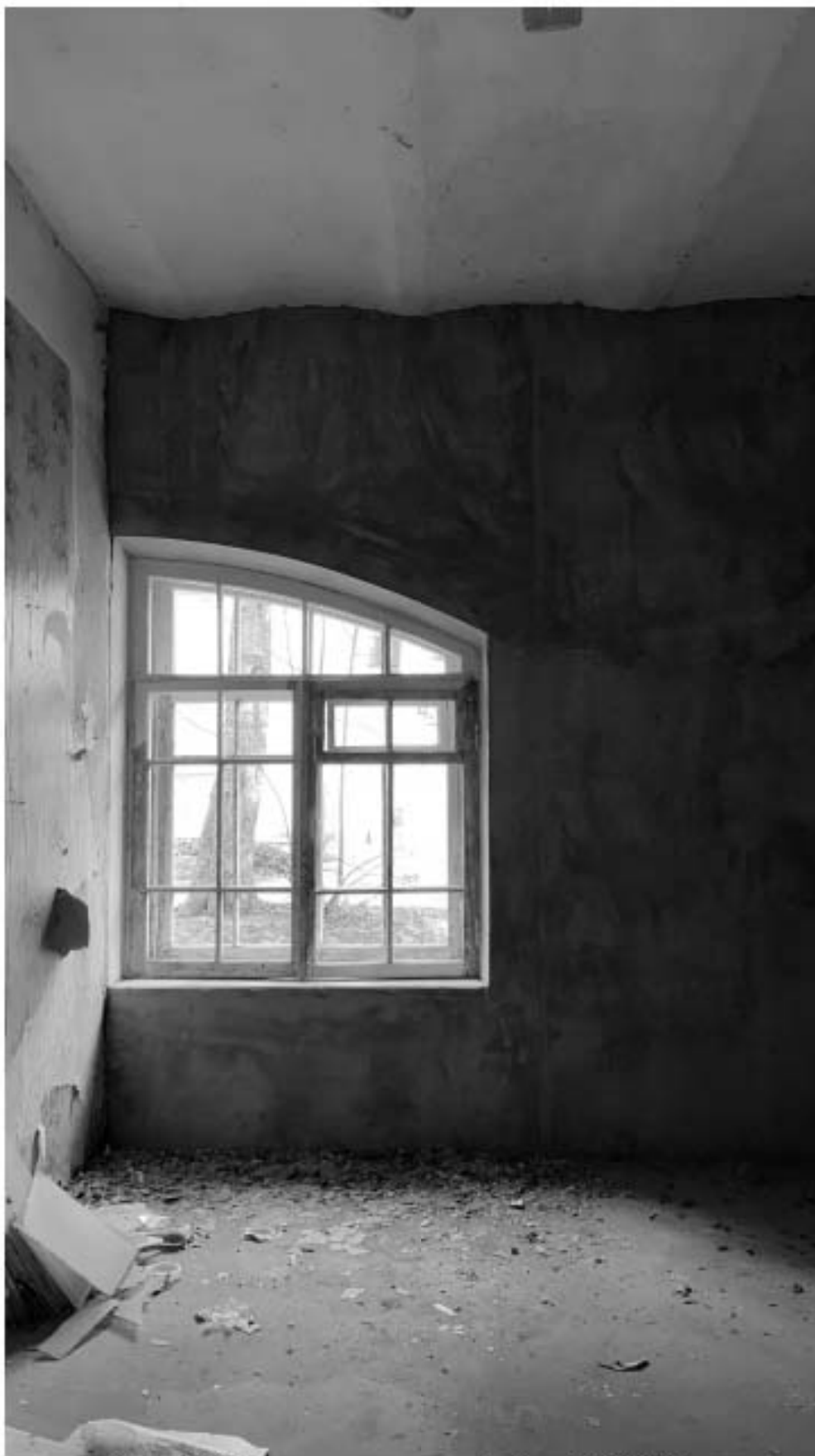
Фото 22. Вид на помещение кв. 2. Фото 13.03.2023 г.
