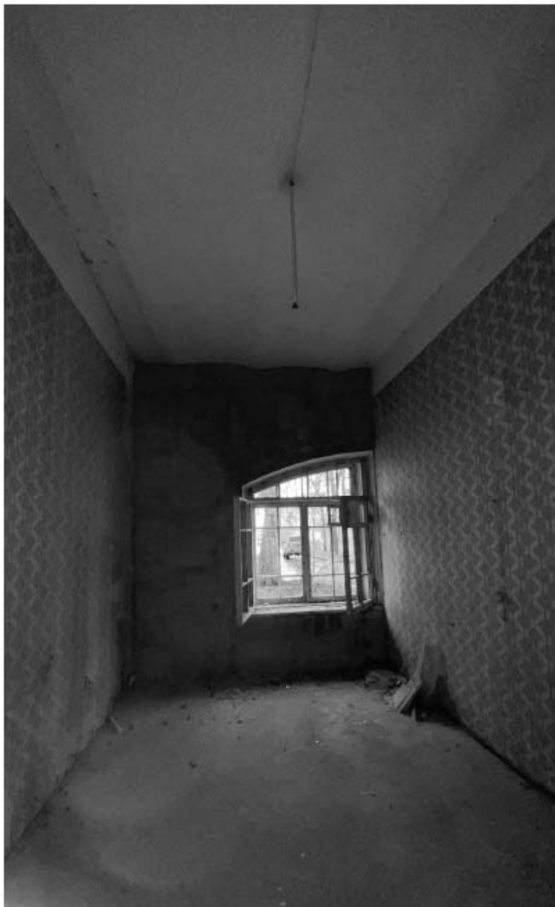
Фото 21. Вид на помещение кв. 2. Фото 13.03.2023 г.
