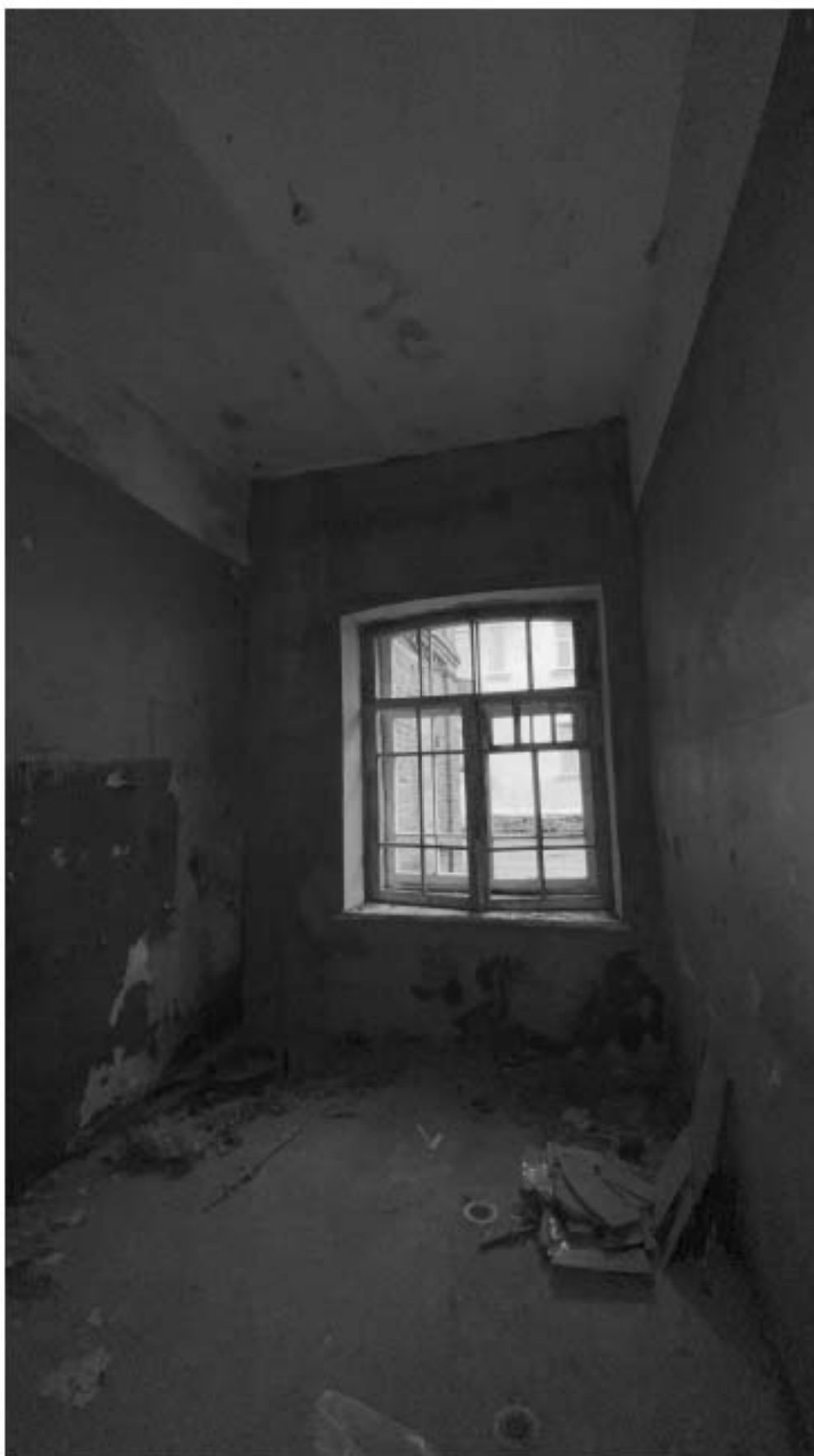
Фото 23. Вид на помещение кв. 2. Фото 13.03.2023 г.
