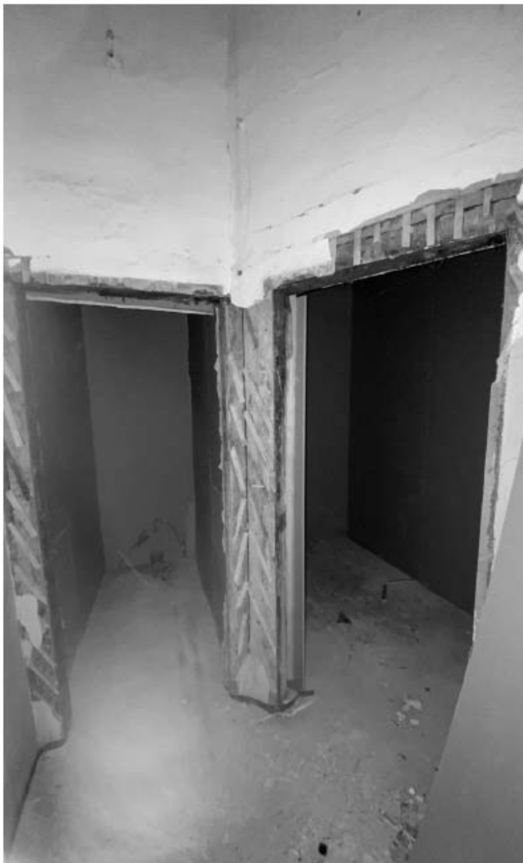
Фото 13. Вид на помещение кв. 12. Фото 13.03.2023 г.
