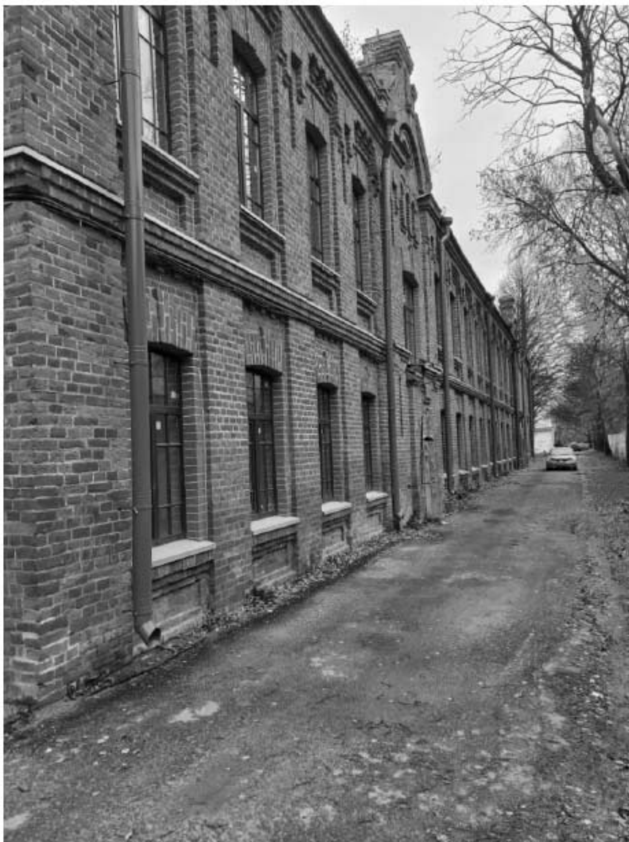
Фото 5. Общий вид здания с юго-западного угла. Фото 13.03.2023 г.
