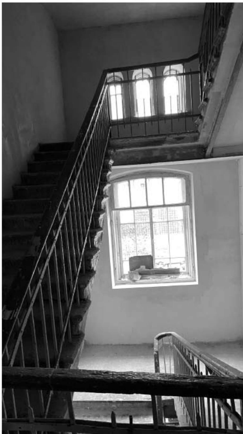
Фото 7. Лестничная клетка 2. Фото 13.03.2023 г.
