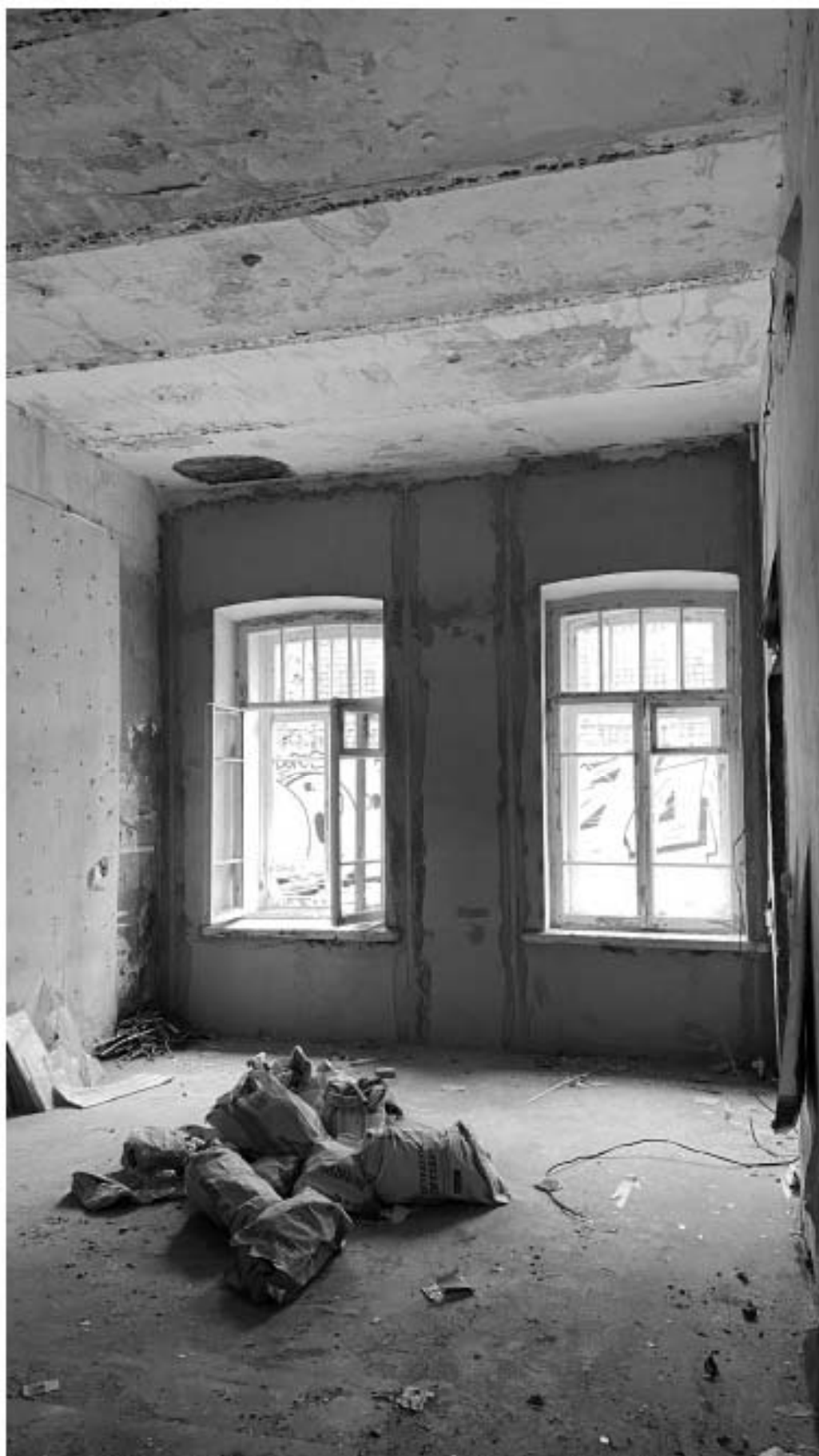
Фото 11. Вид на помещение кв. 9. Фото 13.03.2023 г.
