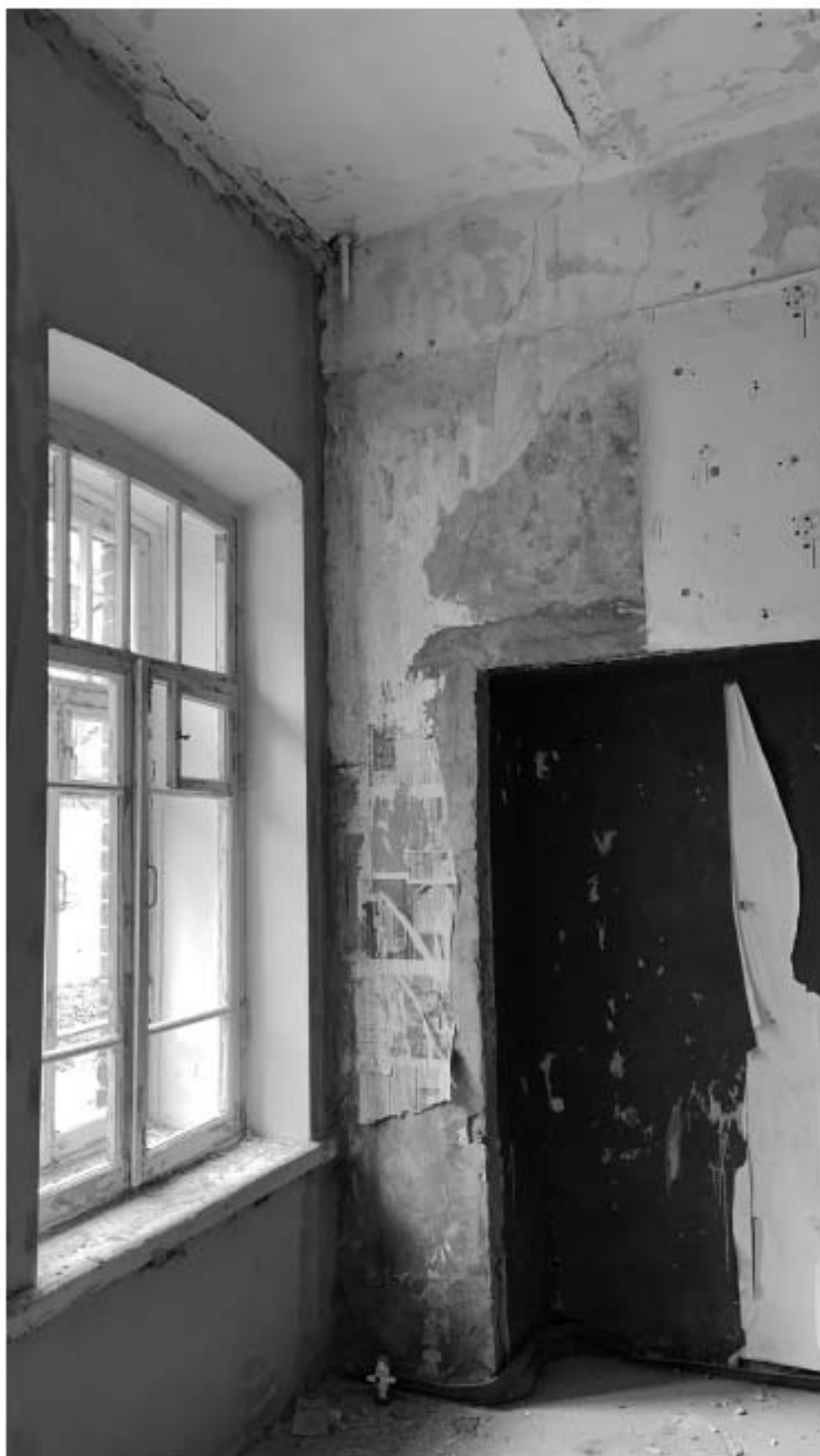
Фото 19. Вид на помещение кв. 7. Фото 13.03.2023 г.
