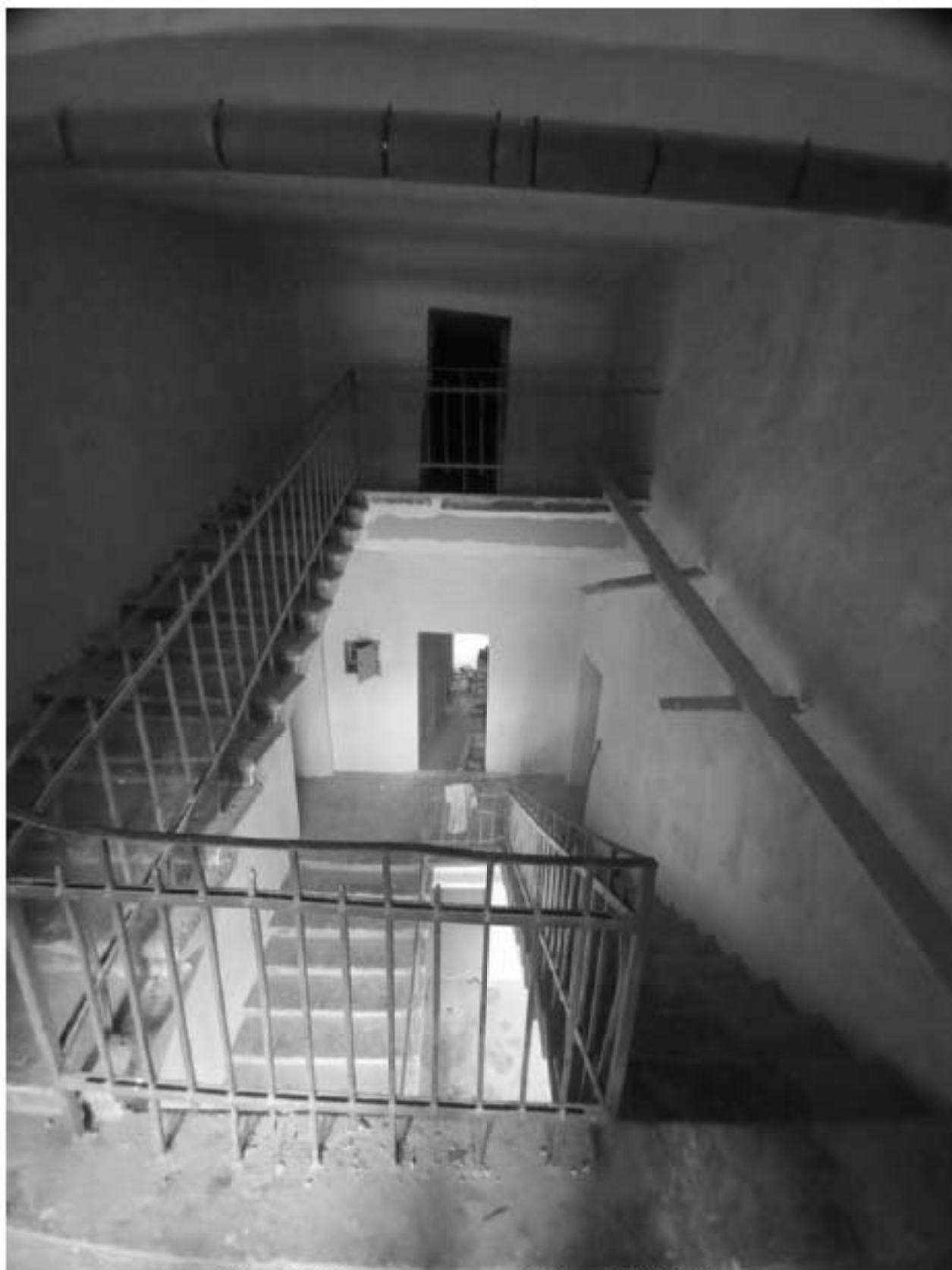
Фото 27. Лестничная клетка 1. Фото 13.03.2023 г.
