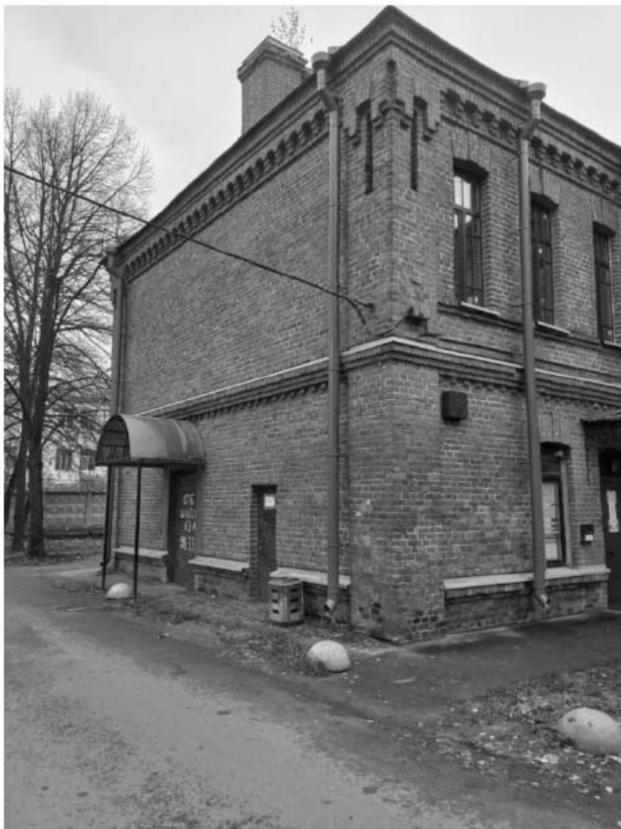
Фото 1. Общий вид здания с северо-восточного угла. Фото 13.03.2023 г.
