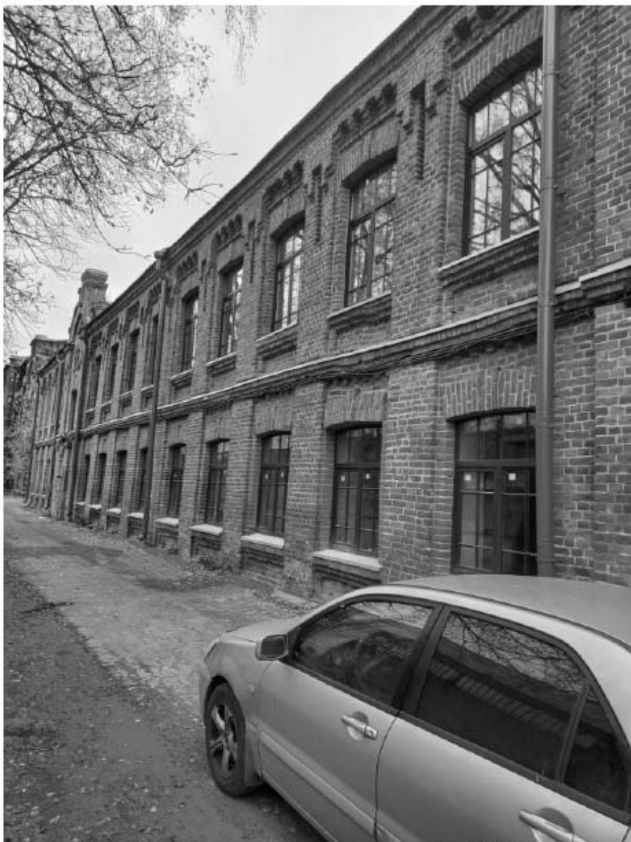
Фото 6. Общий вид здания с юго-восточного угла. Фото 13.03.2023 г.
