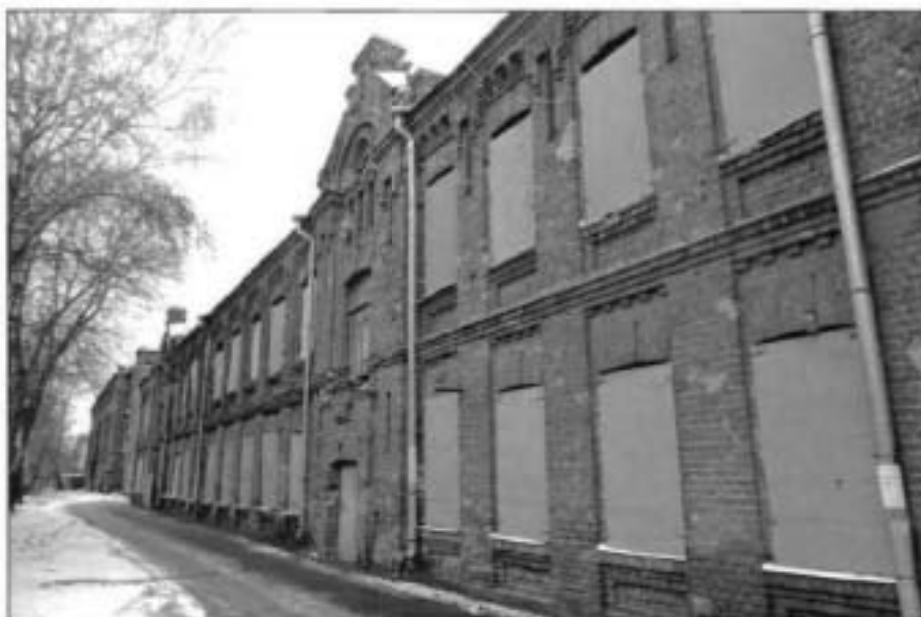
2. Общий вид с юго-востока.
