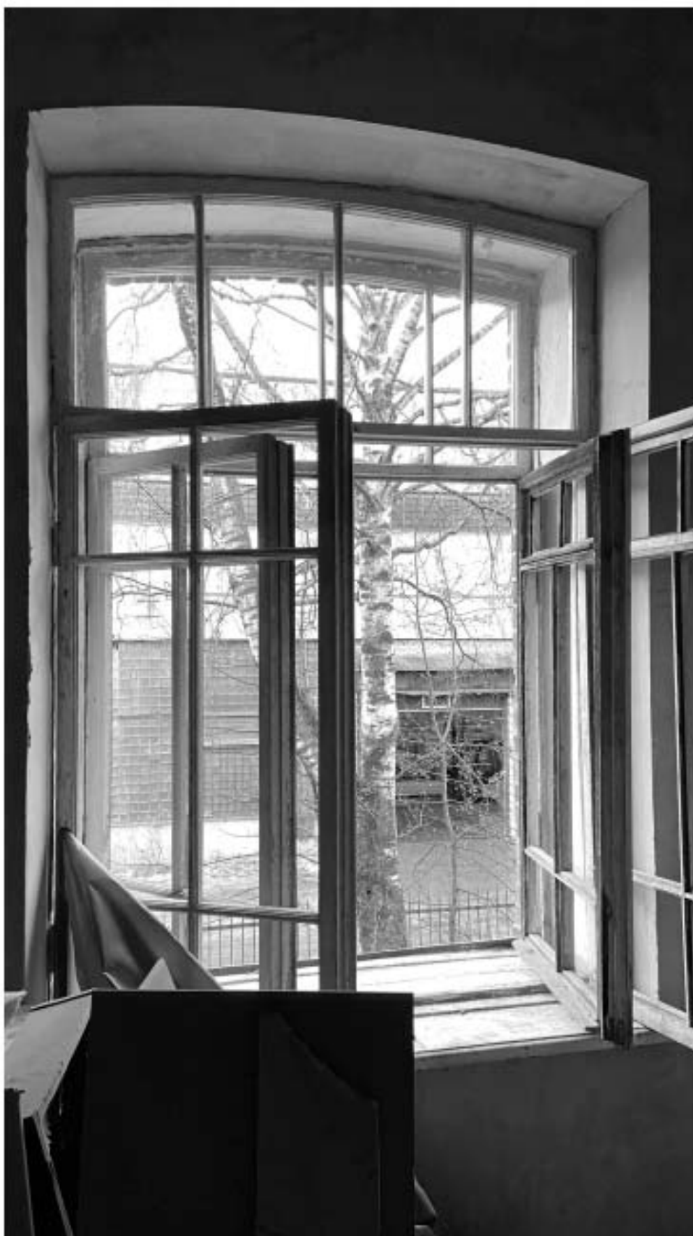
Фото 16. Фото оконного заполнения в помещении кв. 5. Фото 13.03.2023 г.
