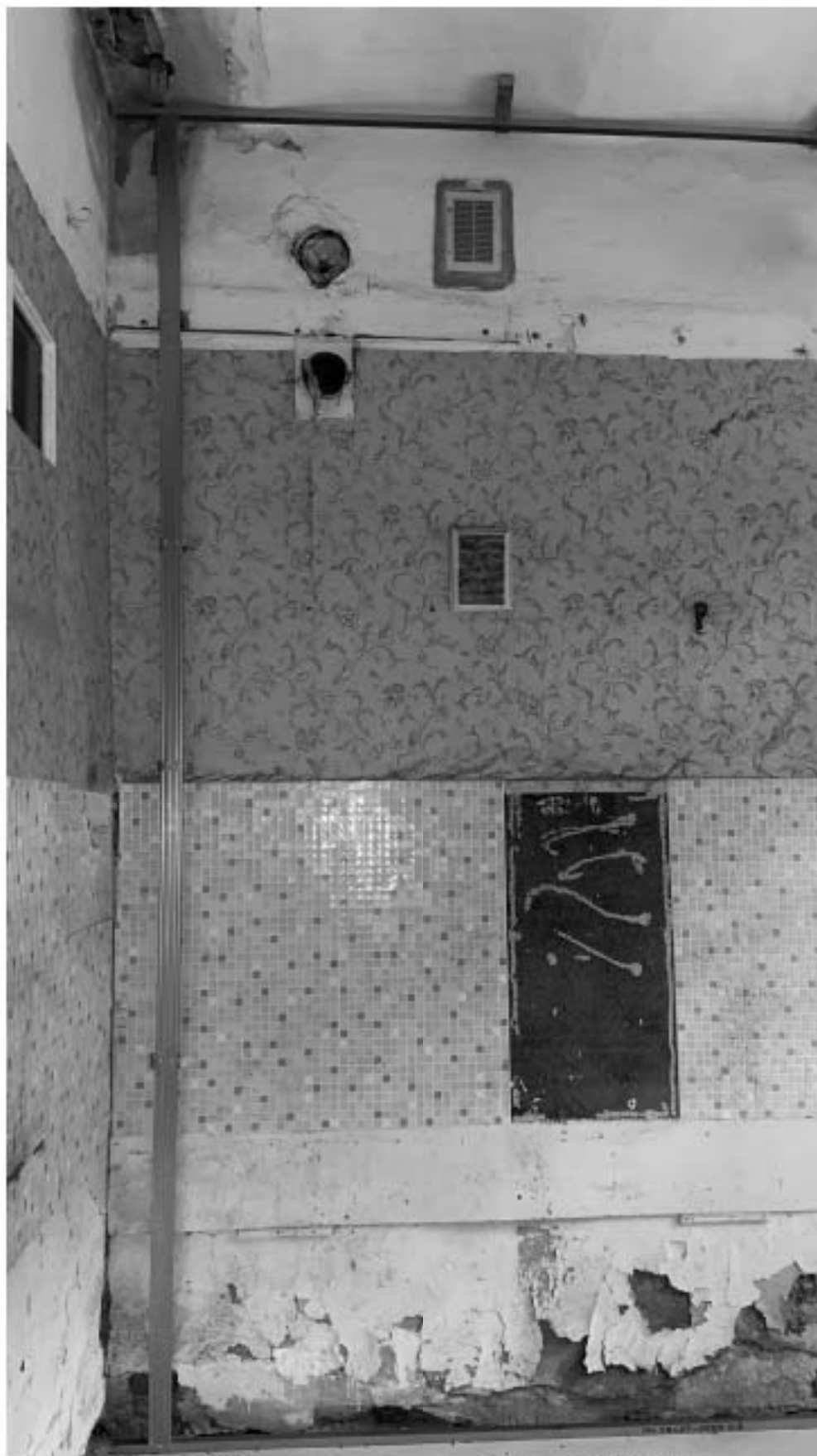
Фото 14. Вид на помещение кв. 6. Фото 13.03.2023 г.
