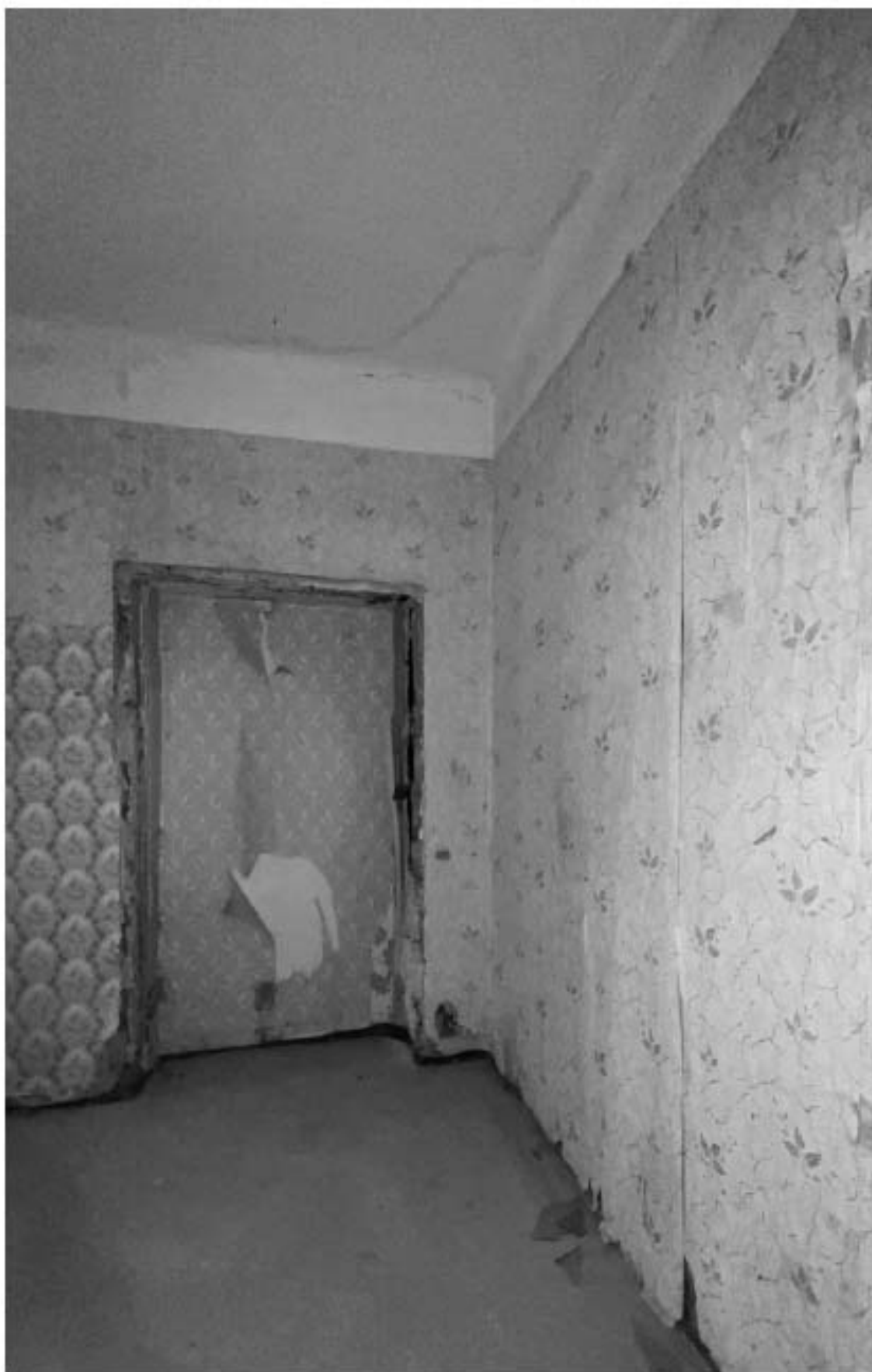
Фото 20. Вид на помещение кв. 2. Фото 13.03.2023 г.
