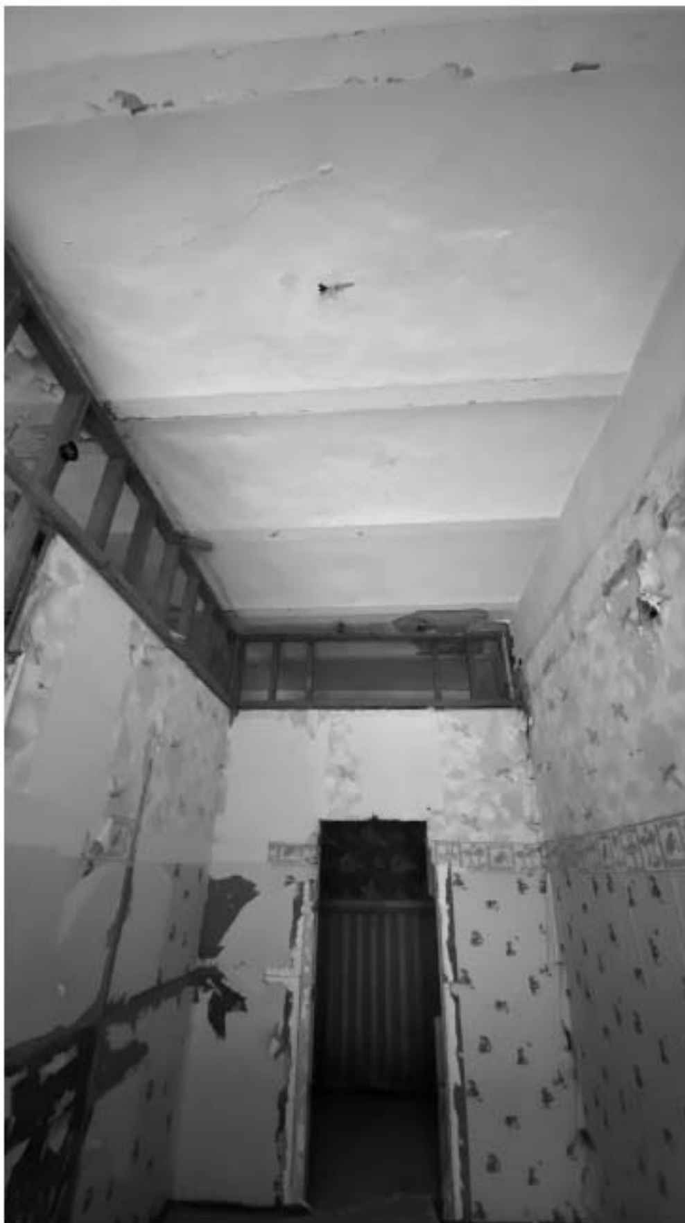
Фото 24. Вид на помещение кв. 10. Фото 13.03.2023 г.
