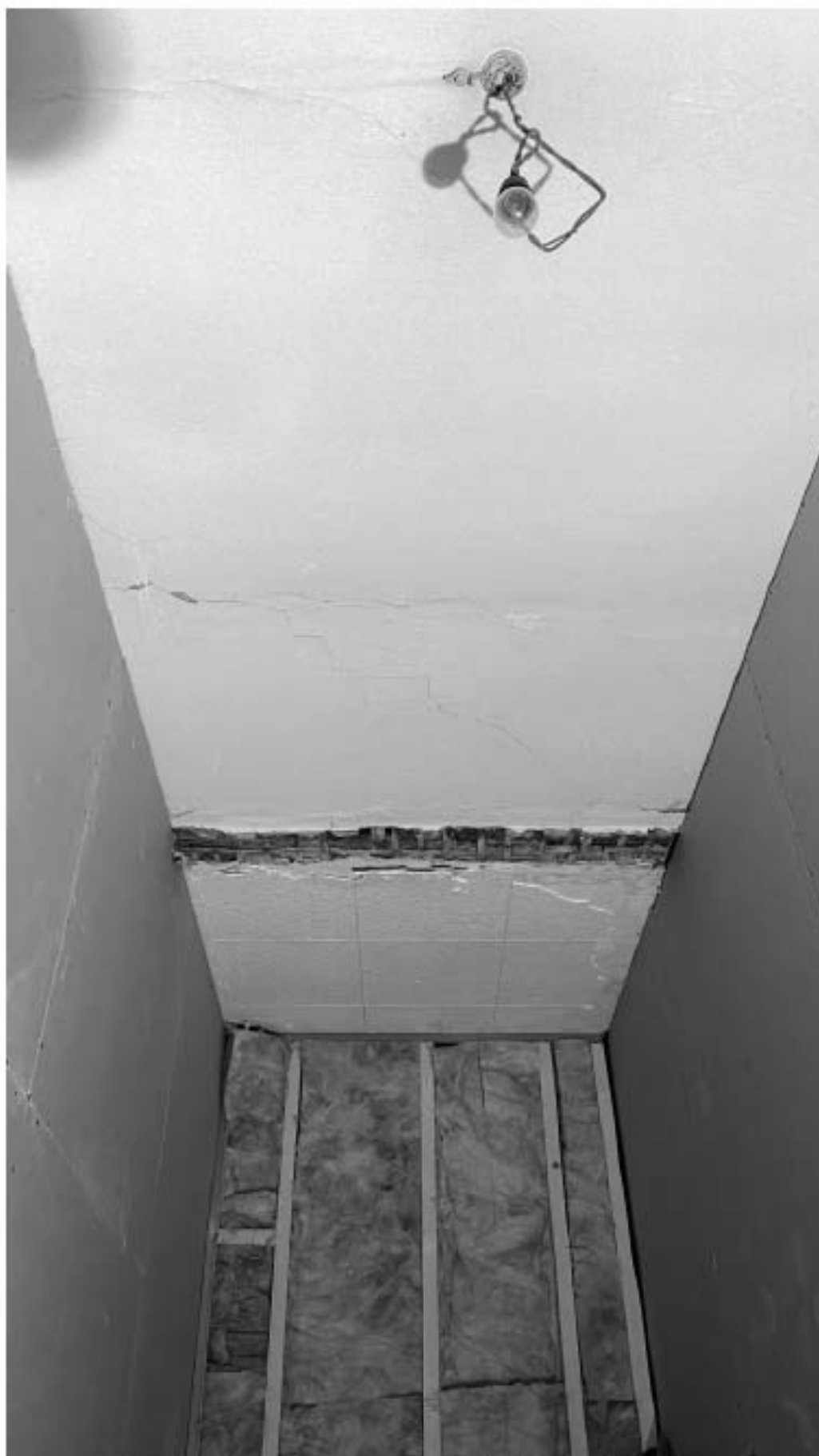
Фото 12. Вид на помещение кв. 12. Фото 13.03.2023 г.
