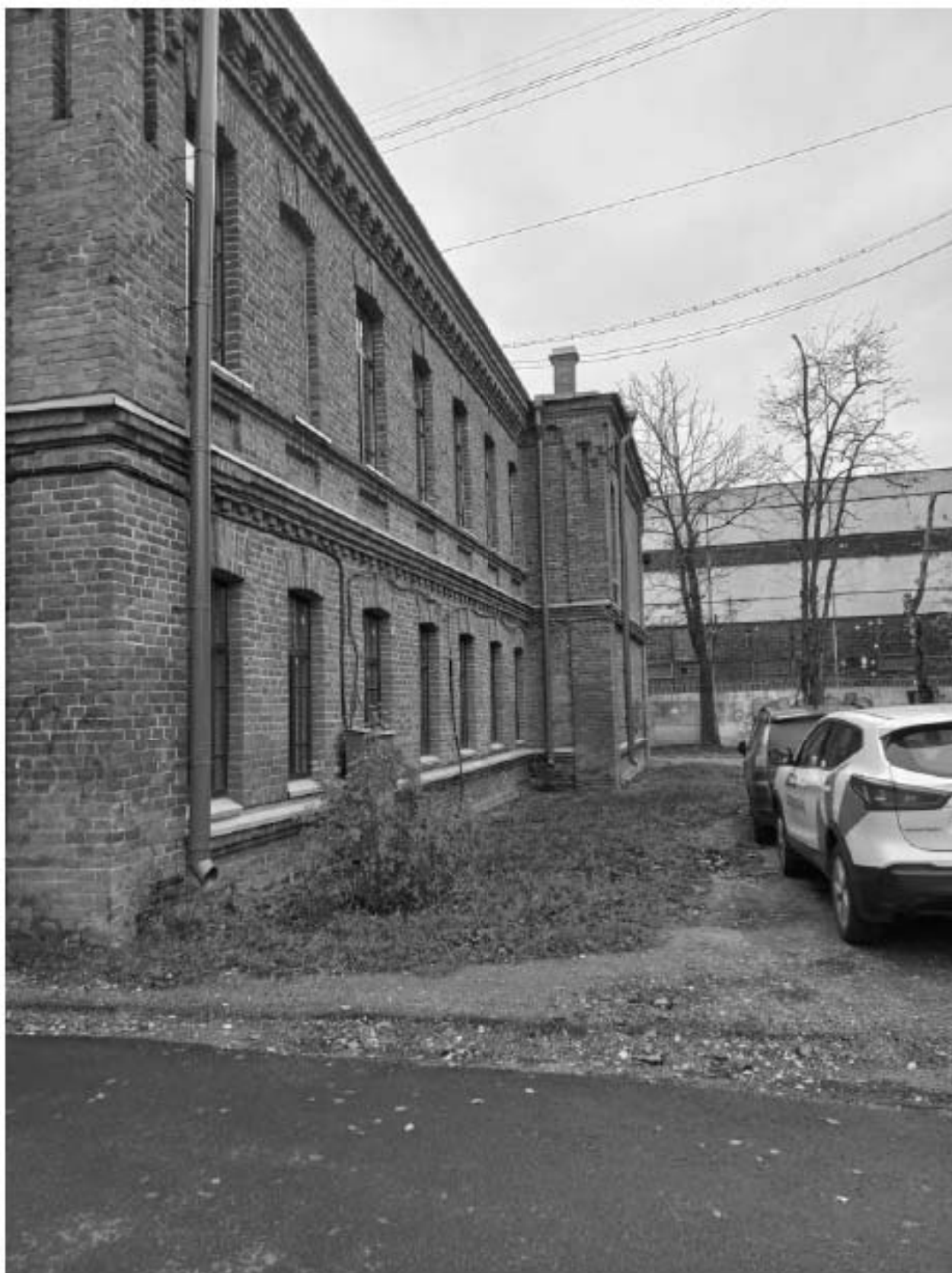
Фото 2. Общий вид здания с северо-западного угла. Фото 13.03.2023 г.
