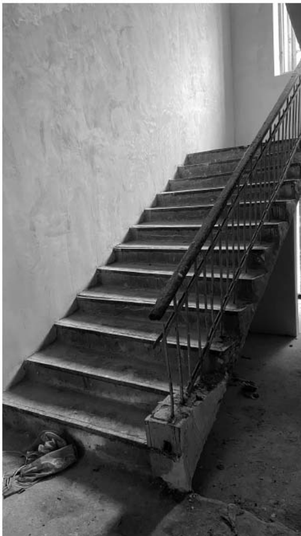
Фото 8. Лестничная клетка 2. Фото 13.03.2023 г.
