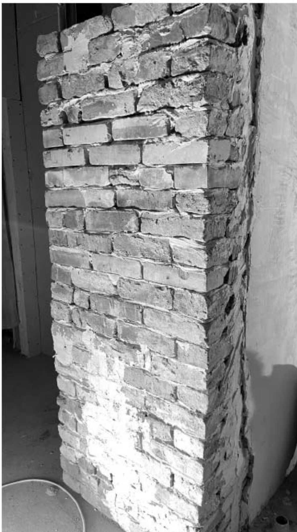
Фото 18. Вид на помещение 4-Н. Фото 13.03.2023 г.
