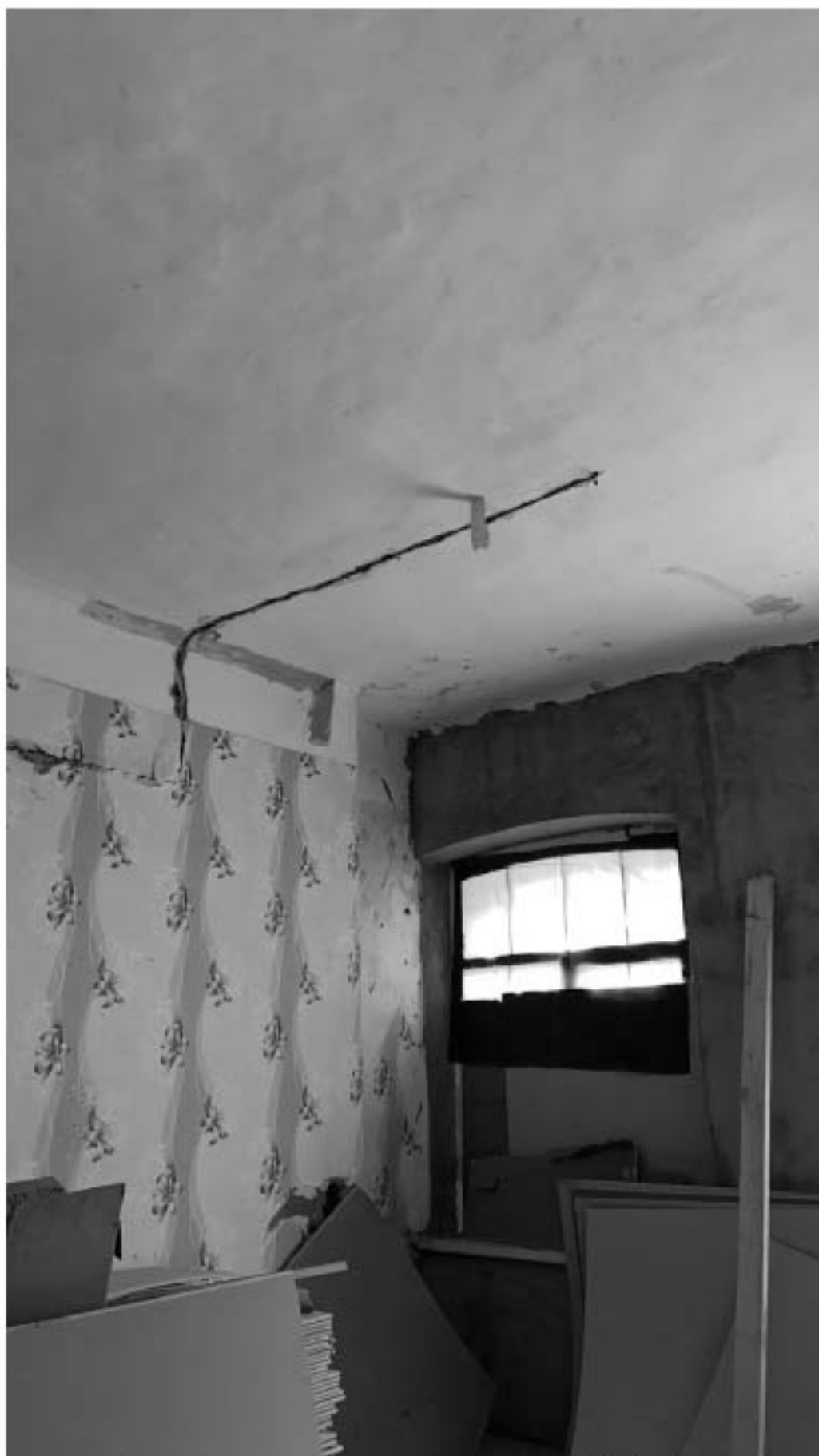
Фото 10. Вид на помещение кв. 11. Фото 13.03.2023 г.
