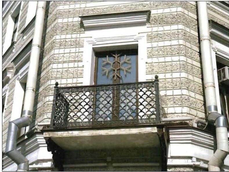
3. Балкон со стороны лицевого юго-восточного фасада.
