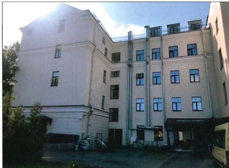
4. Вид на дворовый фасад с северо-западной стороны.
