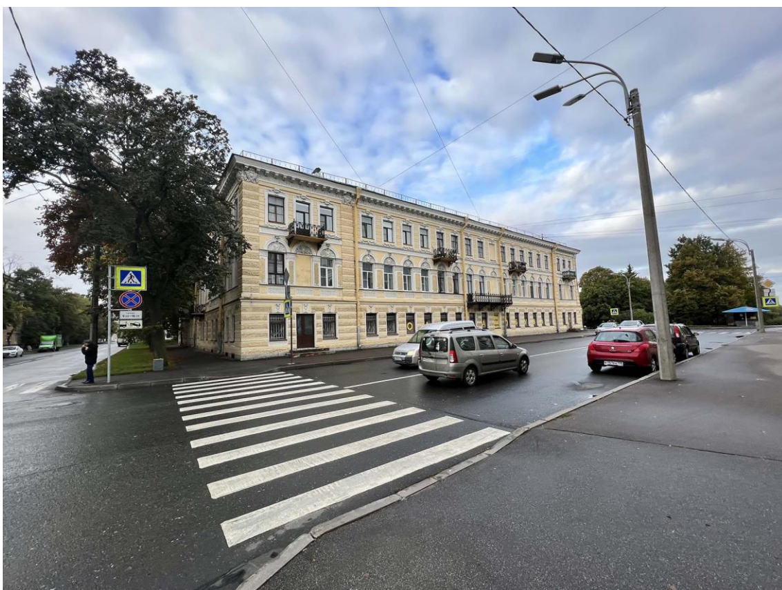
Фото 6. Объект культурного наследия регионального значения «Жилой дом купца Дружинина», Санкт-Петербург, г. Кронштадт, Интернациональная ул. 10/Аммермана ул., 15. Общий вид здания с перекрестка ул. Аммермана и Интернациональной, с востока. Дата съемки: 21.09.2022 г. Автор съемки: Куваева Ю.П.
