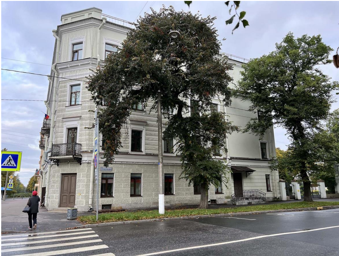
Фото 3. Объект культурного наследия регионального значения «Жилой дом», Санкт-Петербург, г. Кронштадт, Интернациональная ул., 13/Аммермана ул., 13. Общий вид здания с востока, со стороны ул. Аммермана. Дата съемки: 21.09.2022 г. Автор съемки: Куваева Ю.П.
