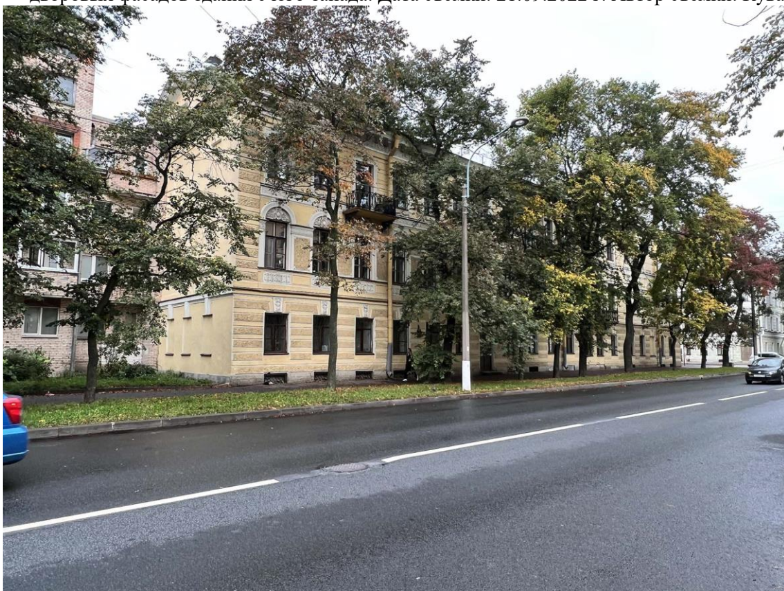
Фото 10. Объект культурного наследия регионального значения «Жилой дом купца Дружинина», Санкт-Петербург, г. Кронштадт, Интернациональная ул. 10/Аммермана ул., 15. Общий вид восточного крыла здания с ул. Аммермана, с юго-востока. Дата съемки: 21.09.2022 г. Автор съемки: Куваева Ю.П.
