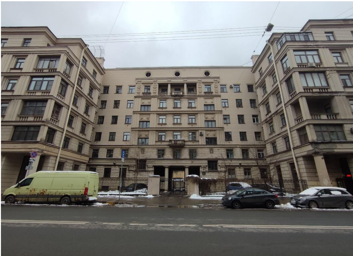
3. Выявленный объект культурного наследия «Жилой дом (с оградой)», по адресу: г. Санкт-Петербург, 8-я Советская улица, дом 9-13, литера А. Общий вид центральной части лицевого фасада по 8-й Советской улице.
