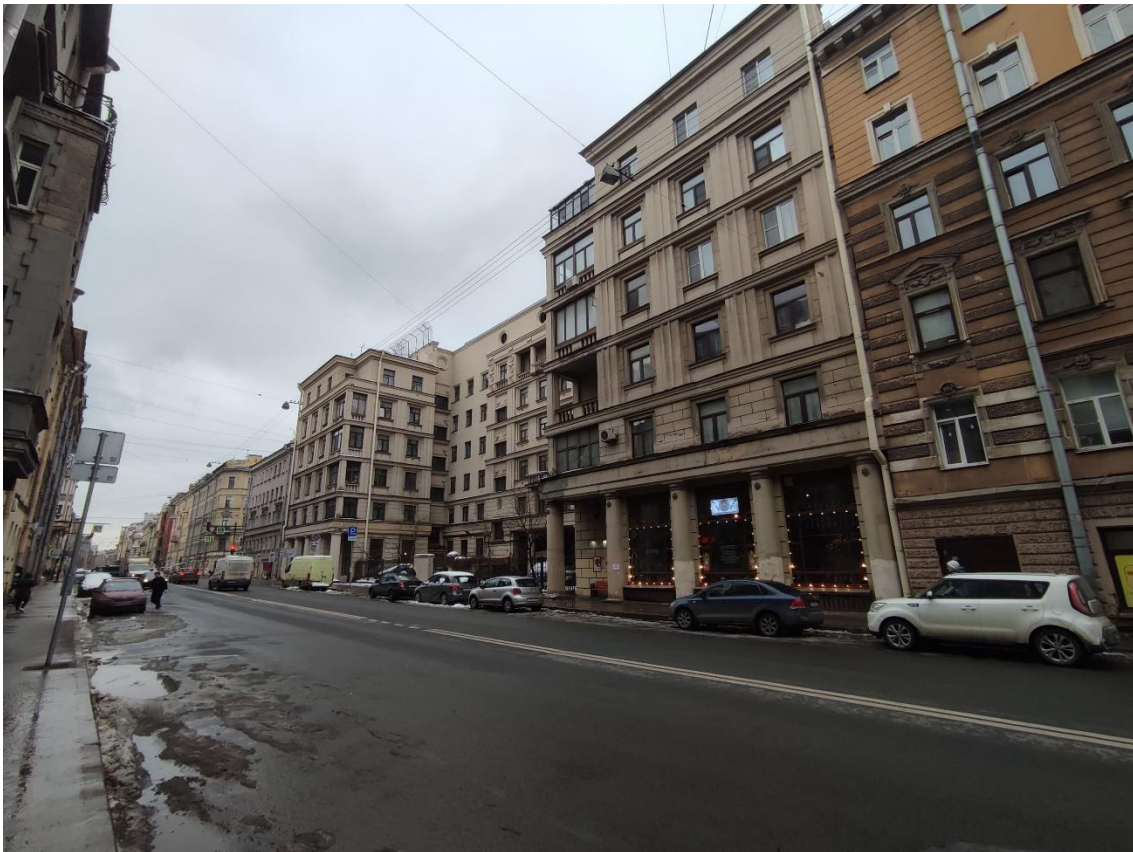
7. Выявленный объект культурного наследия «Жилой дом (с оградой)», по адресу: г. Санкт-Петербург, 8-я Советская улица, дом 9-13, литера А. Общий вид здания в перспективе 8-й Советской улицы.
