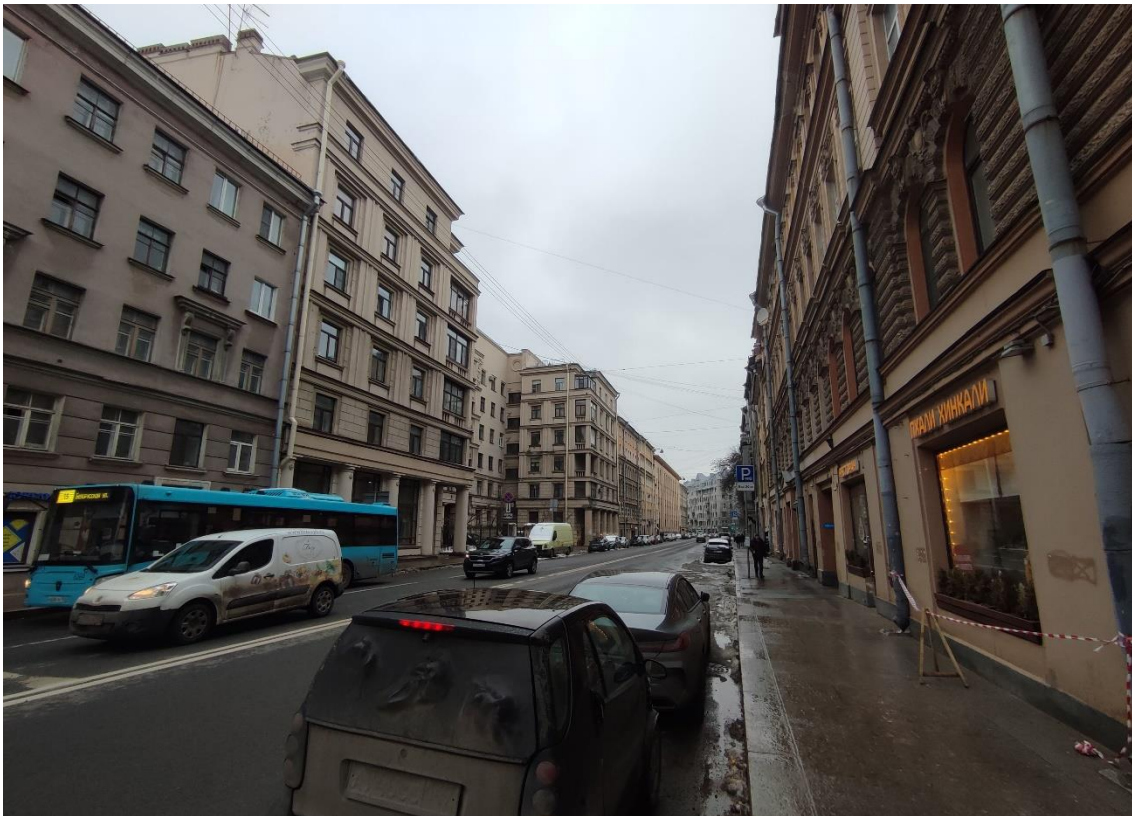
1. Выявленный объект культурного наследия «Жилой дом (с оградой)», по адресу: г. Санкт-Петербург, 8-я Советская улица, дом 9-13, литера А. Общий вид от пересечения Суворовского проспекта и 8-й Советской улицы.
