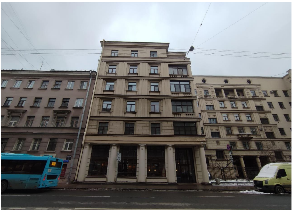
2. Выявленный объект культурного наследия «Жилой дом (с оградой)», по адресу: г. Санкт-Петербург, 8-я Советская улица, дом 9-13, литера А. Общий вид восточной части лицевого фасада по 8-й Советской улице.
