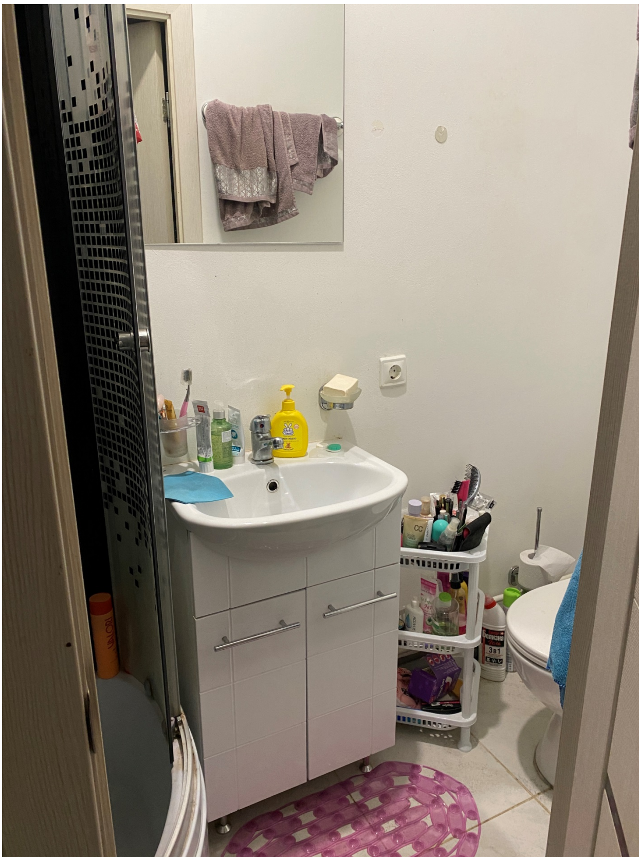
Фото 35. Вид на помещение квартиры № 21 объекта культурного наследия
