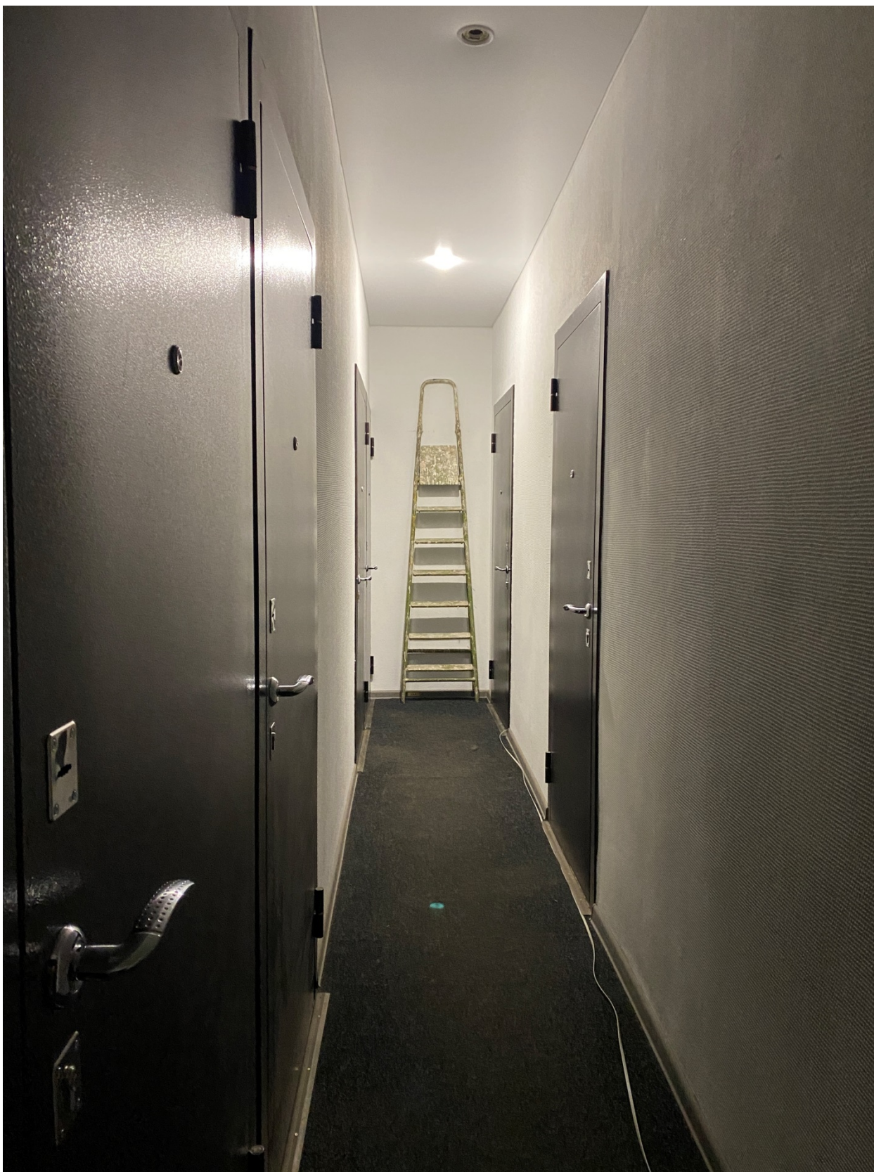
Фото 26. Вид на помещение квартиры № 21 объекта культурного наследия
