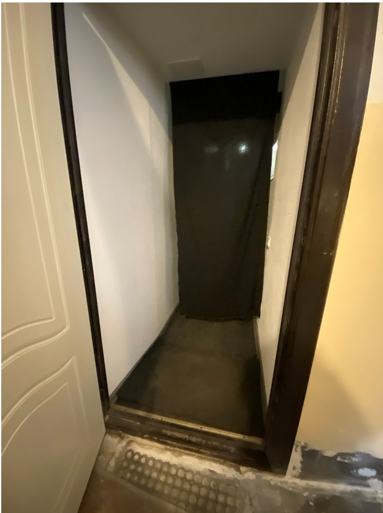
Фото 25. Вид на помещение квартиры № 21 объекта культурного наследия
