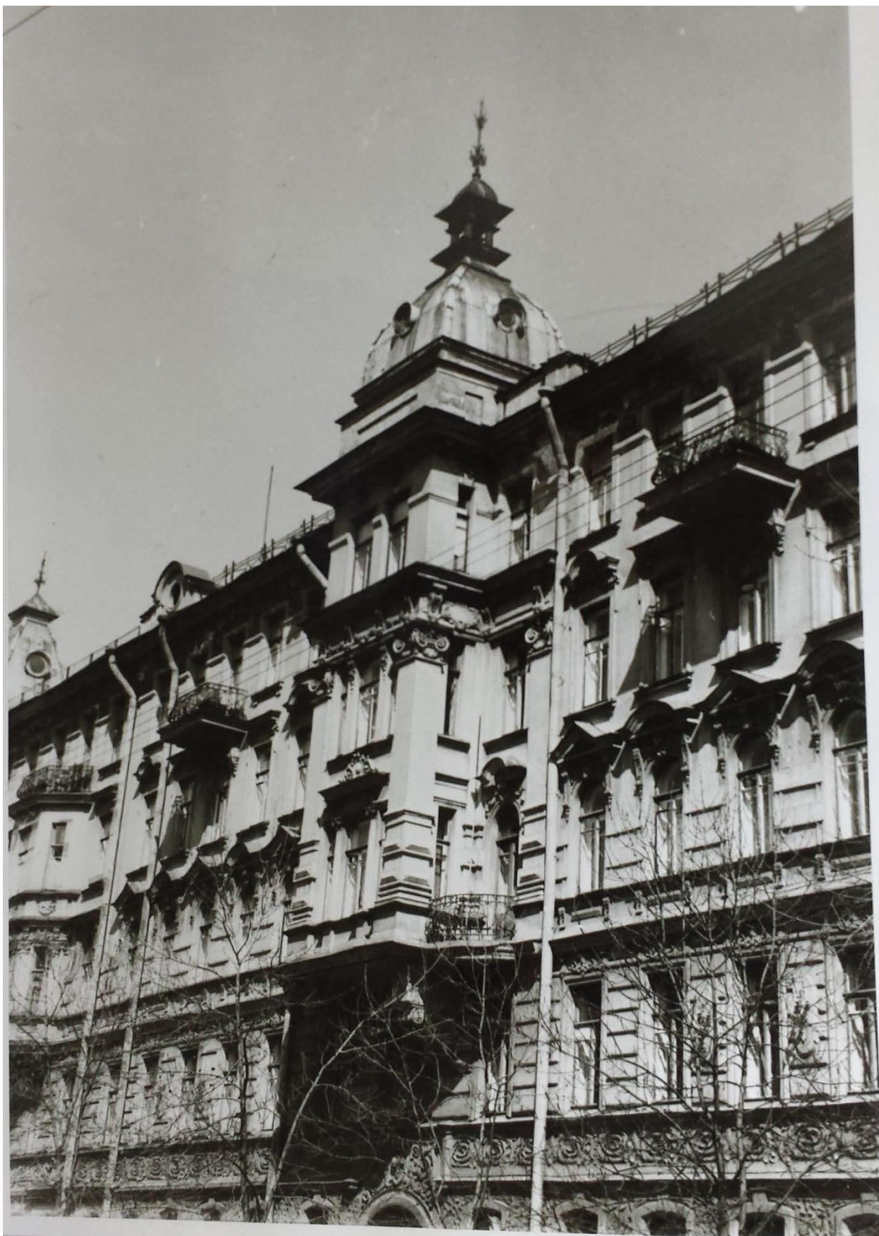
52. Фотография фасада здания по адресу: Санкт-Петербург, 12-я линия, д. 31. 1978 г. Архив КГИОП, б/н
