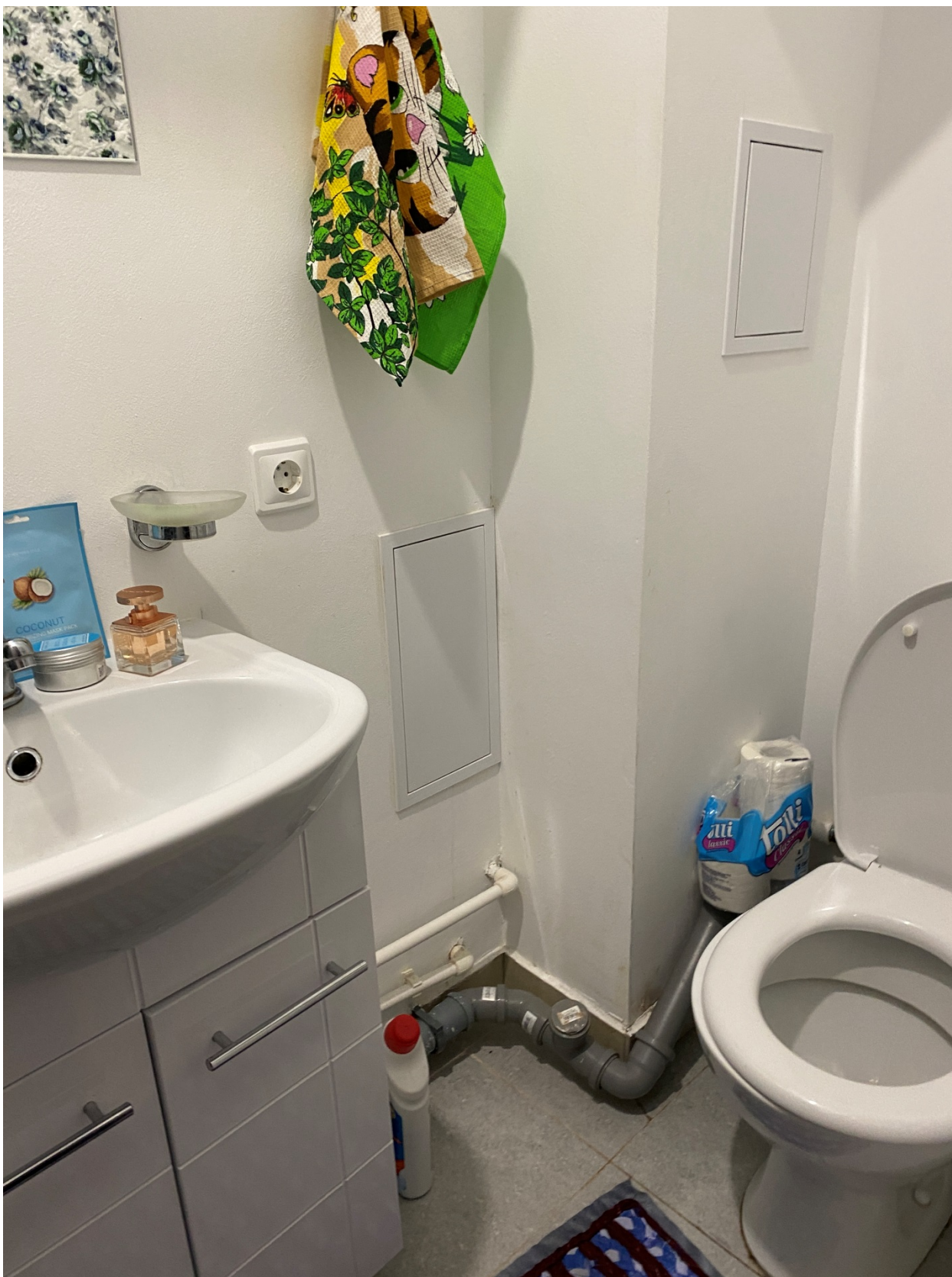
Фото 31. Вид на помещение квартиры № 21 объекта культурного наследия
