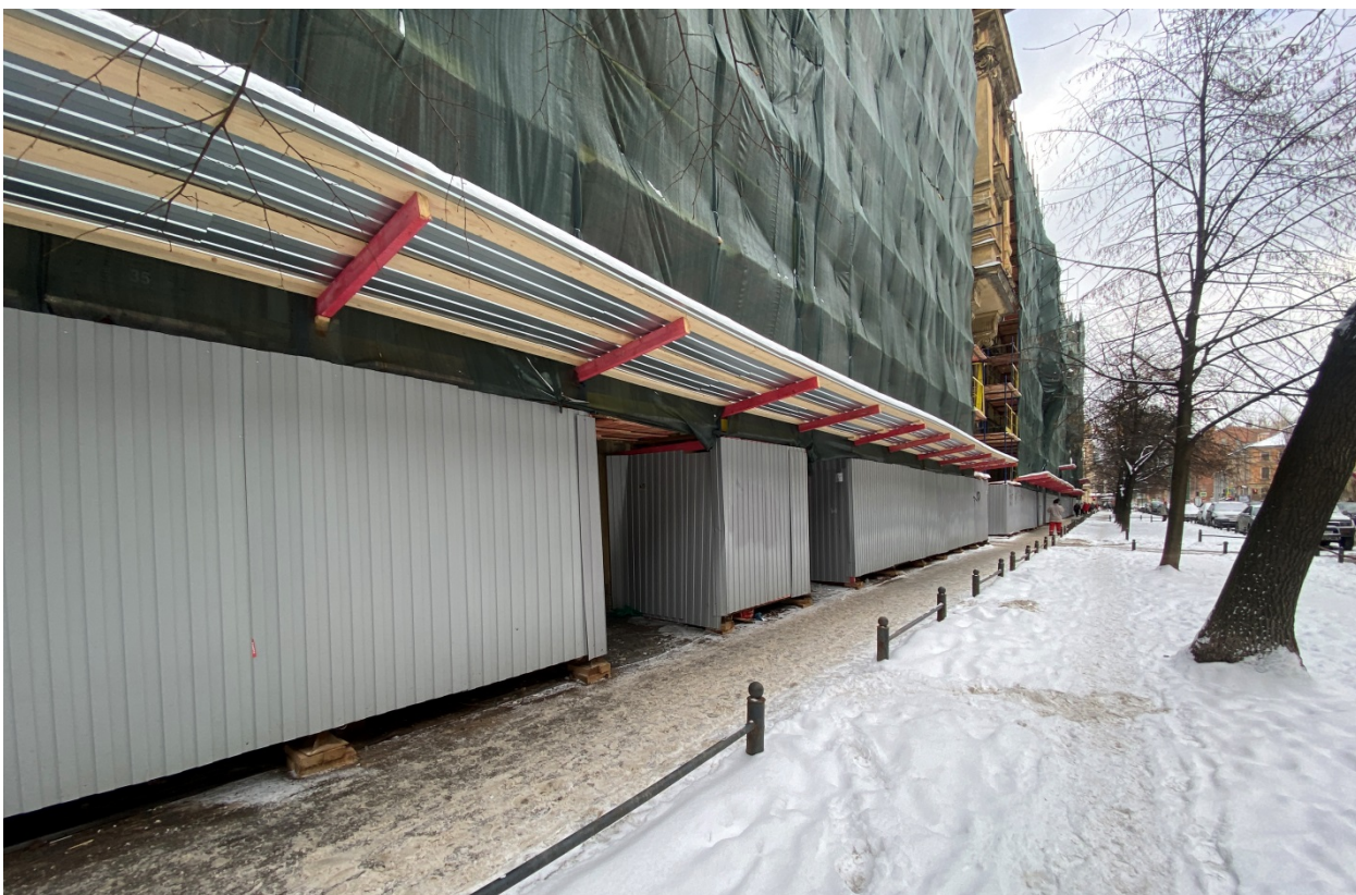
Фото 8. Фрагмент лицевого фасада объекта культурного наследия по 12-й линии В.О.
