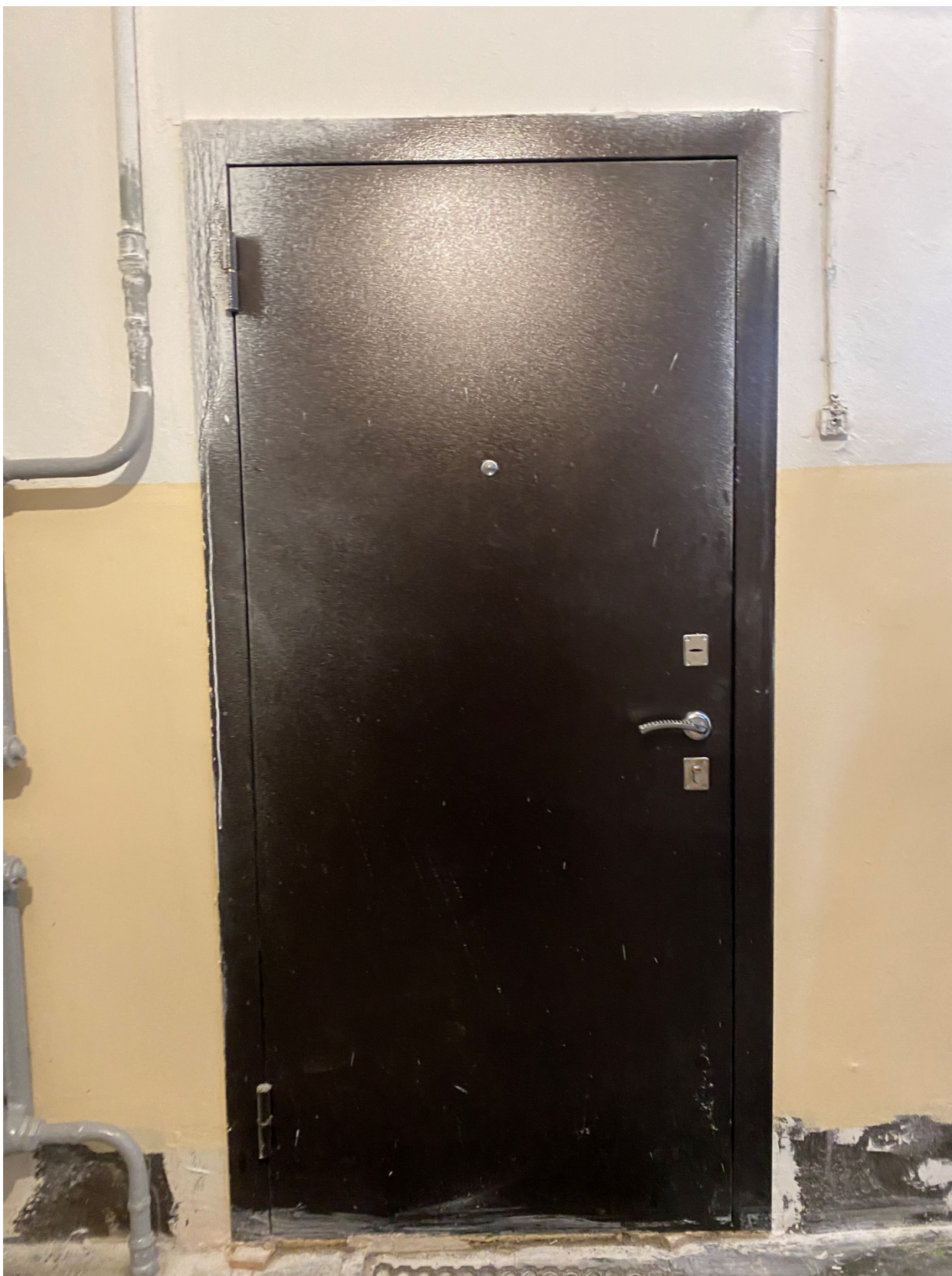
Фото 24. Вид на входное дверное заполнение квартиры № 21, расположенной в части объекта культурного наследия
