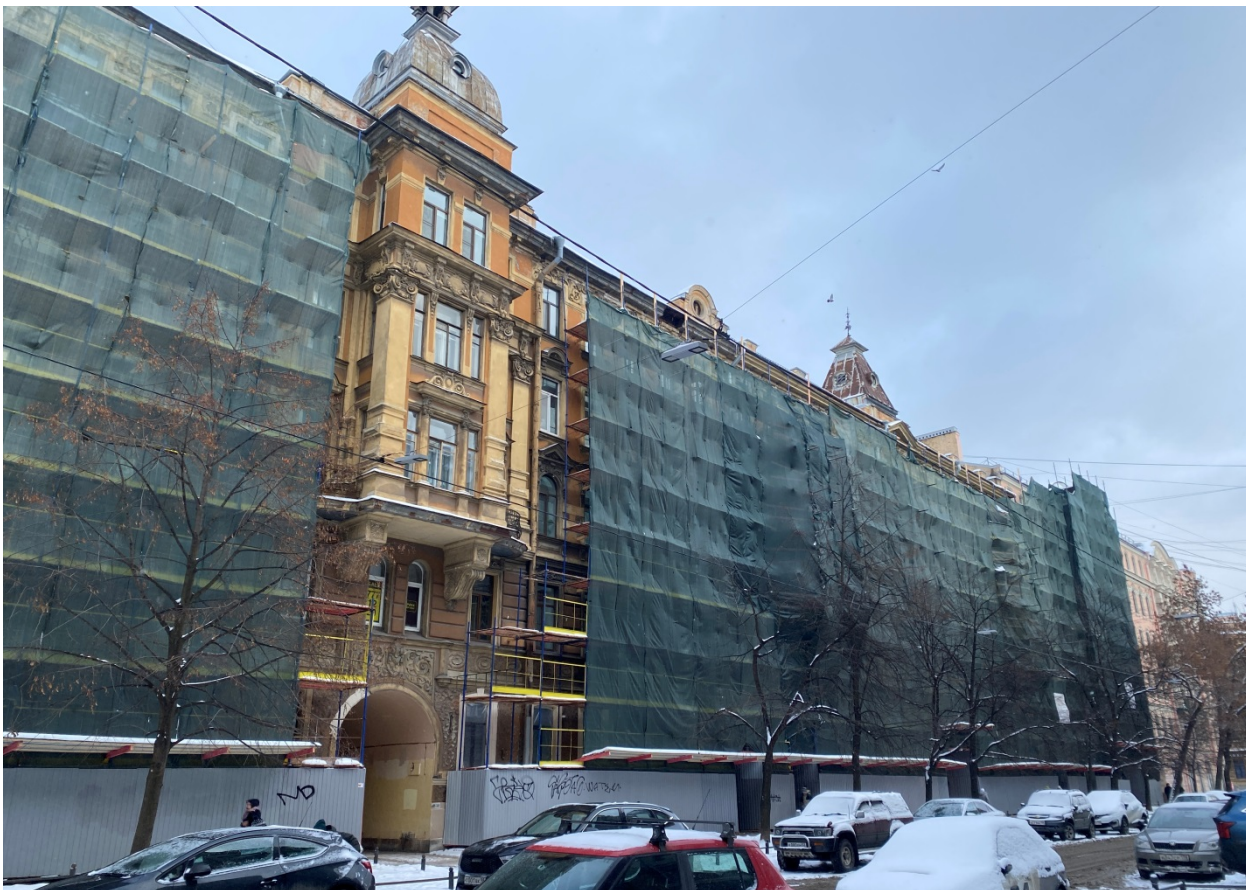
Фото 3. Фрагмент лицевого фасада объекта культурного наследия по 12-й линии В.О.
