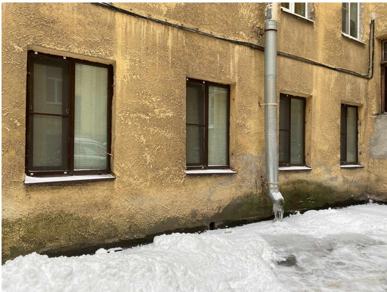
Фото 19. Вид на оконные заполнения квартиры № 21, расположенной в части объекта культурного наследия
