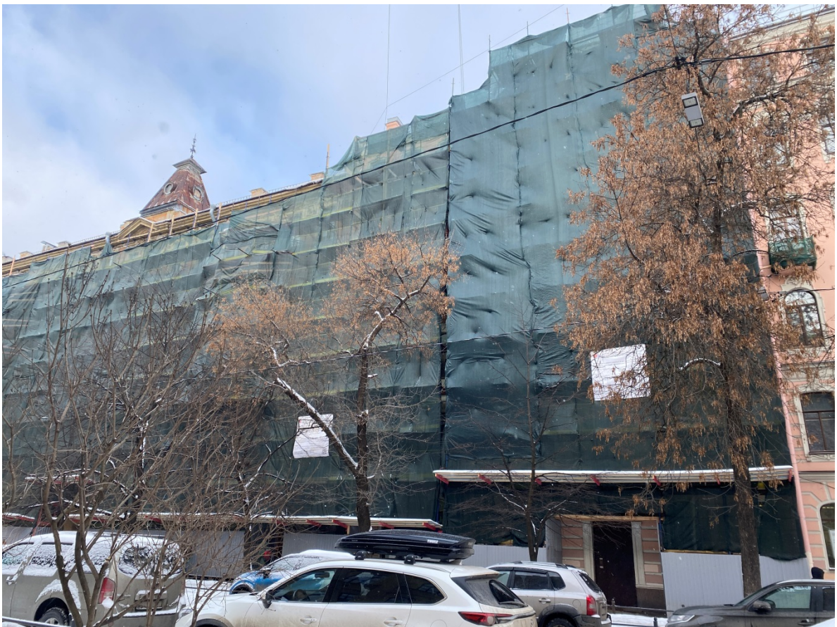
Фото 2. Фрагмент лицевого фасада объекта культурного наследия по 12-й линии В.О.
