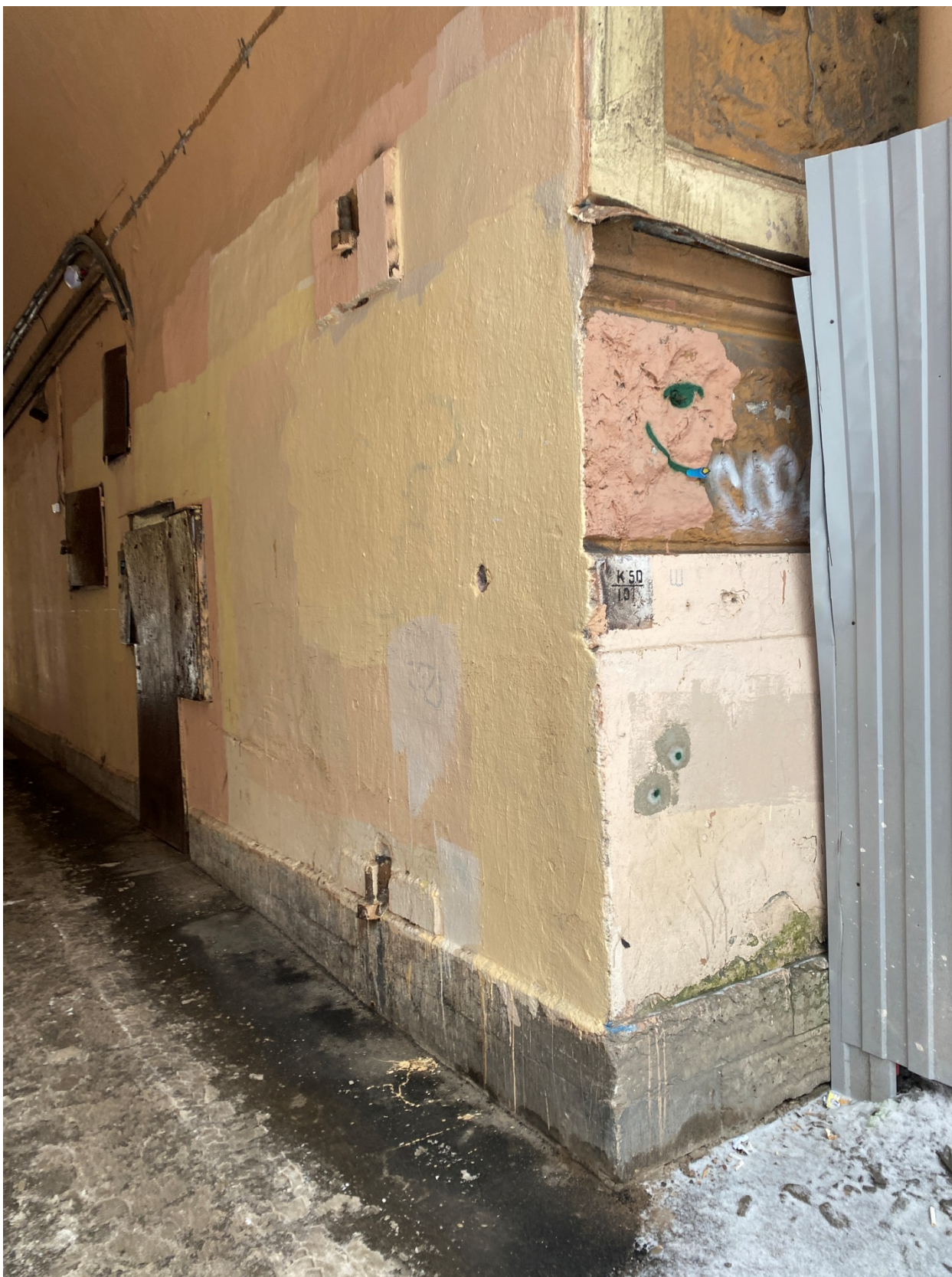
Фото 10. Фрагмент части фасадов объекта культурного наследия
