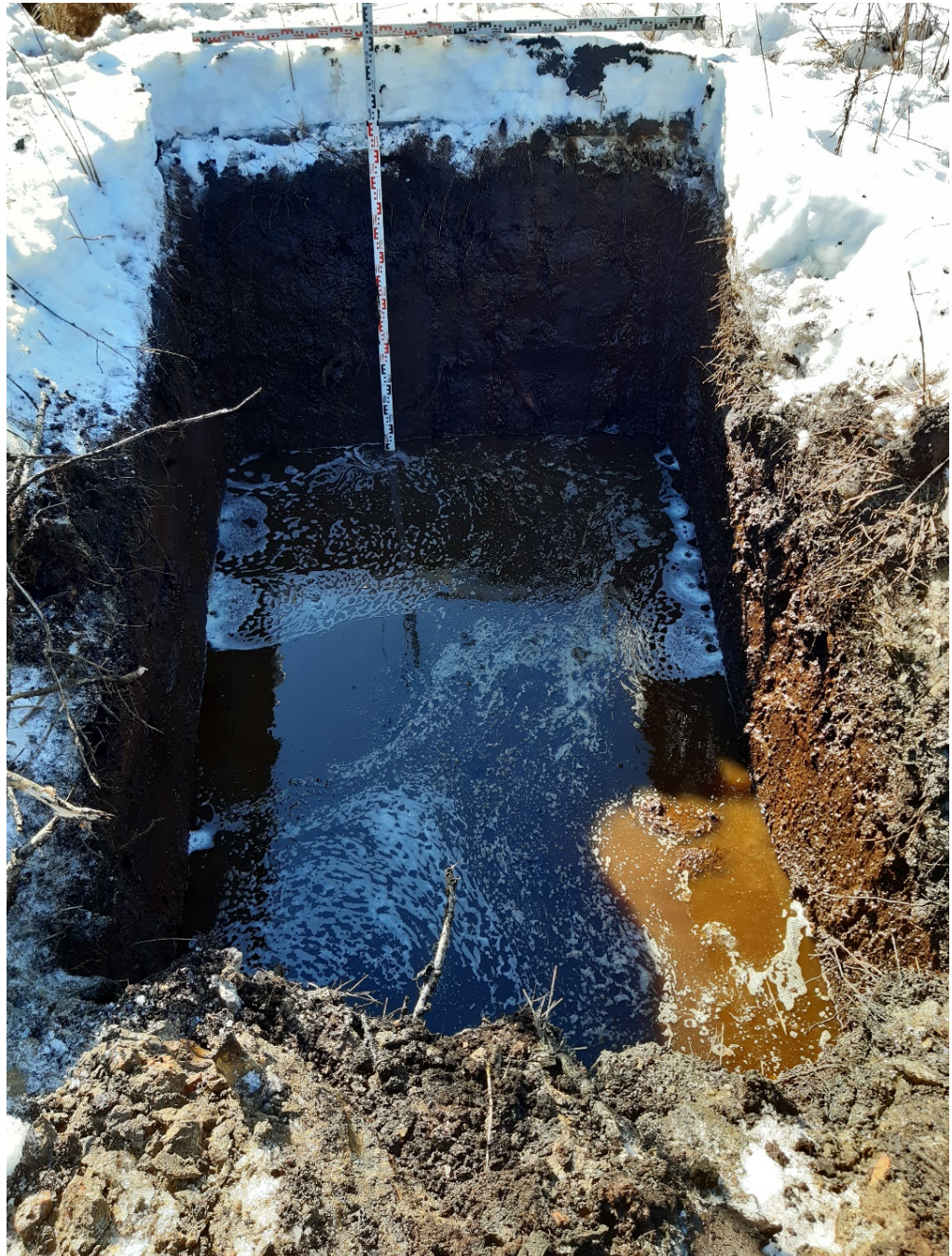
Рис. 36. Санкт-Петербург, п. Парголово, тер. Пригородный (кадастровый номер 78:36:0013262:3851). Шурф 1. Фотофиксация по светло-серой супеси (материку) затопленному грунтовыми водами. Вид на запад.
