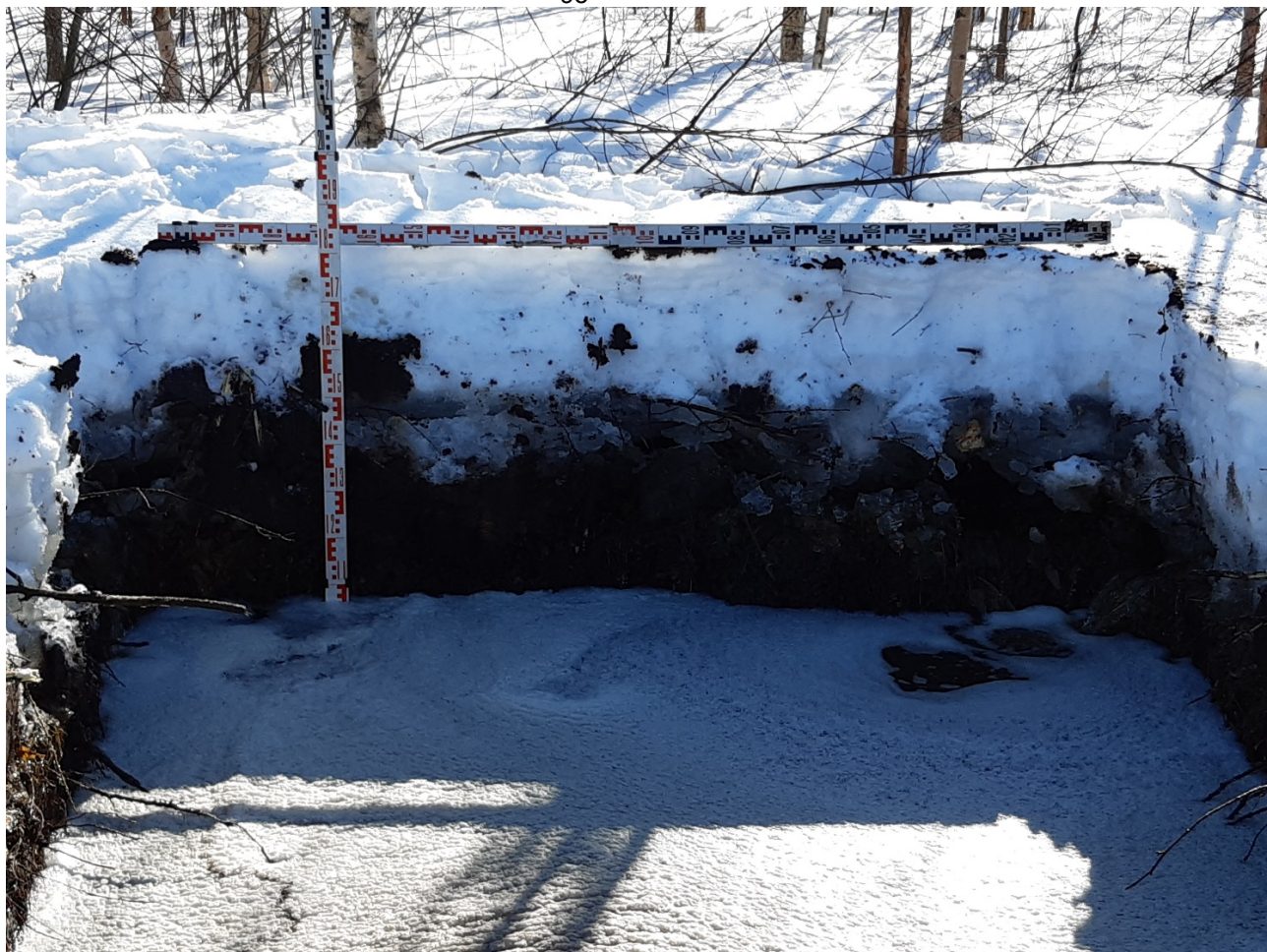
Рис. 47. Санкт-Петербург, п. Парголово, тер. Пригородный (кадастровый номер 78:36:0013262:3851). Шурф 3. Уровень затопления грунтовыми водами. Вид на юг.
