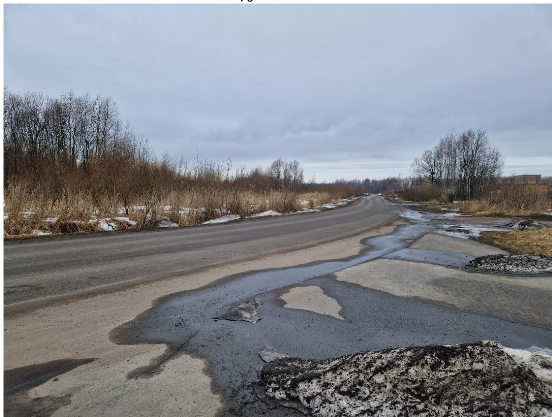
Рис. 11. СПб-2023. Приморский район, пос. Ольгино. Общий вид трассы обследования, восточная часть. Точка фотофиксации 3. Вид с севера.
