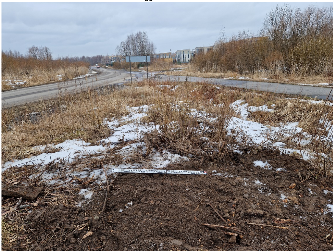
Рис. 23. СПб-2023. Приморский район, пос. Ольгино. Общий вид трассы обследования. Шурф 1. Рекультивация. Вид с востока.
