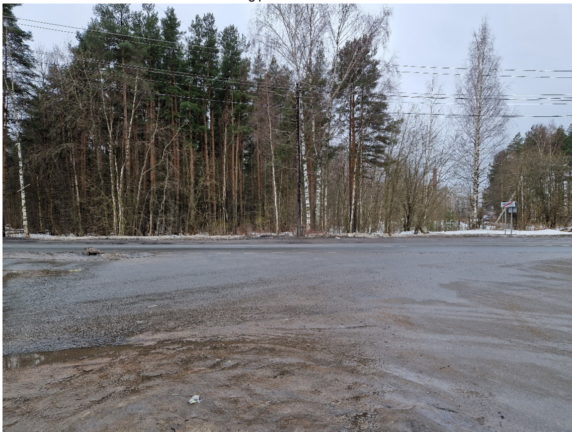
Рис. 15. СПб-2023. Приморский район, пос. Ольгино. Общий вид трассы обследования, западная часть. Точка фотофиксации 7. Вид с севера.
