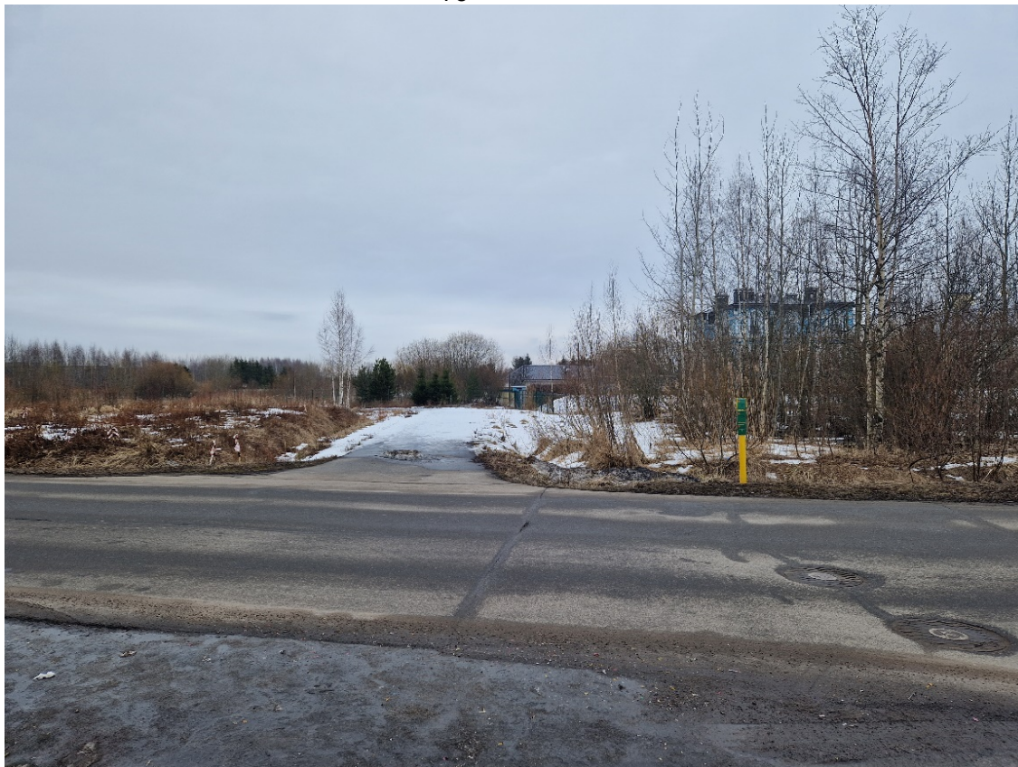
Рис. 9. СПб-2023. Приморский район, пос. Ольгино. Общий вид трассы обследования, восточная часть трассы. Точка фотофиксации 1. Вид с юга.
