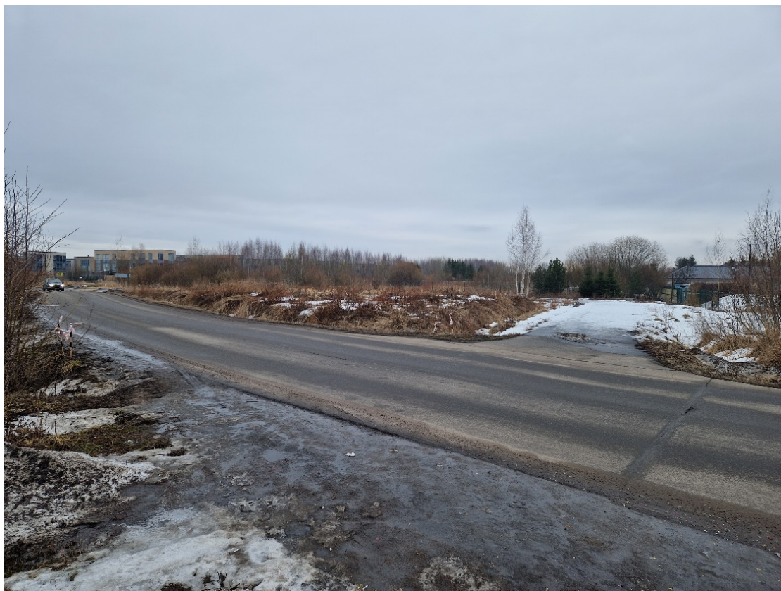
Рис. 10. СПб-2023. Приморский район, пос. Ольгино. Общий вид трассы обследования, восточная часть трассы. Точка фотофиксации 2. Вид с юга.
