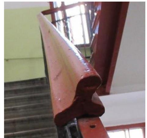
лестничный марш, ведущий из вестибюля парадного входа на лестницу Л-1 – местоположение, габариты, конструкция (средистенная), ограждение (идентичное ограждению лестницы Л1); ступени лещадной плиты, профиль ступеней (с валиком); поручни деревянные профилированные;
