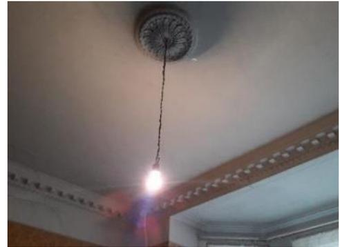
комната № 7 пл. 13,3 кв. м: оформление потолка аналогично оформлению потолка в комн. № 6 (исторически обе комнаты были единым пространством, разделенным поздней временной перегородкой): карниз с сухариками и пояс иоников по периметру потолка (по трем сторонам, с четвертой – поздняя временная перегородка).
