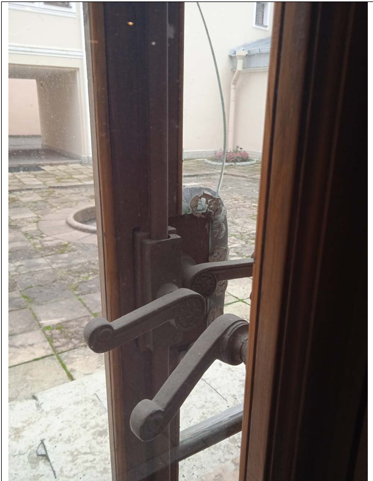
9. Посольство Германии. Вестибюль. Историческая фурнитура дверного заполнения.
