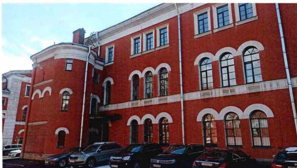
3. Вид на северный фасад объекта культурного наследия.
