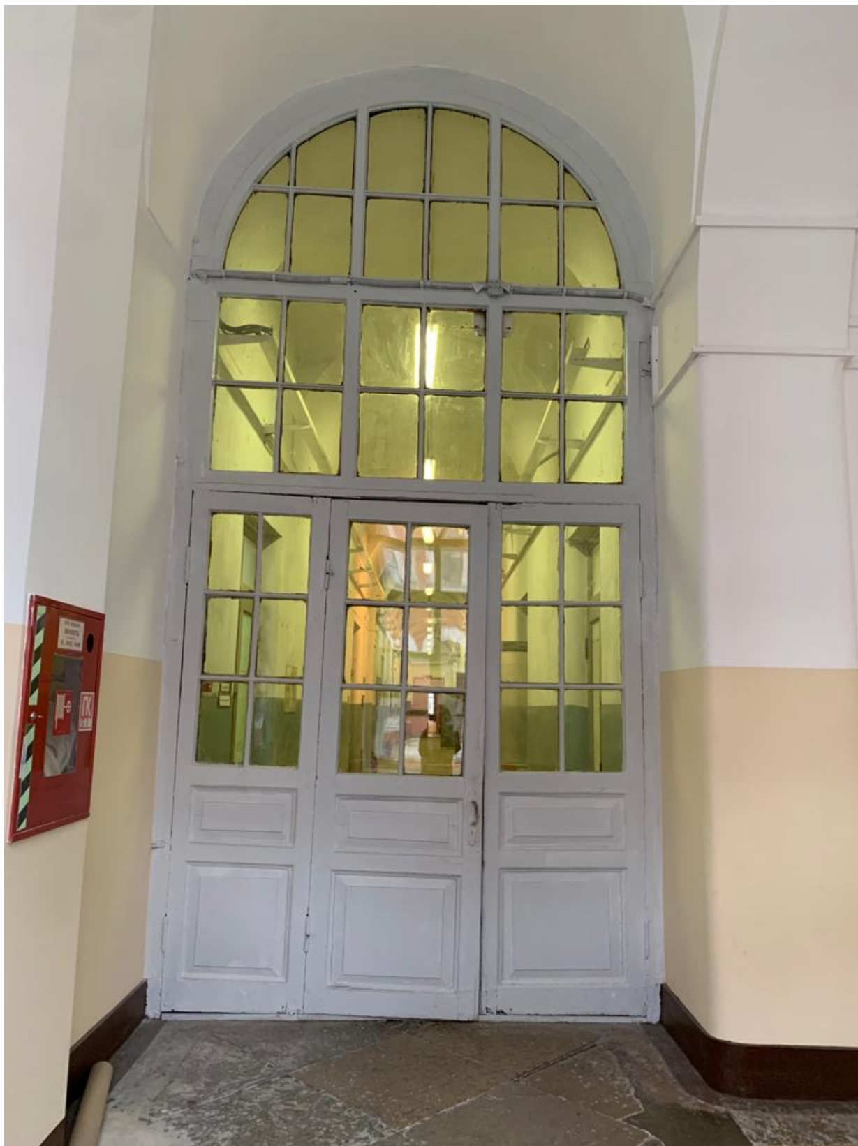
Фото 18. Дверное заполнение (2 этаж), вид со стороны лестницы.
