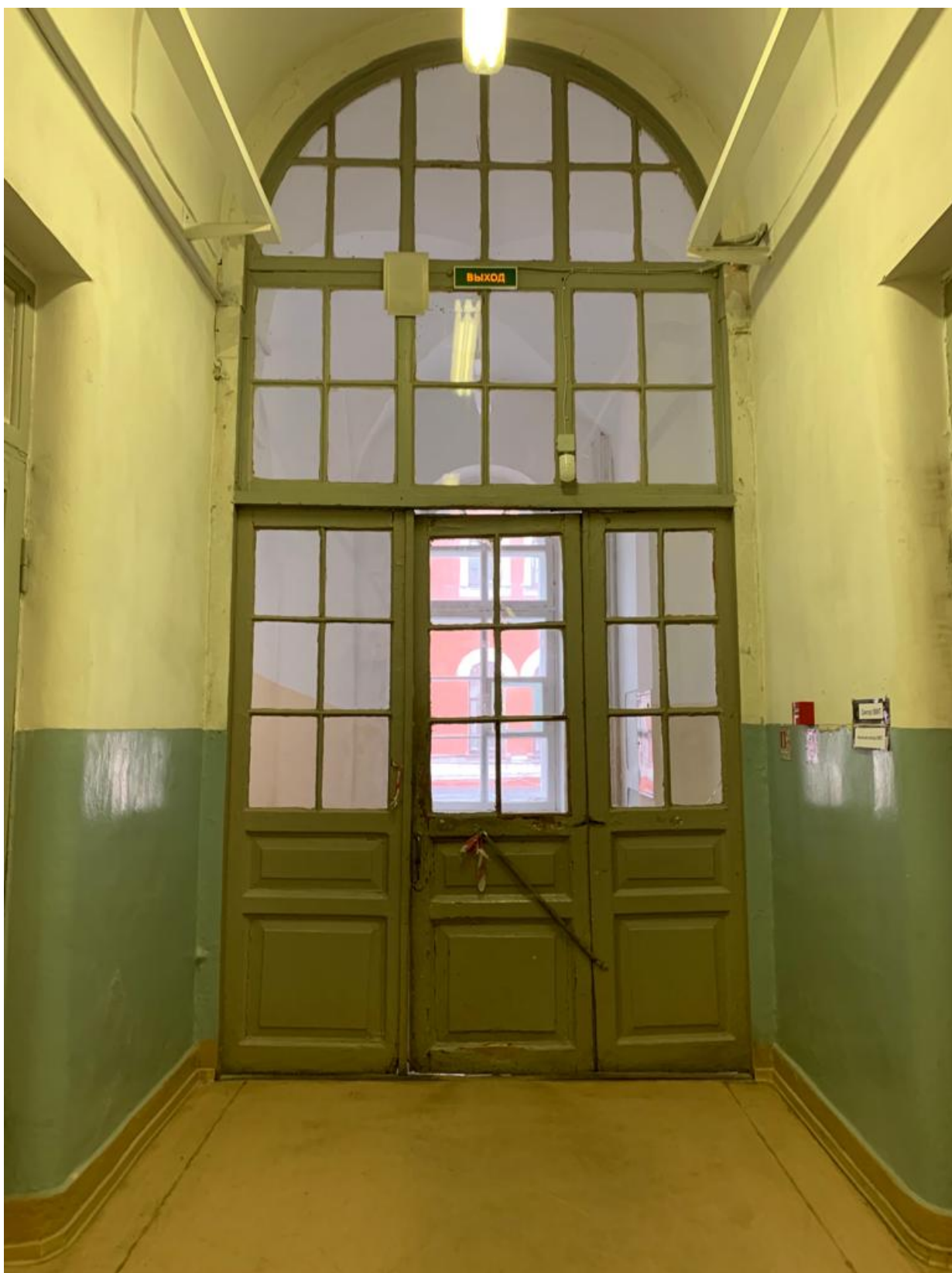
Фото 19. Дверное заполнение (2 этаж), вид со стороны коридора.
