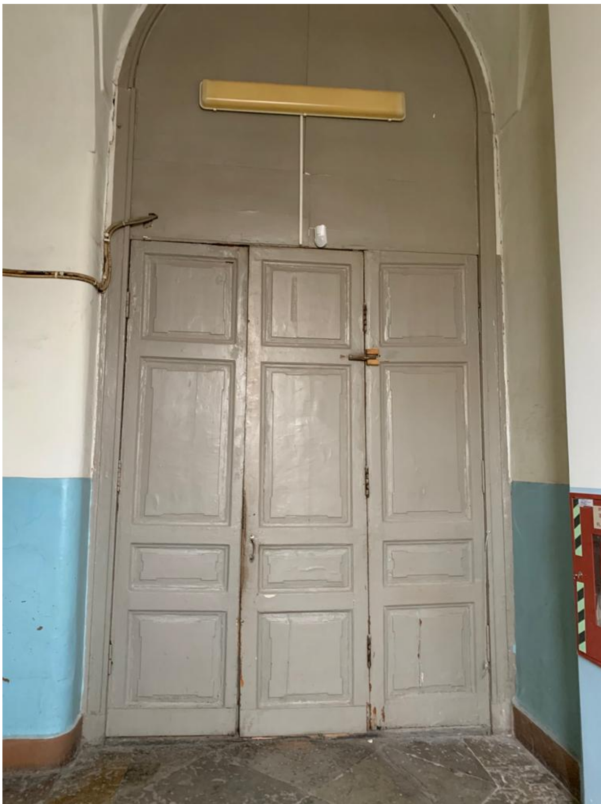
Фото 9. Дверное заполнение 2 этажа со стороны лестницы.
