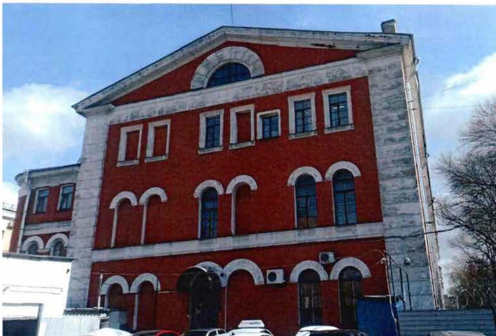
2. Вид на западный фасад объекта культурного наследия.
