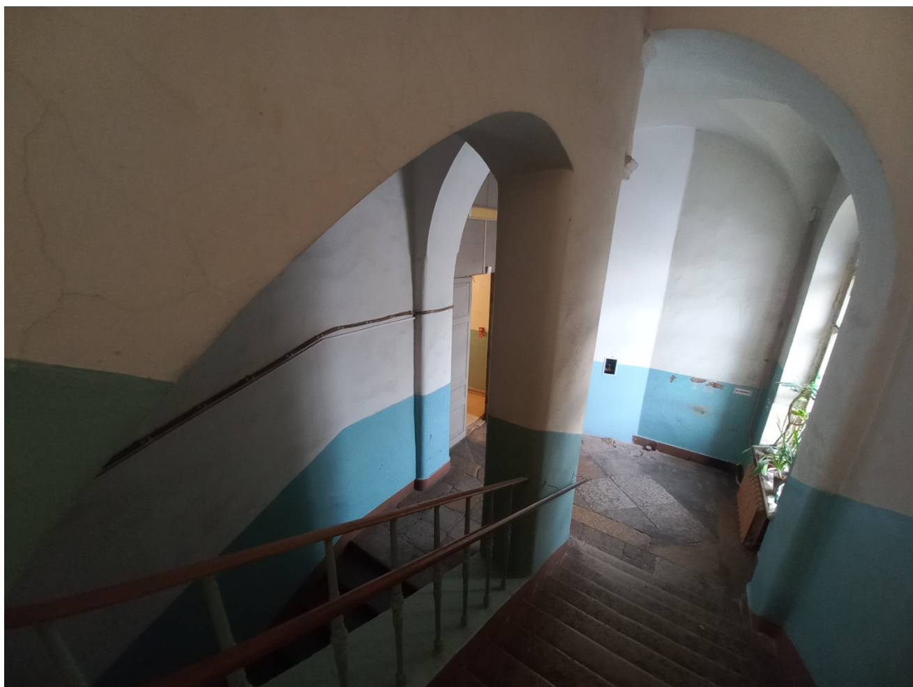
Фото 8. Вид на площадку 2 этажа.
