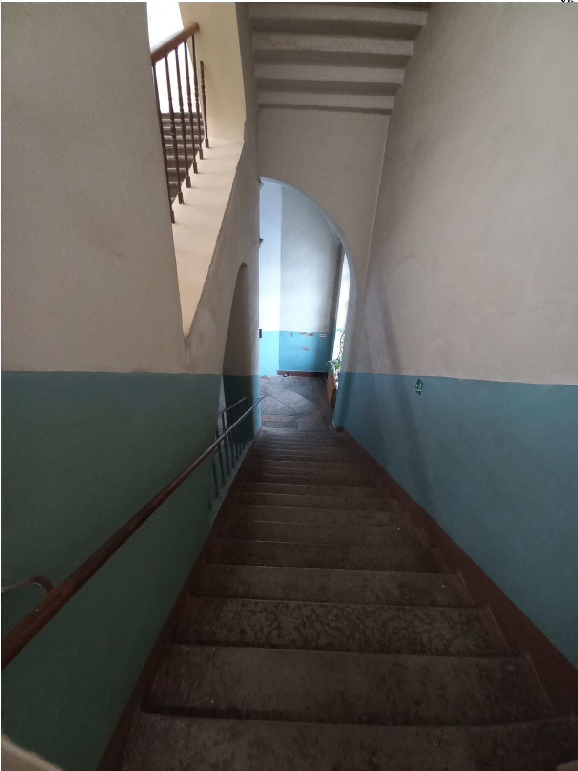
Фото 11. Вид на площадку 2 этажа.
