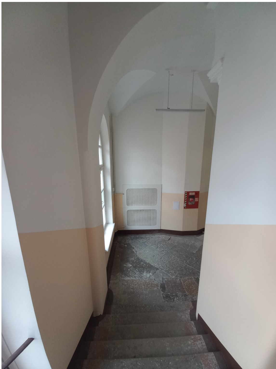
Фото 21. Вид на площадку второго этажа.
