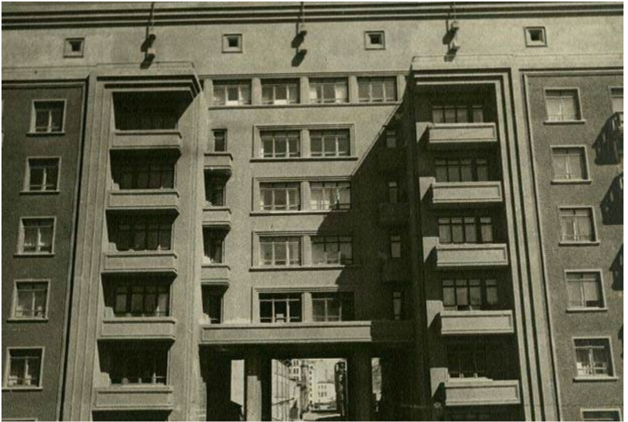
Илл. 33. 1938 г. Фото после окончания строительства. Фасад по Малому пр. П.С..
