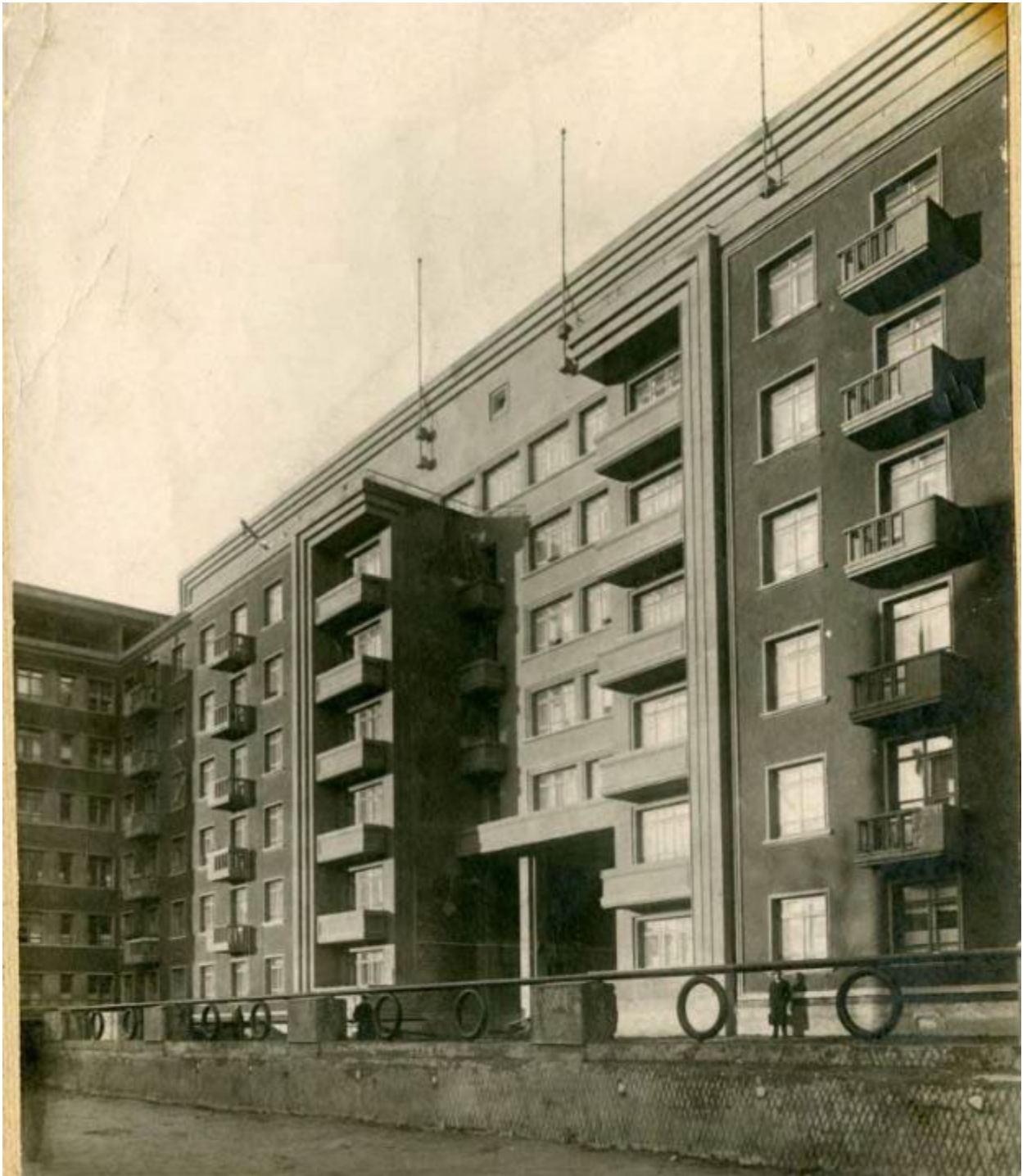
Илл. 34. 1938 г. Фото после окончания строительства. Общий вид на фасад (жилой дом работников "Свирьстроя"). Архитектор И. Явейн.
