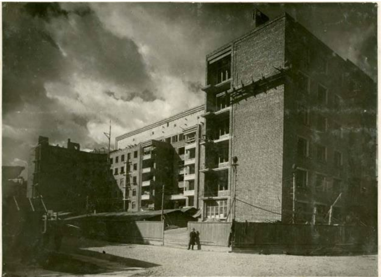
Илл. 25. Общий вид дома № 84-86 (жилой дом работников "Свирьстроя") на проспекте Щорса в процессе строительства. Архитектор И. Явейн. 1935 г.
