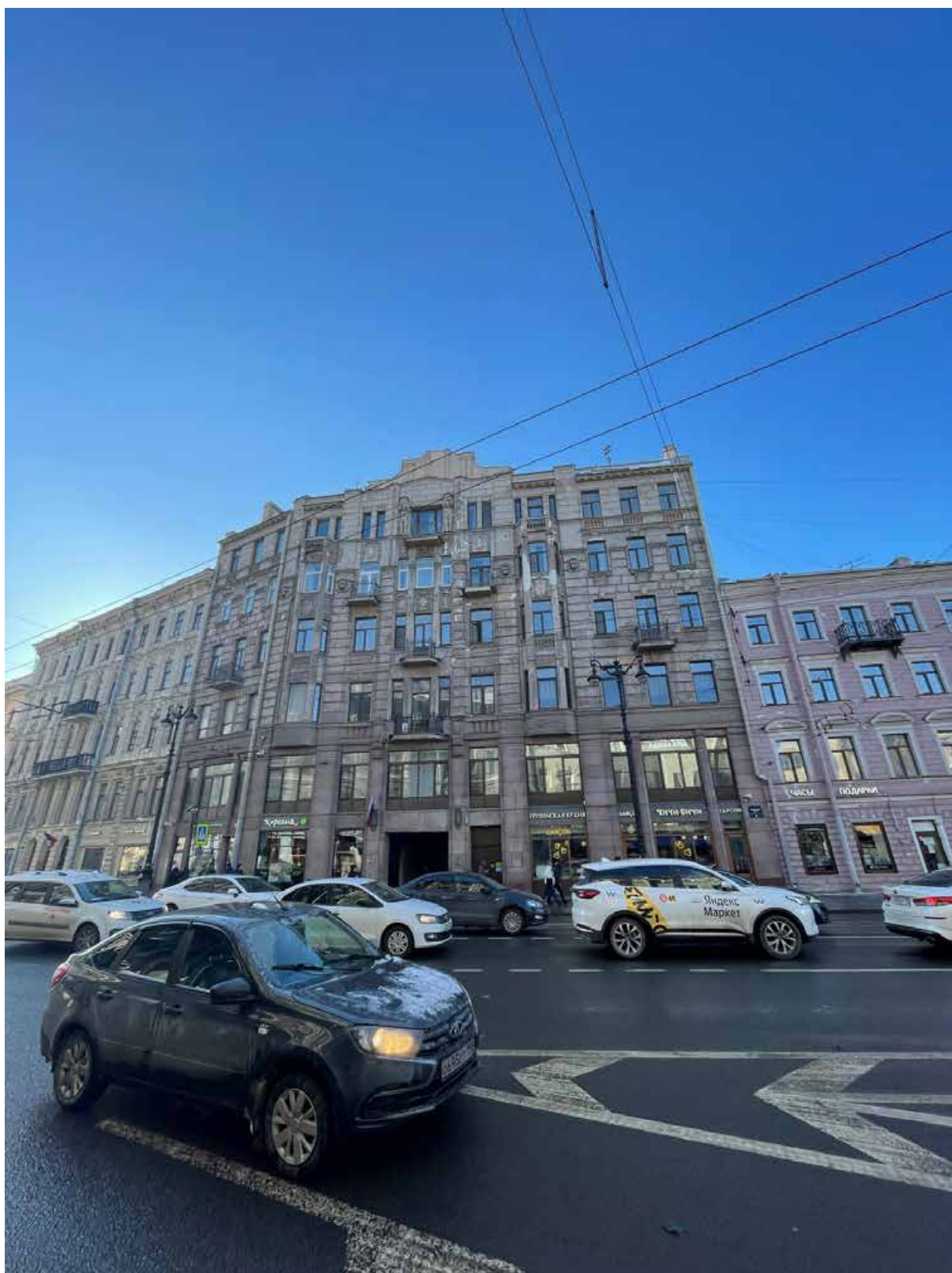
Фото 14. Выявленный объект культурного наследия «Дом Г.Г. Гесселя», г. Санкт-Петербург, Невский проспект, дом 95, литера А. Дата съемки: 03.04.2023
