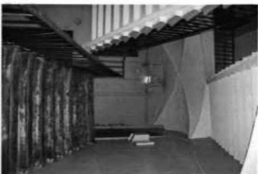
фото №14, 15. Центральная межэтажная лестница.
