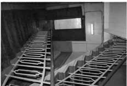
Фото №8. Боковая (западная) межэтажная лестница
