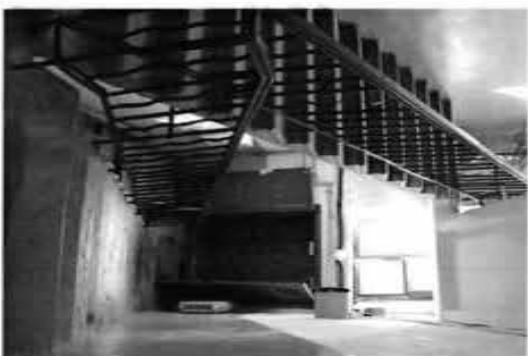
фото №16. Боковая (восточная) межэтажная лестница.
