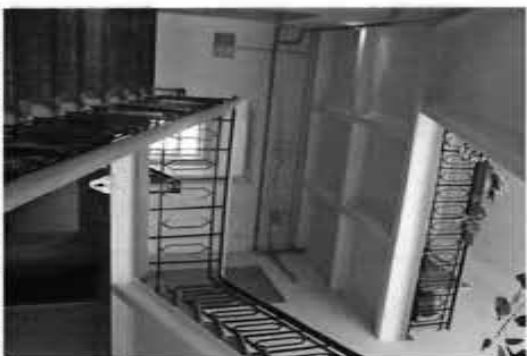
Фото №7. Центральная межэтажная лестница.
