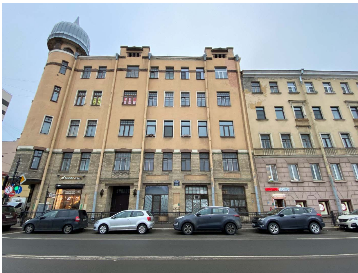
Фото №4. Лицевой (Восточный) фасад с Петроградской набережной.
