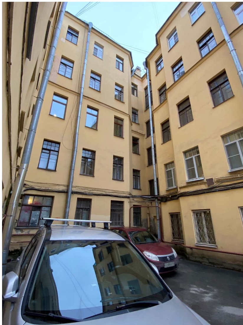
Фото №1. Дворовый (Юго-западный) фасад.
