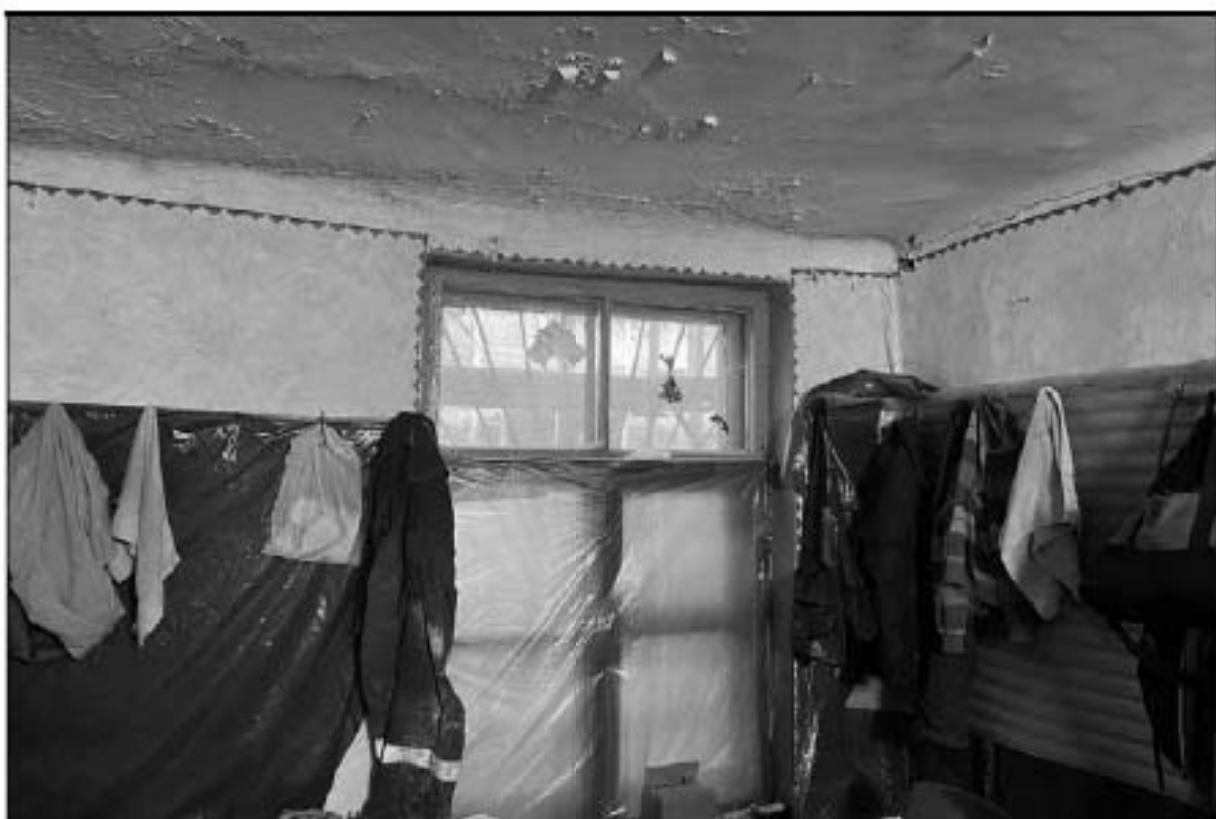
57. Объект культурного наследия федерального значения «Церковь англиканская Иисуса Христа. Церковь» (Галерная улица, дом 57, литера Б). 1-й этаж, помещение № 2 (ЛК-2). 13.02.2023 г.
