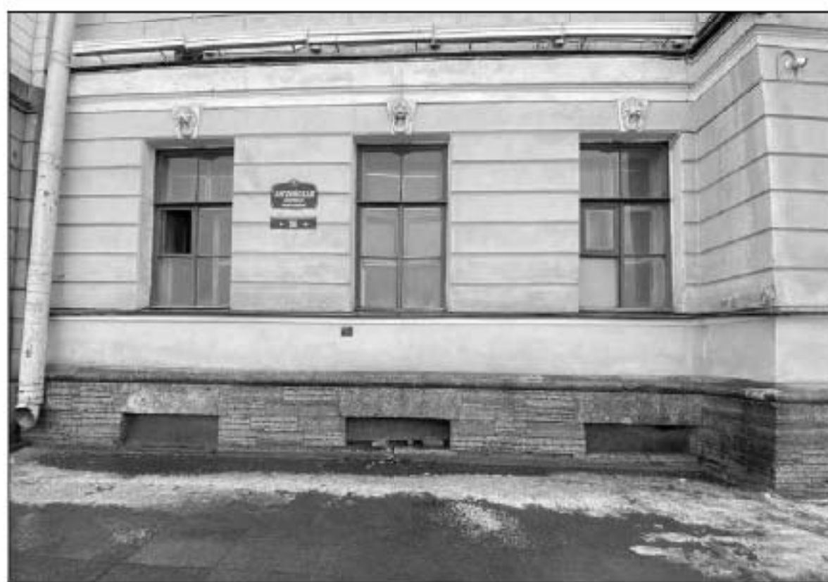
16. Объект культурного наследия федерального значения «Церковь англиканская Иисуса Христа. Церковь» (Галерная улица, дом 57, литера Б). Восточная часть лицевого фасада. Оконные проемы 1-го этажа. 13.02.2023 г.
