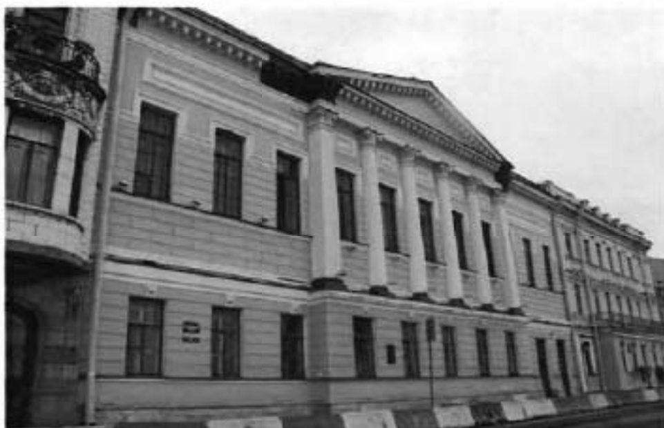
Фото №1. Вид на лицевой (северный) фасад со стороны наб. Английской.
