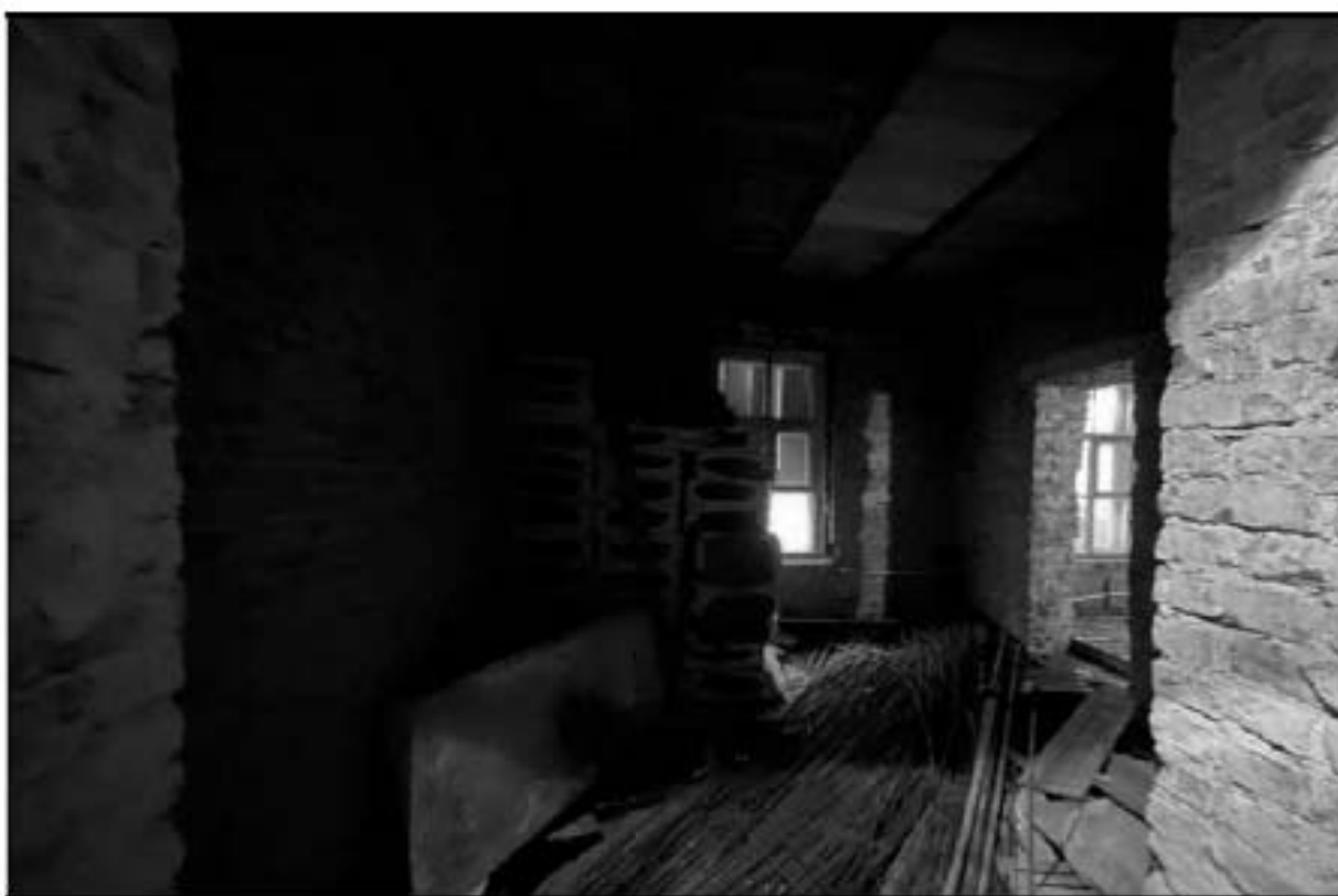
51. Объект культурного наследия федерального значения «Церковь англиканская Иисуса Христа. Церковь» (Галерная улица, дом 57, литера Б). 1-й этаж, помещение № 1-Н (28). 13.02.2023 г.
