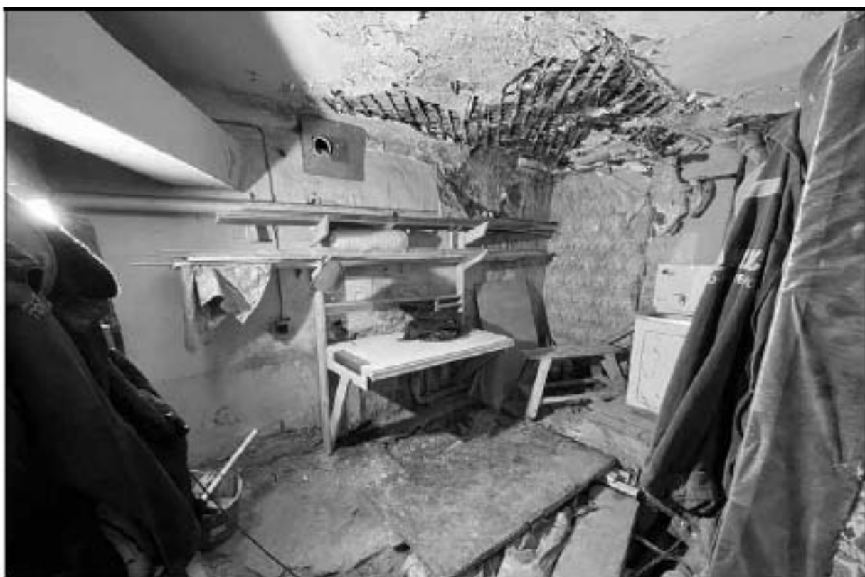
58. Объект культурного наследия федерального значения «Церковь англиканская Иисуса Христа. Церковь» (Галерная улица, дом 57, литера Б). 1-й этаж, помещение № 3 (ЛК-2). 13.02.2023 г.
