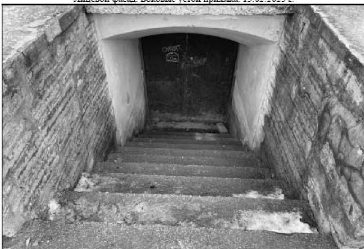
11. Объект культурного наследия федерального значения «Церковь англиканская Иисуса Христа. Церковь» (Галерная улица, дом 57, литера Б). Лицевой фасад. Лестница приямка и дверной проем в полуподвал. 13.02.2023 г.
