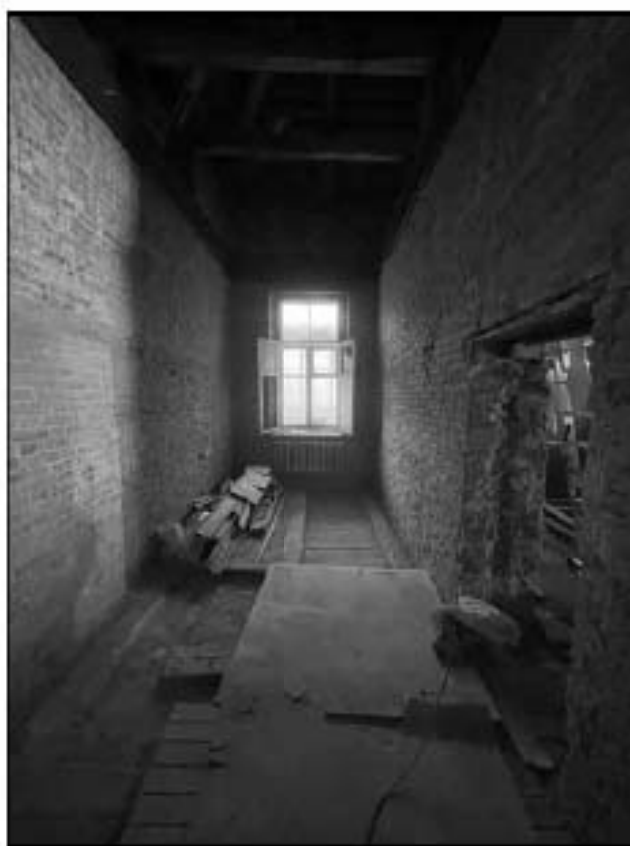
86. Объект культурного наследия федерального значения «Церковь англиканская Иисуса Христа. Церковь» (Галерная улица, дом 57, литера Б). 2-й этаж, помещение № 6 (ЛК-1). Вход в помещение № 7 (ЛК-1). 13.02.2023 г.
