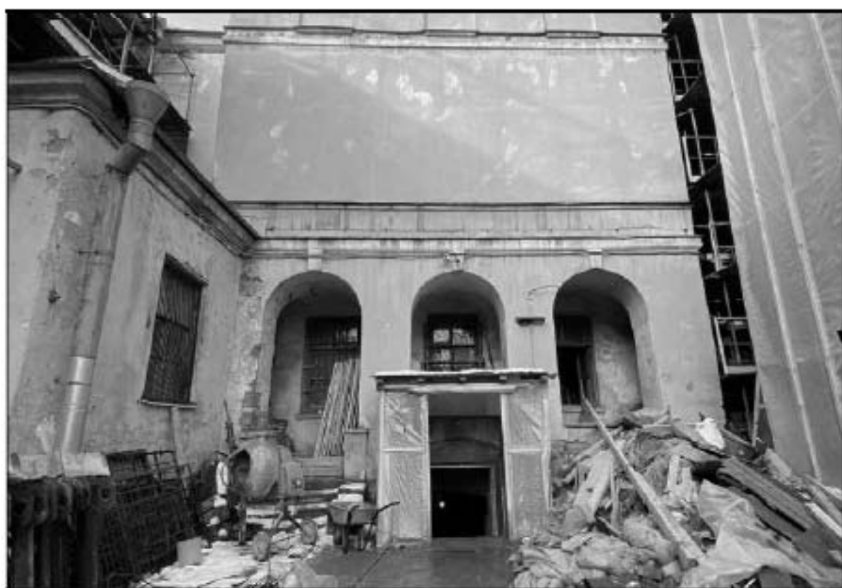
21. Объект культурного наследия федерального значения «Церковь англиканская Инсуса Христа. Церковь» (Галерная улица, дом 57, литера Б). Дворовые фасады. Аркада ризалита. 13.02.2023 г.
