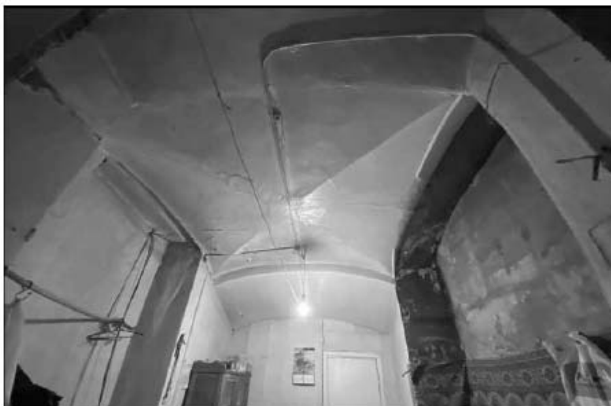
45. Объект культурного наследия федерального значения «Церковь англиканская Иисуса Христа. Церковь» (Галерная улица, дом 57, литера Б). 1-й этаж, помещение № 1-Н (4). Крестовый свод. 13.02.2023 г.
