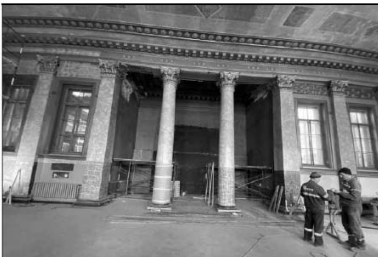
69. Объект культурного наследия федерального значения «Церковь англиканская Иисуса Христа. Церковь» (Галерная улица, дом 57, литера Б). 2-й этаж, помещение № 1-Н (34). Церковный зал. Помещение для органа. 13.02.2023 г.
