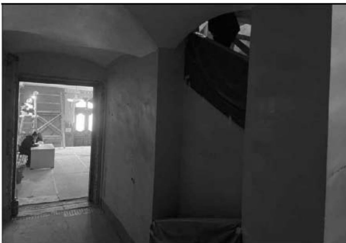
39. Объект культурного наследия федерального значения «Церковь англиканская Иисуса Христа. Церковь» (Галерная улица, дом 57, литера Б). 1-й этаж, помещение № 1-Н (3). Опорные пилоны парадной лестницы. 13.02.2023 г.
