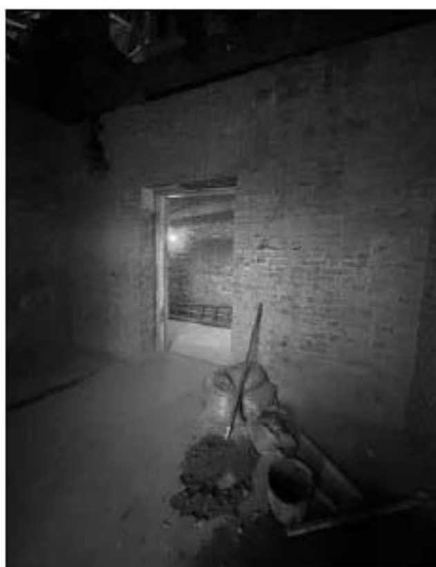
85. Объект культурного наследия федерального значения «Церковь англиканская Иисуса Христа. Церковь» (Галерная улица, дом 57, литера Б). 2-й этаж, помещение № 5 (ЛК-1). Вход в помещение № 2 (ЛК-1). 13.02.2023 г.
