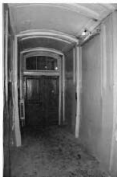
Фото №5. Тамбур и вестибюль входа (1-ЛК).
