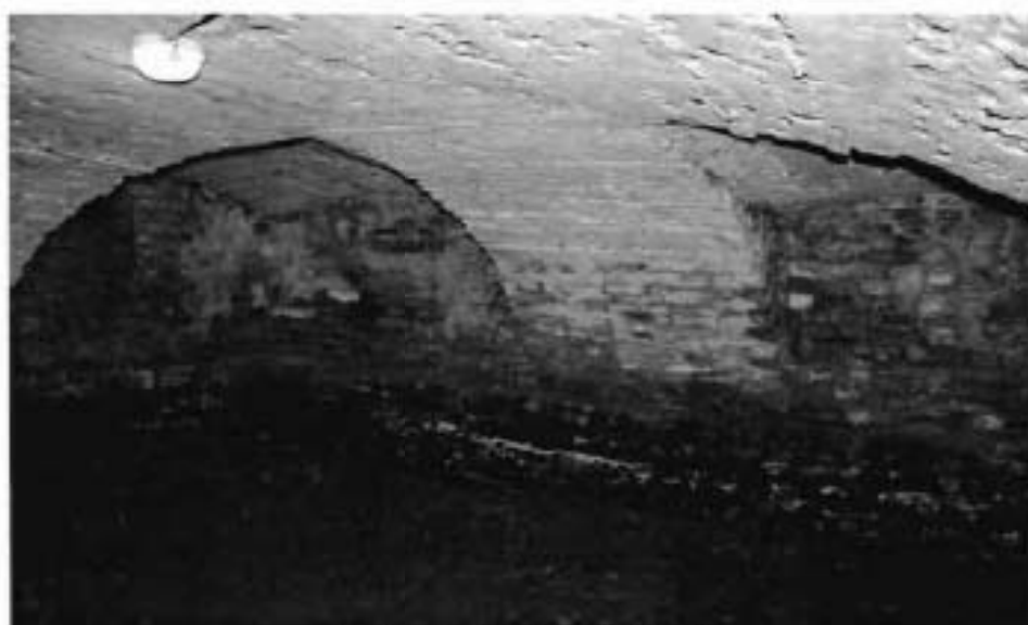
Фото №8. Свод подвального этажа.
