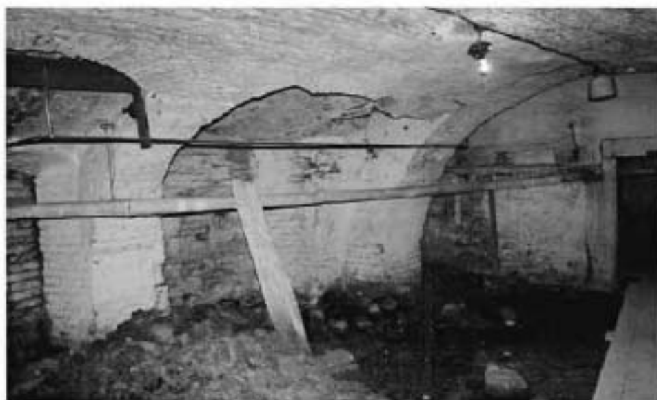
Фото №13. Своды подвального этажа.
