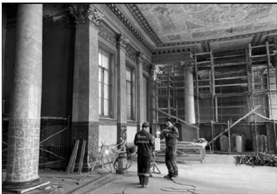
63. Объект культурного наследия федерального значения «Церковь англиканская Иисуса Христа. Церковь» (Галерная улица, дом 57, литера Б). 2-й этаж, помещение № 1-Н (34). Юго-западная часть церковного зала. 13.02.2023 г.
