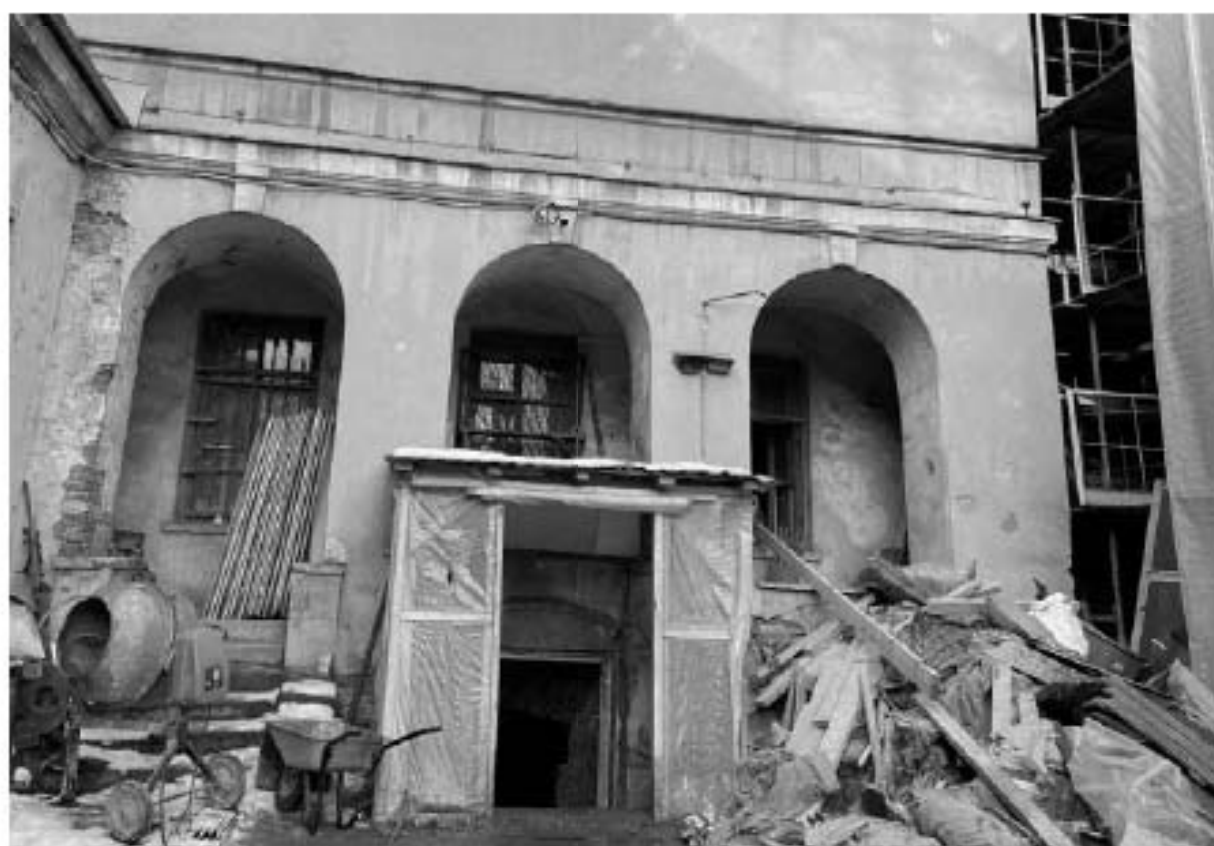
22. Объект культурного наследия федерального значения «Церковь англиканская Иисуса Христа. Церковь» (Галерная улица, дом 57, литера Б). Дворовые фасады. Аркада ризалита и прямая. 13.02.2023 г.
