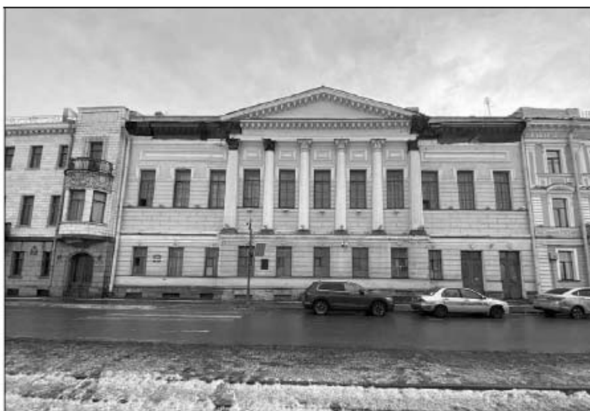
3. Объект культурного наследия федерального значения «Церковь англиканская Иисуса Христа. Церковь» (Галерная улица, дом 57, литера Б). Лицевой фасад. Вид с Английской набережной. 13.02.2023 г.
