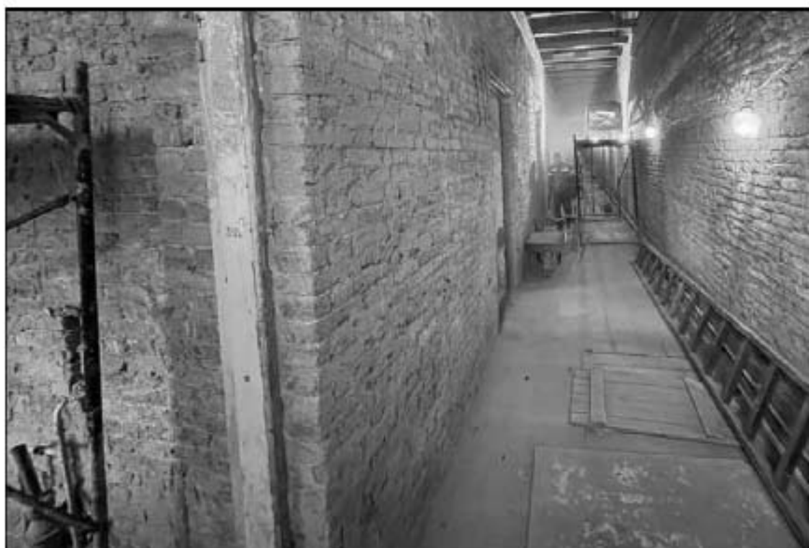
80. Объект культурного наследия федерального значения «Церковь англиканская Иисуса Христа. Церковь» (Галерная улица, дом 57, литера Б). 2-й этаж, помещение № 2 (ЛК-1). 13.02.2023 г.
