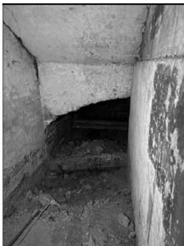
56. Объект культурного наследия федерального значения «Церковь англиканская Иисуса Христа. Церковь» (Галерная улица, дом 57, литера Б). 1-й этаж, ЛК-2. Свод. 13.02.2023 г.
