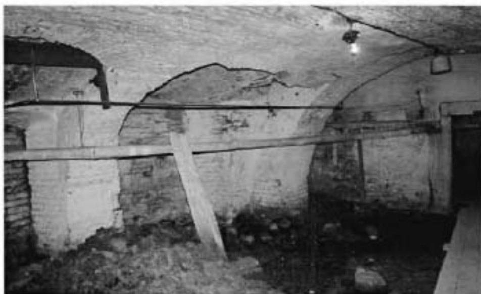
Фото №13. Своды подвального этажа.
