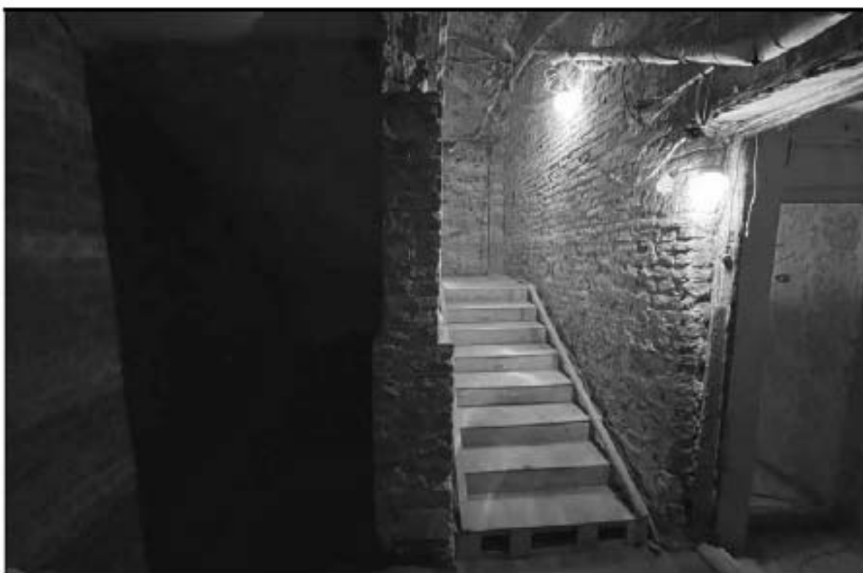
55. Объект культурного наследия федерального значения «Церковь англиканская Иисуса Христа. Церковь» (Галерная улица, дом 57, литера Б). 1-й этаж, ЛК-2. Вход в помещения №№ 1, 2, 3 (ЛК-2). 13.02.2023 г.
