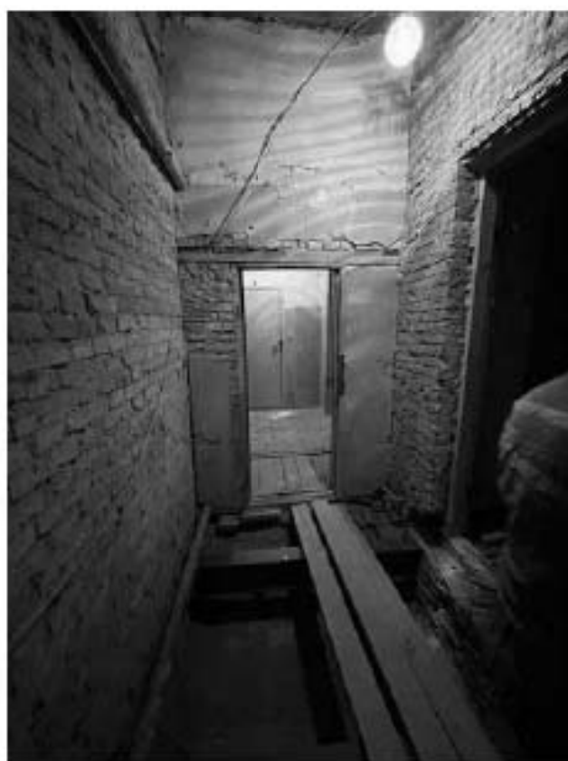
52. Объект культурного наследия федерального значения «Церковь англиканская Иисуса Христа. Церковь» (Галерная улица, дом 57, литера Б). 1-й этаж, помещение № 1-Н (26). Вход в помещение № 2 (ЛК-1). 13.02.2023 г.
