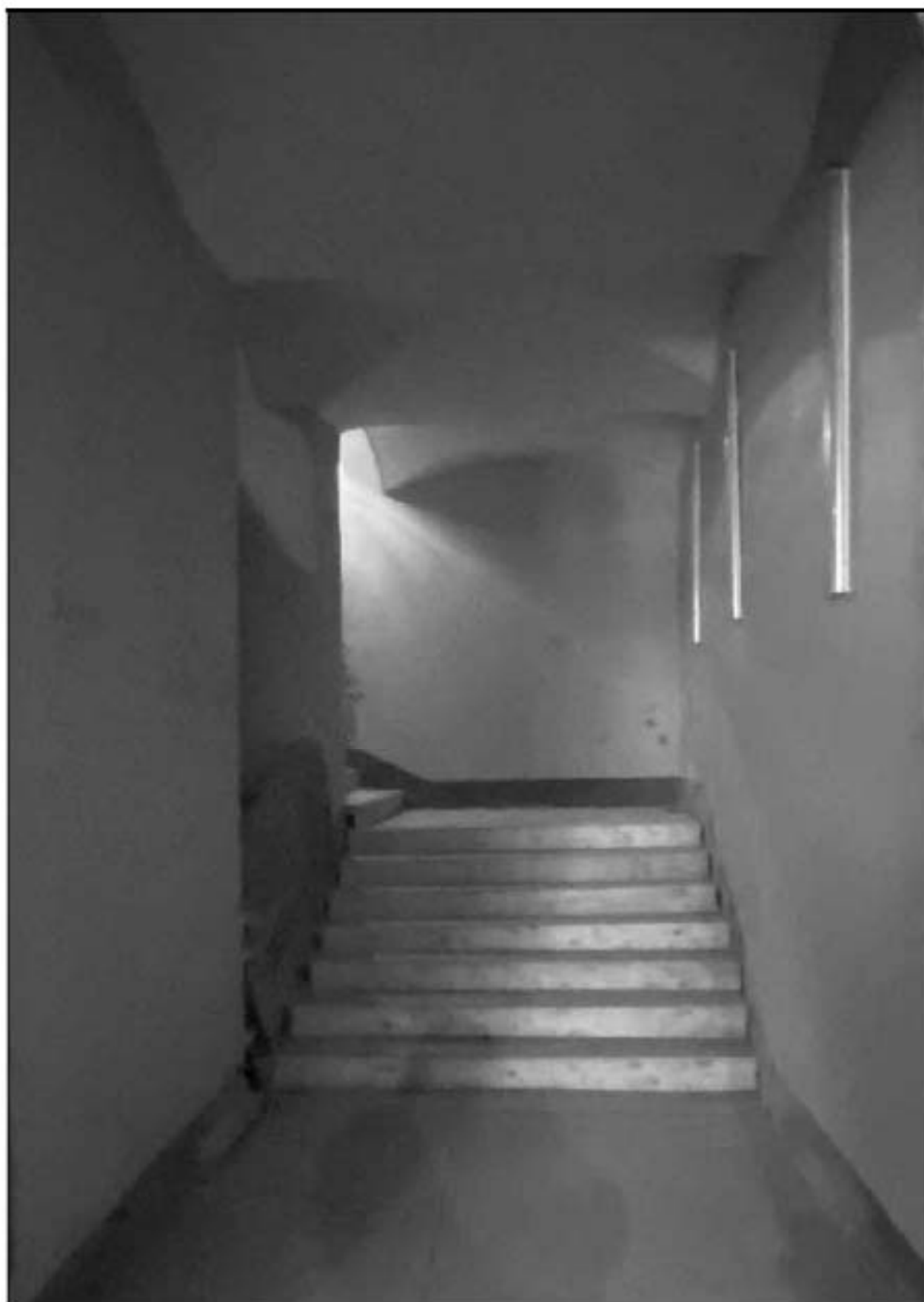
38. Объект культурного наследия федерального значения «Церковь англиканская Иисуса Христа. Церковь» (Галерная улица, дом 57, литера Б). 1-й этаж, помещение № 1-Н (3). Парадная лестница. Вид от помещения № 1-Н (2). 13.02.2023 г.
