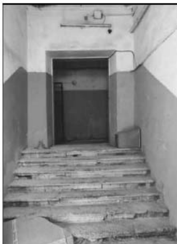
53. Объект культурного наследия федерального значения «Церковь англиканская Иисуса Христа. Церковь» (Галерная улица, дом 57, литера Б). 1-й этаж, помещение № 1 (ЛК-1). Лестничный марш. 13.02.2023 г.
