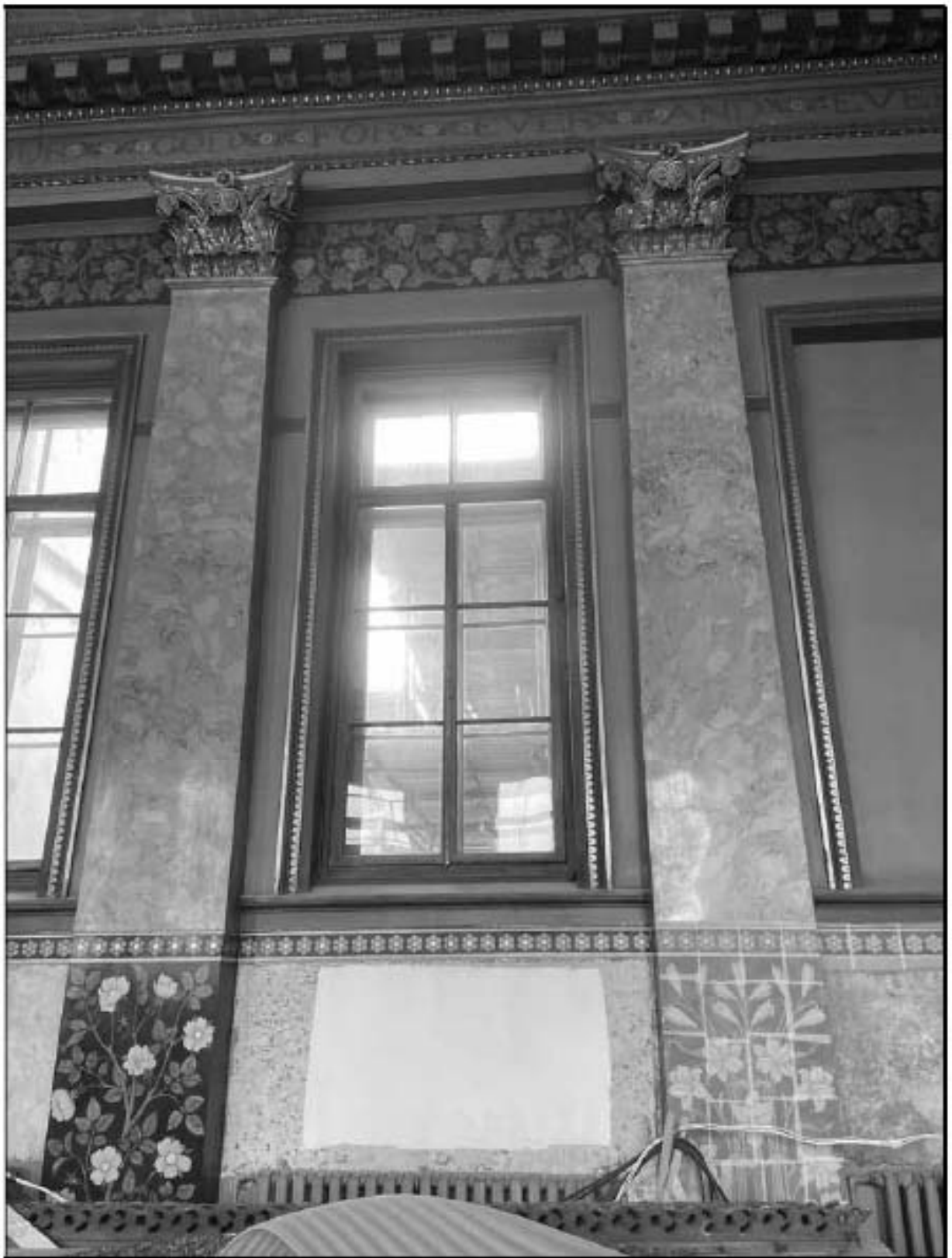
67. Объект культурного наследия федерального значения «Церковь англиканская Иисуса Христа. Церковь» (Галерная улица, дом 57, литера Б). 2-й этаж, помещение № 1-Н (34). Пиллястры в юго-западной части церковного зала. 13.02.2023 г.
