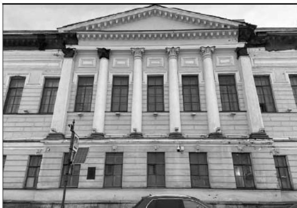
4. Объект культурного наследия федерального значения «Церковь англиканская Иисуса Христа. Церковь» (Галерная улица, дом 57, литера Б). Лицевой фасад. Центральный ризалит с портиком композитного ордера. 13.02.2023 г.
