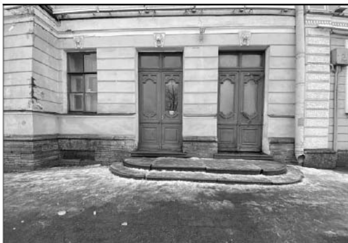
13. Объект культурного наследия федерального значения «Церковь англиканская Иисуса Христа. Церковь» (Галерная улица, дом 57, литера Б). Западная часть лицевого фасада. Крыльцо и дверные проемы. 13.02.2023 г.
