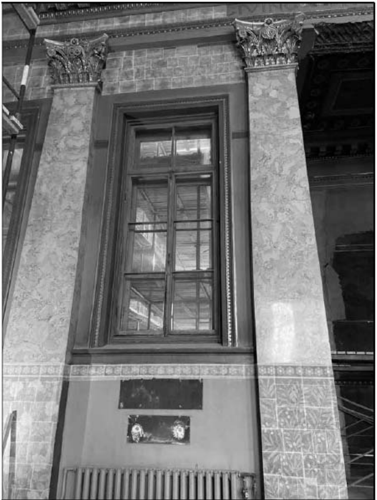
71. Объект культурного наследия федерального значения «Церковь англиканская Иисуса Христа. Церковь» (Галерная улица, дом 57, литера Б). 2-й этаж, помещение № 1-Н (34). Юго-восточная часть церковного зала. Оконный проем и пилястры. 13.02.2023 г.
