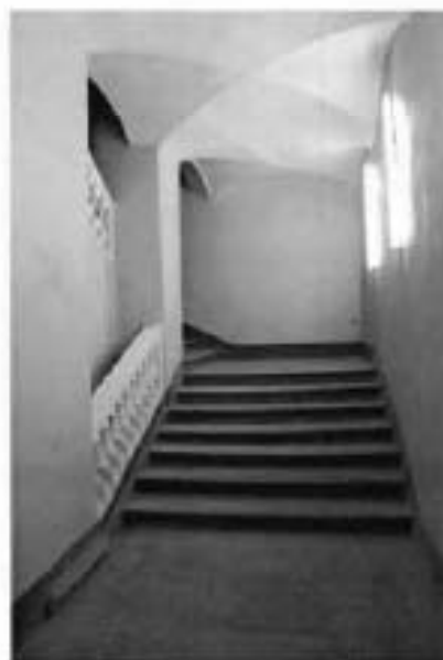
Фото №9, 10. Парадная лестница на опорных пилонах с балюстрадным ограждением.
