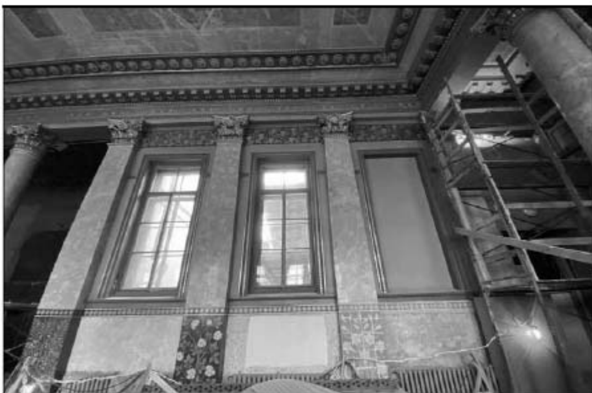
65. Объект культурного наследия федерального значения «Церковь англиканская Иисуса Христа. Церковь» (Галерная улица, дом 57, литера Б). 2-й этаж, помещение № 1-Н (34). Оконные проемы, ниша и пилястры в юго-западной части церковного зала. 13.02.2023 г.
