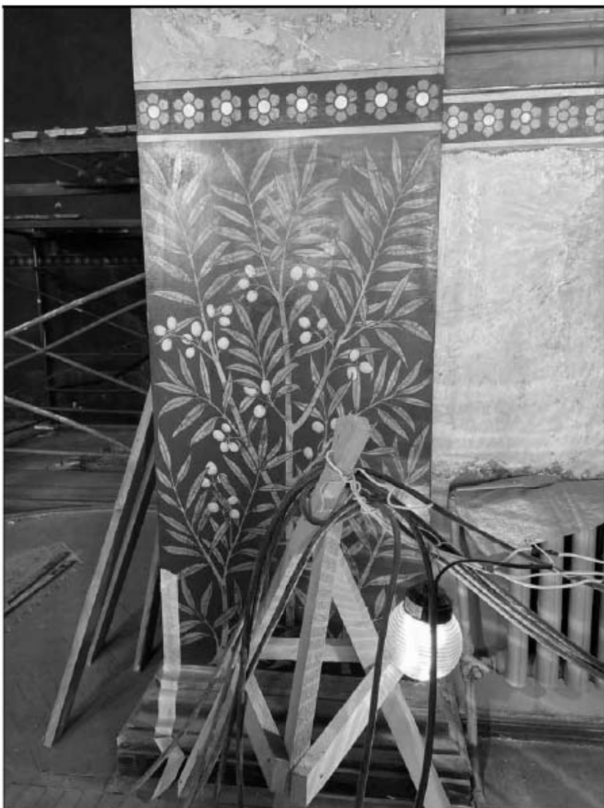
68. Объект культурного наследия федерального значения «Церковь англиканская Иисуса Христа. Церковь» (Галерная улица, дом 57, литера Б). 2-й этаж, помещение № 1-Н (34). Юго-западная часть церковного зала. Фрагмент угловой пилястры. 13.02.2023 г.
