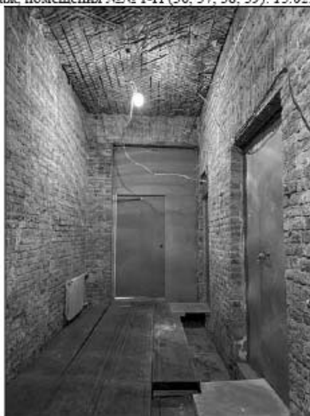
73. Объект культурного наследия федерального значения «Церковь англиканская Иисуса Христа. Церковь» (Галерная улица, дом 57, литера Б). 2-й этаж, помещение № 1-Н (43). Вход в помещения №№ 1-Н (36, 37, 38, 39). 13.02.2023 г.
