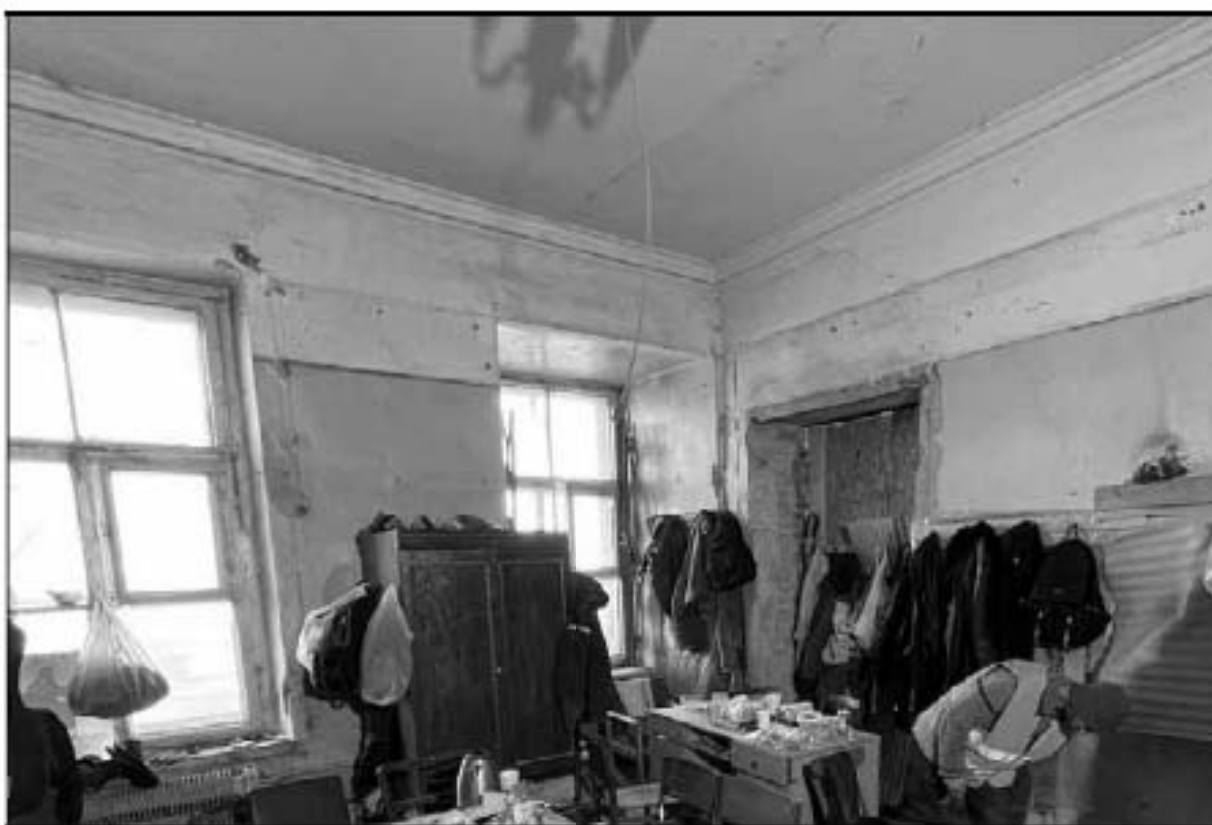
47. Объект культурного наследия федерального значения «Церковь англиканская Иисуса Христа. Церковь» (Галерная улица, дом 57, литера Б). 1-й этаж, помещение № 1-Н (15). Оконные проемы и вход в помещение № 1-Н (16). 13.02.2023 г.
