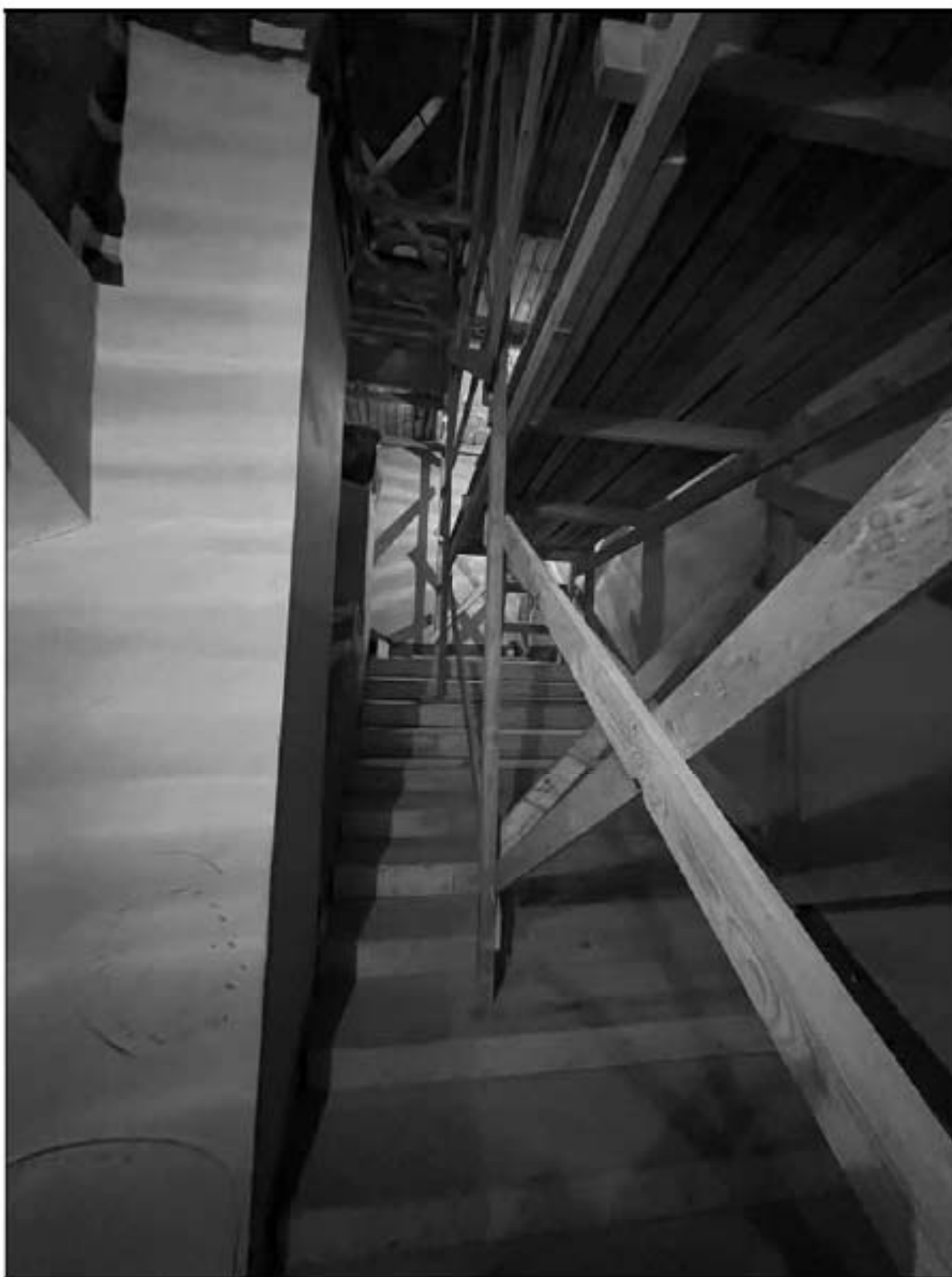
42. Объект культурного наследия федерального значения «Церковь англиканская Иисуса Христа. Церковь» (Галерная улица, дом 57, литера Б). 1-й этаж, помещение № 1-Н (3). Парадная лестница. Лестничный марш на 2-й этаж. 13.02.2023 г.
