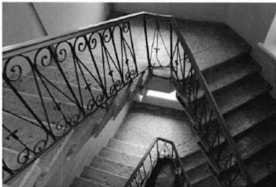
Фото №3. Трехмаршевая лестница (1-ЛК).
