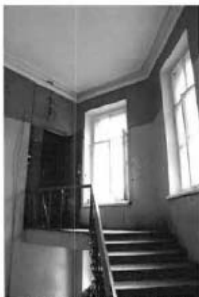
Фото №4. Верхняя площадка (1-ЛК).
