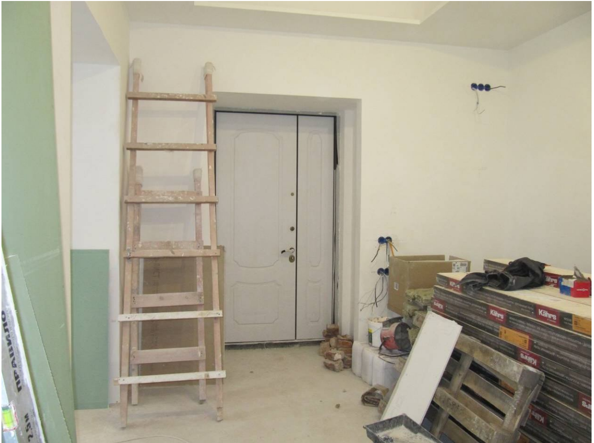
7. Вид на вход с лестничной клетки 1ЛК в квартиру № 4 (пом. 13*).
