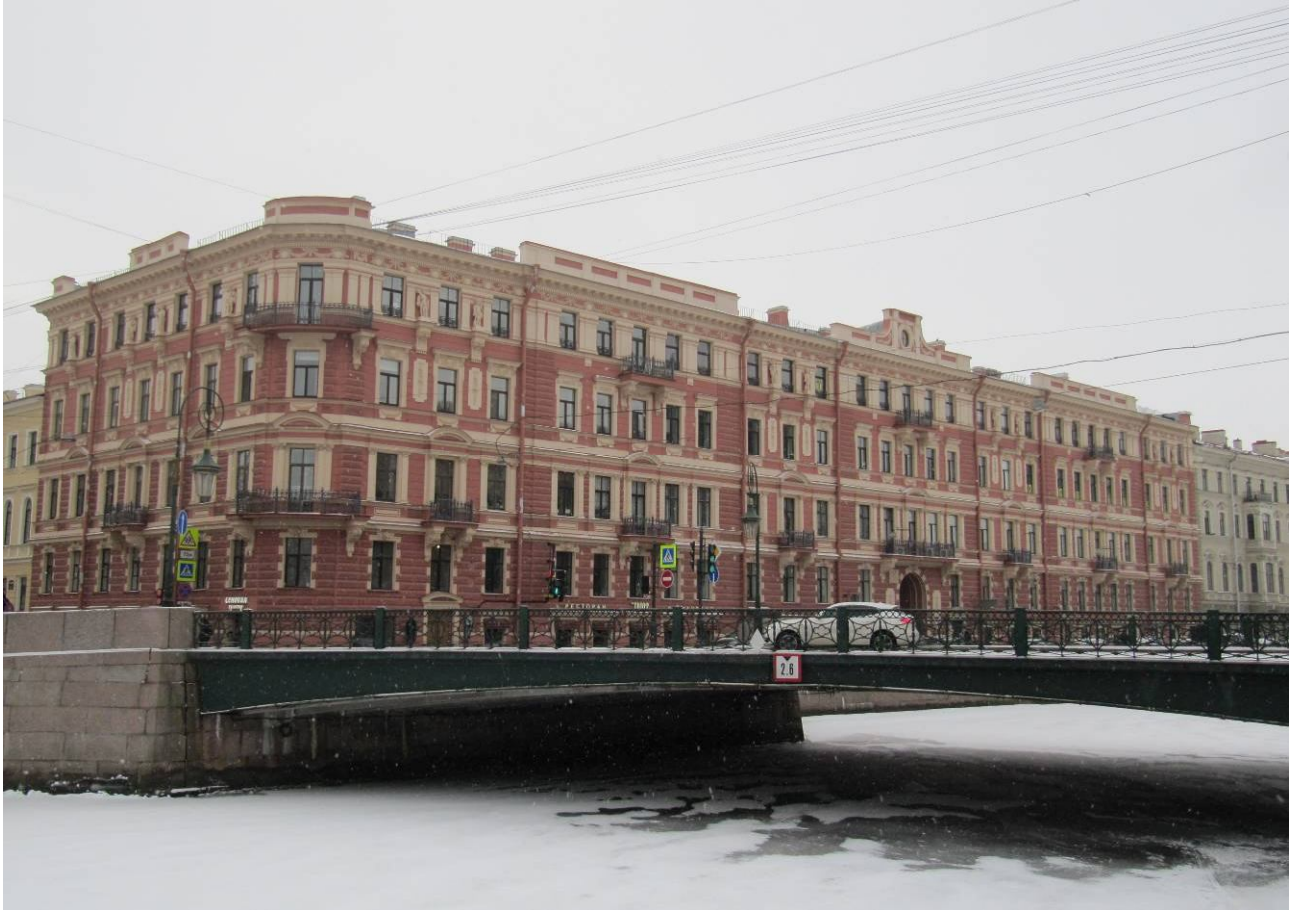
1. Доходные дома М.С. Воронина. Вид на лицевые фасады по Фонарному пер. и набережной р. Мойки.
