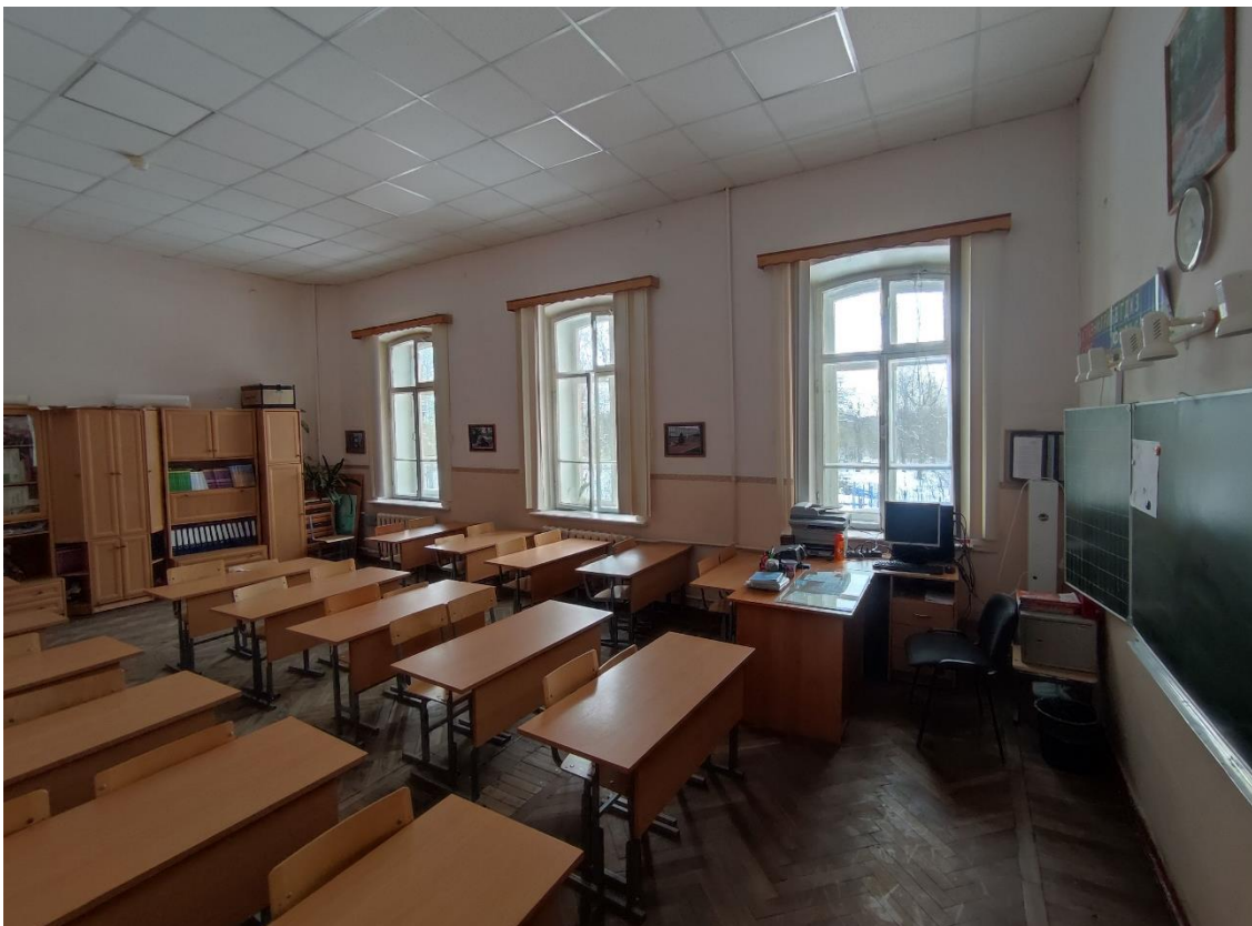
61. Выявленный объект культурного наследия «Школа нянь», по адресу: Санкт-Петербург, город Пушкин, Красносельское шоссе, дом 9, литера А. Общий вид пом. 2-Н (23) в уровне 2-го этажа.
