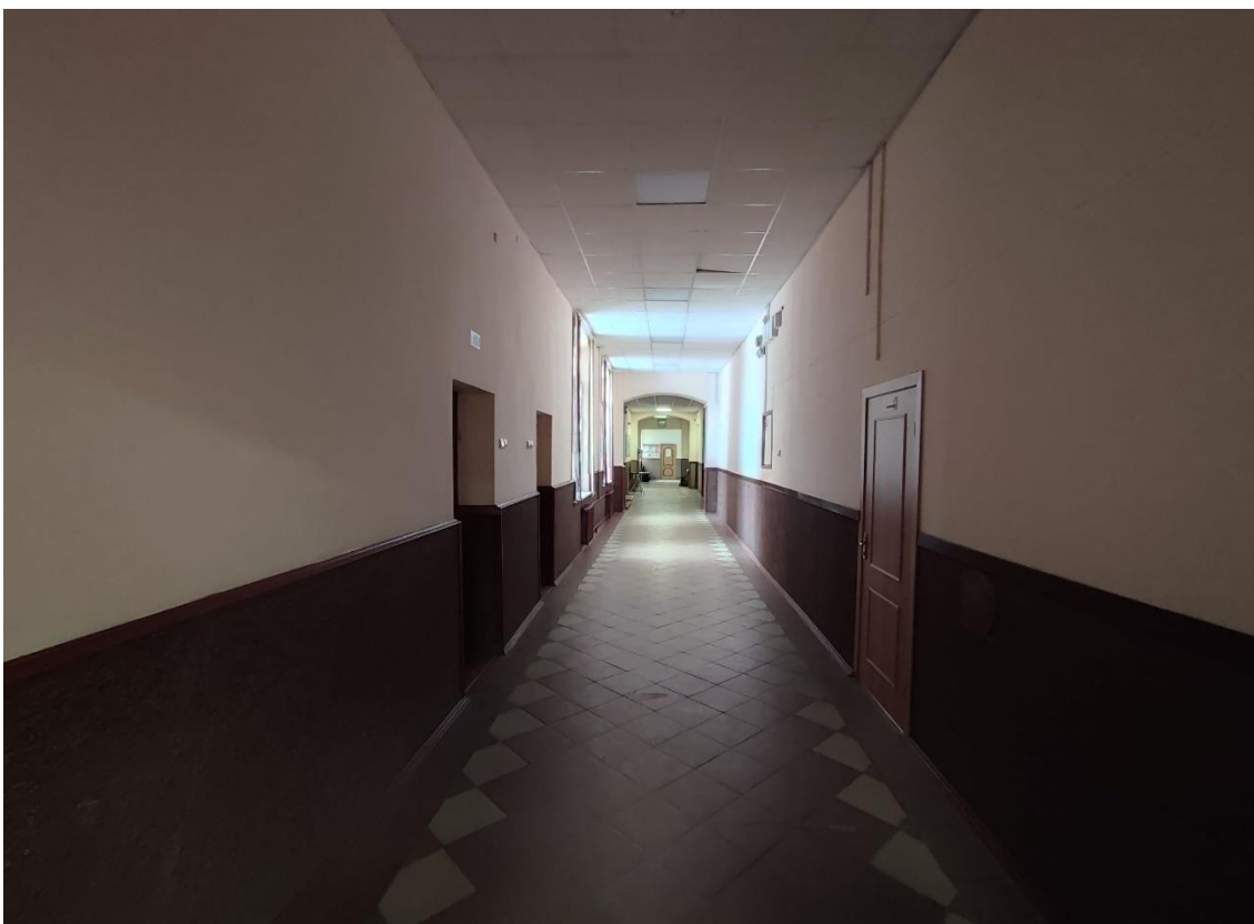
31. Выявленный объект культурного наследия «Школа нянь», по адресу: Санкт-Петербург, город Пушкин, Красносельское шоссе, дом 9, литера А. Общий вид пом. 1-Н (31) в уровне 1-го этажа.
