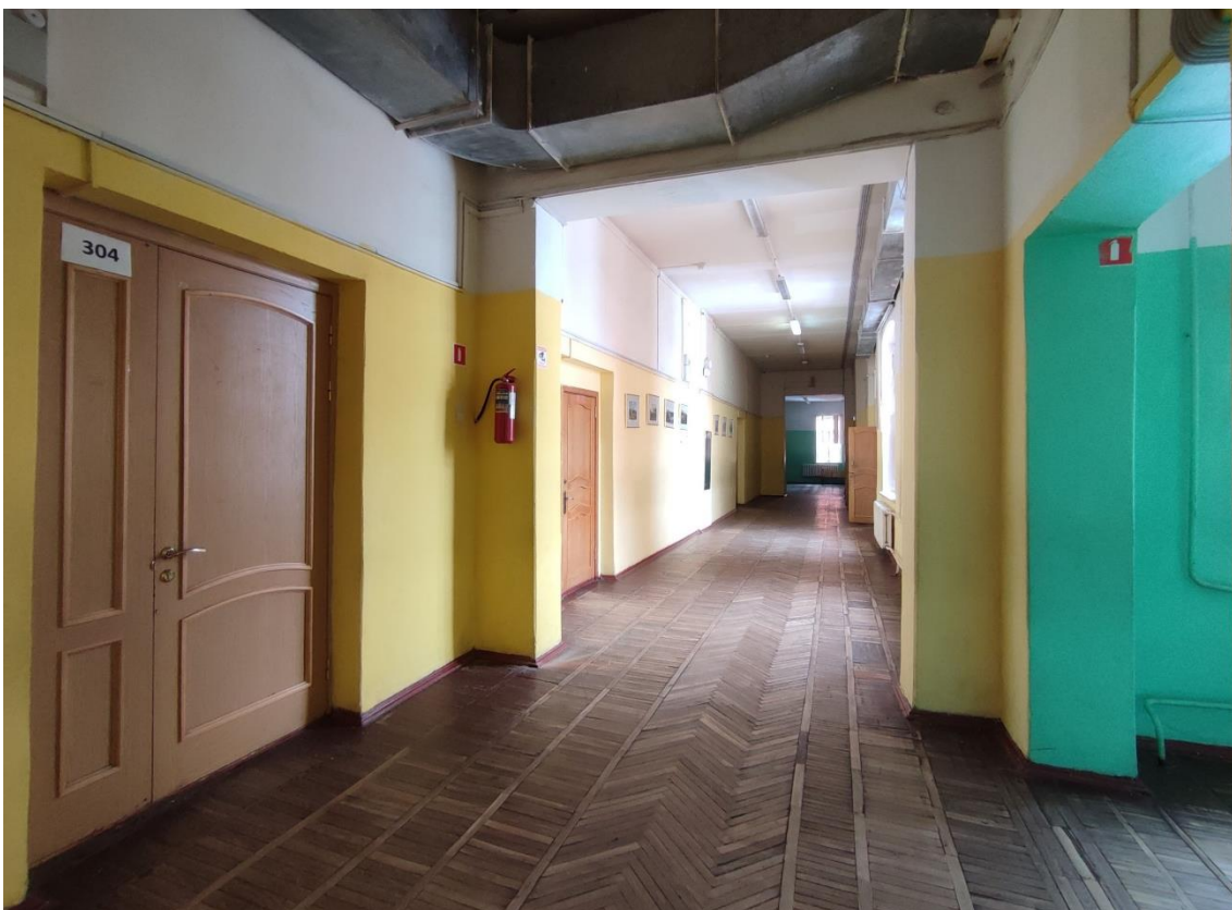
73. Выявленный объект культурного наследия «Школа нянь», по адресу: Санкт-Петербург, город Пушкин, Красносельское шоссе, дом 9, литера А. Общий вид пом. 3-Н (24) в уровне 3-го этажа.
