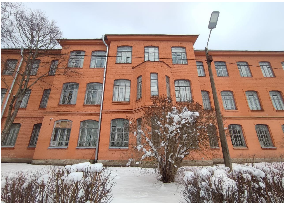
4. Выявленный объект культурного наследия «Школа нянь», по адресу: Санкт-Петербург, город Пушкин, Красносельское шоссе, дом 9, литера А. Фрагмент южного лицевого фасада.
