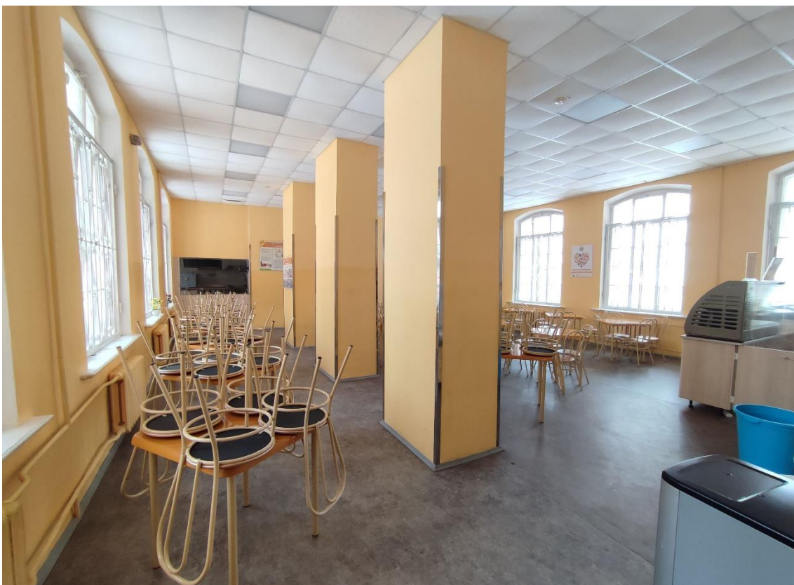
26. Выявленный объект культурного наследия «Школа нянь», по адресу: Санкт-Петербург, город Пушкин, Красносельское шоссе, дом 9, литера А. Общий вид пом. 1-Н (33) в уровне 1-го этажа.
