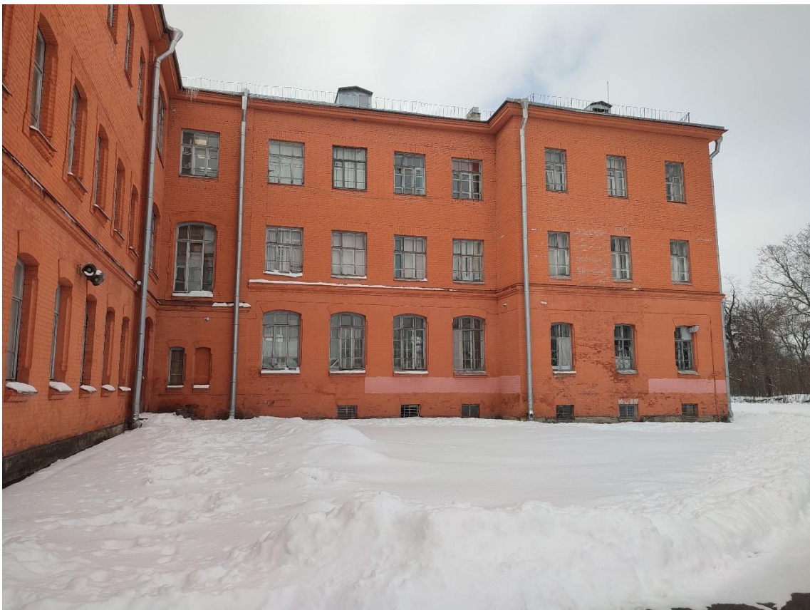
6. Выявленный объект культурного наследия «Школа нянь», по адресу: Санкт-Петербург, город Пушкин, Красносельское шоссе, дом 9, литера А. Общий вид восточного дворового фасада северного поперечного объема здания.
