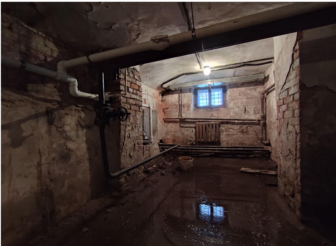
16. Выявленный объект культурного наследия «Школа нянь», по адресу: Санкт-Петербург, город Пушкин, Красносельское шоссе, дом 9, литера А. Общий вид пом. 4-Н (12) в уровне подвала.
