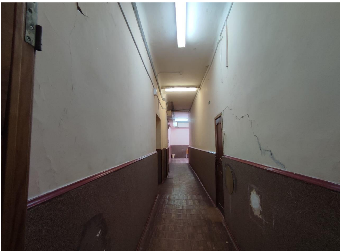
22. Выявленный объект культурного наследия «Школа нянь», по адресу: Санкт-Петербург, город Пушкин, Красносельское шоссе, дом 9, литера А. Общий вид пом. 1-Н (2) в уровне 1-го этажа.
