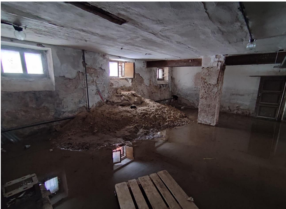
14. Выявленный объект культурного наследия «Школа нянь», по адресу: Санкт-Петербург, город Пушкин, Красносельское шоссе, дом 9, литера А. Фрагмент пом. 4-Н (9) в уровне подвала.
