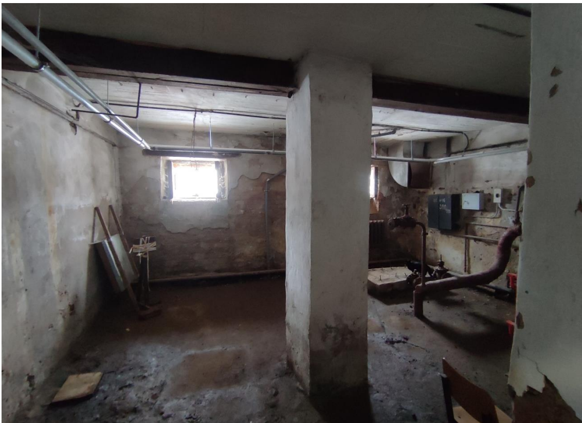
12. Выявленный объект культурного наследия «Школа нянь», по адресу: Санкт-Петербург, город Пушкин, Красносельское шоссе, дом 9, литера А. Общий вид пом. 4-Н (6) в уровне подвала.
