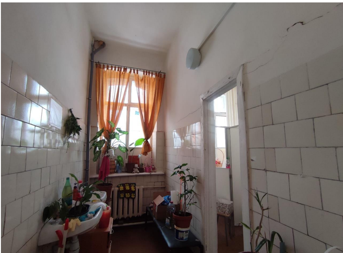
23. Выявленный объект культурного наследия «Школа нянь», по адресу: Санкт-Петербург, город Пушкин, Красносельское шоссе, дом 9, литера А. Общий вид пом. 1-Н (5) в уровне 1-го этажа.
