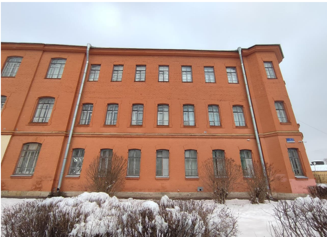
2. Выявленный объект культурного наследия «Школа нянь», по адресу: Санкт-Петербург, город Пушкин, Красносельское шоссе, дом 9, литера А. Фрагмент южного лицевого фасада.
