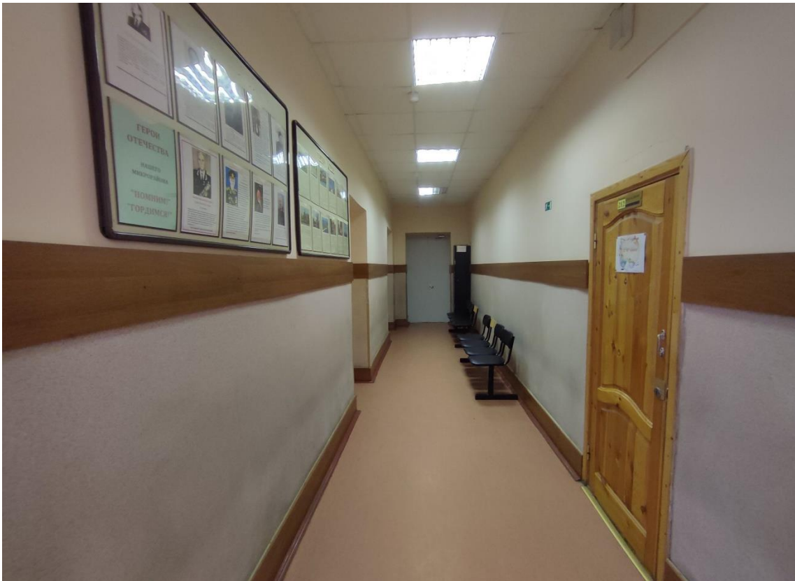
55. Выявленный объект культурного наследия «Школа нянь», по адресу: Санкт-Петербург, город Пушкин, Красносельское шоссе, дом 9, литера А. Общий вид пом. 2-Н (34) в уровне 2-го этажа.
