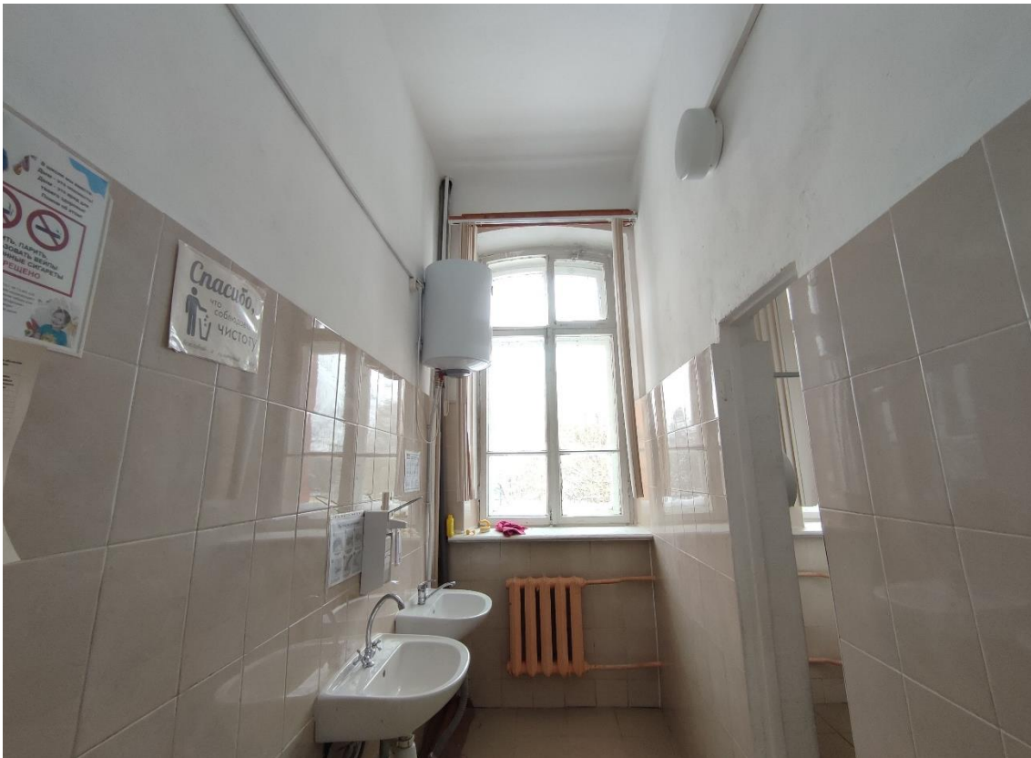
47. Выявленный объект культурного наследия «Школа нянь», по адресу: Санкт-Петербург, город Пушкин, Красносельское шоссе, дом 9, литера А. Общий вид пом. 2-Н (3) в уровне 2-го этажа.
