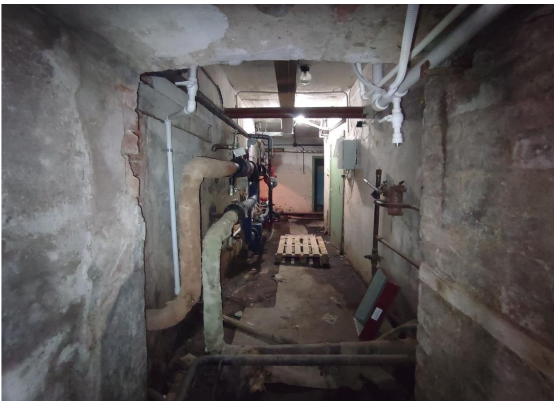
13. Выявленный объект культурного наследия «Школа нянь», по адресу: Санкт-Петербург, город Пушкин, Красносельское шоссе, дом 9, литера А. Общий вид пом. 4-Н (4) в уровне подвала.
