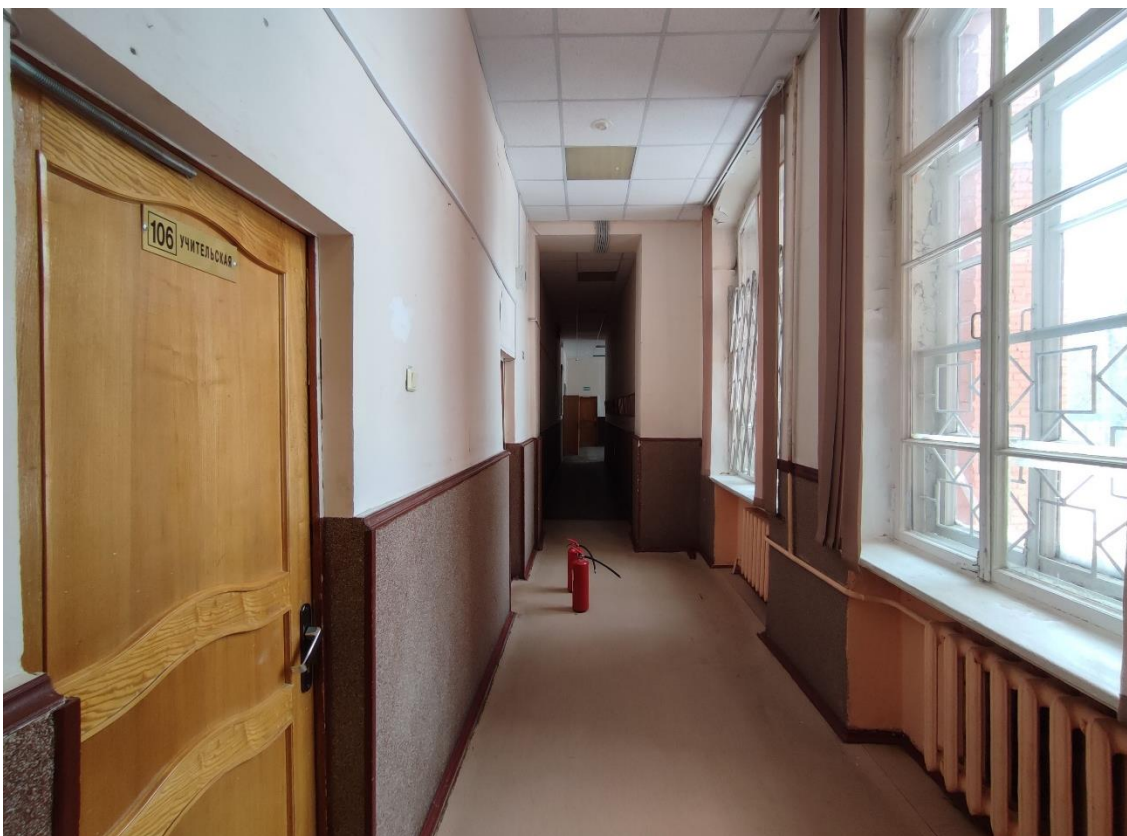
36. Выявленный объект культурного наследия «Школа нянь», по адресу: Санкт-Петербург, город Пушкин, Красносельское шоссе, дом 9, литера А. Общий вид пом. 1-Н (23) в уровне 1-го этажа.
