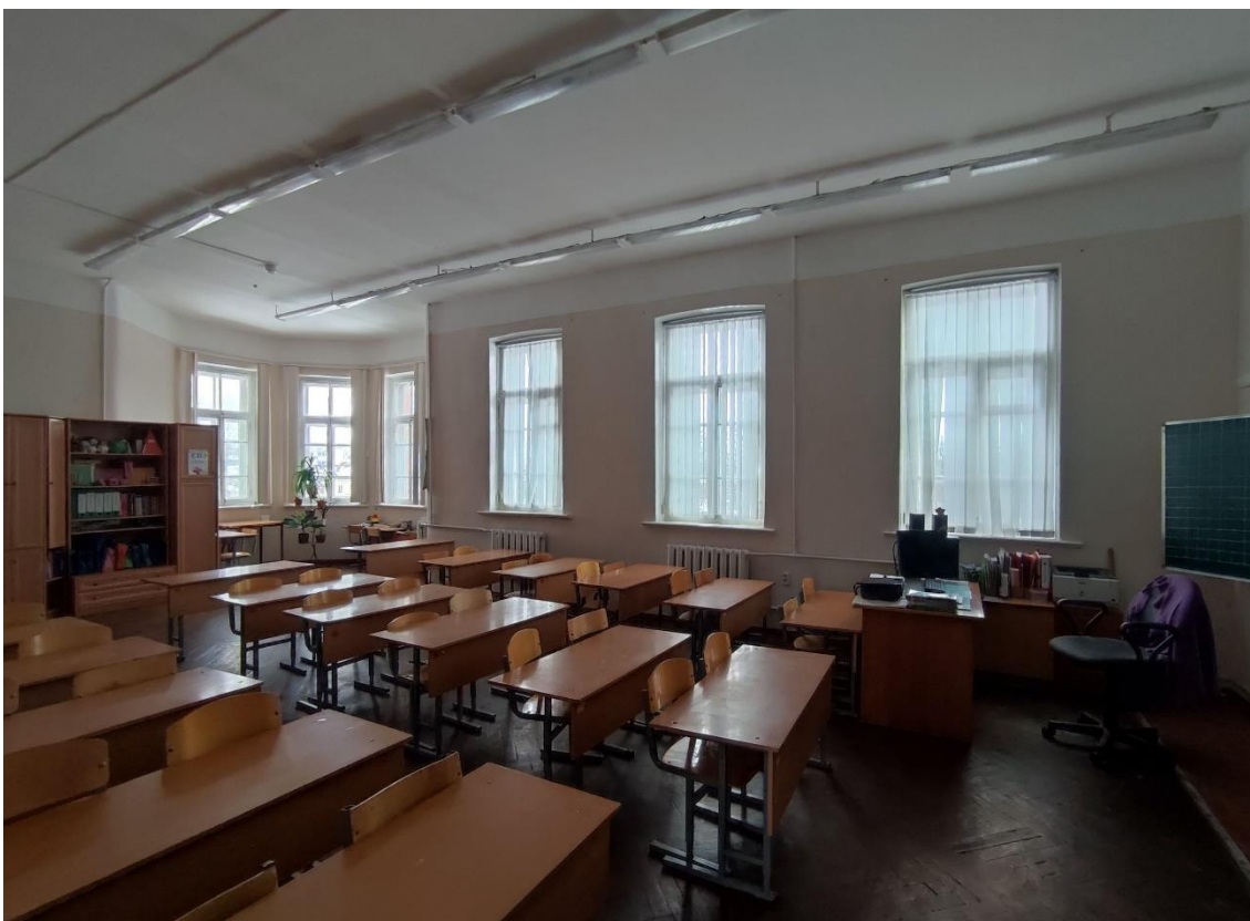
69. Выявленный объект культурного наследия «Школа нянь», по адресу: Санкт-Петербург, город Пушкин, Красносельское шоссе, дом 9, литера А. Общий вид пом. 3-Н (6) в уровне 3-го этажа.
