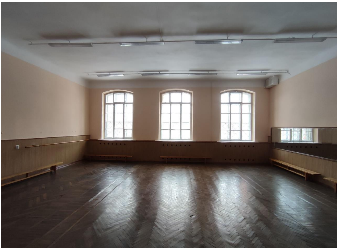
30. Выявленный объект культурного наследия «Школа нянь», по адресу: Санкт-Петербург, город Пушкин, Красносельское шоссе, дом 9, литера А. Общий вид пом. 1-Н (35) в уровне 1-го этажа.
