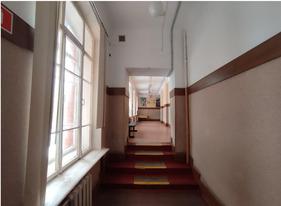
53. Выявленный объект культурного наследия «Школа нянь», по адресу: Санкт-Петербург, город Пушкин, Красносельское шоссе, дом 9, литера А. Общий вид пом. 2-Н (31) в уровне 2-го этажа.
