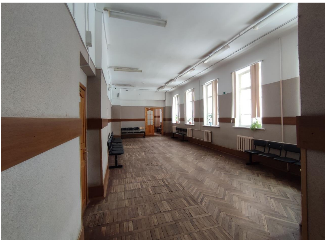
46. Выявленный объект культурного наследия «Школа нянь», по адресу: Санкт-Петербург, город Пушкин, Красносельское шоссе, дом 9, литера А. Общий вид пом. 2-Н (2) в уровне 2-го этажа.
