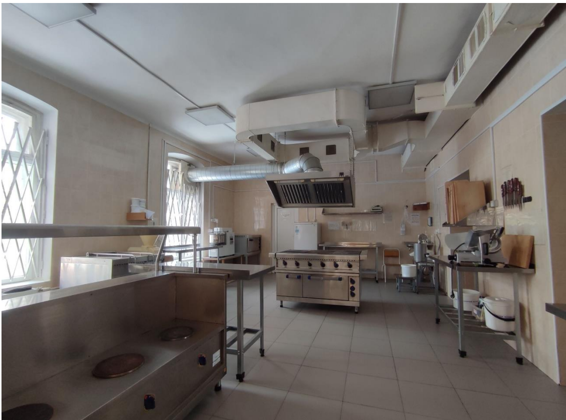
29. Выявленный объект культурного наследия «Школа нянь», по адресу: Санкт-Петербург, город Пушкин, Красносельское шоссе, дом 9, литера А. Общий вид пом. 1-Н (35) в уровне 1-го этажа.
