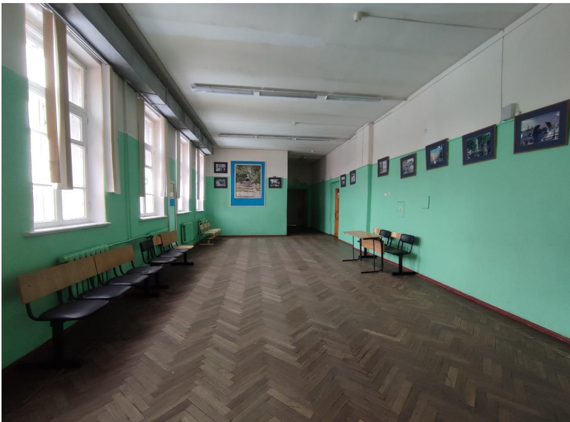
67. Выявленный объект культурного наследия «Школа нянь», по адресу: Санкт-Петербург, город Пушкин, Красносельское шоссе, дом 9, литера А. Общий вид пом. 3-Н (2) в уровне 3-го этажа.
