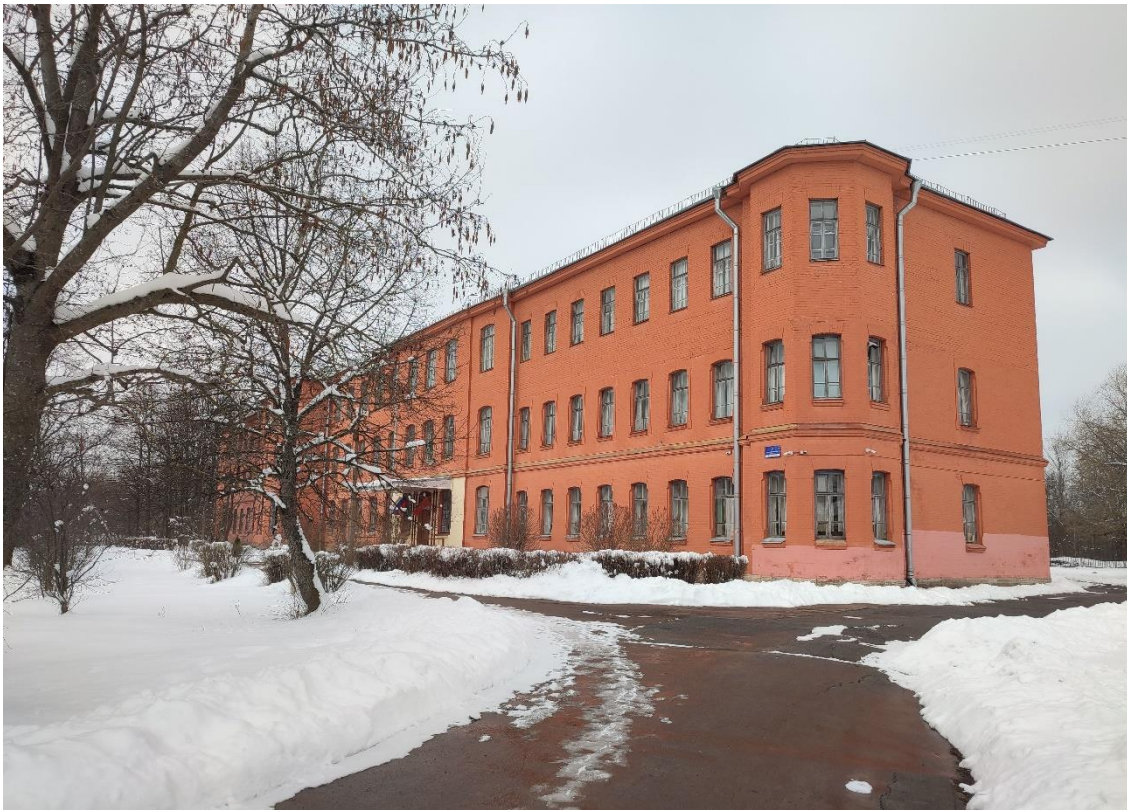
1. Выявленный объект культурного наследия «Школа нянь», по адресу: Санкт-Петербург, город Пушкин, Красносельское шоссе, дом 9, литера А. Общий вид южного лицевого фасада.
