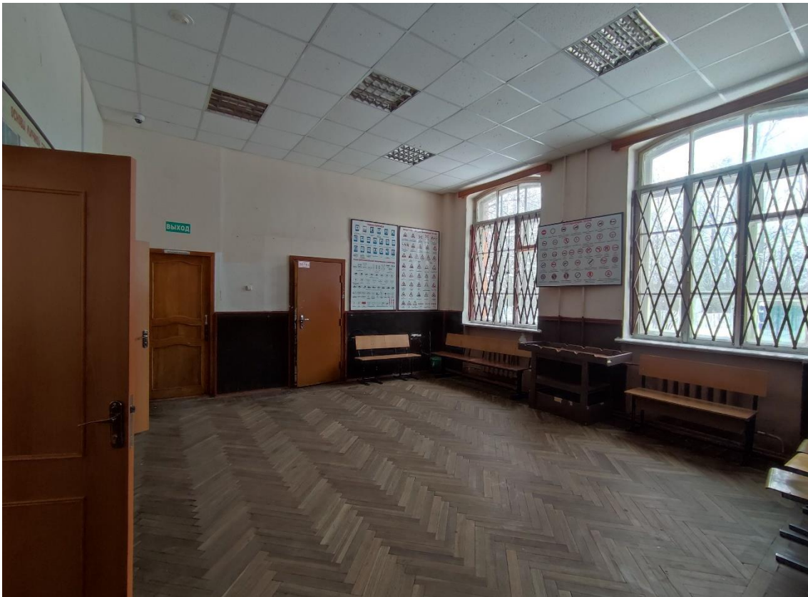
38. Выявленный объект культурного наследия «Школа нянь», по адресу: Санкт-Петербург, город Пушкин, Красносельское шоссе, дом 9, литера А. Общий вид пом. 1-Н (21) в уровне 1-го этажа.
