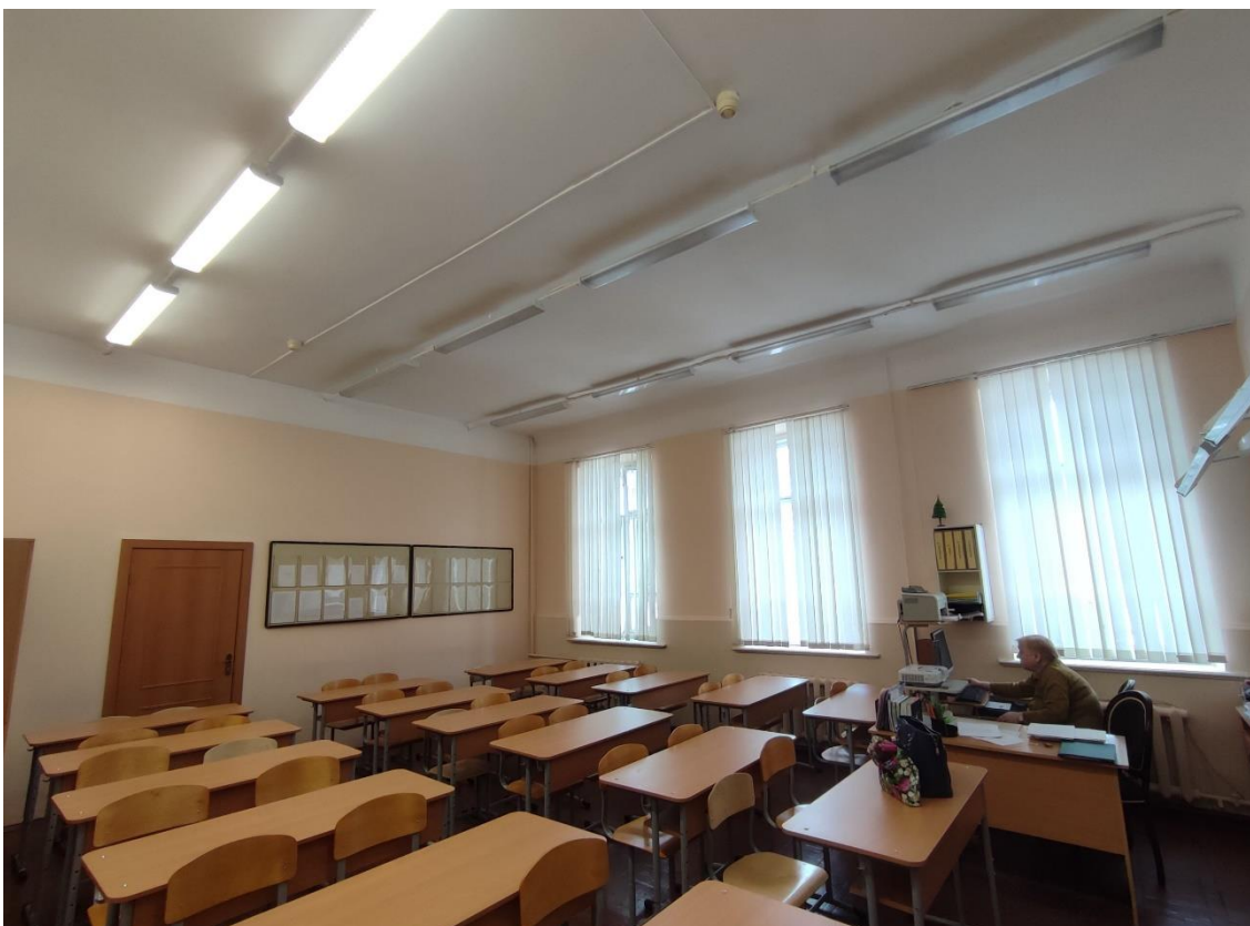
21. Выявленный объект культурного наследия «Школа нянь», по адресу: Санкт-Петербург, город Пушкин, Красносельское шоссе, дом 9, литера А. Общий вид пом. 1-Н (3) в уровне 1-го этажа.
