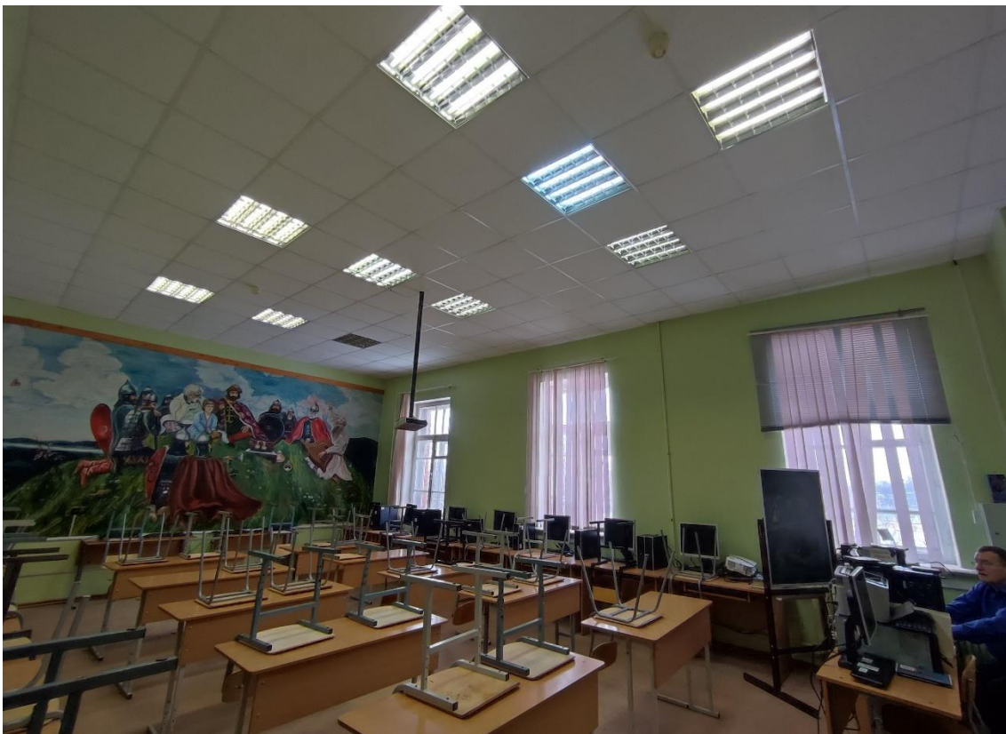
76. Выявленный объект культурного наследия «Школа нянь», по адресу: Санкт-Петербург, город Пушкин, Красносельское шоссе, дом 9, литера А. Общий вид пом. 3-Н (29) в уровне 3-го этажа.
