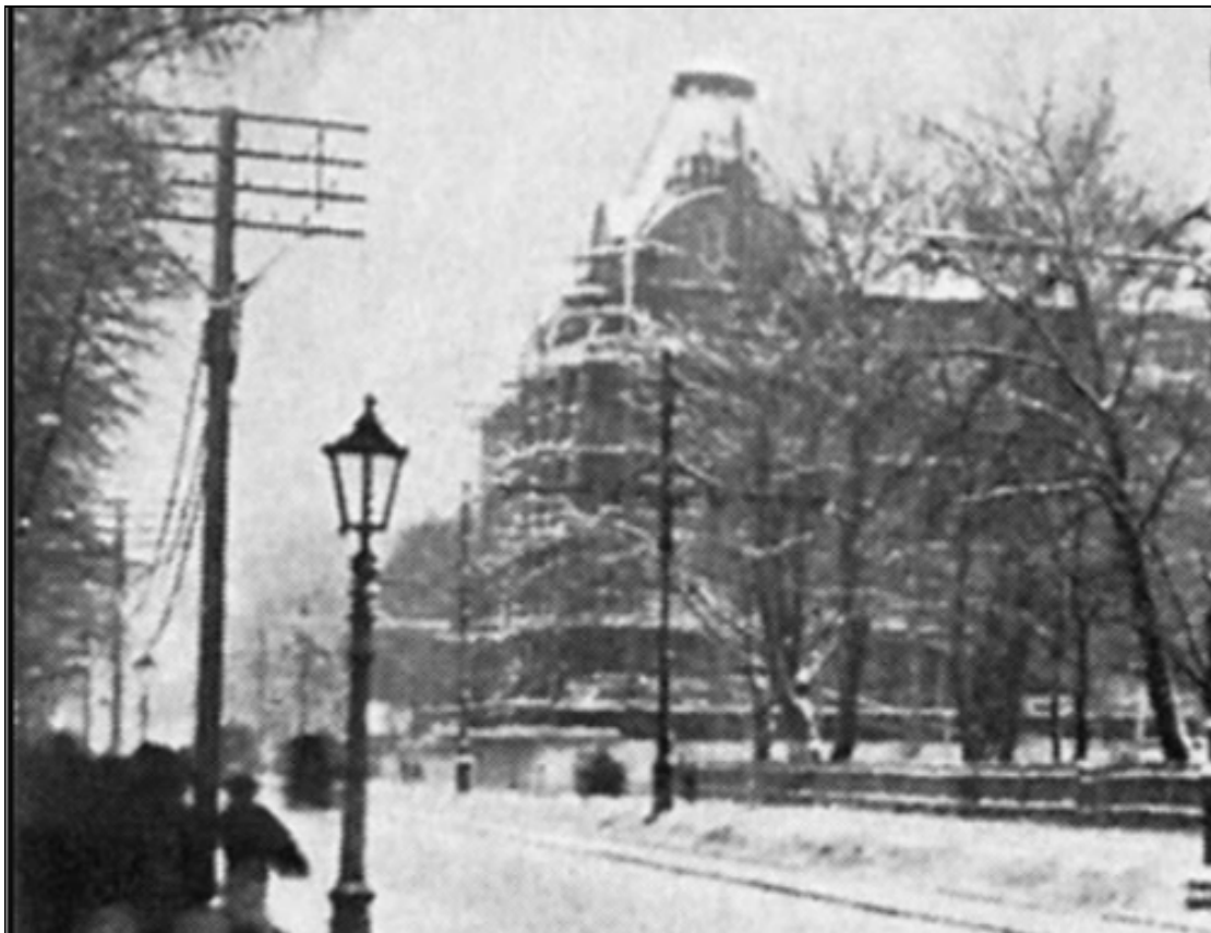
10. Фотография. Доходный дом К.В. Маркова в процессе строительства. 1908 г.
