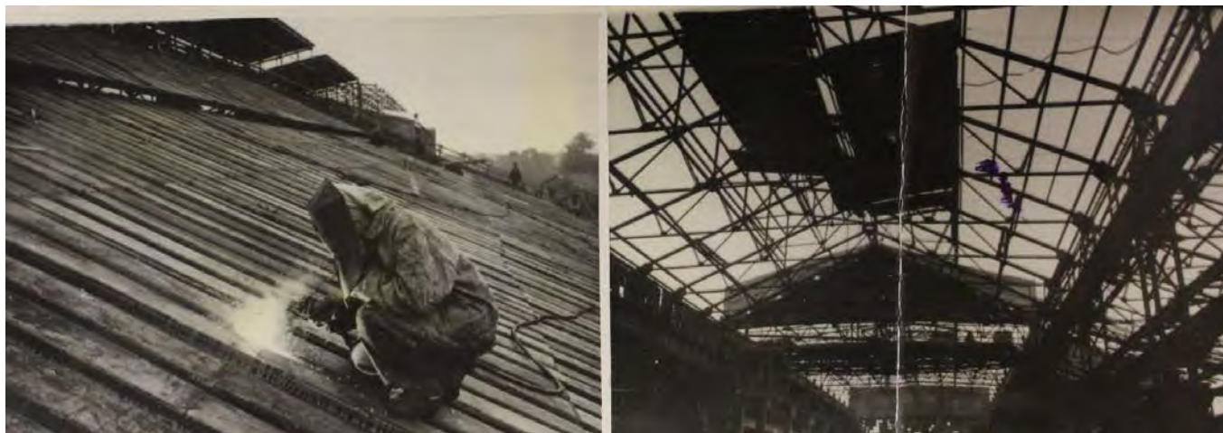
57. Реконструкция крыши сталелитейного цеха. 1948 г. // ЦГА КФФД СПб. Шифр: Ар 19275.
