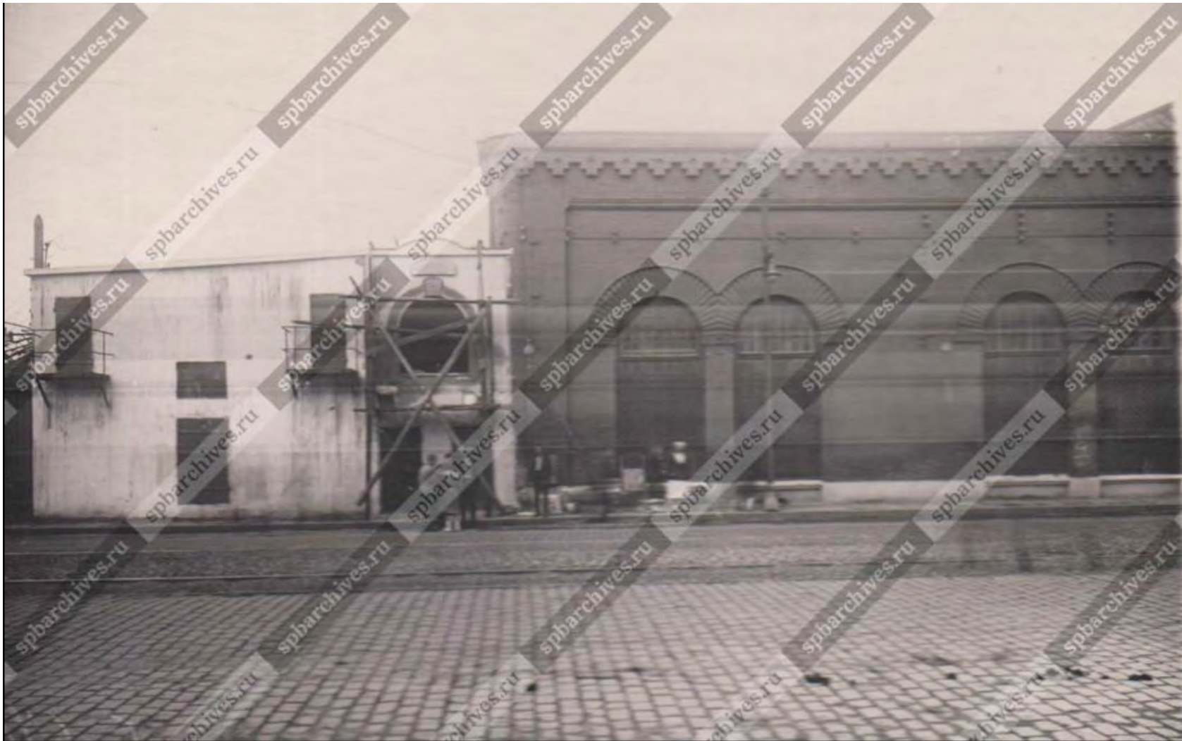
45. Северо-западная часть лицевого фасада прокатной и сталелитейной мастерской. 1934 г. // ЦГА КФФД СПб. Шифр: Гр 67087 (фрагмент).
