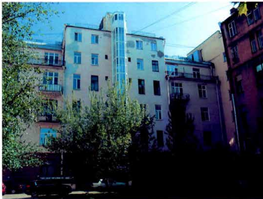
Фото 3. Вид на западный фасад. Фрагмент.
