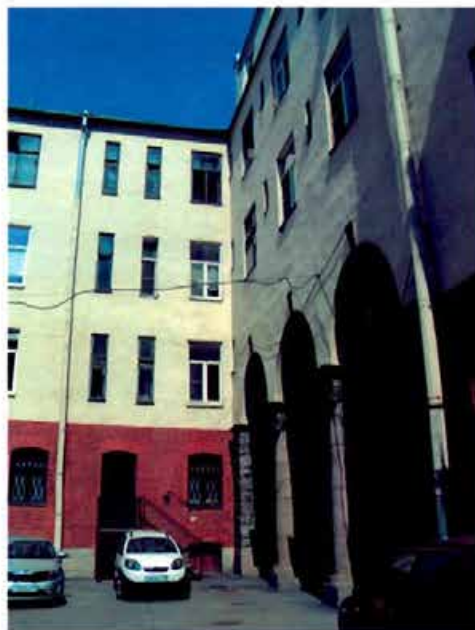
Фото 4. Вид на западный и южный фасады.
