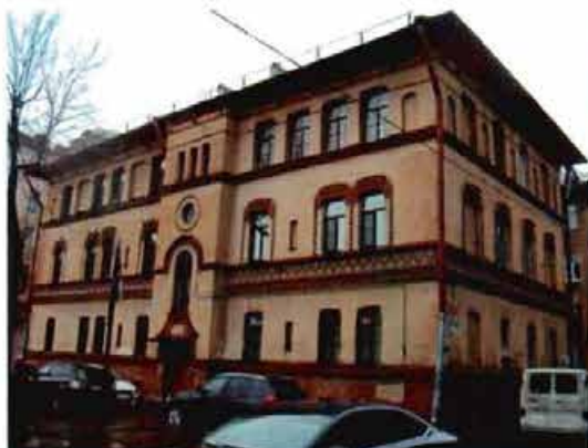
Фото 9. Вид на восточный и северный фасады.
