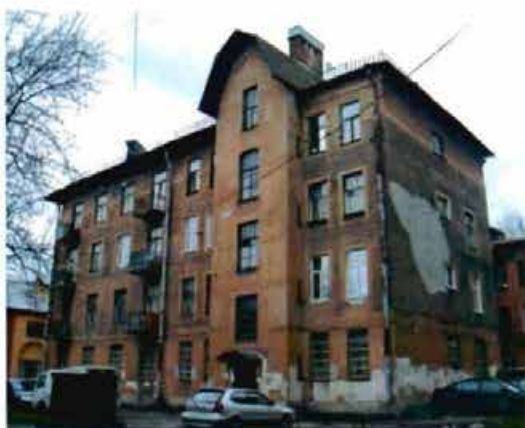
Фото 1. Вид на западный и южный фасады.
