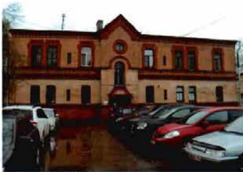
Фото 13. Вид на западный фасад.
