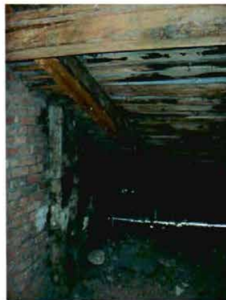
Фото 4. Чердачные помещения. Фрагмент.
