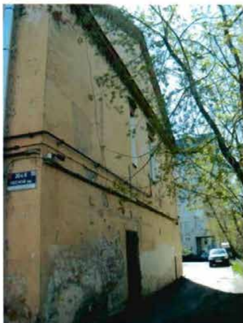
Фото 22. Вид на западный фасад.
