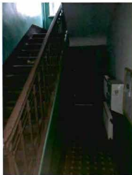
Фото 3. Лестница в северной части здания. Фрагмент. Метлахская плитка.
