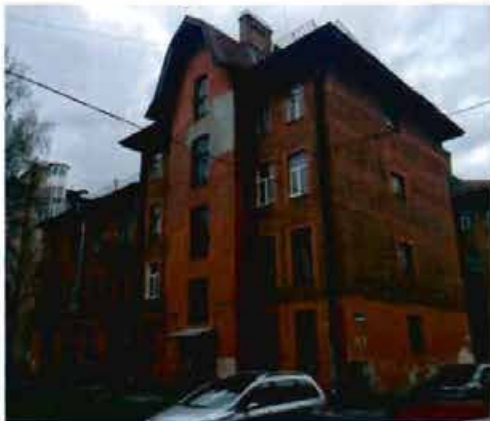
Фото 5. Вид на восточный и северный фасады.
