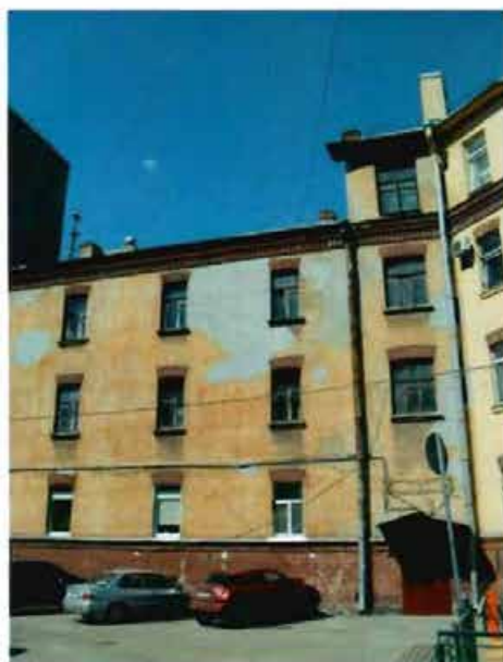
Фото 32. Вид на южный фасад. Фрагмент.
