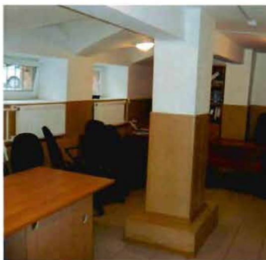
Фото 30. Пилоны в уровне подвального этажа. Фрагмент.
