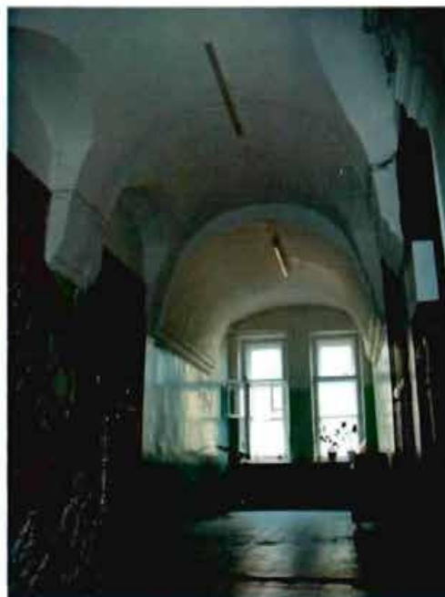
Фото 16. Вестибюль 2-го этажа. Цилиндрические своды с распалубками.
