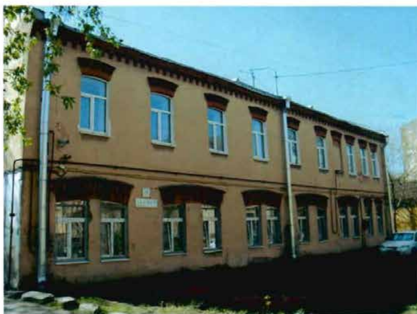
Фото 21. Вид на северный фасад.
