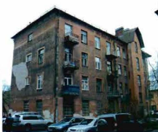
Фото 2. Вид на восточный и южный фасады.
