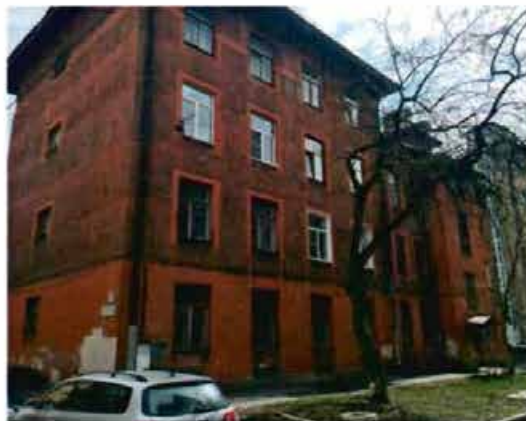
Фото 6. Вид на западный и северный фасады.
