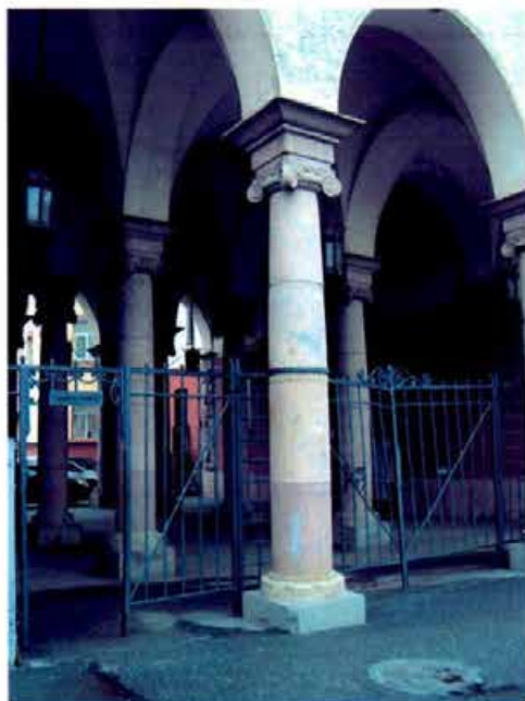
Фото 6. Ограда с калитками и воротами. Фрагмент.
