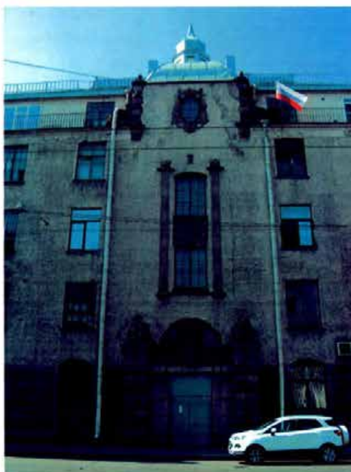
Фото 2. Вид на восточный фасад. Фрагмент.
