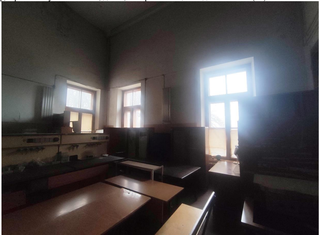
52. Объект культурного наследия федерального значения «Дворец герцога Максимилиана Лейхтенбергского с перголами и лестницами», расположенный по адресу: Санкт-Петербург, город Петергоф, Ораниенбаумское шоссе, дом 2, литера А. Общий вид пом. № 1-Н(41).
