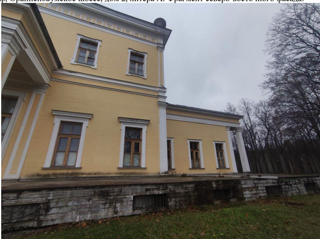
8. Объект культурного наследия федерального значения «Дворец герцога Максимилиана Лейхтенбергского с перголами и лестницами», расположенный по адресу: Санкт-Петербург, город Петергоф, Ораниенбаумское шоссе, дом 2, литера А. Фрагмент северо-восточного фасада.
