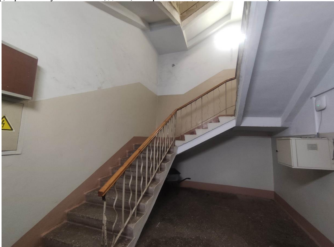
68. Объект культурного наследия федерального значения «Дворец герцога Максимилиана Лейхтенбергского с перголами и лестницами», расположенный по адресу: Санкт-Петербург, город Петергоф, Ораниенбаумское шоссе, дом 2, литера А. Фрагмент пом. № 1-Н(22).
