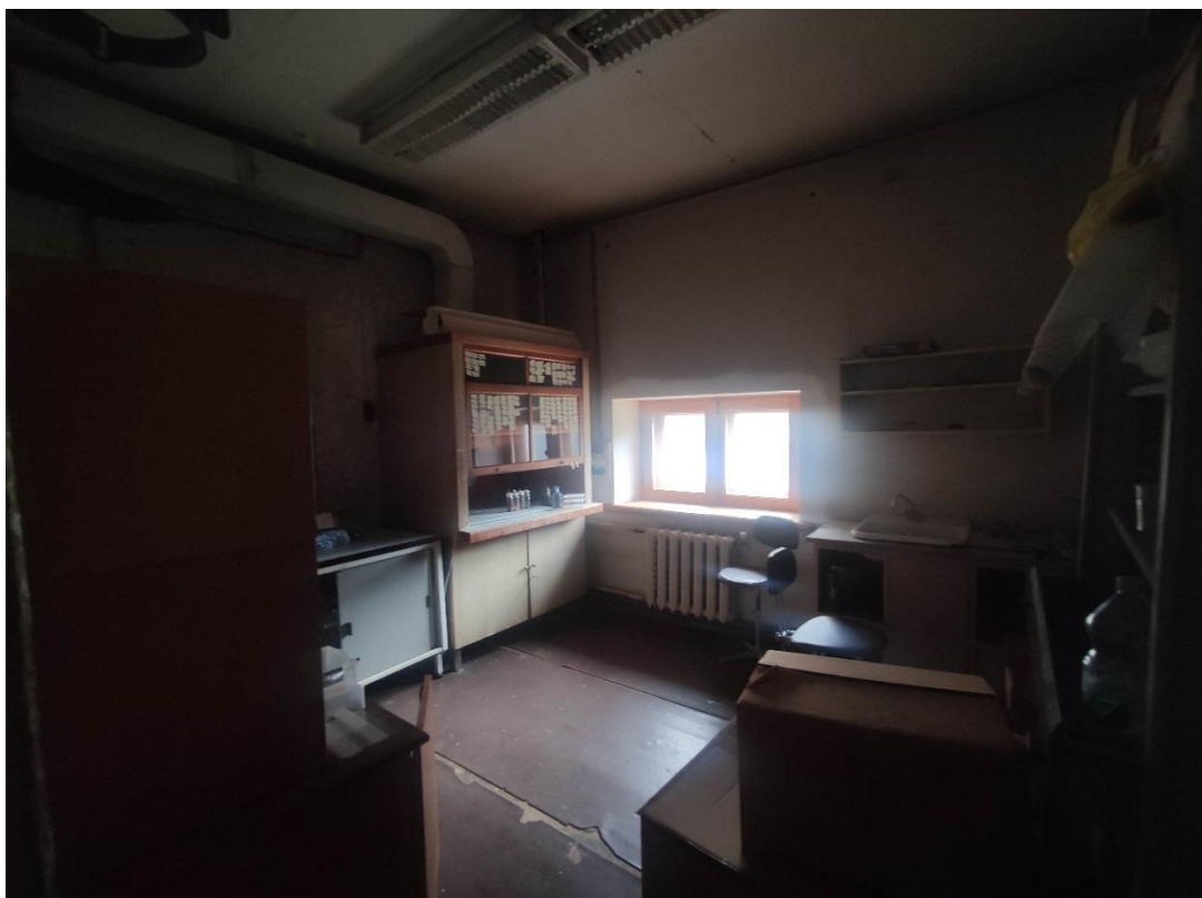
85. Объект культурного наследия федерального значения «Дворец герцога Максимилиана Лейхтенбергского с перголами и лестницами», расположенный по адресу: Санкт-Петербург, город Петергоф, Ораниенбаумское шоссе, дом 2, литера А. Общий вид пом. № 1-Н(50).
