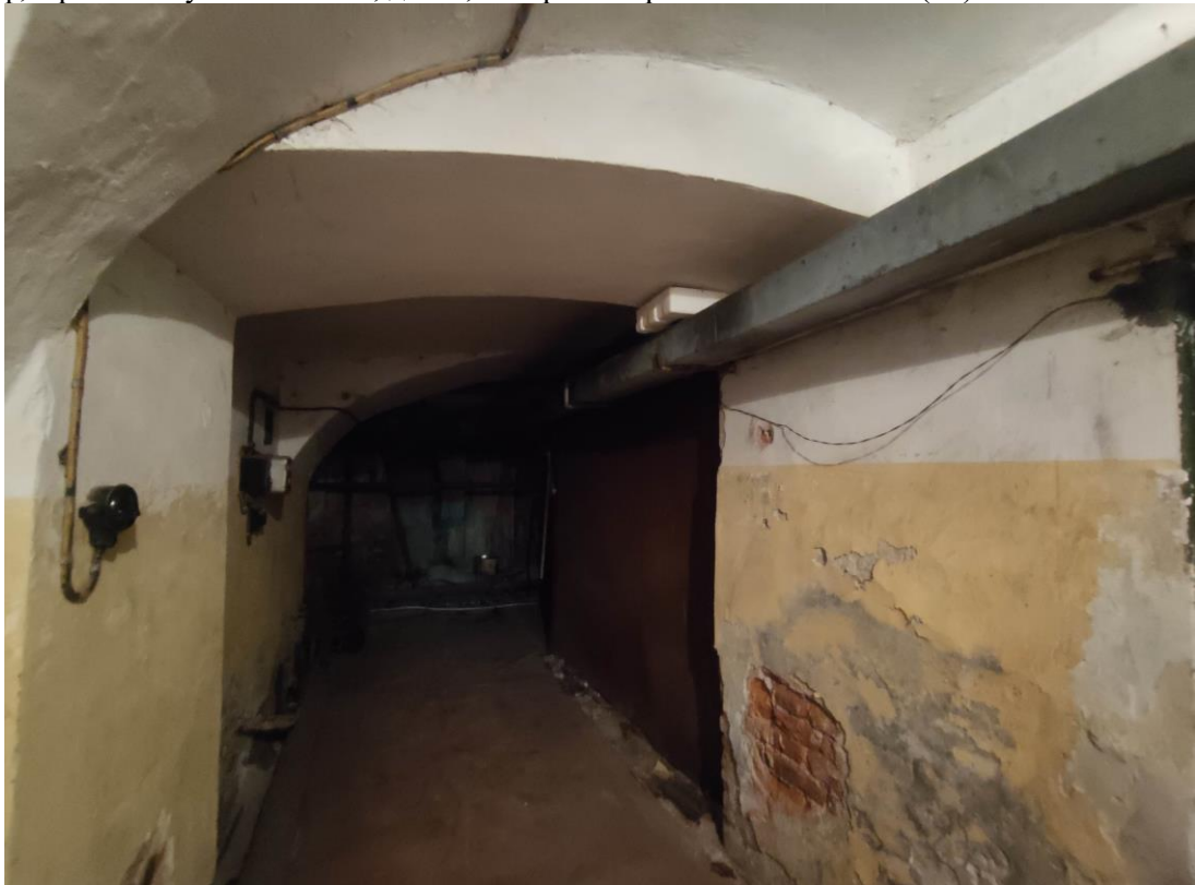
22. Объект культурного наследия федерального значения «Дворец герцога Максимилиана Лейхтенбергского с перголами и лестницами», расположенный по адресу: Санкт-Петербург, город Петергоф, Ораниенбаумское шоссе, дом 2, литера А. Фрагмент пом. № 3-Н(23).
