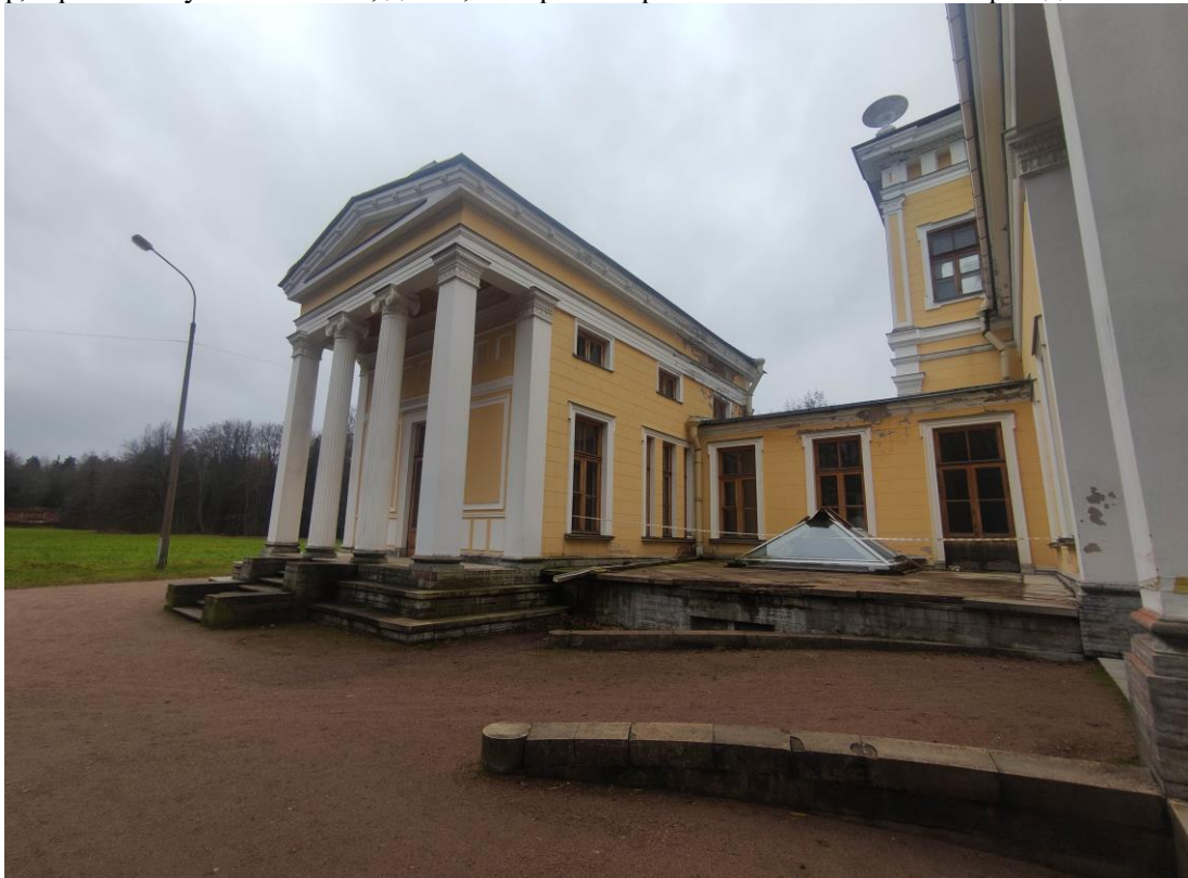
12. Объект культурного наследия федерального значения «Дворец герцога Максимилиана Лейхтенбергского с перголами и лестницами», расположенный по адресу: Санкт-Петербург, город Петергоф, Ораниенбаумское шоссе, дом 2, литера А. Фрагмент юго-восточного фасада.
