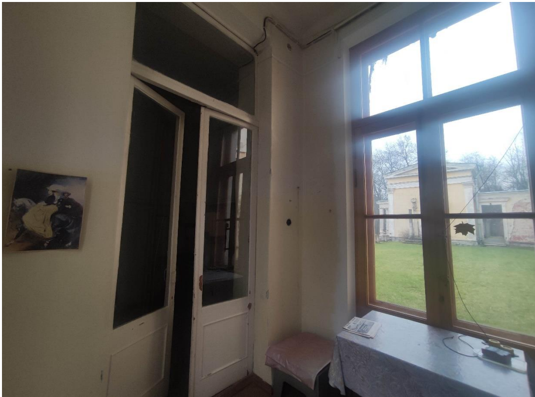
87. Объект культурного наследия федерального значения «Дворец герцога Максимилиана Лейхтенбергского с перголами и лестницами», расположенный по адресу: Санкт-Петербург, город Петергоф, Ораниенбаумское шоссе, дом 2, литера А. Фрагмент пом. № 1-Н(6).
