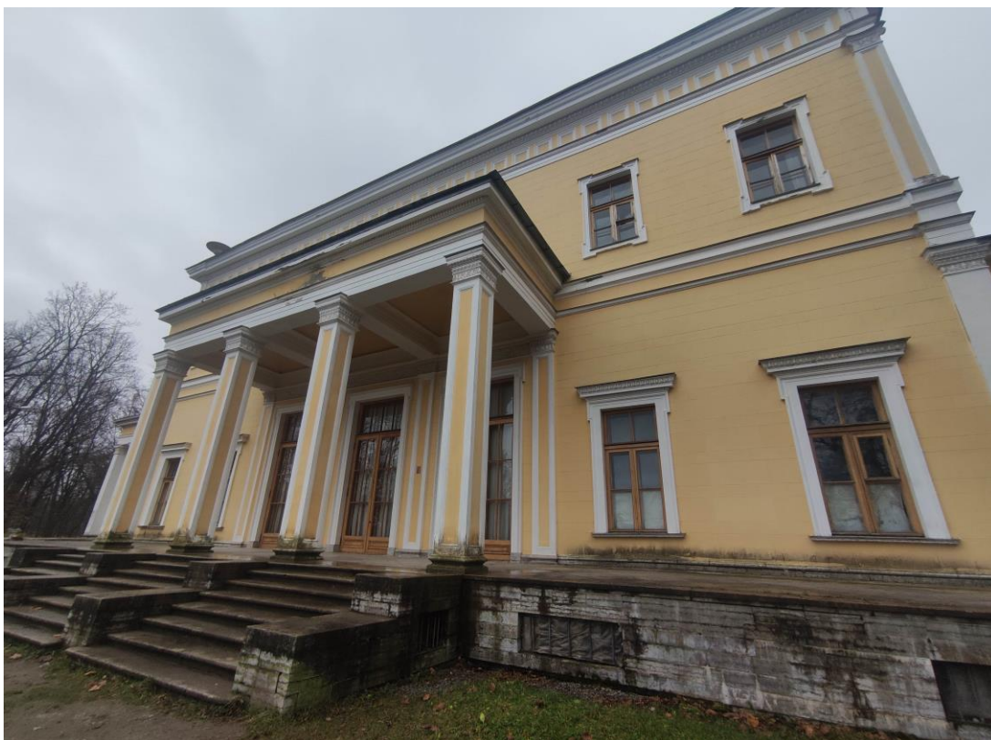
7. Объект культурного наследия федерального значения «Дворец герцога Максимилиана Лейхтенбергского с перголами и лестницами», расположенный по адресу: Санкт-Петербург, город Петергоф, Ораниенбаумское шоссе, дом 2, литера А. Фрагмент северо-восточного фасада.
