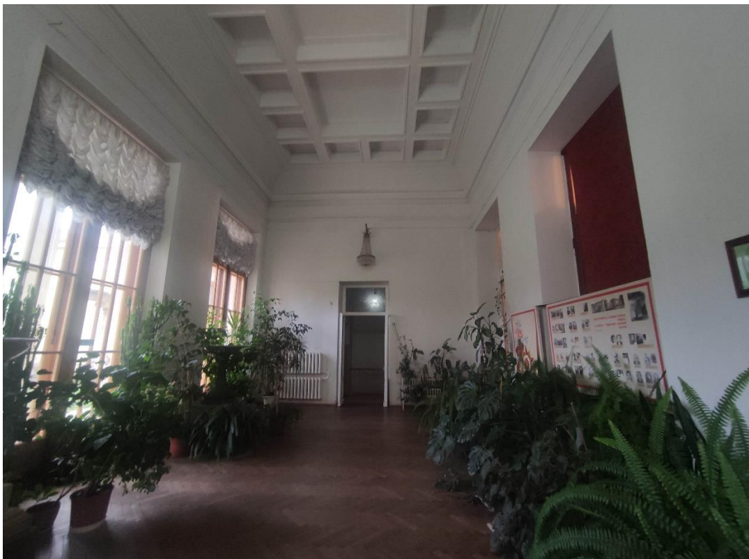
41. Объект культурного наследия федерального значения «Дворец герцога Максимилиана Лейхтенбергского с перголами и лестницами», расположенный по адресу: Санкт-Петербург, город Петергоф, Ораниенбаумское шоссе, дом 2, литера А. Общий вид пом. № 1-Н(27).
