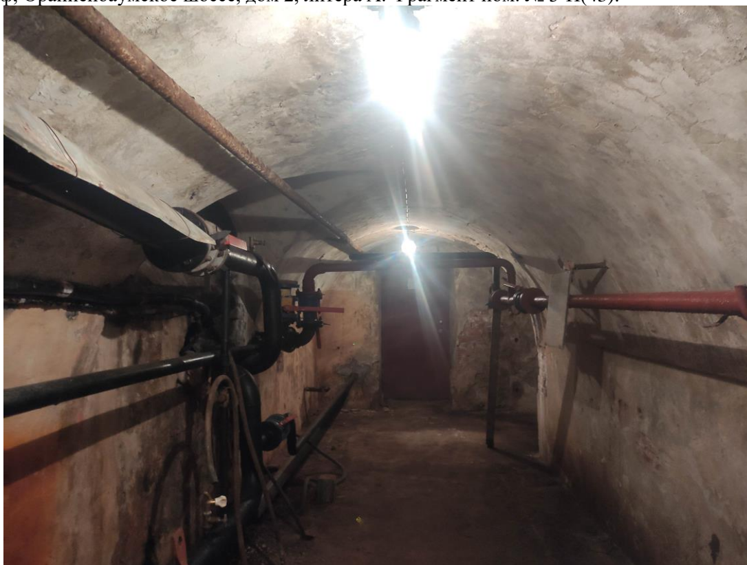
24. Объект культурного наследия федерального значения «Дворец герцога Максимилиана Лейхтенбергского с перголами и лестницами», расположенный по адресу: Санкт-Петербург, город Петергоф, Ораниенбаумское шоссе, дом 2, литера А. Фрагмент пом. № 3-Н(43).
