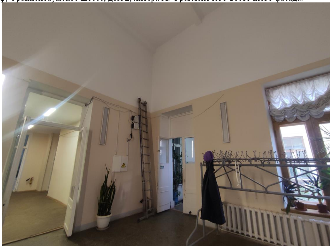
14. Объект культурного наследия федерального значения «Дворец герцога Максимилиана Лейхтенбергского с перголами и лестницами», расположенный по адресу: Санкт-Петербург, город Петергоф, Ораниенбаумское шоссе, дом 2, литера А. Общий вид пом. № 1-Н(4).
