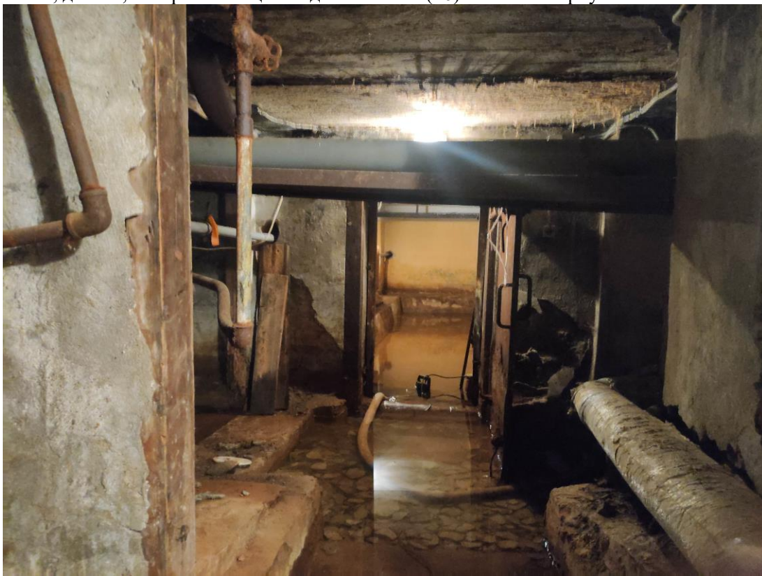
120. Объект культурного наследия регионального значения «Здание Физико-химического института Высших женских (Бестужевских) курсов», расположенный по адресу: г. Санкт-Петербург, Средний проспект В.О., дом 41, литера А. Общий вид пом. № 1-Н(49) дворового флигеля.
