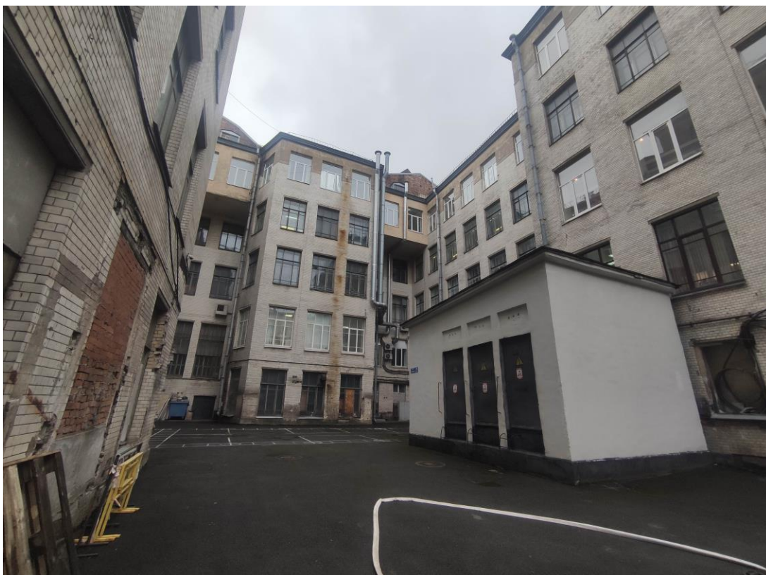
11. Объект культурного наследия регионального значения «Здание Физико-химического института Высших женских (Бестужевских) курсов», расположенный по адресу: г. Санкт-Петербург, Средний проспект В.О., дом 41, литера А. Общий вид внутреннего двора.
