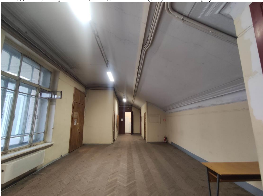
52. Объект культурного наследия регионального значения «Здание Физико-химического института Высших женских (Бестужевских) курсов», расположенный по адресу: г. Санкт-Петербург, Средний проспект В.О., дом 41, литера А. Общий вид пом. № 1-Н(317) главного корпуса.
