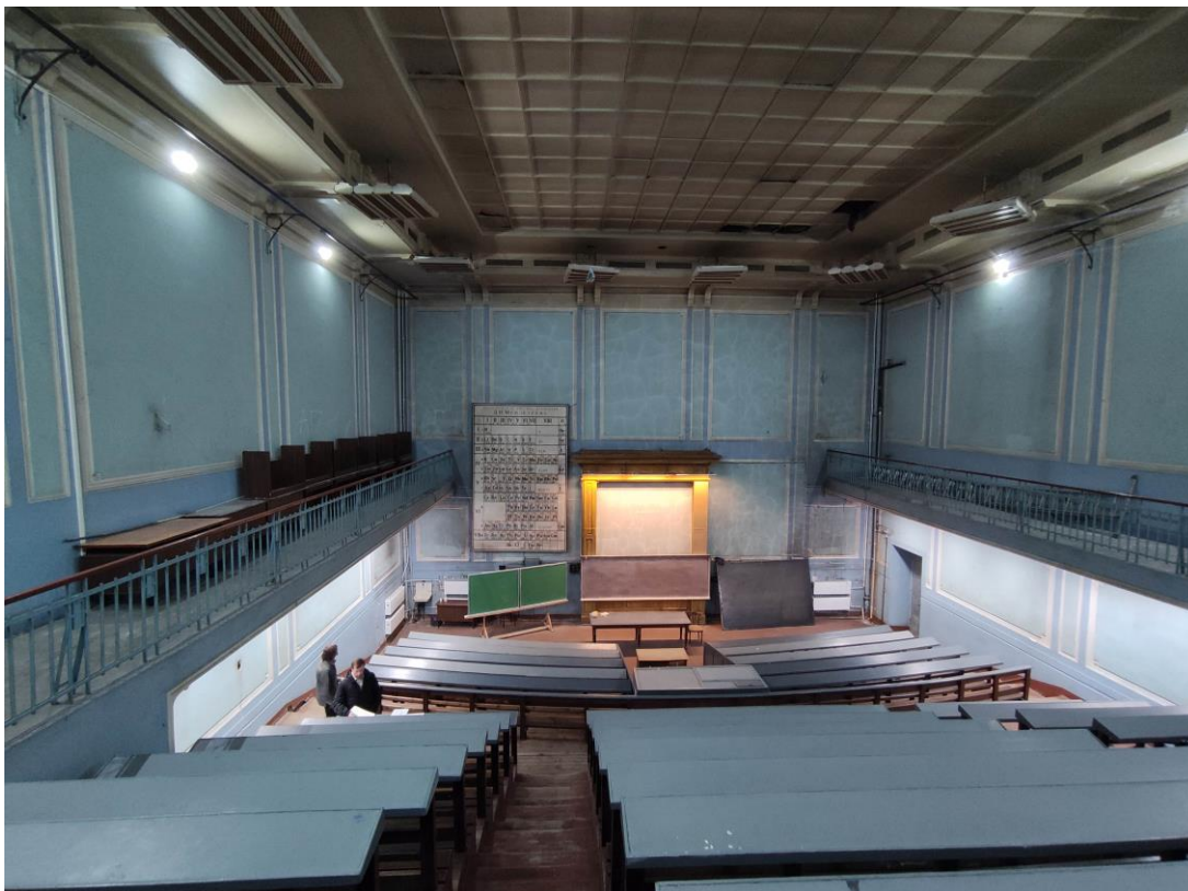
69. Объект культурного наследия регионального значения «Здание Физико-химического института Высших женских (Бестужевских) курсов», расположенный по адресу: г. Санкт-Петербург, Средний проспект В.О., дом 41, литера А. Общий вид пом. № 6/н главного корпуса (северо-западная большая аудитория).
