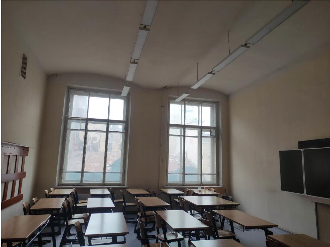
39. Объект культурного наследия регионального значения «Здание Физико-химического института Высших женских (Бестужевских) курсов», расположенный по адресу: г. Санкт-Петербург, Средний проспект В.О., дом 41, литера А. Общий вид пом. № 1-Н(237) главного корпуса.
