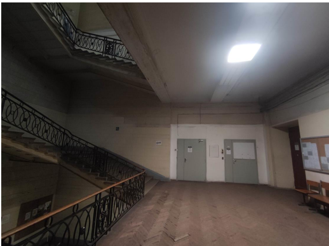
31. Объект культурного наследия регионального значения «Здание Физико-химического института Высших женских (Бестужевских) курсов», расположенный по адресу: г. Санкт-Петербург, Средний проспект В.О., дом 41, литера А. Общий вид пом. № 1-Н(247) главного корпуса.
