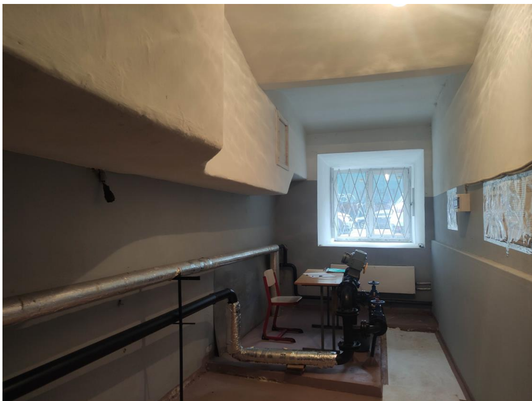
113. Объект культурного наследия регионального значения «Здание Физико-химического института Высших женских (Бестужевских) курсов», расположенный по адресу: г. Санкт-Петербург, Средний проспект В.О., дом 41, литера А. Общий вид пом. № 1-Н(1) главного корпуса.
