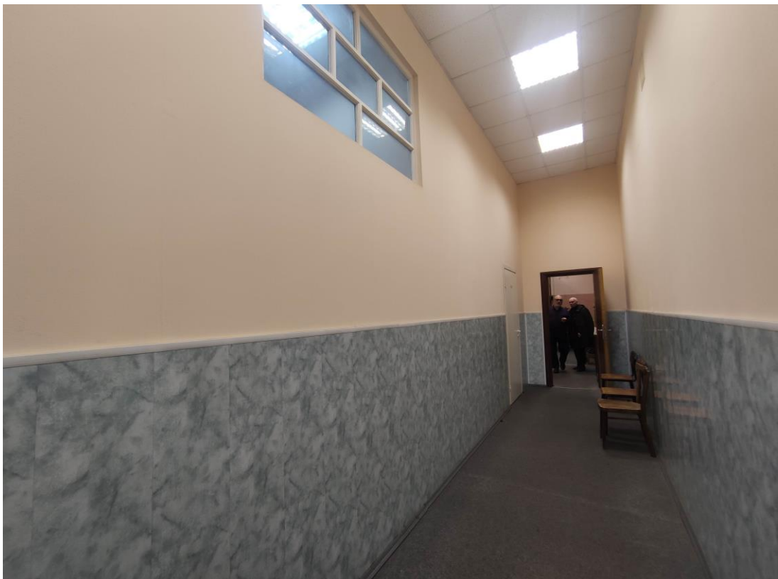
60. Объект культурного наследия регионального значения «Здание Физико-химического института Высших женских (Бестужевских) курсов», расположенный по адресу: г. Санкт-Петербург, Средний проспект В.О., дом 41, литера А. Общий вид пом. № 1-Н(309) главного корпуса.
