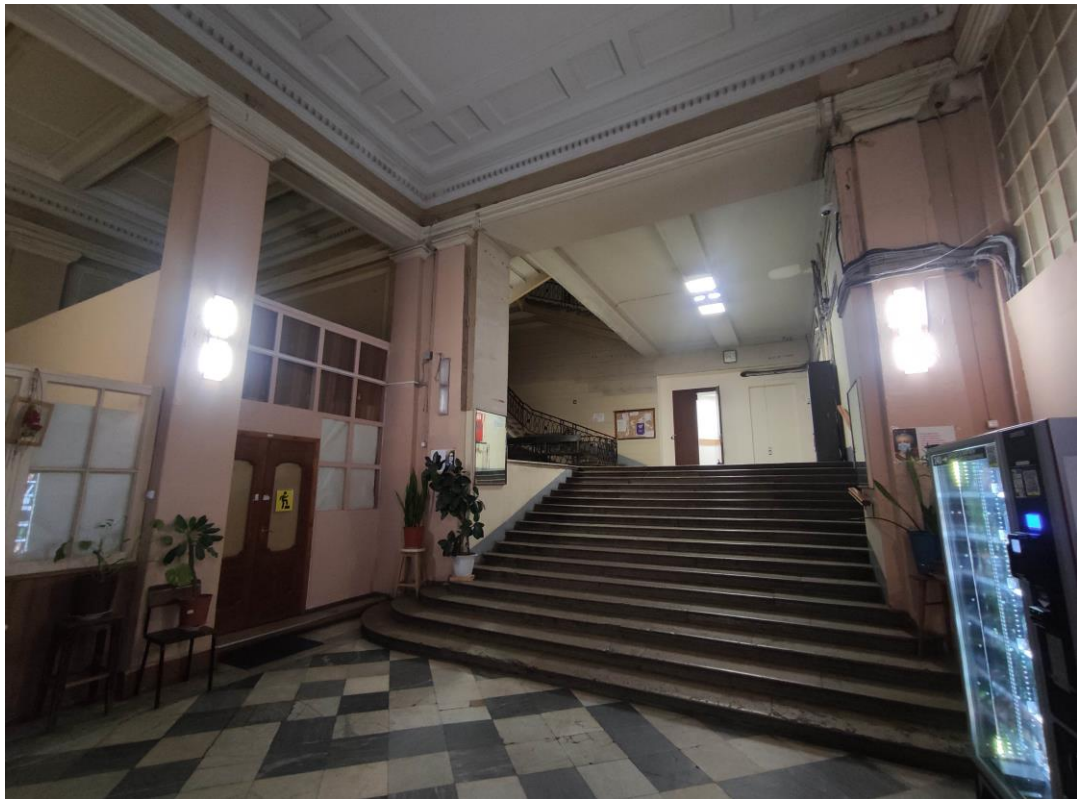
15. Объект культурного наследия регионального значения «Здание Физико-химического института Высших женских (Бестужевских) курсов», расположенный по адресу: г. Санкт-Петербург, Средний проспект В.О., дом 41, литера А. Общий вид пом. № 1-Н(104) главного корпуса, парадный вестибюль, лестница между парадным вестибюлем и парадной лестницей.
