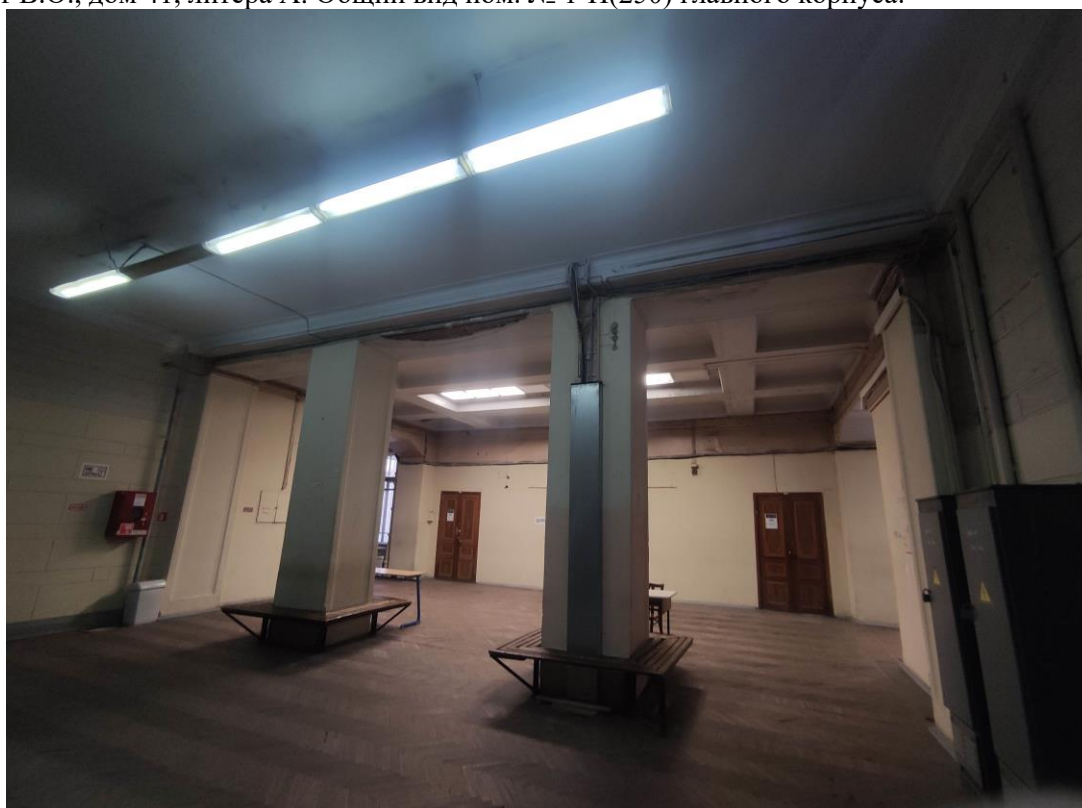
50. Объект культурного наследия регионального значения «Здание Физико-химического института Высших женских (Бестужевских) курсов», расположенный по адресу: г. Санкт-Петербург, Средний проспект В.О., дом 41, литера А. Общий вид пом. № 1-Н(322) главного корпуса.
