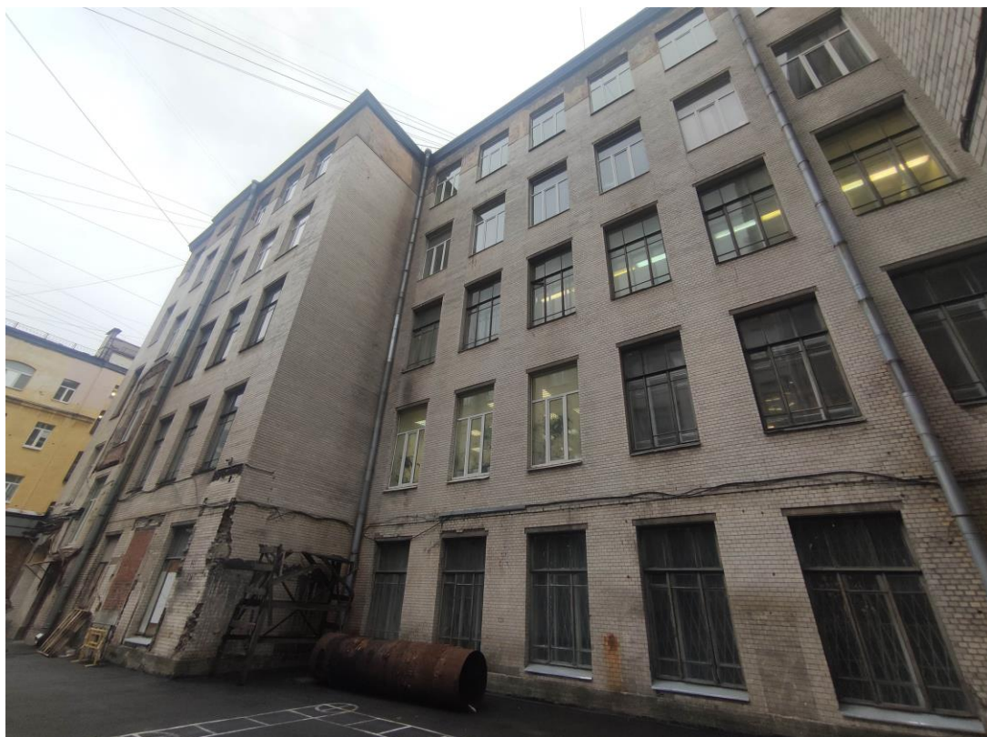
10. Объект культурного наследия регионального значения «Здание Физико-химического института Высших женских (Бестужевских) курсов», расположенный по адресу: г. Санкт-Петербург, Средний проспект В.О., дом 41, литера А. Общий вид фасада флигеля, расположенного вдоль Среднего проспекта В.О., выходящего во внутренний двор.
