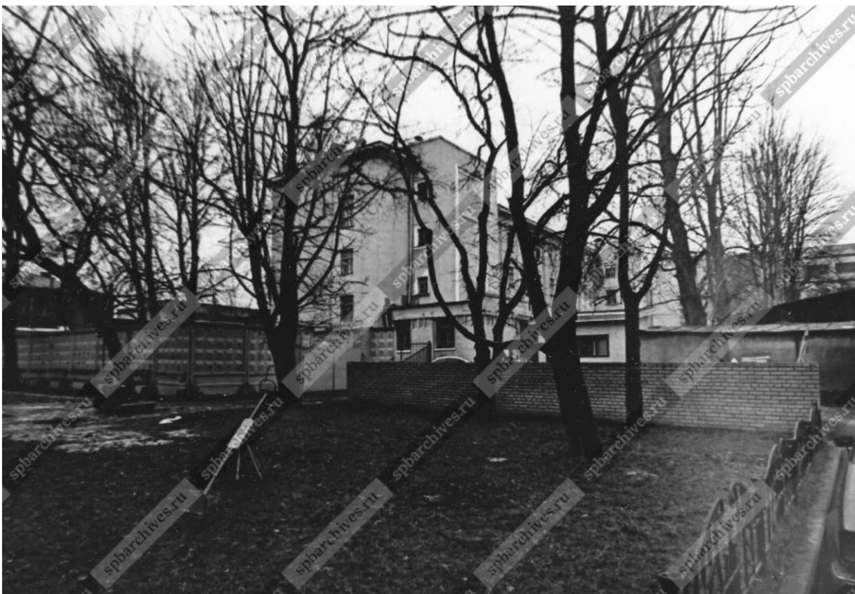
12. Вид на фасад здания факультета Военного обучения университета со стороны двора (В.О., Средний пр., д. 41). Архивный шифр: ЦГАКФФД СПб Ар 239207. Дата съёмки: 29 ноября 2003 г.
