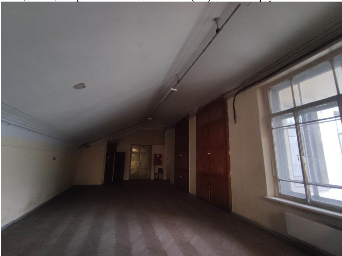
64. Объект культурного наследия регионального значения «Здание Физико-химического института Высших женских (Бестужевских) курсов», расположенный по адресу: г. Санкт-Петербург, Средний проспект В.О., дом 41, литера А. Общий вид пом. № 1-Н(324) главного корпуса.
