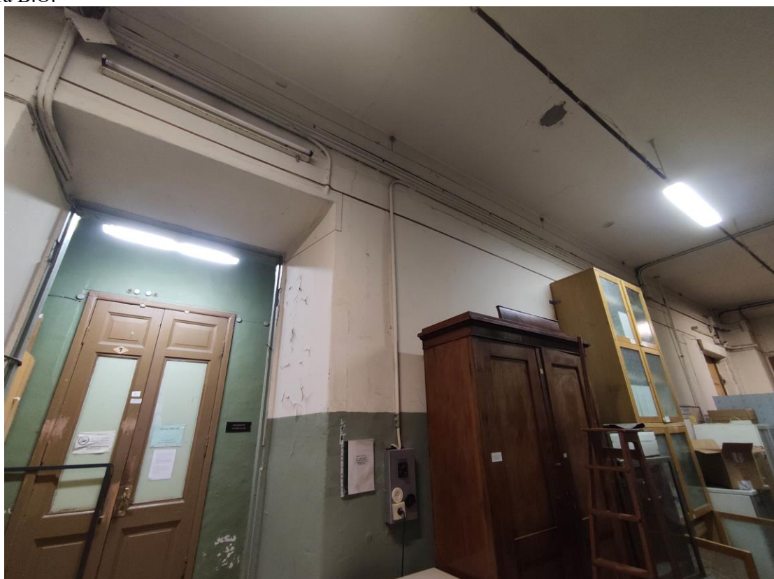
96. Объект культурного наследия регионального значения «Здание Физико-химического института Высших женских (Бестужевских) курсов», расположенный по адресу: г. Санкт-Петербург, Средний проспект В.О., дом 41, литера А. Общий вид пом. № 1-Н(152) флигеля, расположенного вдоль Среднего проспекта В.О.
