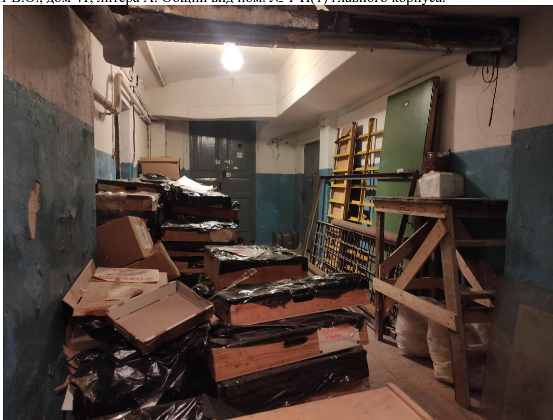
114. Объект культурного наследия регионального значения «Здание Физико-химического института Высших женских (Бестужевских) курсов», расположенный по адресу: г. Санкт-Петербург, Средний проспект В.О., дом 41, литера А. Общий вид пом. № 1-Н(3) главного корпуса.
