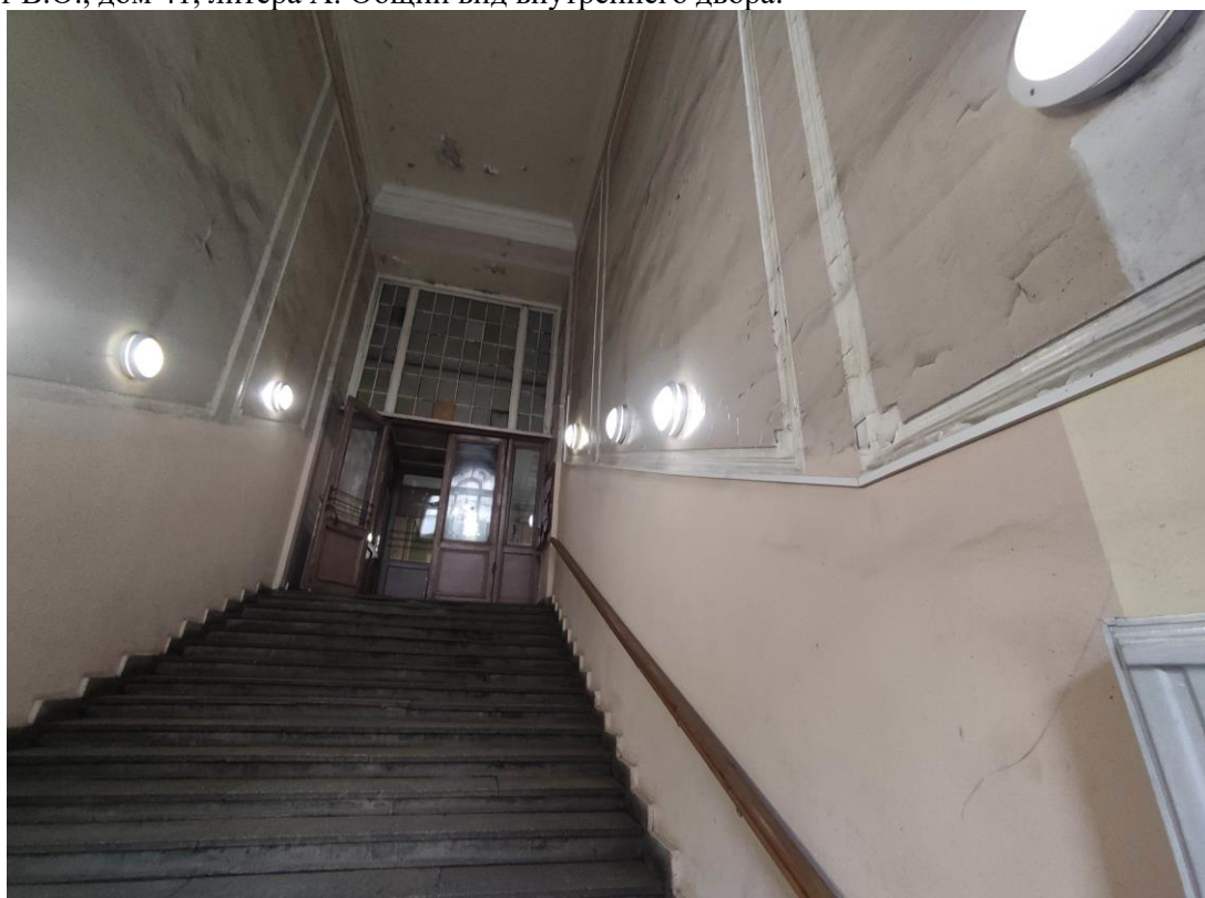
12. Объект культурного наследия регионального значения «Здание Физико-химического института Высших женских (Бестужевских) курсов», расположенный по адресу: г. Санкт-Петербург, Средний проспект В.О., дом 41, литера А. Общий вид пом. № 1-Н(96) главного корпуса, средистенная лестница от парадного входа к вестибюлю.
