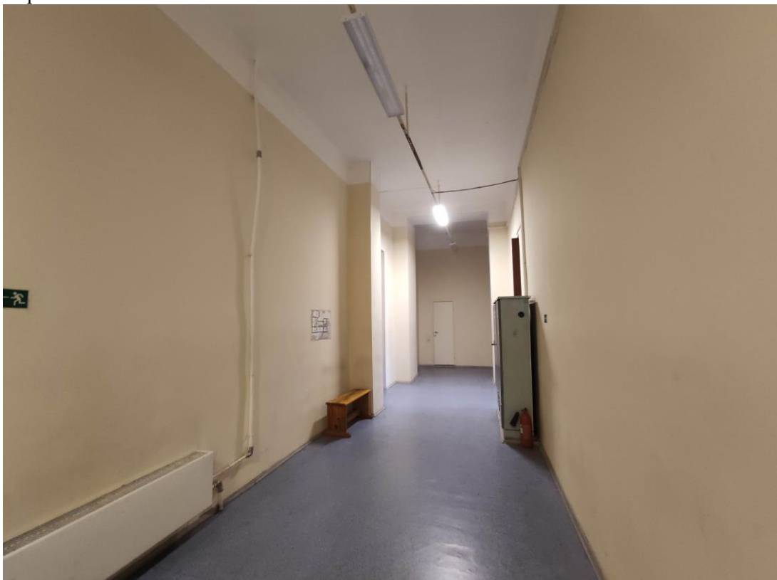
88. Объект культурного наследия регионального значения «Здание Физико-химического института Высших женских (Бестужевских) курсов», расположенный по адресу: г. Санкт-Петербург, Средний проспект В.О., дом 41, литера А. Общий вид пом. № 1-Н(359) флигеля, расположенного вдоль Среднего проспекта В.О.
