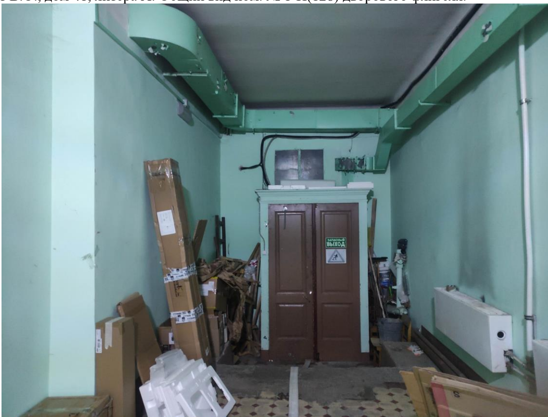
128. Объект культурного наследия регионального значения «Здание Физико-химического института Высших женских (Бестужевских) курсов», расположенный по адресу: г. Санкт-Петербург, Средний проспект В.О., дом 41, литера А. Общий вид пом. № 1-Н(129) дворового флигеля.
