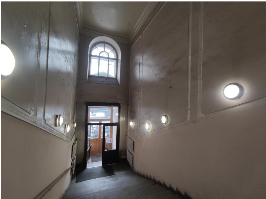
13. Объект культурного наследия регионального значения «Здание Физико-химического института Высших женских (Бестужевских) курсов», расположенный по адресу: г. Санкт-Петербург, Средний проспект В.О., дом 41, литера А. Общий вид пом. № 1-Н(96) главного корпуса, средистенная лестница от парадного входа к вестибюлю
