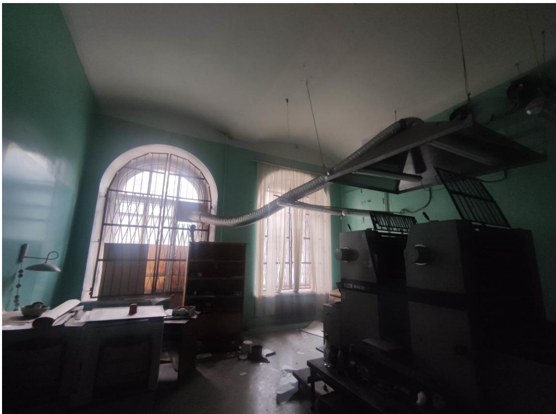
110. Объект культурного наследия регионального значения «Здание Физико-химического института Высших женских (Бестужевских) курсов», расположенный по адресу: г. Санкт-Петербург, Средний проспект В.О., дом 41, литера А. Общий вид пом. № 1-Н(86) флигеля, расположенного вдоль Среднего проспекта В.О.
