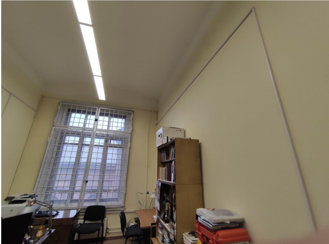
71. Объект культурного наследия регионального значения «Здание Физико-химического института Высших женских (Бестужевских) курсов», расположенный по адресу: г. Санкт-Петербург, Средний проспект В.О., дом 41, литера А. Общий вид пом. № 1-Н(328) главного корпуса.
