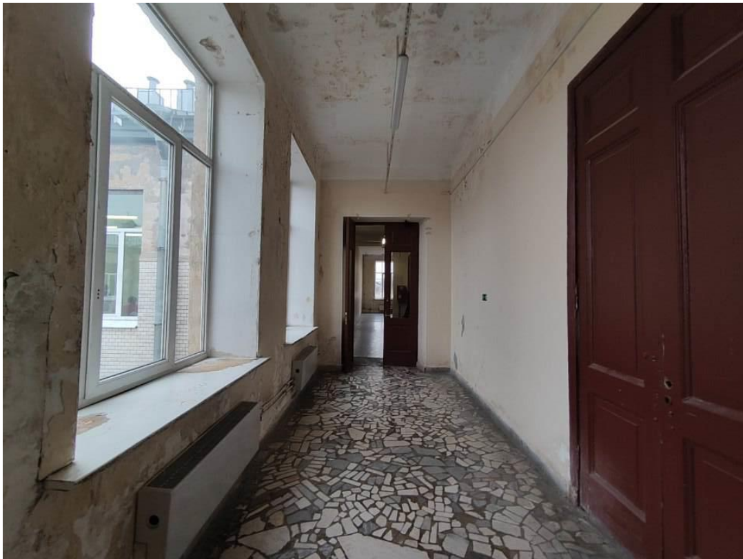
83. Объект культурного наследия регионального значения «Здание Физико-химического института Высших женских (Бестужевских) курсов», расположенный по адресу: г. Санкт-Петербург, Средний проспект В.О., дом 41, литера А. Общий вид пом. № 1-Н(364) главного корпуса.
