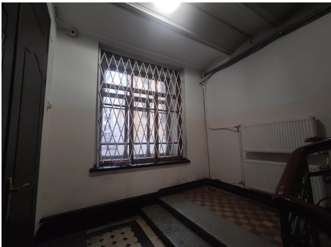
83. Часть объекта культурного наследия «Здания, в которых 1885-1918 гг. находились Высшие женские (Бестужевские) курсы. Здесь преподавали Бестужев-Рюмин К.Н., Менделеев Д.И., Бутлеров А.М., Сеченов И.М. и другие деятели науки» по адресу: Санкт-Петербург, 10-я линия В.О., дом 31-33, литера А. Общий вид пом. № 1-Н(120).
