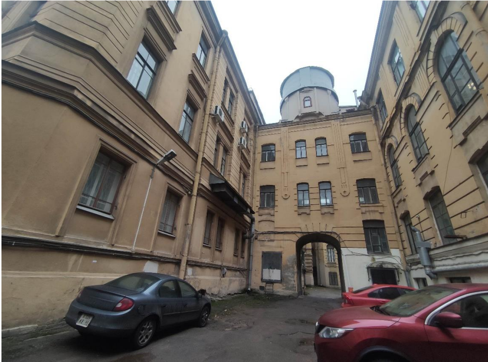
17. Часть объекта культурного наследия «Здания, в которых 1885-1918 гг. находились Высшие женские (Бестужевские) курсы. Здесь преподавали Бестужев-Рюмин К.Н., Менделеев Д.И., Бутлеров А.М., Сеченов И.М. и другие деятели науки» по адресу: Санкт-Петербург, 10-я линия В.О., дом 31-33, литера А. Общий вид дворовых фасадов.
