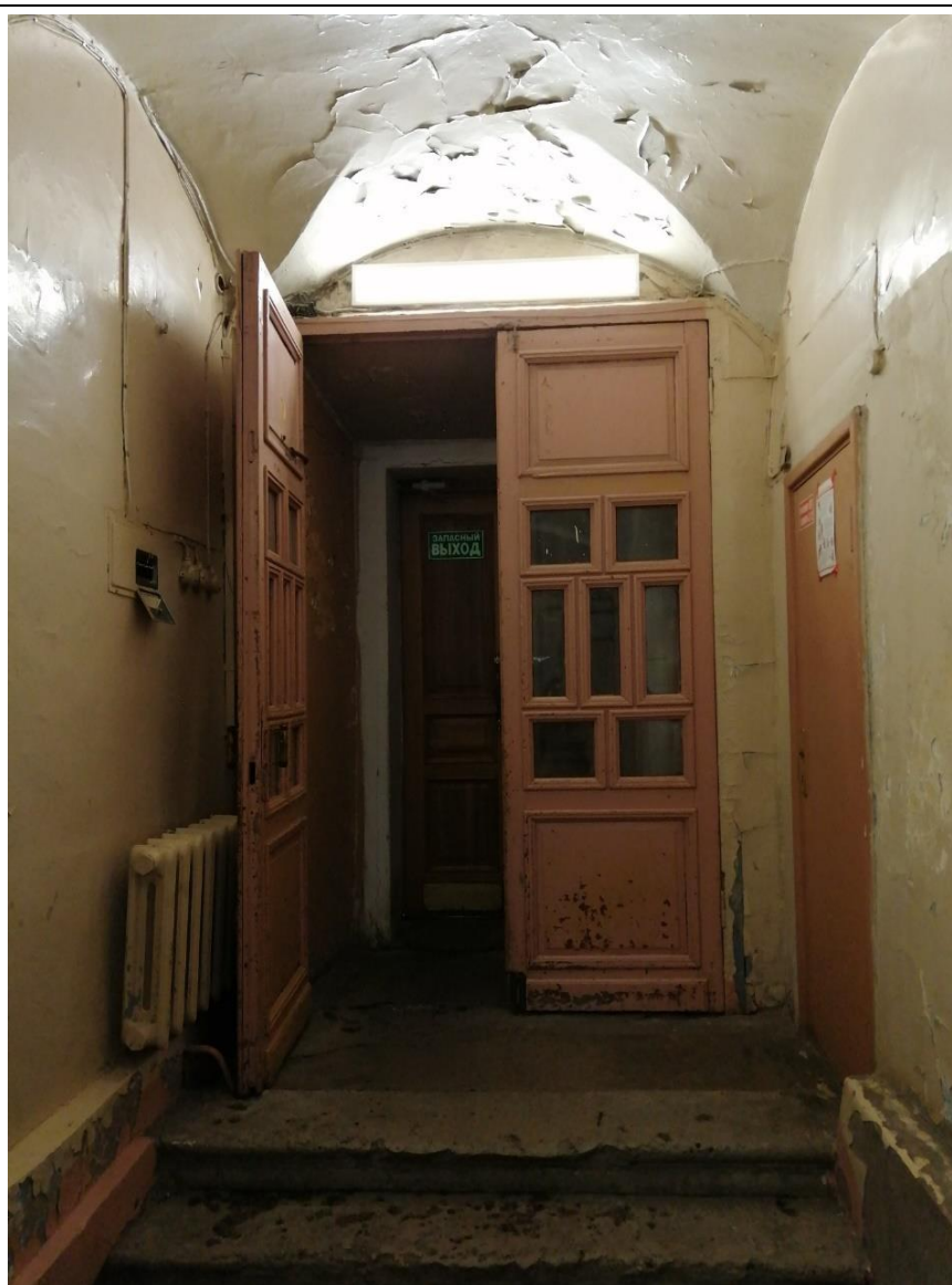
6. Объект культурного наследия федерального значения «Корпус для игры в мяч ("жедепом")», расположенный по адресу: г. Санкт-Петербург, Университетская набережная, дом 7-9-11, литера О. Общий вид пом. № 1-Н(1) в отметке подвального этажа, дверной проем парадного входа.
