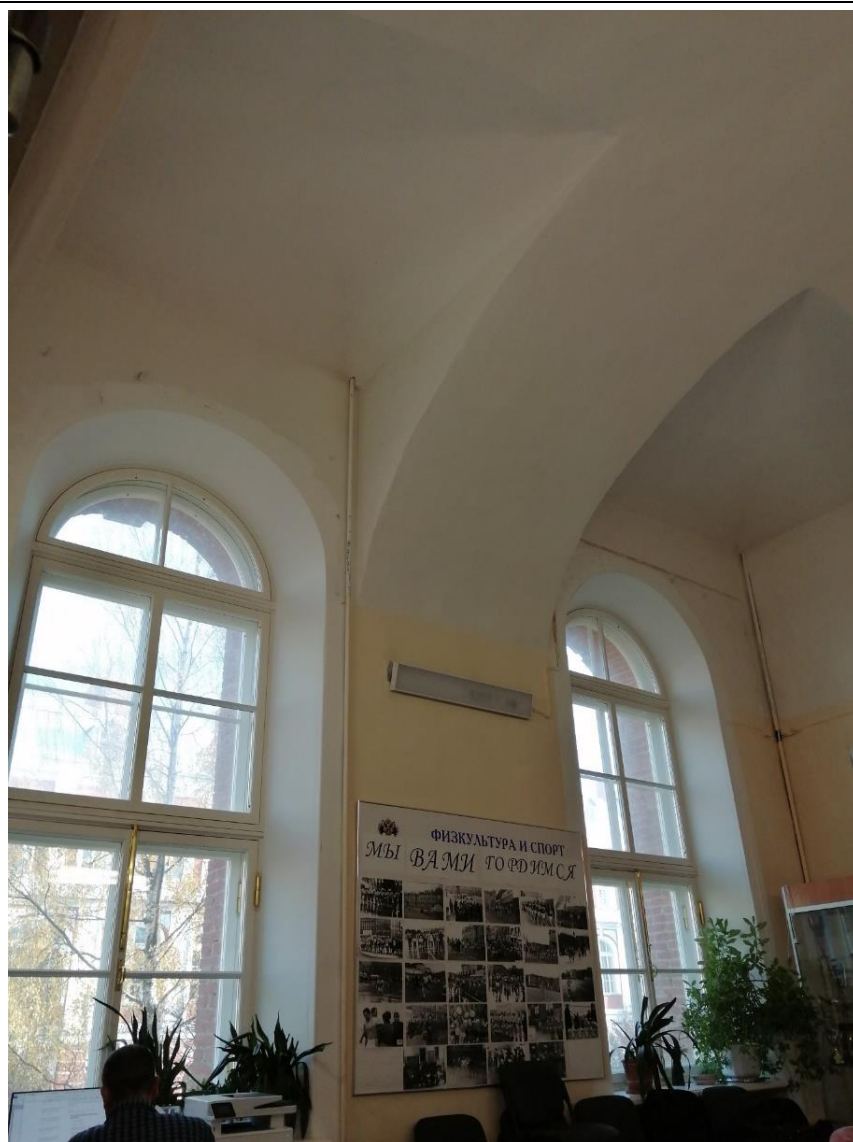
25. Объект культурного наследия федерального значения «Корпус для игры в мяч ("жедепом")», расположенный по адресу: г. Санкт-Петербург, Университетская набережная, дом 7-9-11, литера О. Фрагмент пом. № 1-Н(47) в отметке 1-го этажа.
