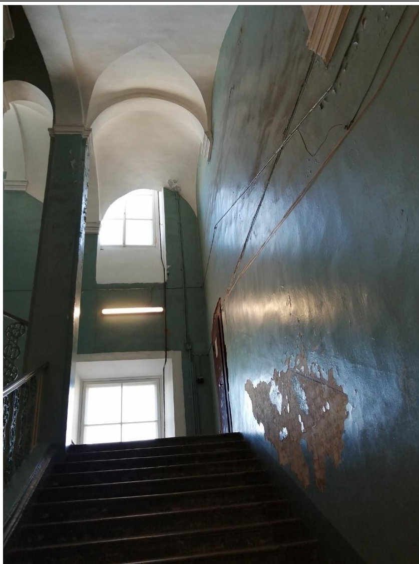
14. Объект культурного наследия федерального значения «Корпус для игры в мяч ("жедепом")», расположенный по адресу: г. Санкт-Петербург, Университетская набережная, дом 7-9-11, литера О. Фрагмент парадной лестницы Л1, пом. № 1-Н(65).
