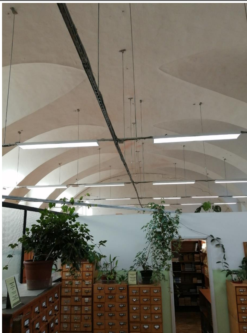
27. Объект культурного наследия федерального значения «Корпус для игры в мяч ("жедепом")», расположенный по адресу: г. Санкт-Петербург, Университетская набережная, дом 7-9-11, литера О. Фрагмент пом. № 1-Н(51) в отметке 1-го этажа.
