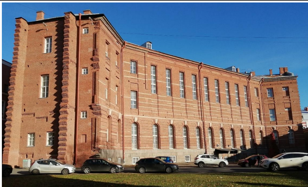
4. Объект культурного наследия федерального значения «Корпус для игры в мяч ("жедепом")», расположенный по адресу: г. Санкт-Петербург, Университетская набережная, дом 7-9-11, литера О. Общий вид торцевого юго-западного и юго-восточного фасадов западного бокового крыла, южного дворового фасада центрального корпуса, юго-западного фасада восточного бокового крыла.
