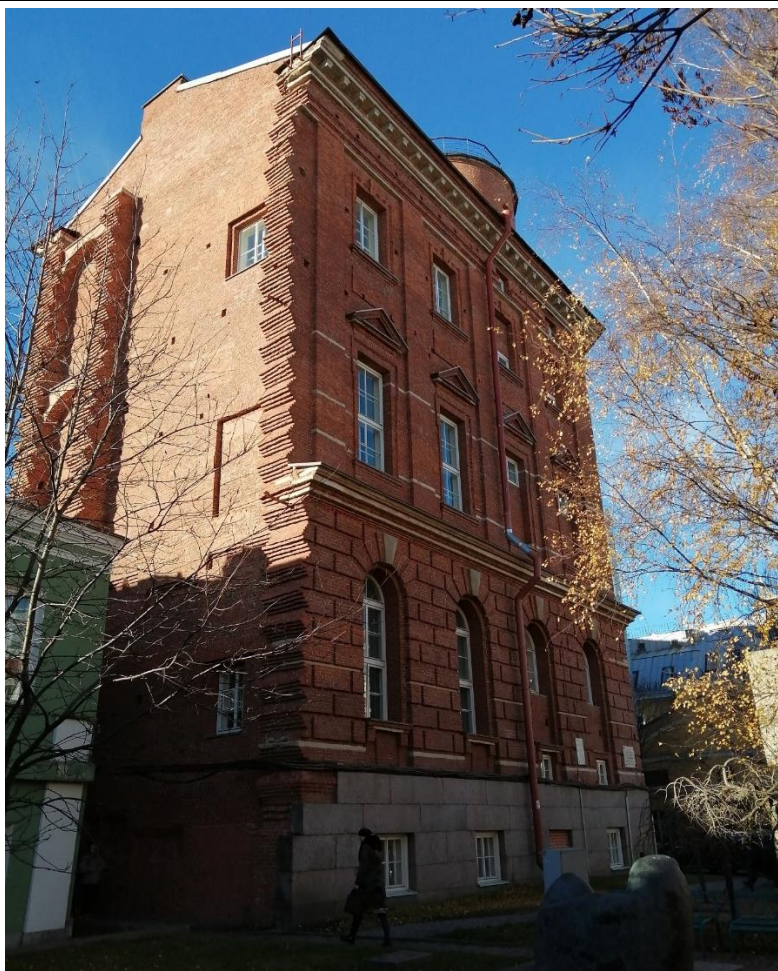
3. Объект культурного наследия федерального значения «Корпус для игры в мяч ("жедепом")», расположенный по адресу: г. Санкт-Петербург, Университетская набережная, дом 7-9-11, литера О. Общий вид торцевого юго-восточного и северо-восточного фасадов восточного бокового крыла.
