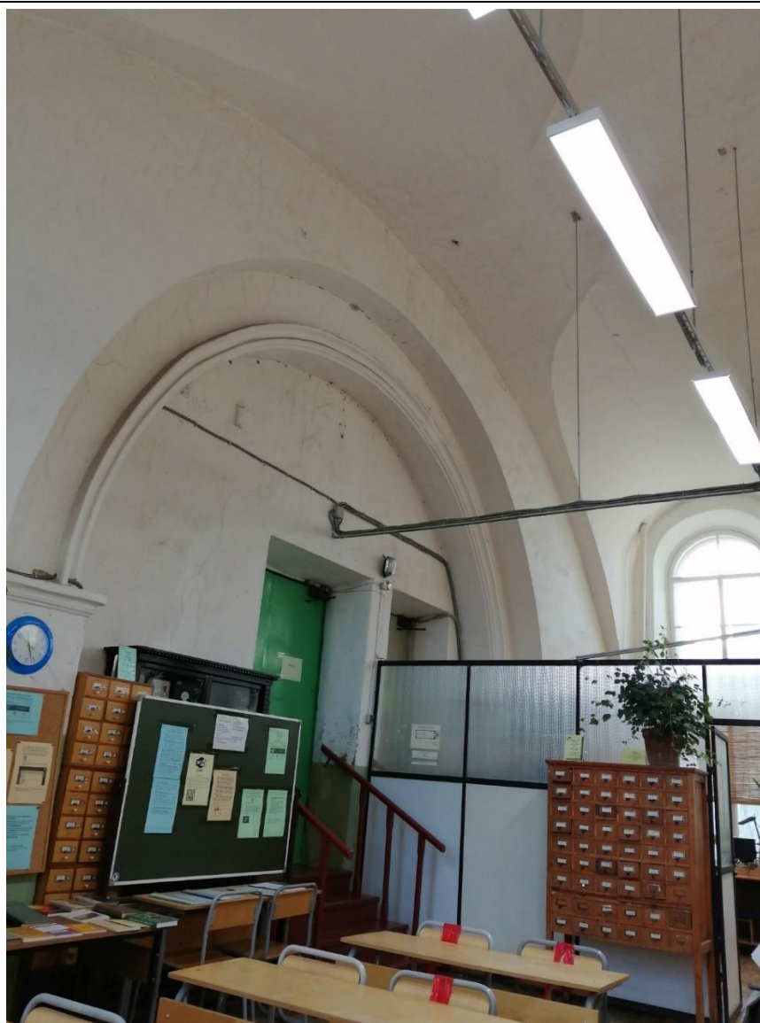
29. Объект культурного наследия федерального значения «Корпус для игры в мяч ("жедепом")», расположенный по адресу: г. Санкт-Петербург, Университетская набережная, дом 7-9-11, литера О. Фрагмент пом. № 1-Н(51) в отметке 1-го этажа.
