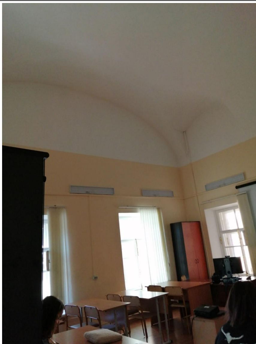
44. Объект культурного наследия федерального значения «Корпус для игры в мяч ("жедепом")», расположенный по адресу: г. Санкт-Петербург, Университетская набережная, дом 7-9-11, литера О. Общий вид пом. № 1-Н(60) в отметке 1-го этажа.
