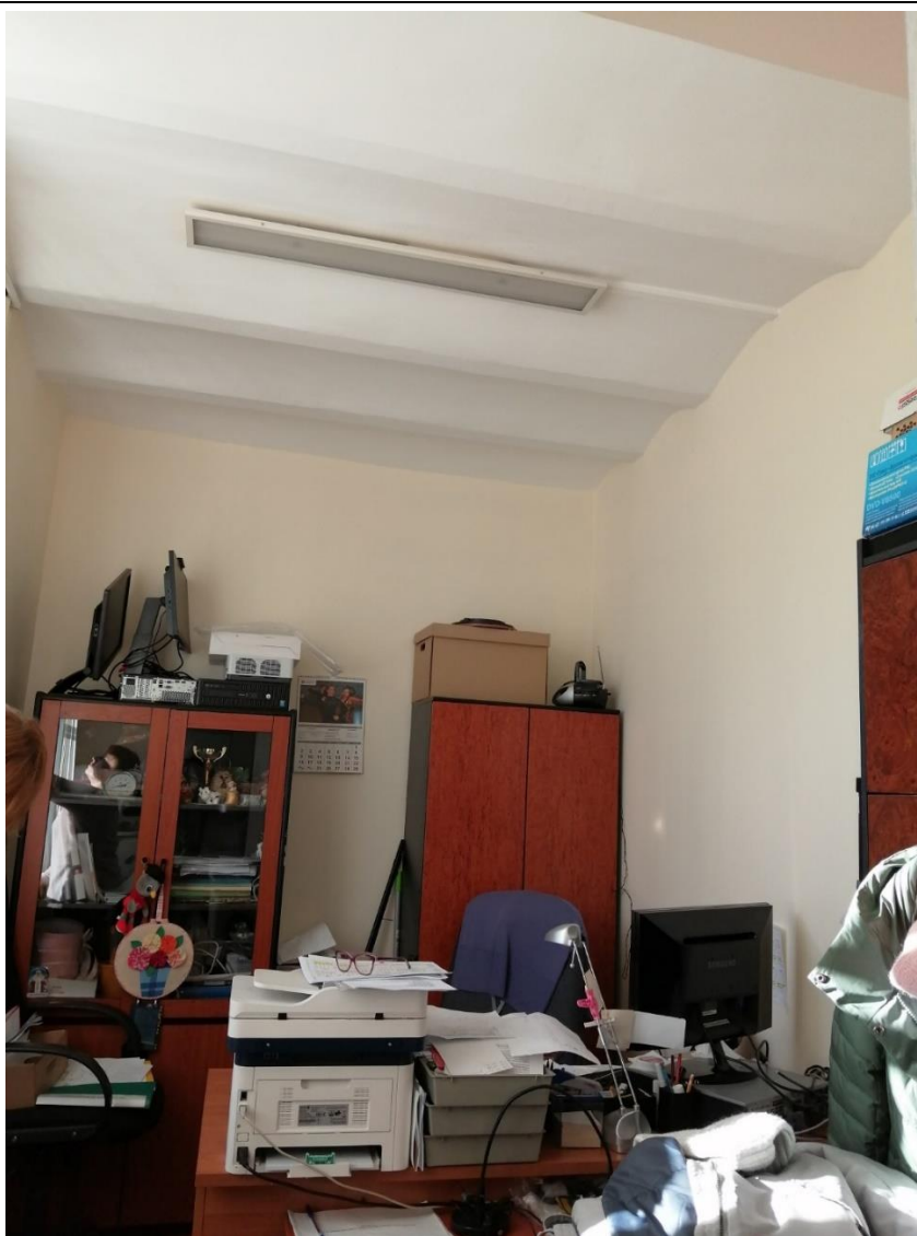
43. Объект культурного наследия федерального значения «Корпус для игры в мяч ("жедепом")», расположенный по адресу: г. Санкт-Петербург, Университетская набережная, дом 7-9-11, литера О. Общий вид пом. № 1-Н(61) в отметке 1-го этажа.
