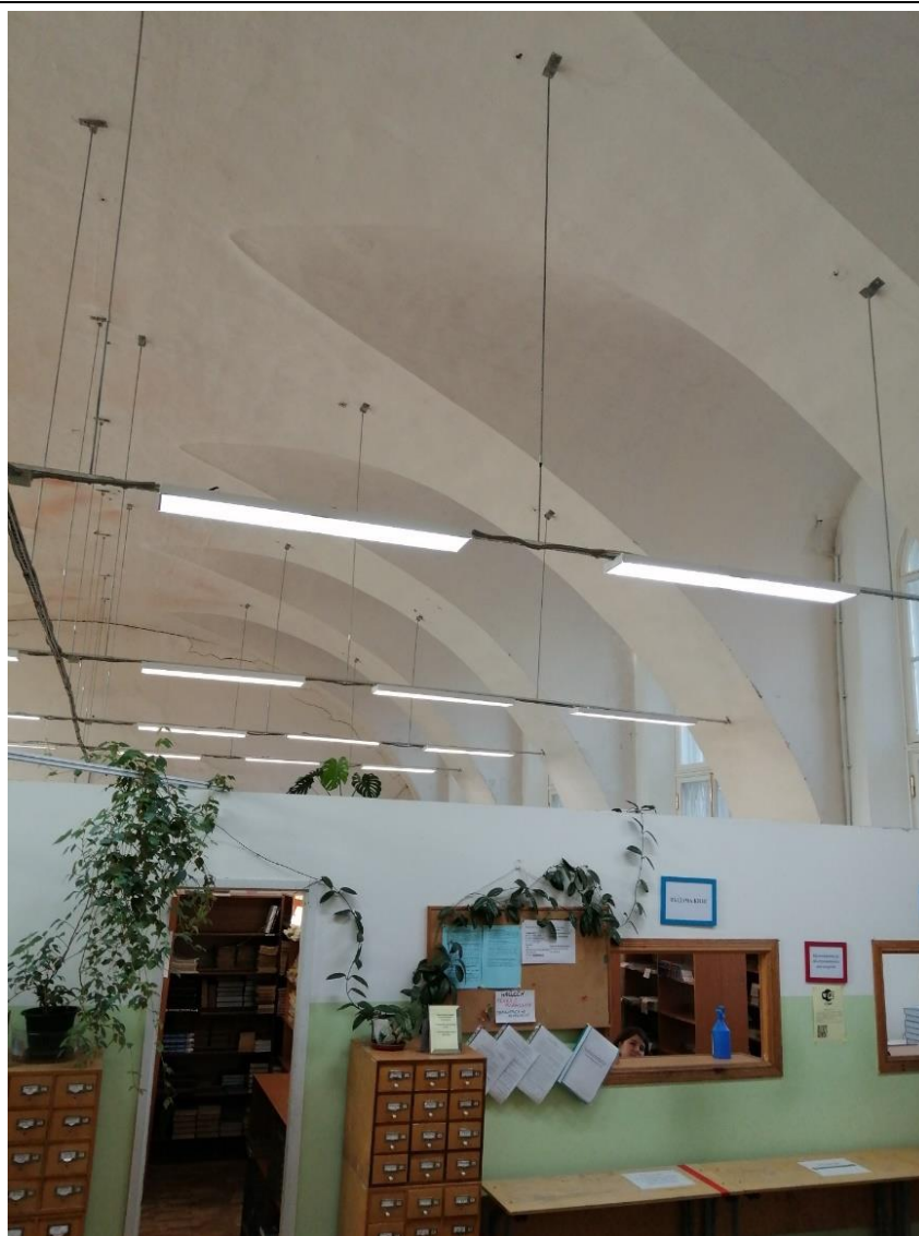
26. Объект культурного наследия федерального значения «Корпус для игры в мяч ("жедепом")», расположенный по адресу: г. Санкт-Петербург, Университетская набережная, дом 7-9-11, литера О. Фрагмент пом. № 1-Н(51) в отметке 1-го этажа.
