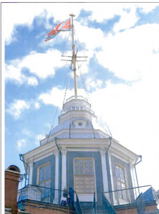
1. Общий вид со стороны северного фасада
