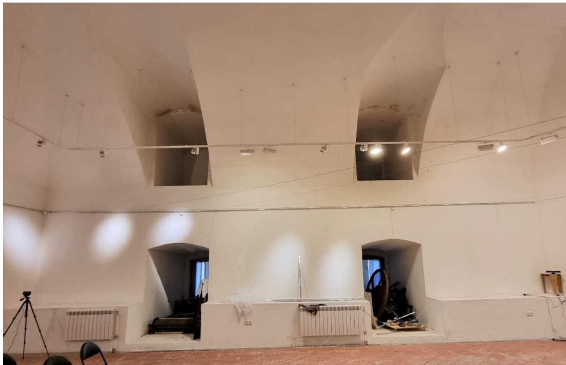
40. Объект культурного наследия федерального значения «Бастион Нарышкин» в составе объекта культурного наследия федерального значения «Петропавловская крепость» по адресу: г. Санкт-Петербург, Петропавловская крепость, дом 3, литера Д (о. Заячий, Петропавловская крепость). Каземат №9. Фрагмент интерьера.
