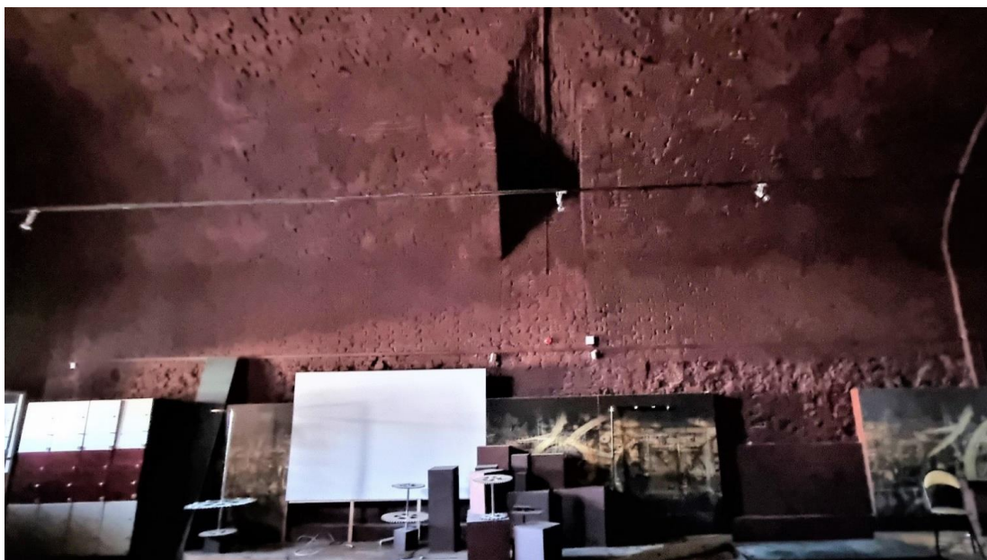
12. Объект культурного наследия федерального значения «Бастион Нарышкин» в составе объекта культурного наследия федерального значения «Петропавловская крепость» по адресу: г. Санкт-Петербург, Петропавловская крепость, дом 3, литера Д (о. Заячий, Петропавловская крепость). Каземат №1. Фрагмент интерьера.
