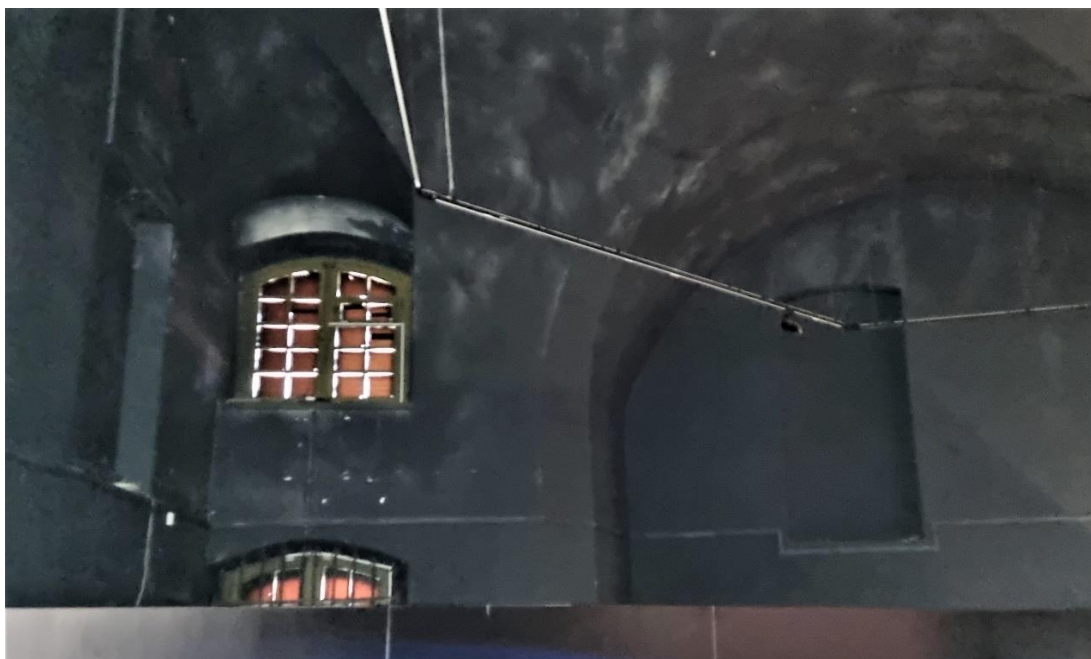
20. Объект культурного наследия федерального значения «Бастион Нарышкин» в составе объекта культурного наследия федерального значения «Петропавловская крепость» по адресу: г. Санкт-Петербург, Петропавловская крепость, дом 3, литера Д (о. Заячий, Петропавловская крепость). Каземат №3. Фрагмент интерьера.
