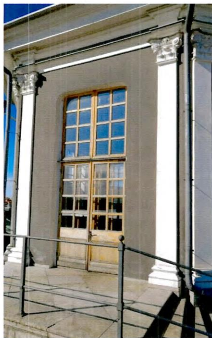
2. Фрагмент южного фасада
