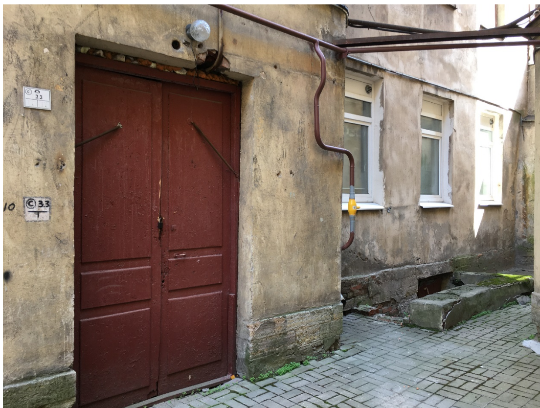
Фото №4. Юго-западный фасад дворового корпуса (лит. Б), вход в общедомовую лестничную клетку.
