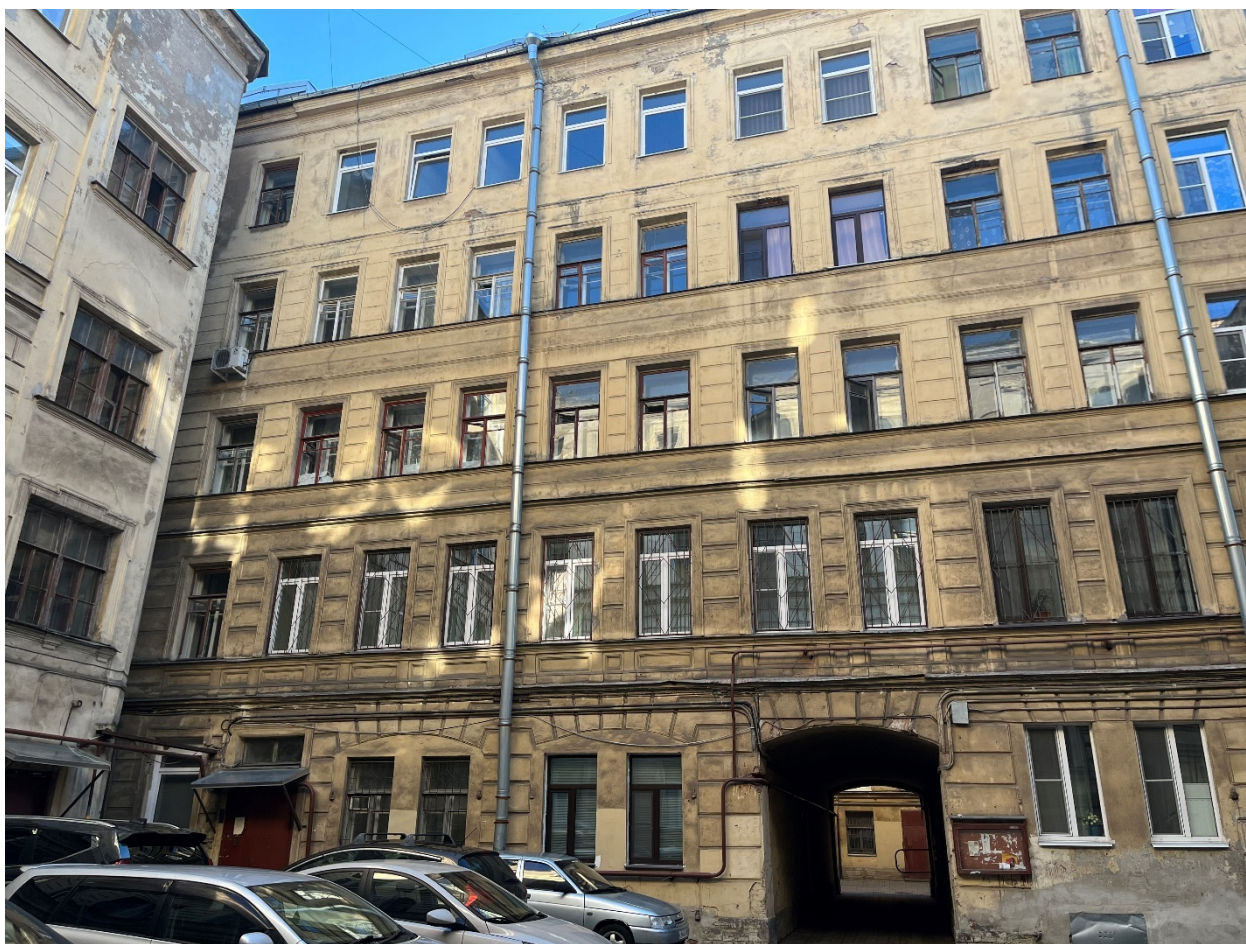
Фото №1. Северо-восточный фасад дворового корпуса (лит. Б).
