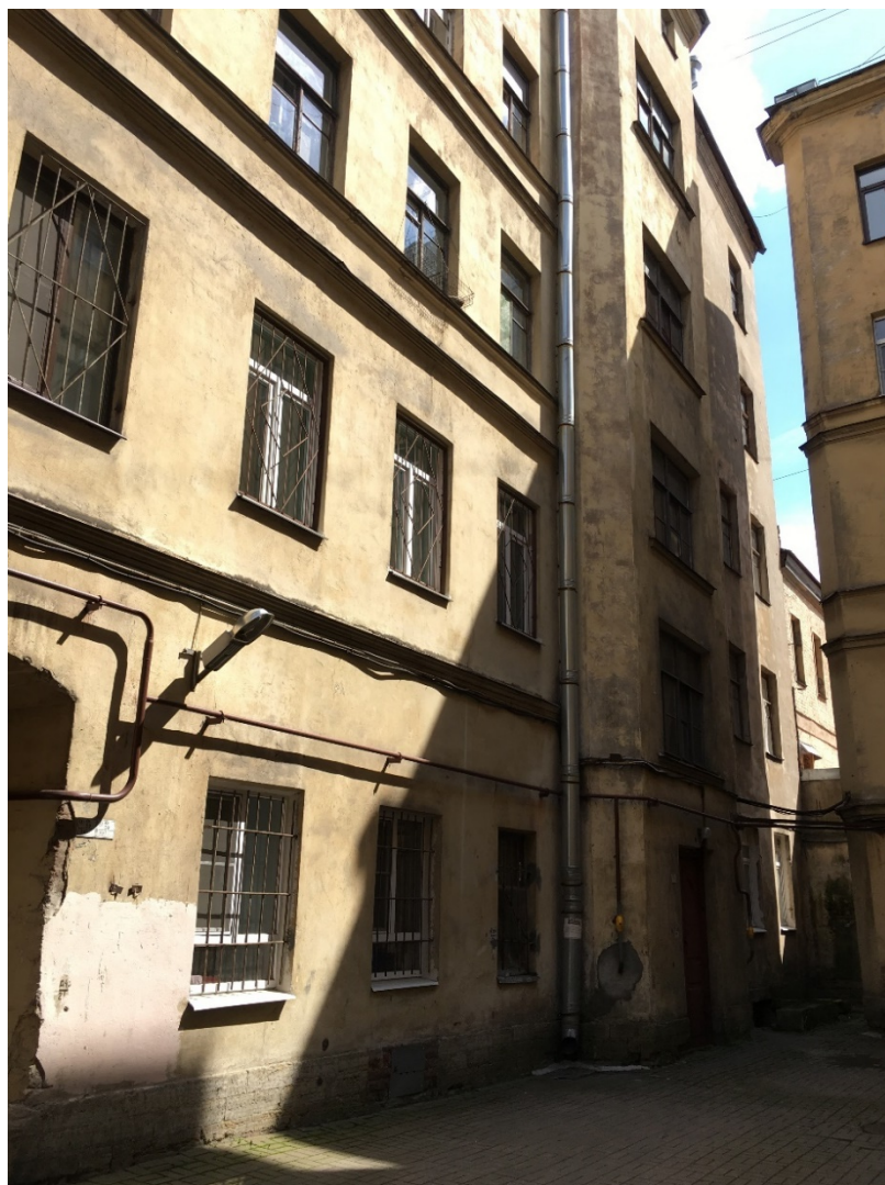
Фото №3. Северо-восточный фасад дворового корпуса (лит. Б), вход в общедомовую лестничную клетку.
