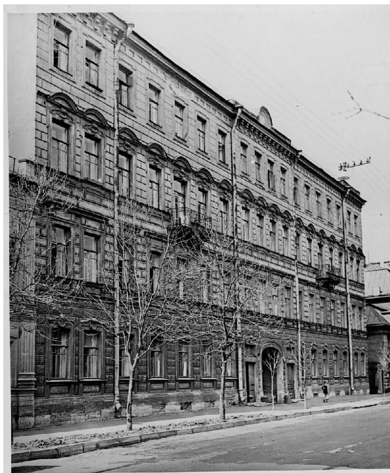
Илл. 25. Вид фасада дома №30 на 5-й линии Васильевского острова. 1974 г. Архив КГИОП. №2028. Паспорт на памятник «Дом, в котором жили: И.Е. Репин, М.Е. Салтыков-Щедрин; жил и умер И.И. Шишкин». 1976. С. 6.
