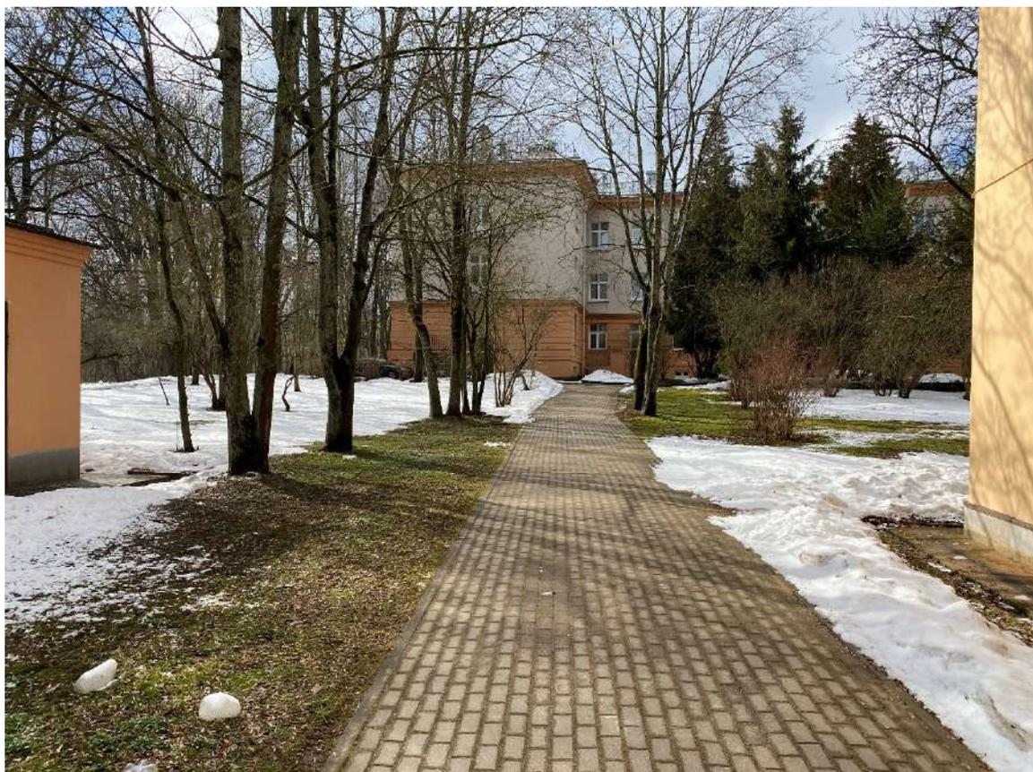
Фото 19. Тротуар с мощением из бетонной плитки между административно-хозяйственным зданием (справа) и зданием гаража (слева).
