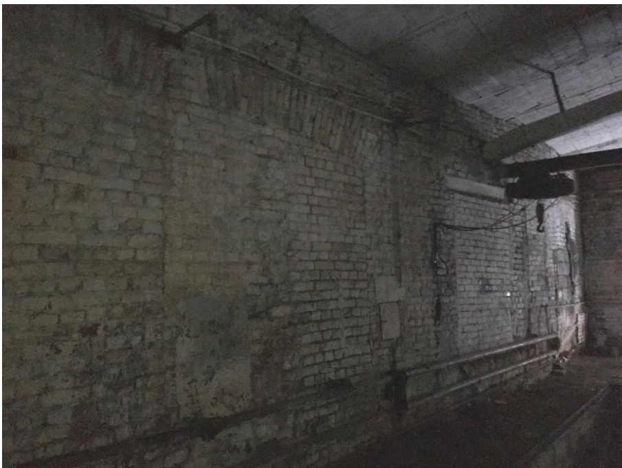
Фото 8. Выявленный объект культурного наследия «Доходные дома М.С. Воронина», расположенный по адресу: Санкт-Петербург, Адмиралтейский район, наб. реки Мойки, д. 82, литера А, Б, Ш. Надворный флигель (литера Ш), помещение 41(Н), поздняя закладка проемов.
