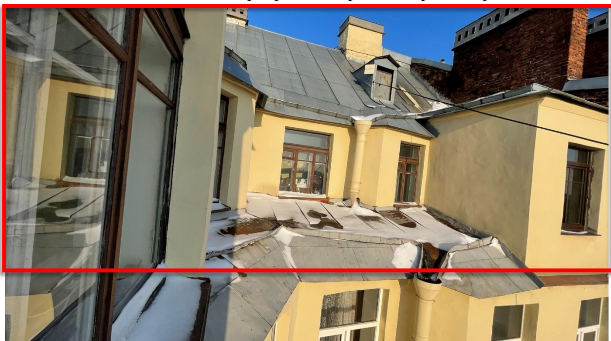
25. Вид на окна квартиры со стороны дворового фасада;
