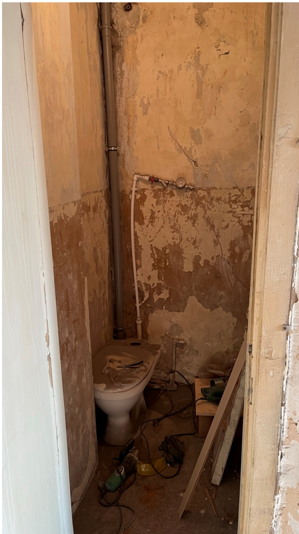
29. Фрагмент интерьера санузла (помещение №4);
