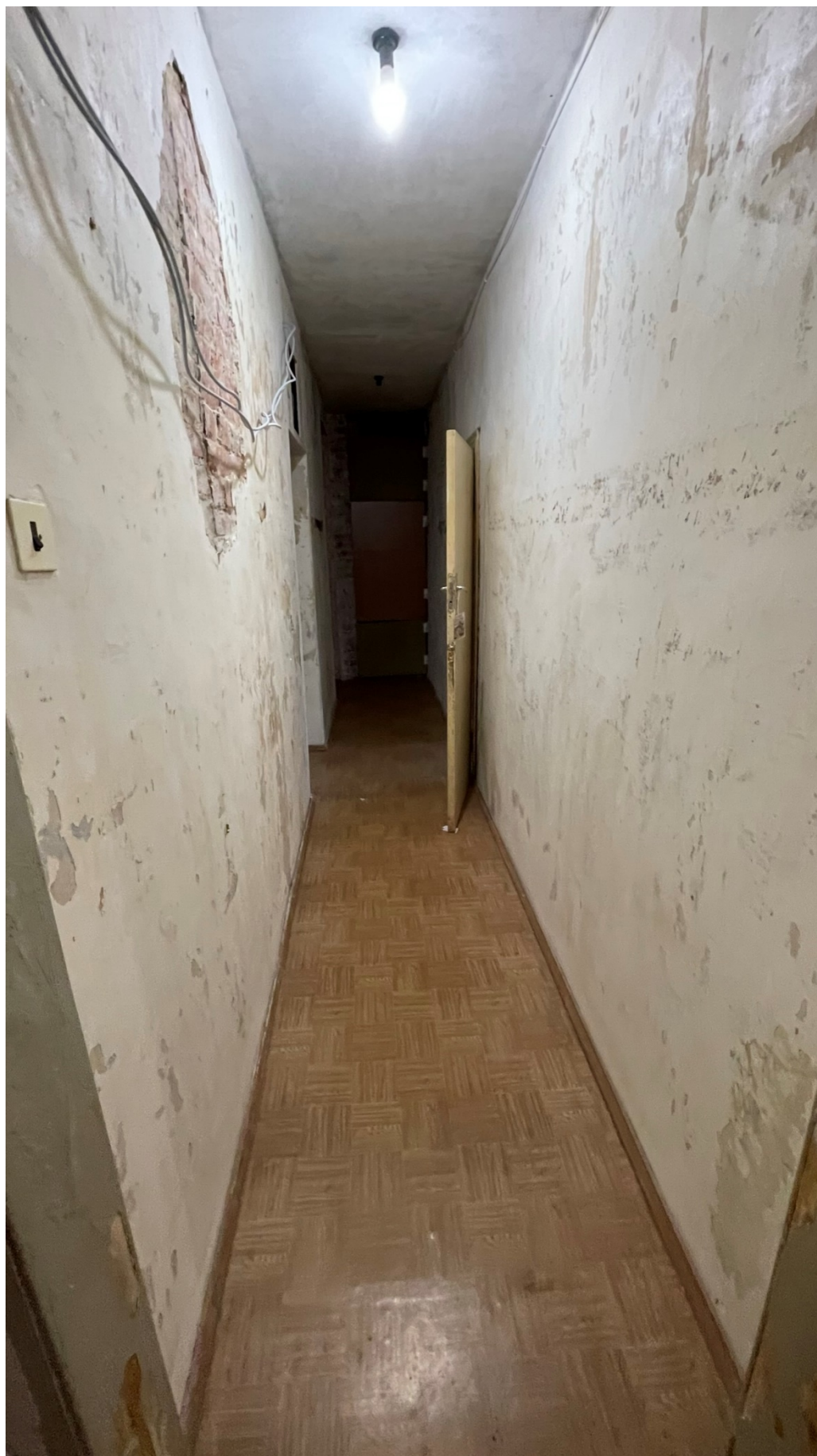
12. Фрагмент интеръера коридора (помещение №9);
