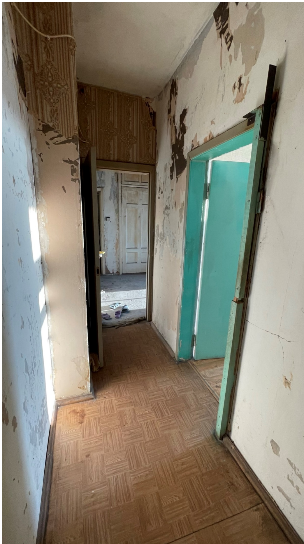
5. Фрагмент интерьера коридора (помещение №2);
