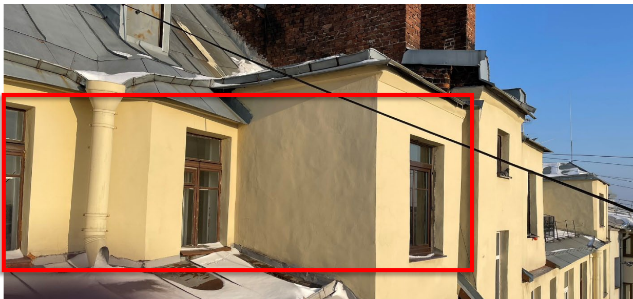
24. Вид на окна квартиры со стороны дворового фасада;
