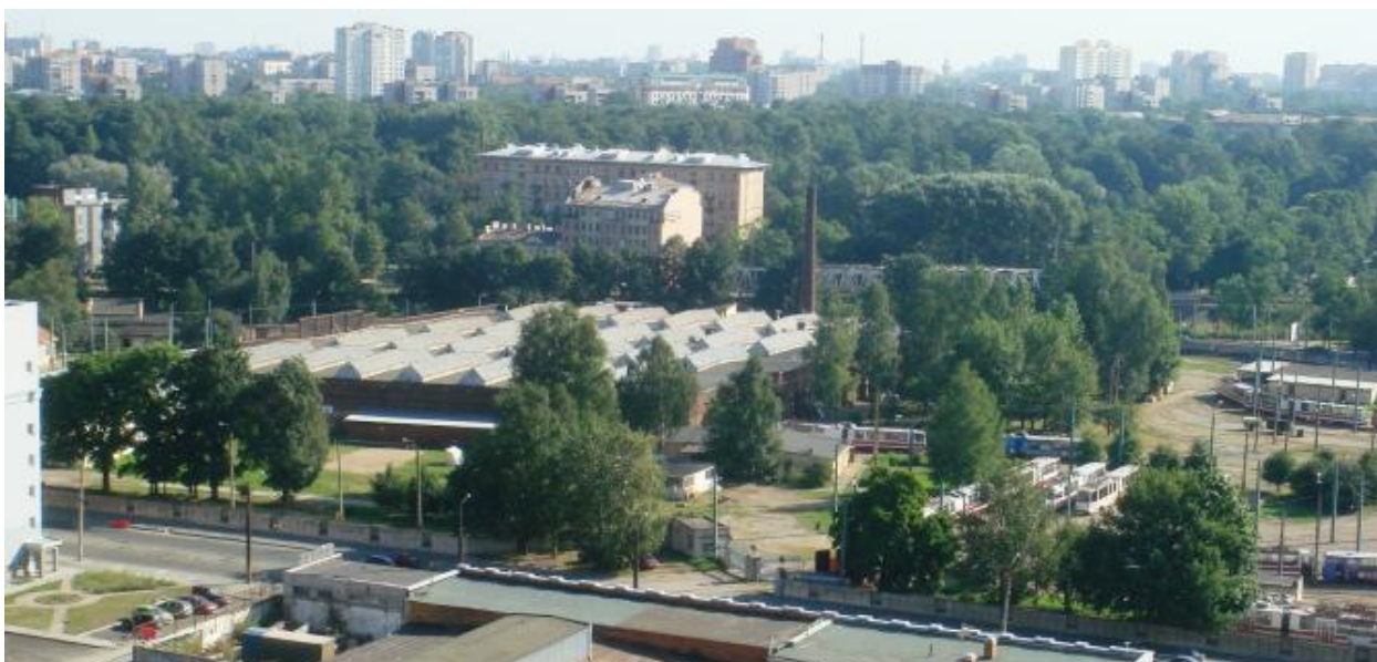
11. Трамвайный парк № 5. 2010 г. — Трамвайный парк № 5 им. М. И. Калинина // Citywalls.ru – архитектурный сайт Петербурга [Электронный ресурс]. URL: https://www.citywalls.ru/house17182.html .
