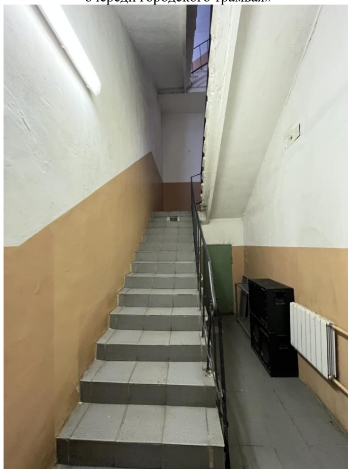
Фото 18. Интерьер второго этажа выявленного объекта культурного наследия «Административное здание», входящего в состав выявленного объекта культурного наследия «Сооружения Второй очереди городского трамвая»
