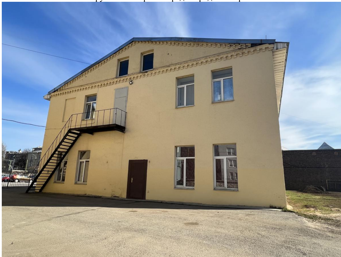
Фото 4. Фрагмент лицевого фасада выявленного объекта культурного наследия «Административное здание», входящего в состав выявленного объекта культурного наследия «Сооружения Второй очереди городского трамвая»
