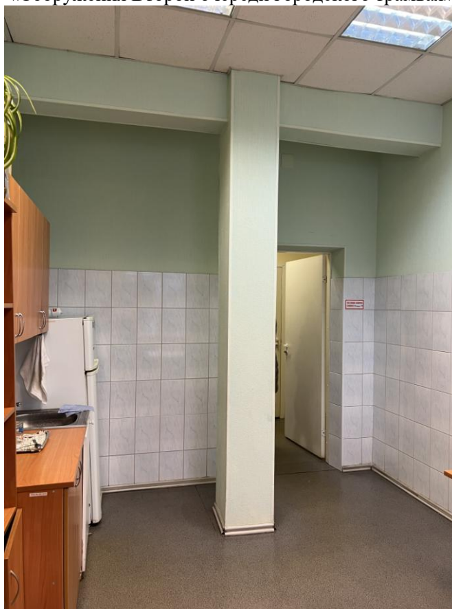
Фото 32. Интерьер второго этажа выявленного объекта культурного наследия «Административное здание», входящего в состав выявленного объекта культурного наследия «Сооружения Второй очереди городского трамвая»
