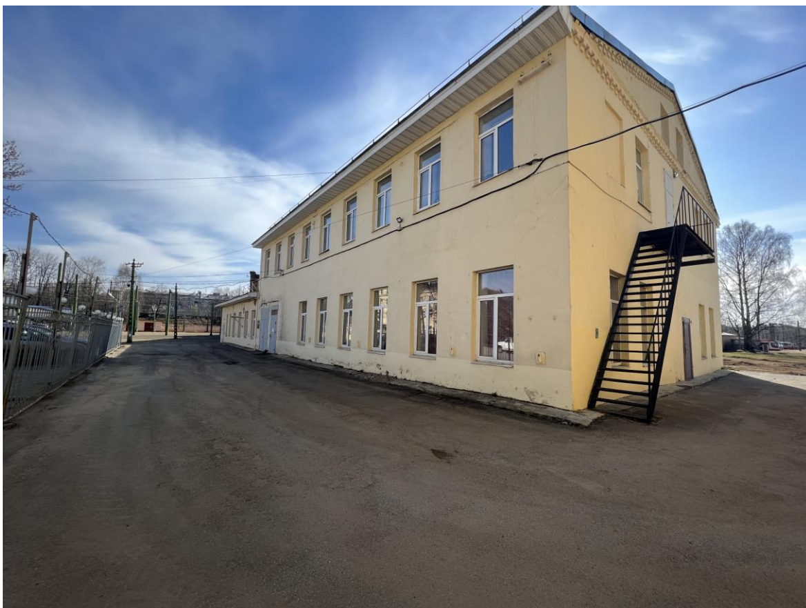
Фото 3. Фрагмент лицевого фасада выявленного объекта культурного наследия «Административное здание», входящего в состав выявленного объекта культурного наследия «Сооружения Второй очереди городского трамвая»
