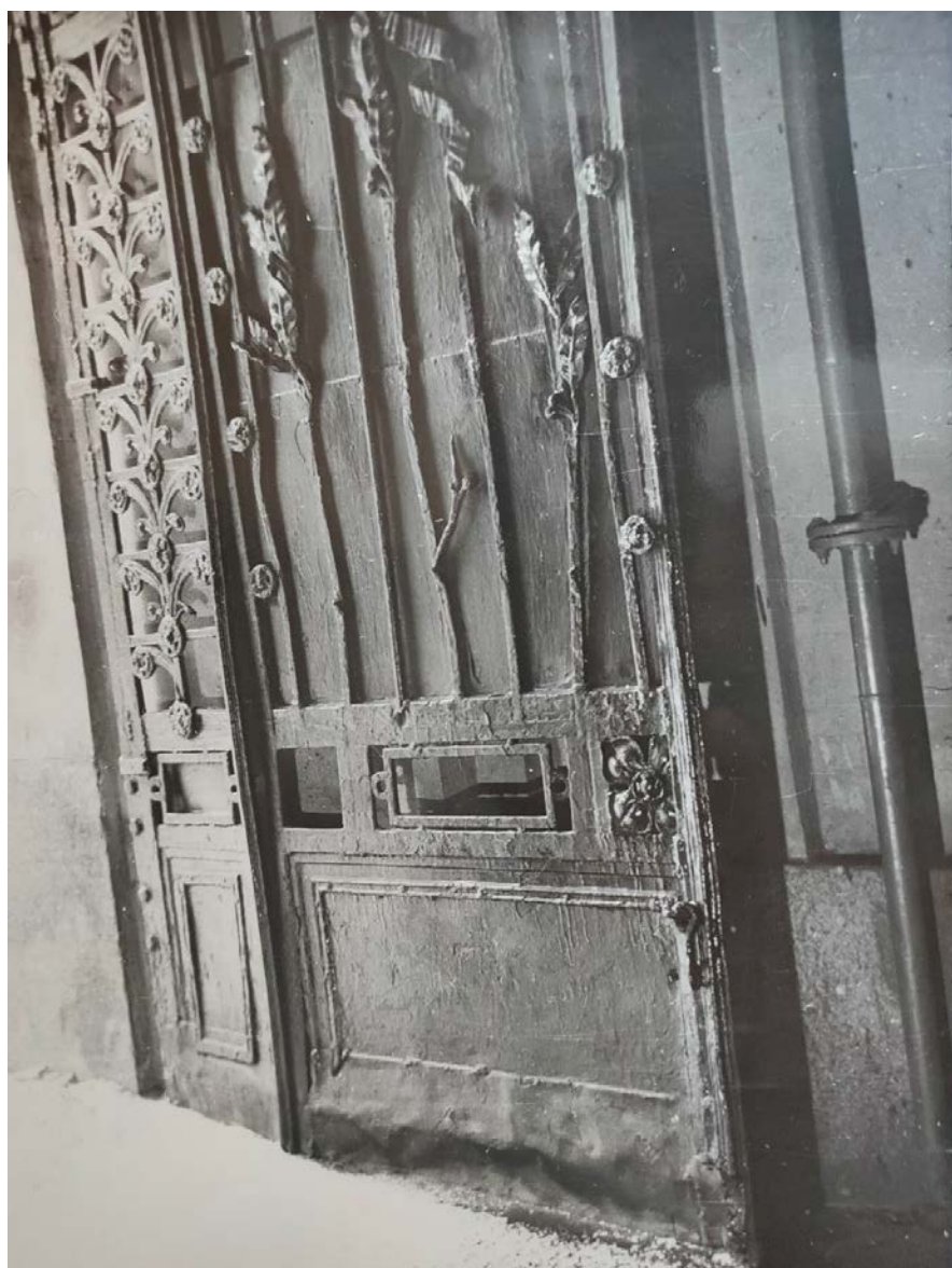
19. Доходный дом Н.В. Спиридонова (Фурштатская ул., дом 60). Воротное заполнение. Нижняя часть ворот. Фотография. 1985 г. Фотофиксация, СНПО «Реставратор». ЦГА НТД СПб. Ф. 488. Оп. 3-11. Д. 77. Л. 4.
