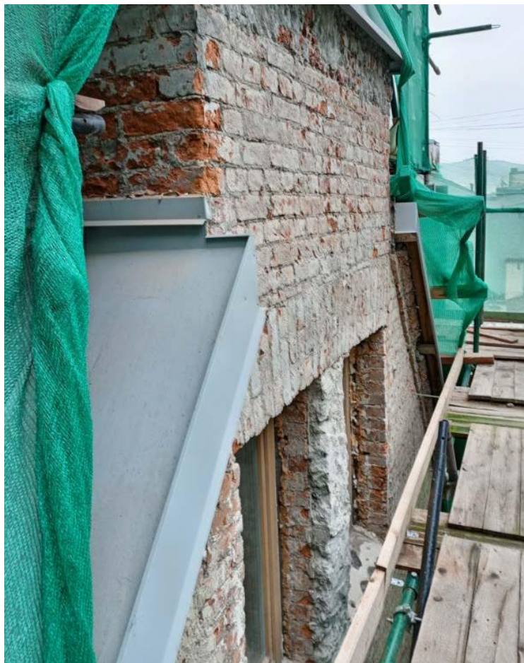
13. Объект культурного наследия регионального значения «Дом Спиридонова Н.В. с флигелем» по адресу: г. Санкт-Петербург, Центральный район, улица Фурштатская, дом 60, литера А (Санкт-Петербург, Фурштатская ул., 60). Дворовый фасад. Фрагмент.
