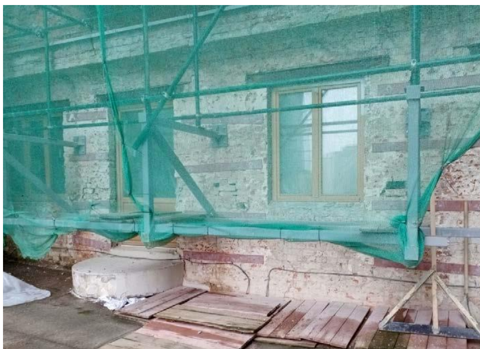
10. Объект культурного наследия регионального значения «Дом Спиридонова Н.В. с флигелем» по адресу: г. Санкт-Петербург, Центральный район, улица Фурштатская, дом 60, литера А (Санкт-Петербург, Фурштатская ул., 60). Дворовый фасад. Фрагмент.
