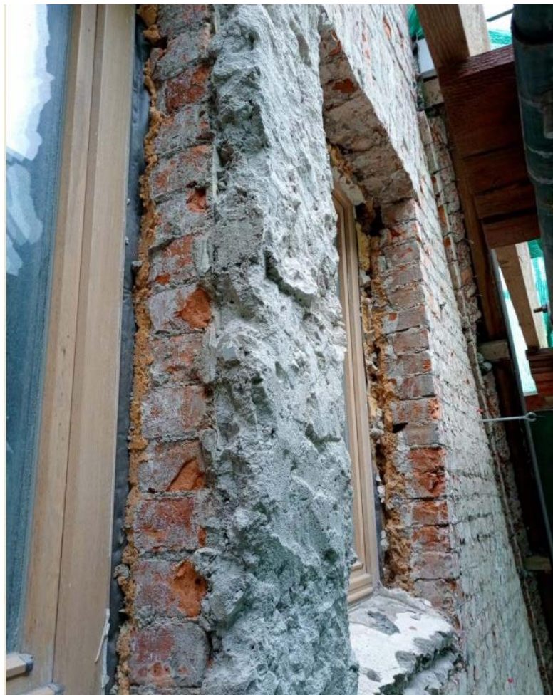
14. Объект культурного наследия регионального значения «Дом Спиридонова Н.В. с флигелем» по адресу: г. Санкт-Петербург, Центральный район, улица Фурштатская, дом 60, литера А (Санкт-Петербург, Фурштатская ул., 60). Дворовый фасад. Фрагмент.
