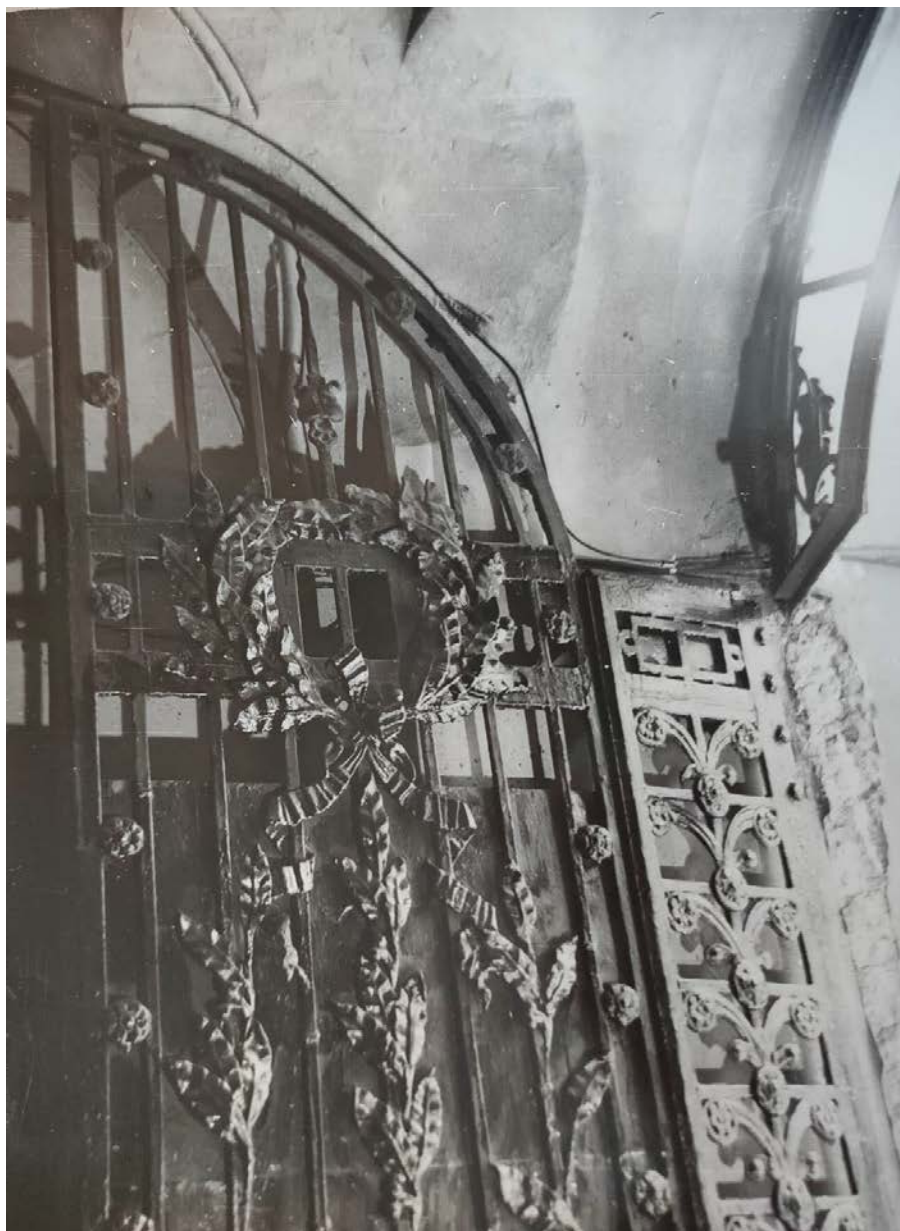
20. Доходный дом Н.В. Спиридонова (Фурштатская ул., дом 60). Воротное заполнение. Верхняя часть ворот (фрагмент). Фотография. 1985 г. Фотофиксация, СНПО «Реставратор». ЦГА НТД СПб. Ф. 488. Оп. 3-11. Д. 77. Л. 2.
