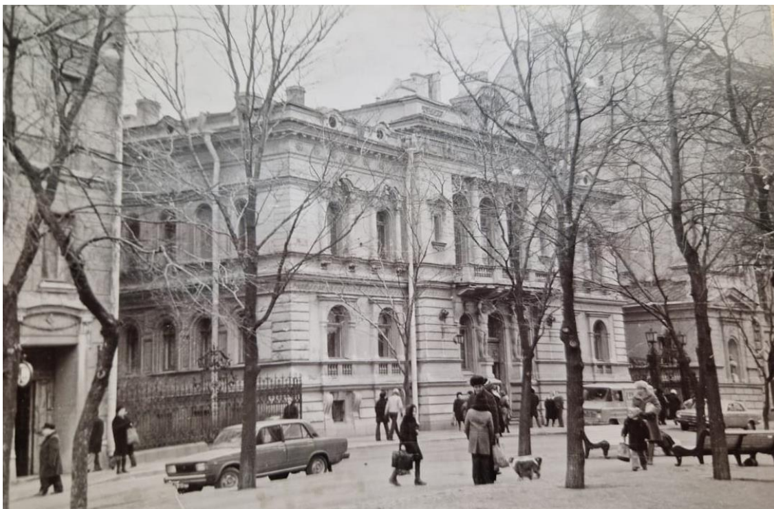
15. Особняк Н.В. Спиридонова по адресу: Фурштатская ул. (в советское время ул. Петра Лаврова), дом 58 (Общий вид) и Доходный дом Н.В. Спиридонова по адресу: Фурштатская ул. (в советское время ул. Петра Лаврова), дом 60 (Западный торцевой фасад). Фотография. 1982 г. ЦГА КФФД СПб.
