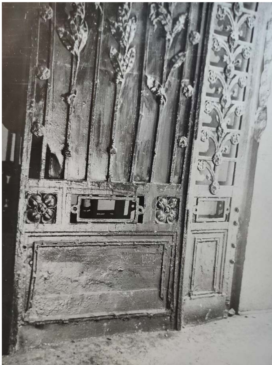
18. Доходный дом Н.В. Спиридонова (Фурштатская ул., дом 60). Воротное заполнение. Нижняя часть ворот. Фотография. 1985 г. Фотофиксация, СНПО «Реставратор». ЦГА НТД СПб. Ф. 488. Оп. 3-11. Д. 77. Л. 6.
