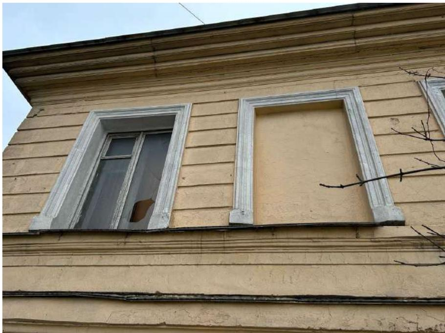
Фото №9. Заложенный оконный проем в уровне 2 этажа южного фасада.
