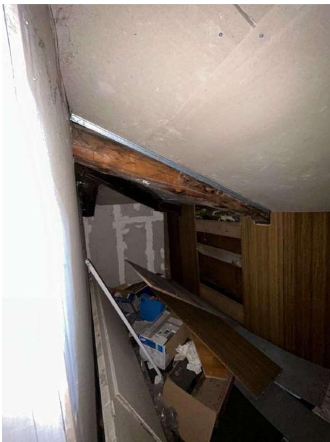
Фото №36. Стропильные конструкции под обшивкой из гипсокартона.
