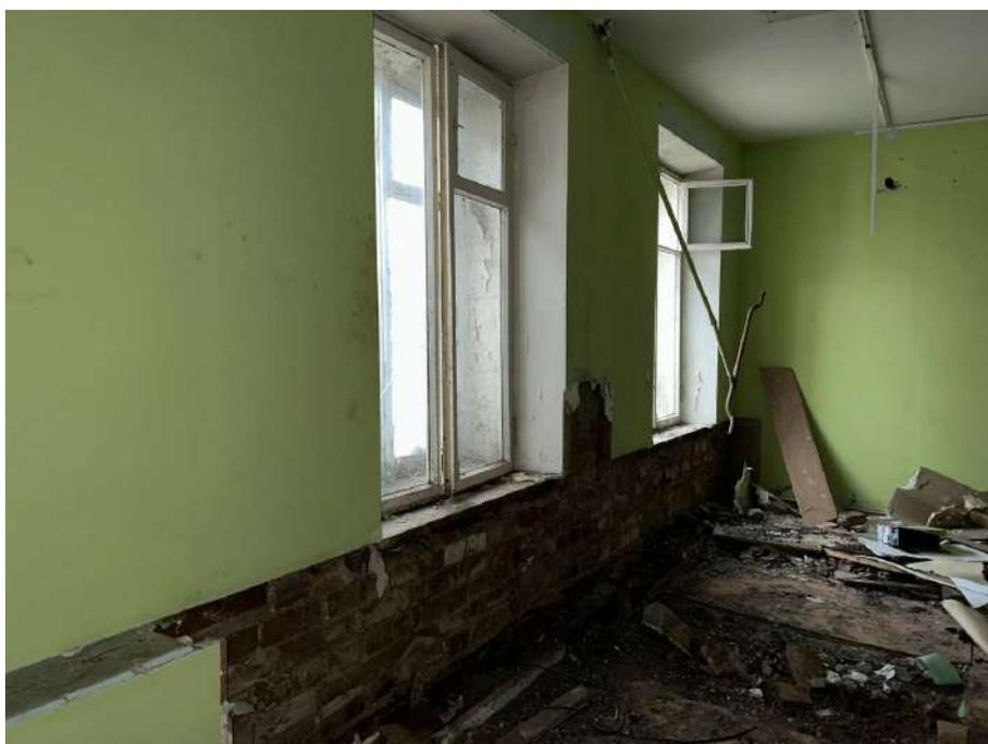
Фото №18. Разрушение отделочного покрытия в помещении 1-го этажа.
