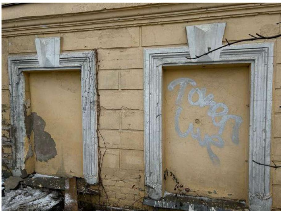
Фото №10. Заложенные оконные проемы в уровне 1 этажа южного фасада.
