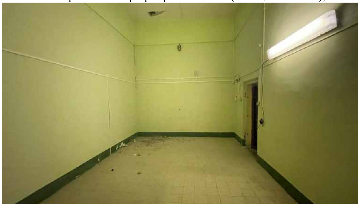
85. Фрагмент интерьера хранилища №2 (помещение №1.20);
