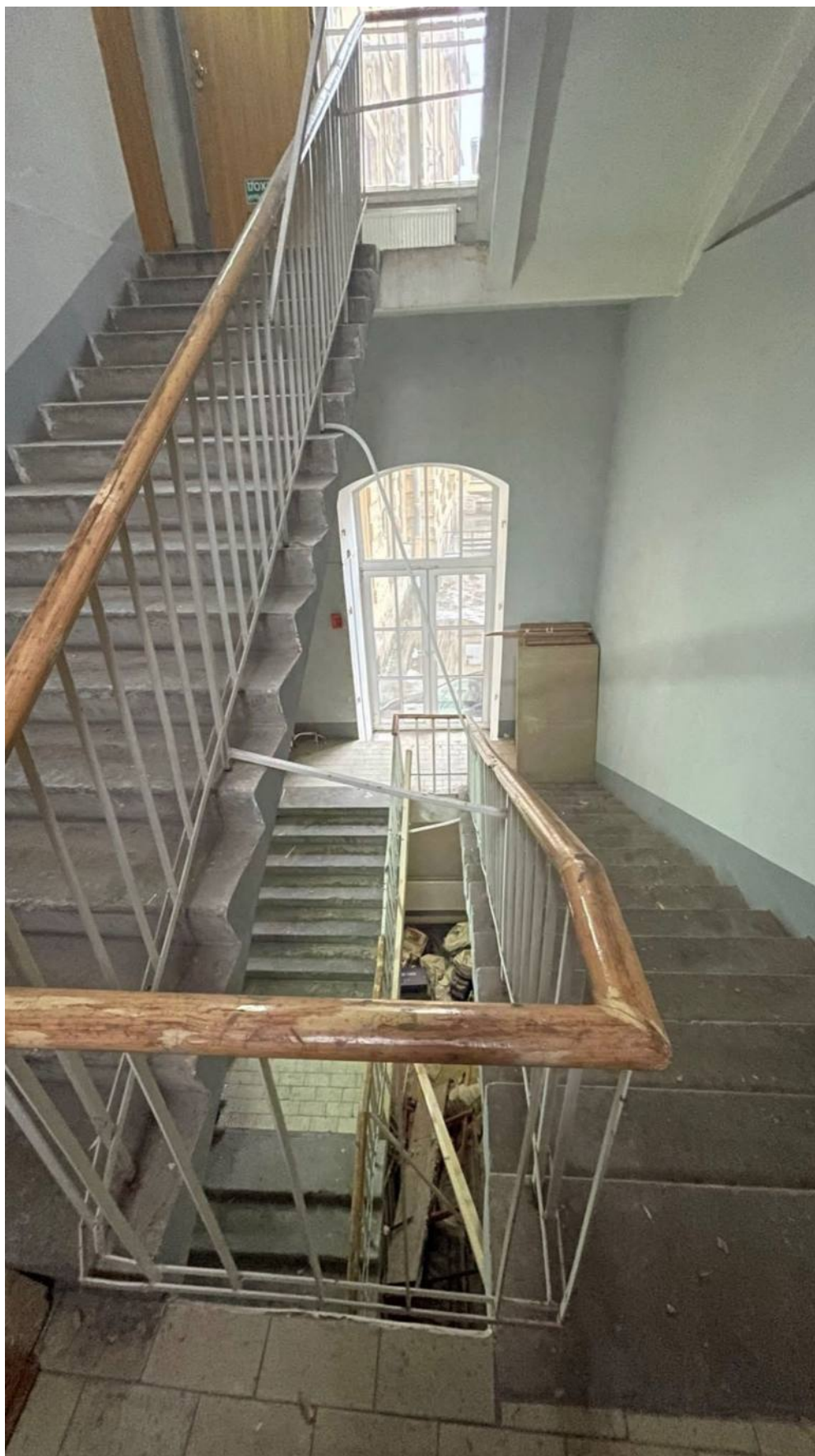
132. Фрагмент эвакуационной лестницы;
