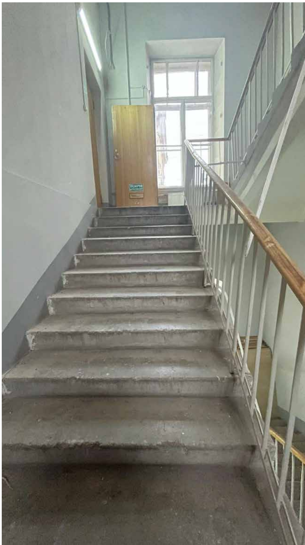
133. Фрагмент эвакуационной лестницы;
