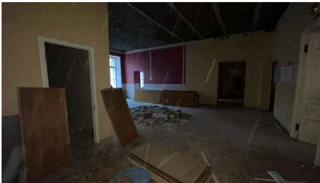
181. Фрагмент интерьера холла на втором этаже;
