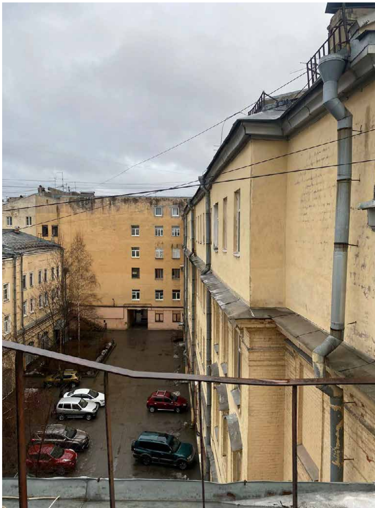
257. Крыша выявленного объекта культурного наследия «Особняк А.П. Шувалова (Е.А. Воронцовой-Дашковой)»;
