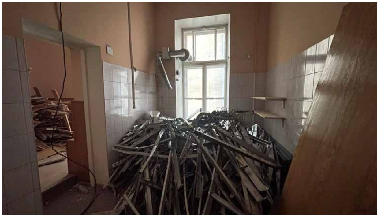
139. Фрагмент офисного помещения (помещение №2.20);
