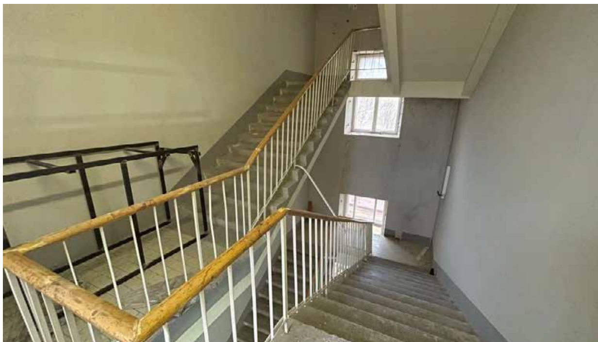
226. Лестничный пролет на третьем этаже;
