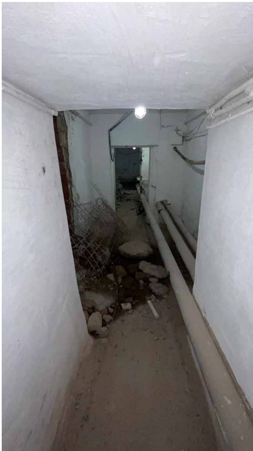
130. Фрагмент интерьера коридора подвального этажа;
