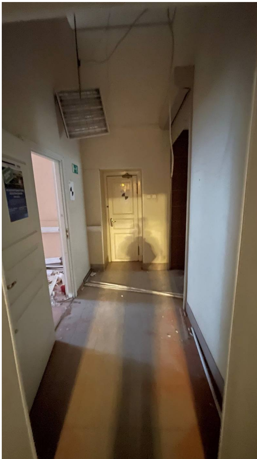
30. Фрагмент интерьера коридора (помещение №1.6);
