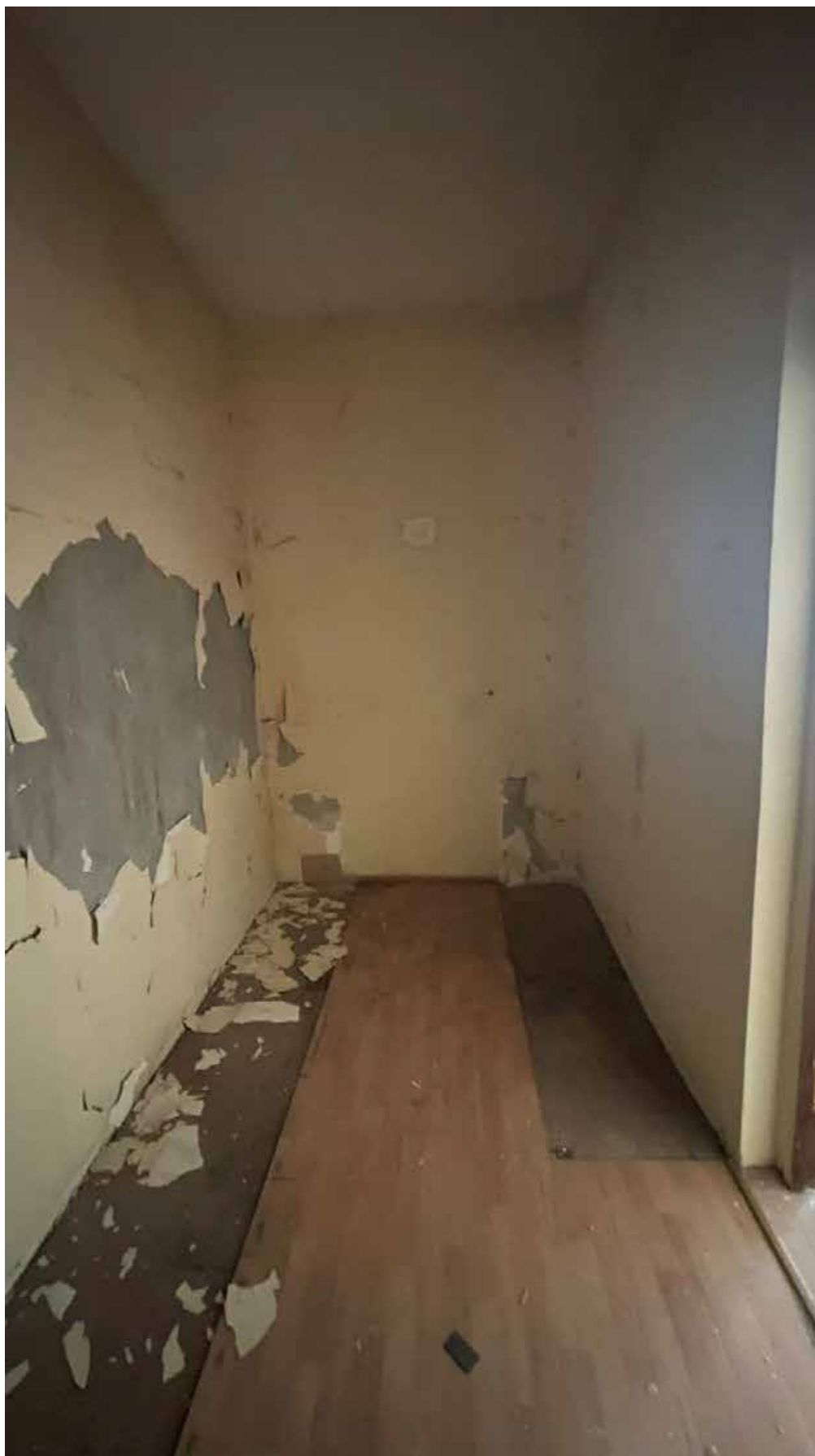
43. Фрагмент интерьера помещения архива (помещение №1.12);
