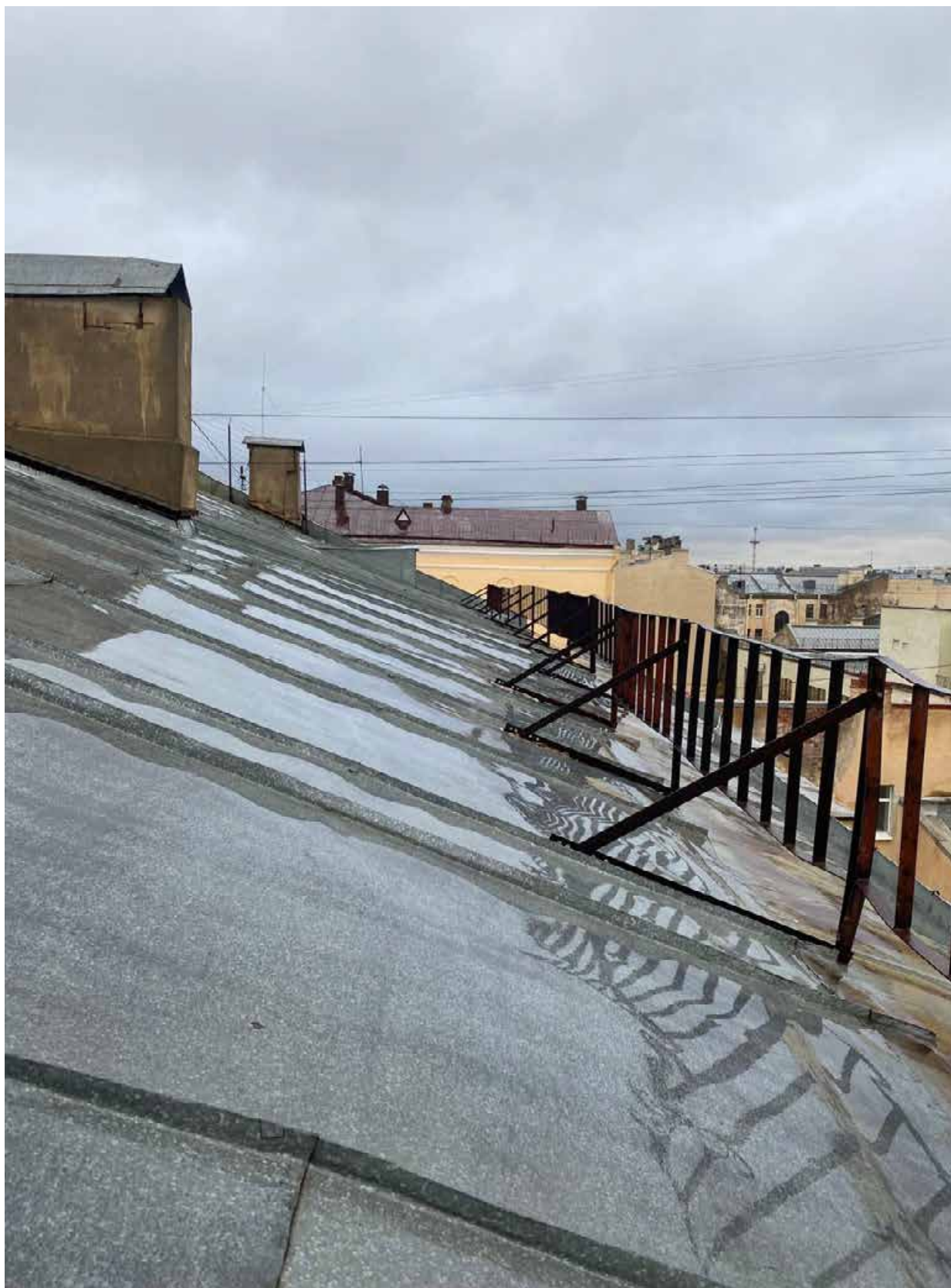
259. Крыша выявленного объекта культурного наследия «Особняк А.П. Шувалова (Е.А. Воронцовой-Дашковой)»;
