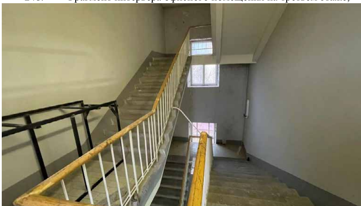
249. Фрагмент интерьера эвакуационной лестницы;
