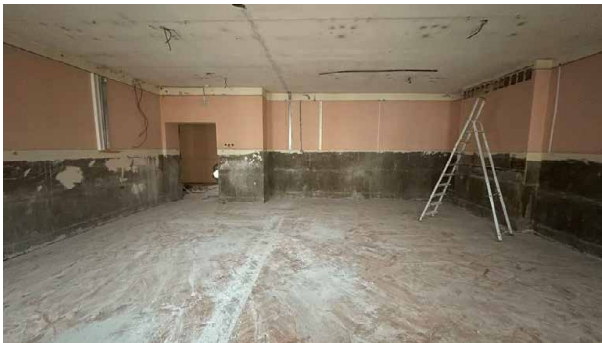
214. Фрагмент интерьера офисного помещения (помещение №3.22);
