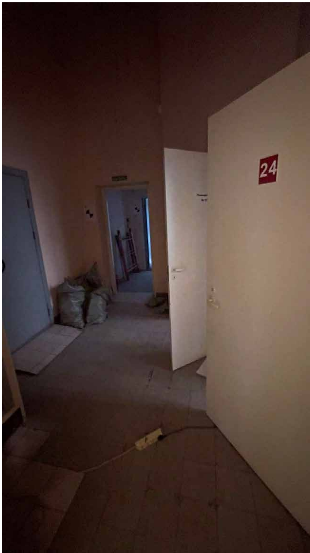
71. Фрагмент интеръера холла №5 (помещение №1.27);
