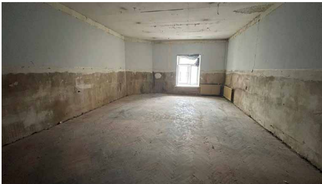
207. Фрагмент интерьера офисного помещения на третьем этаже (помещение №3.3);
