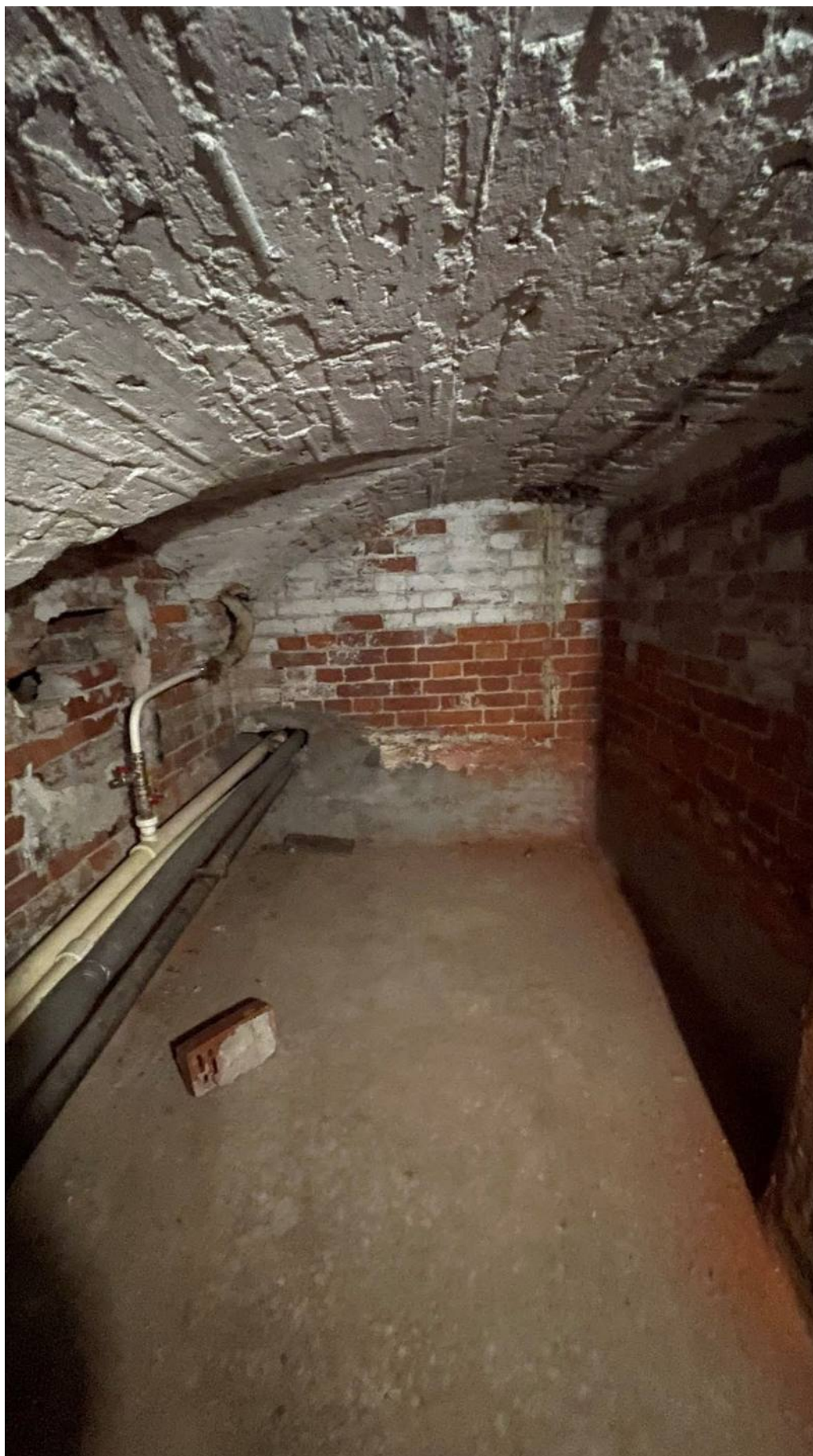
111. Подвальный этаж. Фрагмент интерьера;
