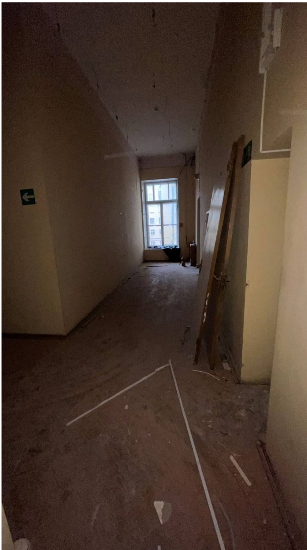
161. Фрагмент интерьера коридора на втором этаже;
