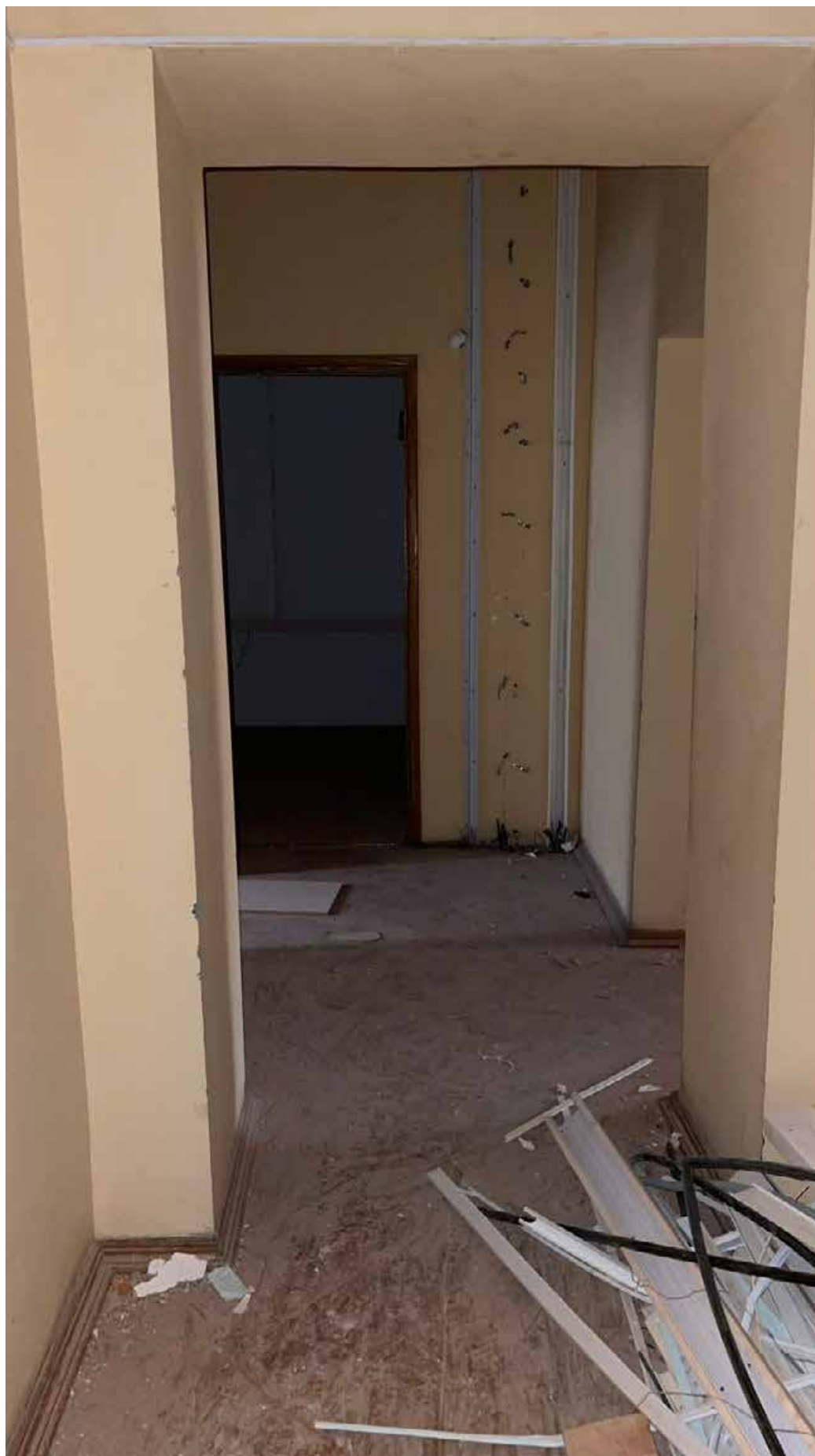
144. Фрагмент интерьера коридора на втором этаже;
