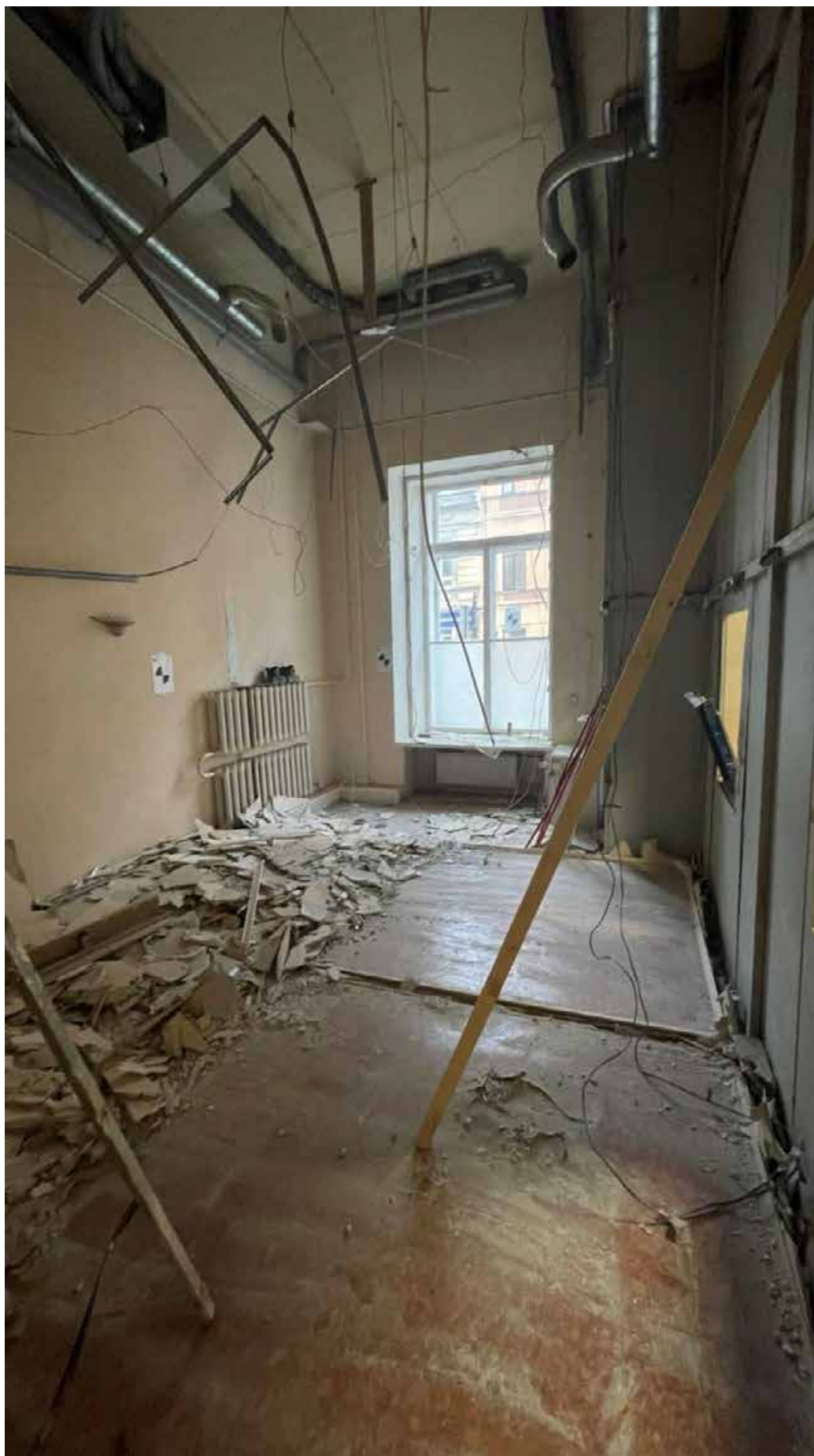
62. Фрагмент интерьера помещений №1.36 и 1.37;
