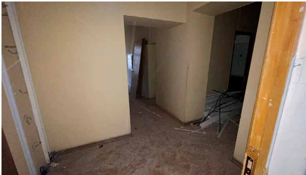
158. Фрагмент интерьера коридора на втором этаже;
