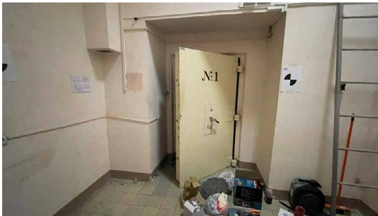
78. Вид на вход в хранилище;
