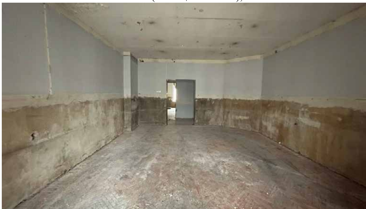
208. Фрагмент интерьера офисного помещения на третьем этаже (помещение №3.3);
