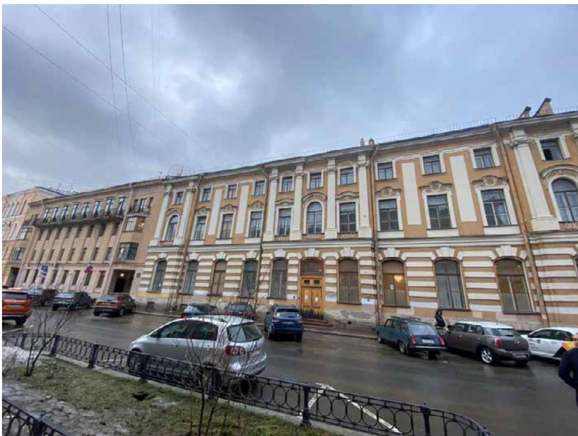
5. Вид на главный фасад выявленного объекта культурного наследия «Особняк А.П. Шувалова (Е.А. Воронцовой-Дашковой)»;
