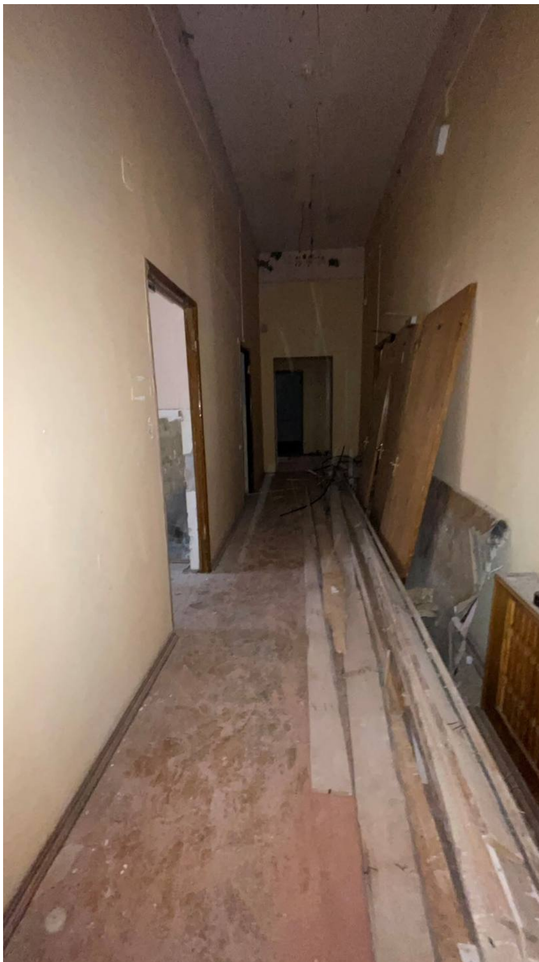
155. Фрагмент интерьера коридора на втором этаже;
