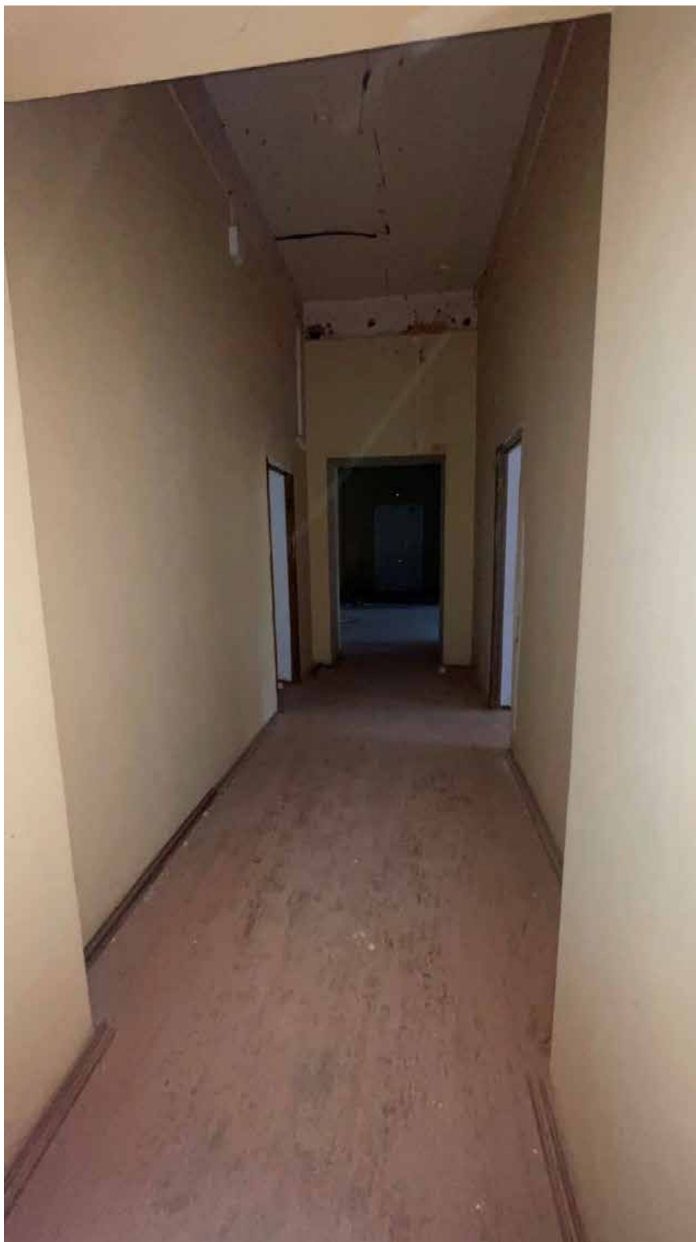
166. Фрагмент интерьера коридора на втором этаже;
