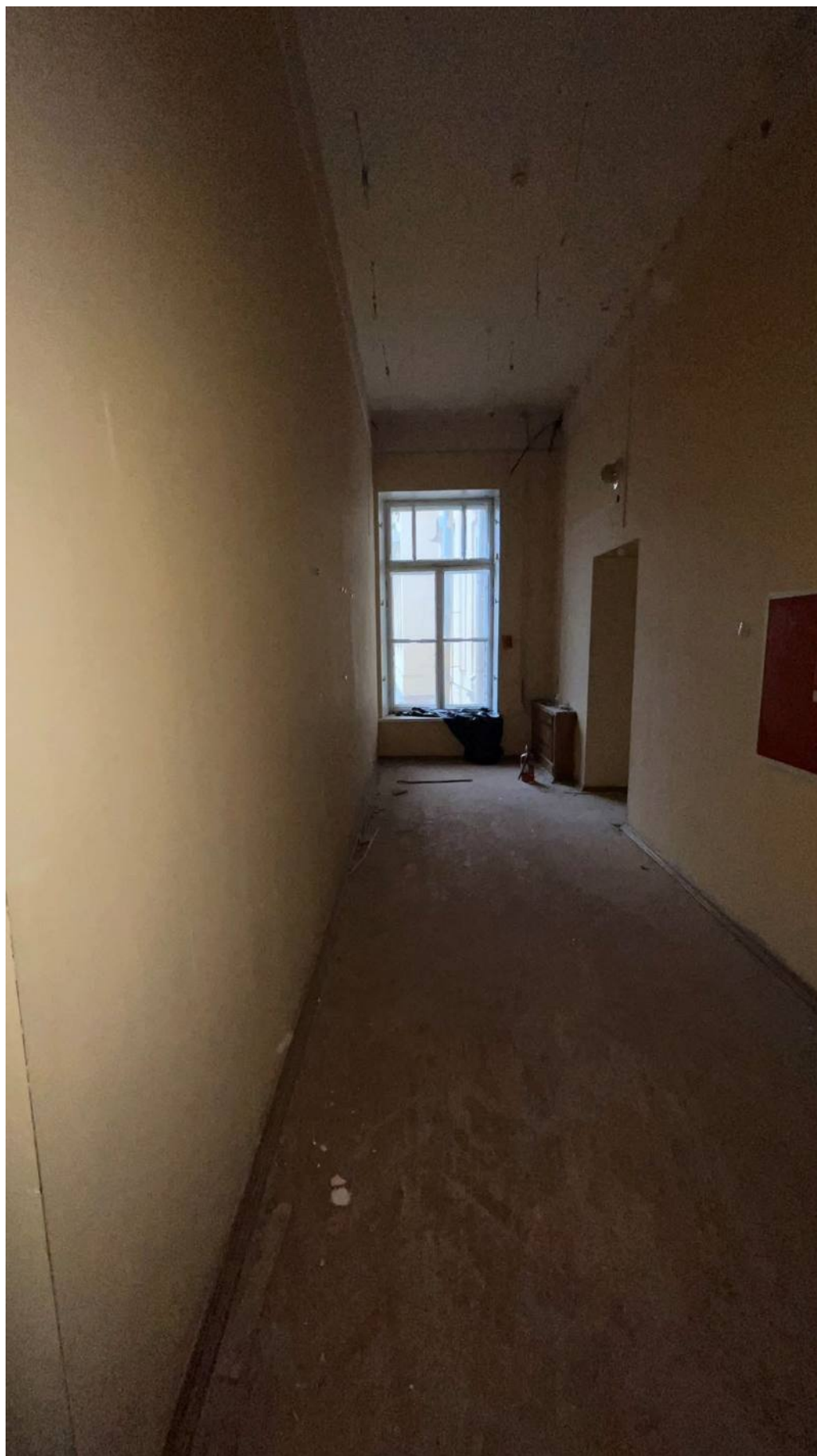
164. Фрагмент интерьера коридора на втором этаже;
