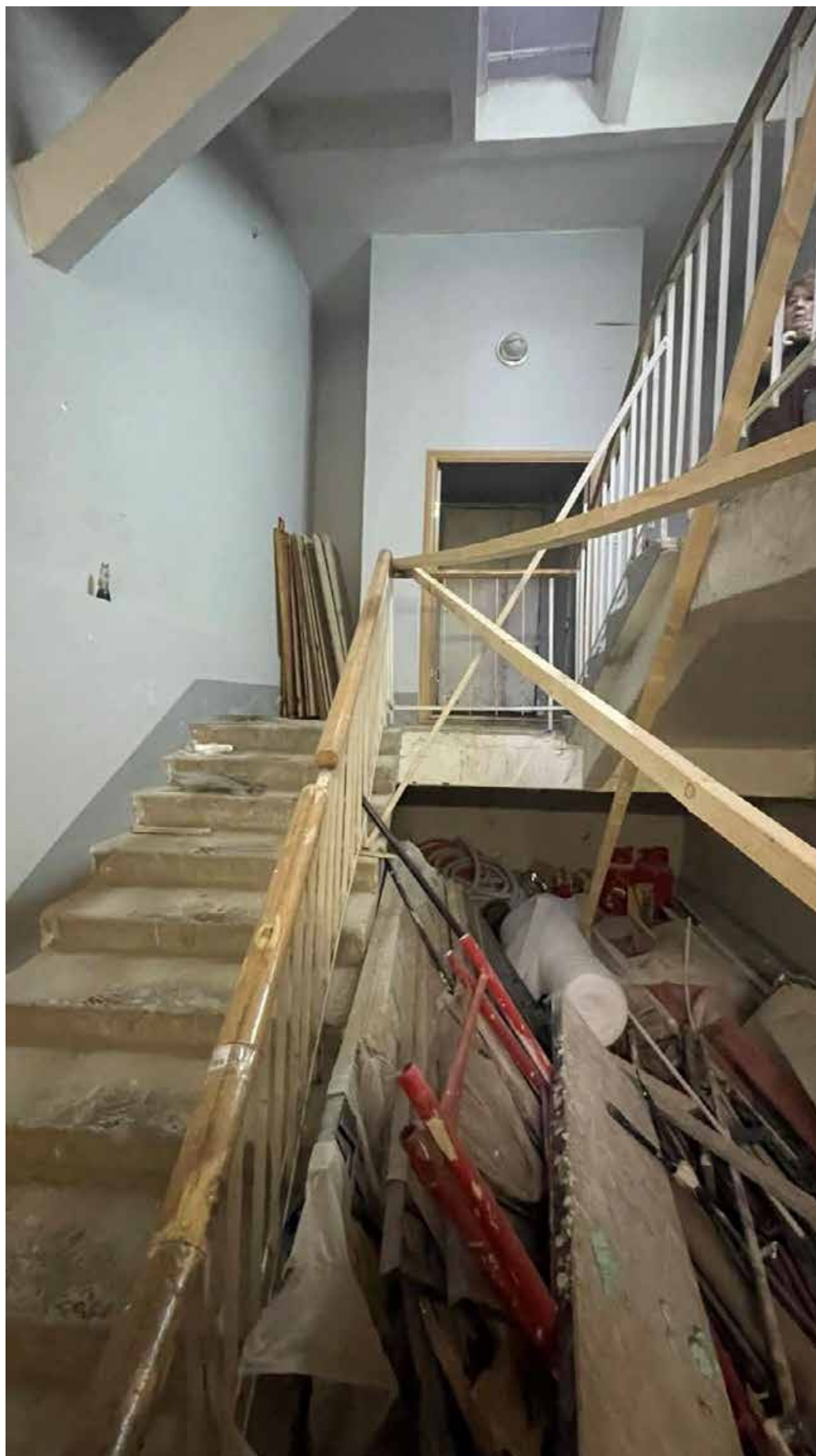
87. Вид на эвакуационную лестницу;
