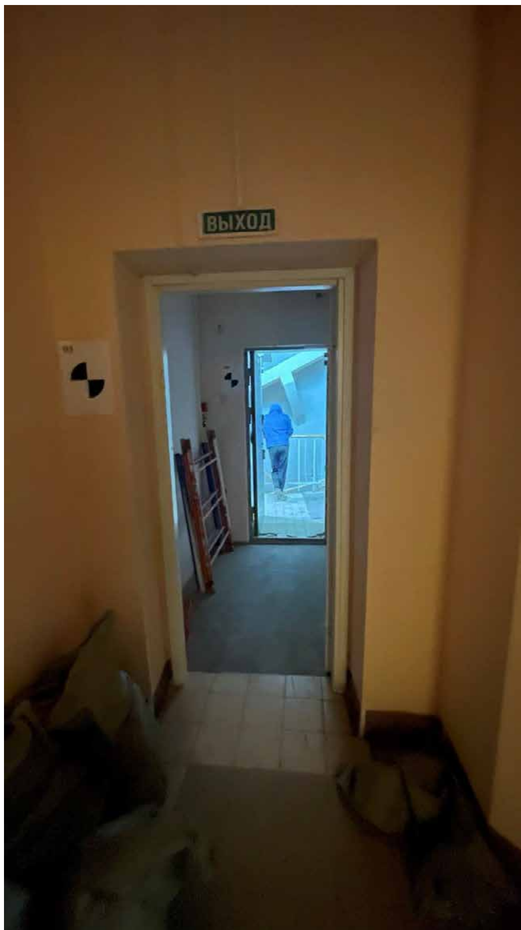
74. Фрагмент интерьера холла №5 (помещение №1.27);
