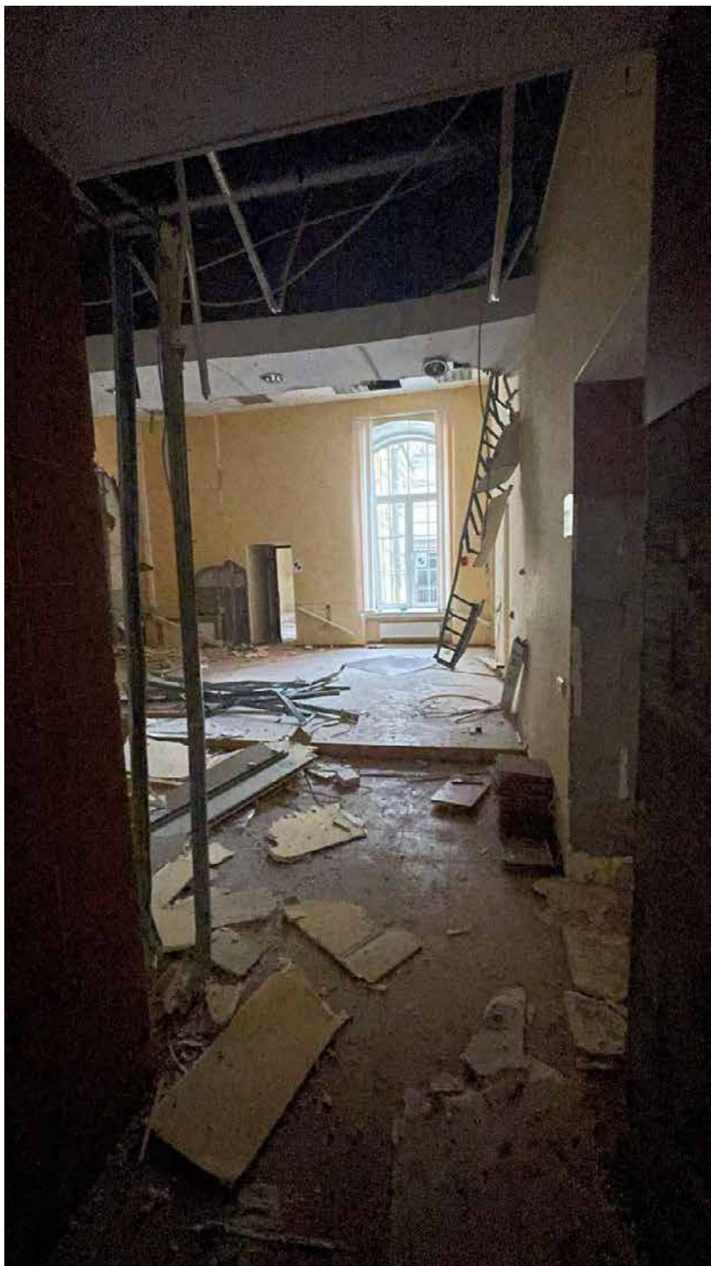
37.Фрагмент интерьера операционного зала (помещение №1.8);
