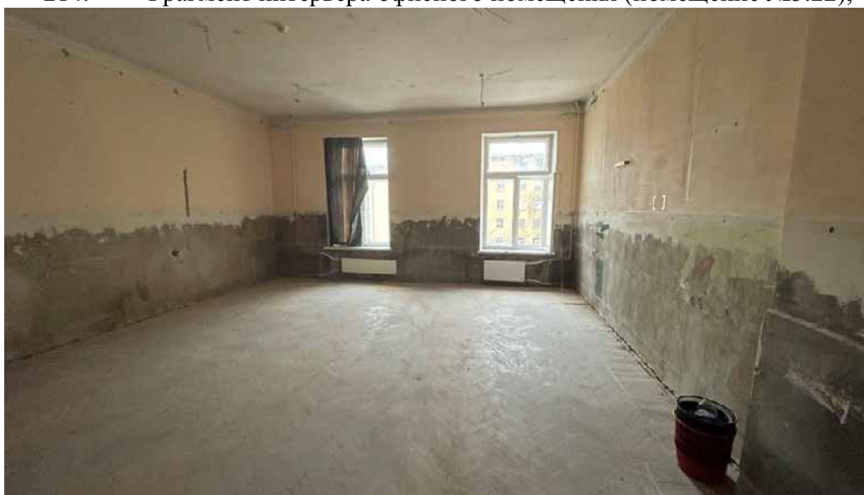
215. Фрагмент интерьера офисного помещения (помещение №3.6);
