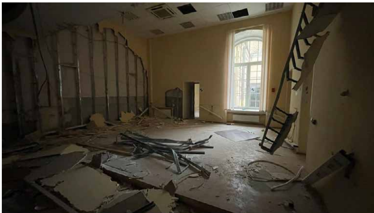
38. Фрагмент интерьера операционного зала (помещение №1.8);
