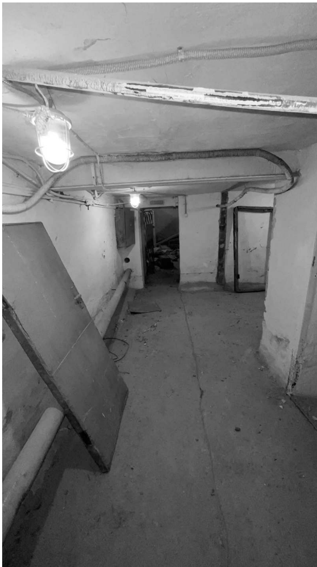
131. Фрагмент интерьера коридора подвального этажа;
