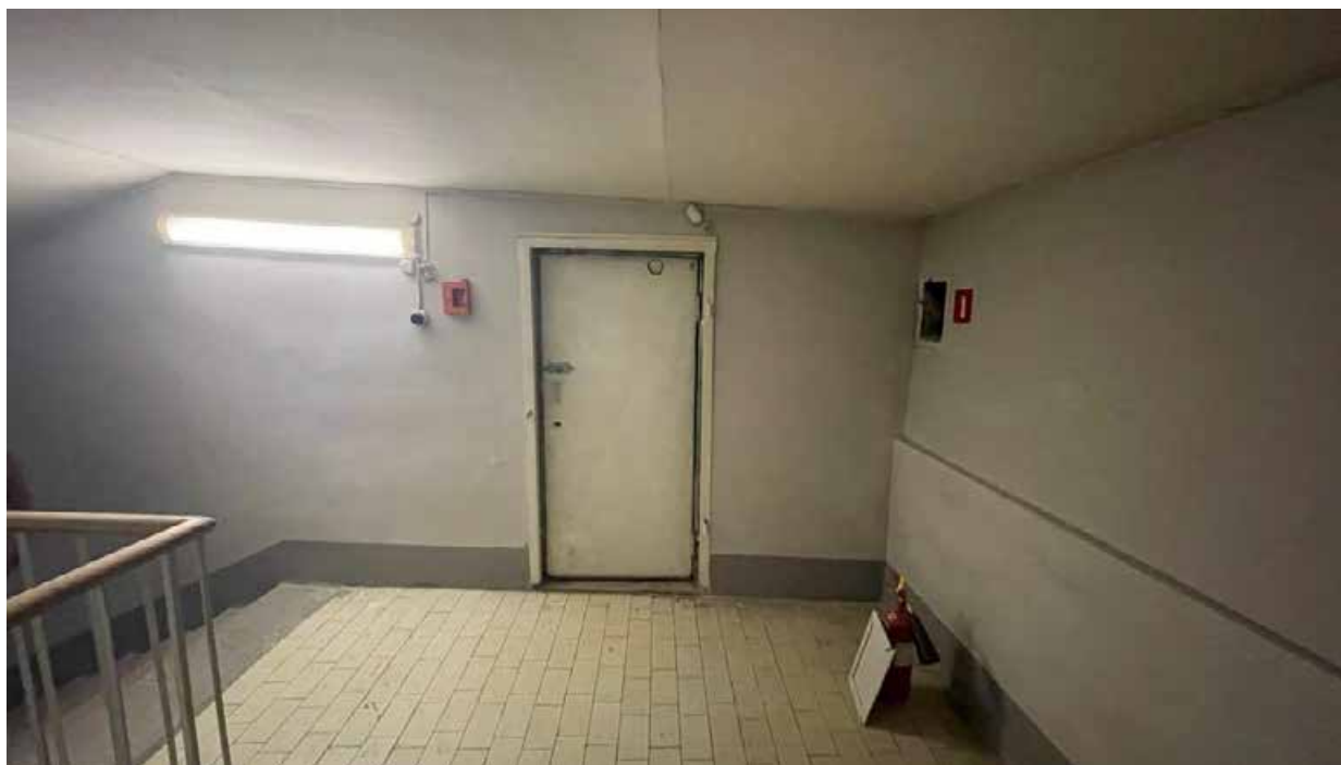
261. Дверь на чердак;
