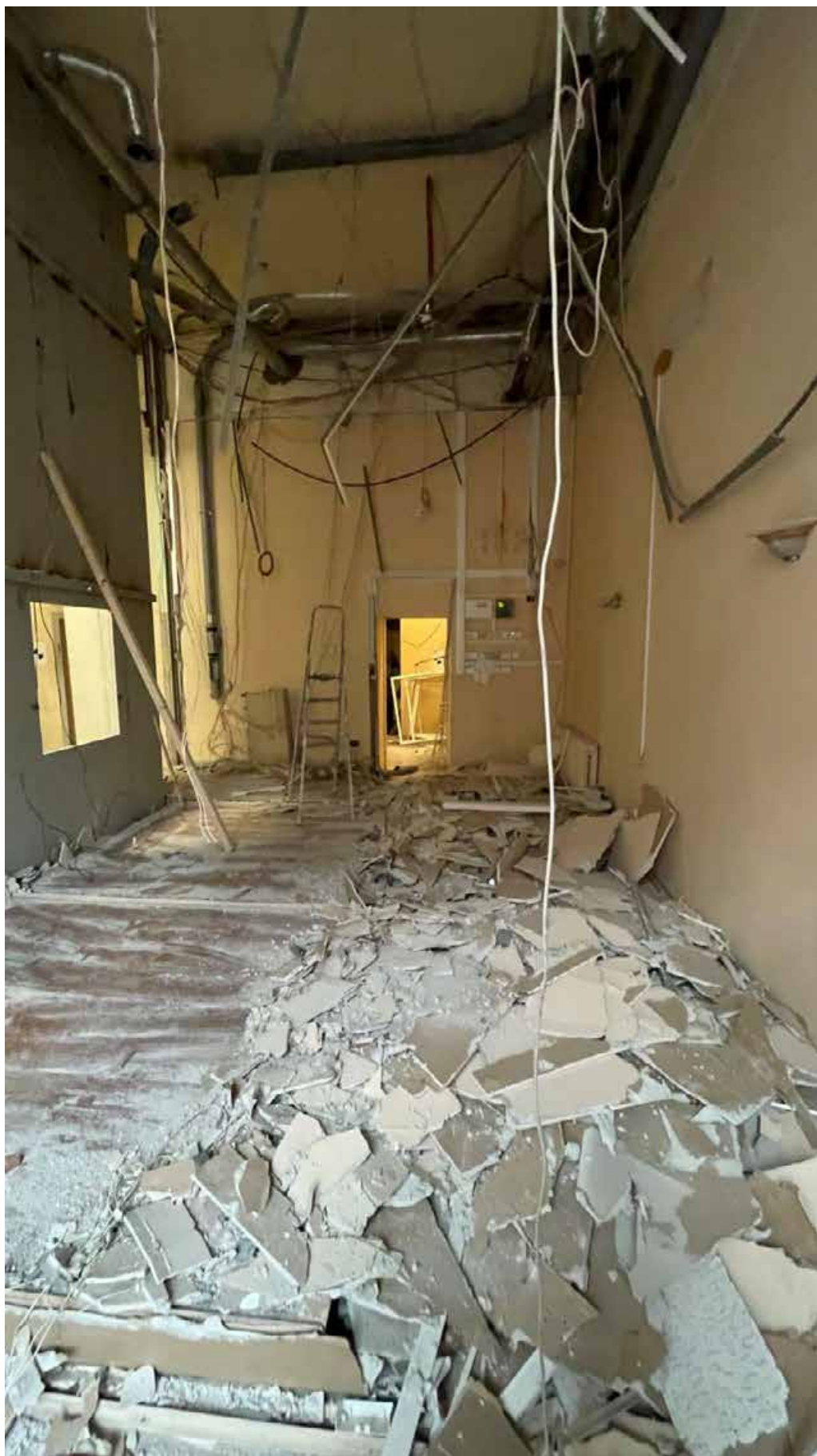
63. Фрагмент интерьера помещений №1.36 и 1.37;
