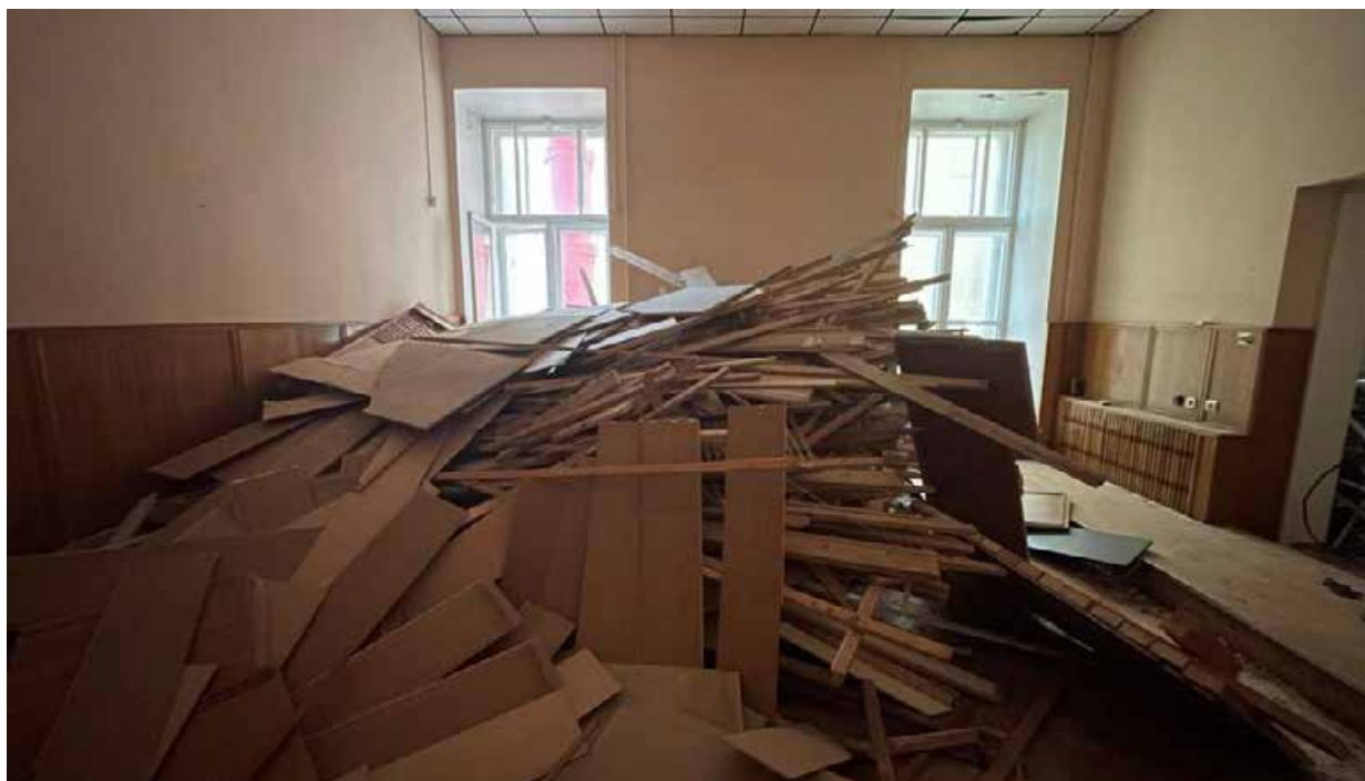
137. Фрагмент офисного помещения (помещение №2.16);
