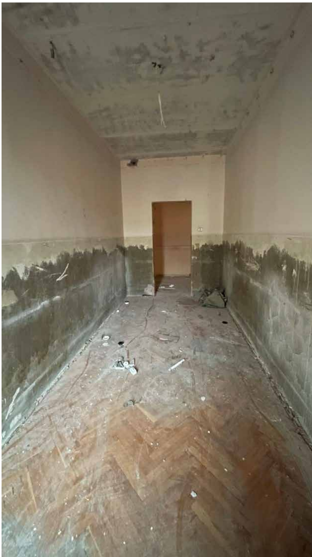
219. Фрагмент интерьера офисного помещения (помещение №3.7);
