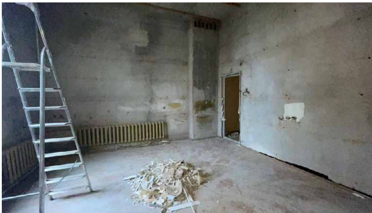
154. Фрагмент интерьера помещения на втором этаже;
