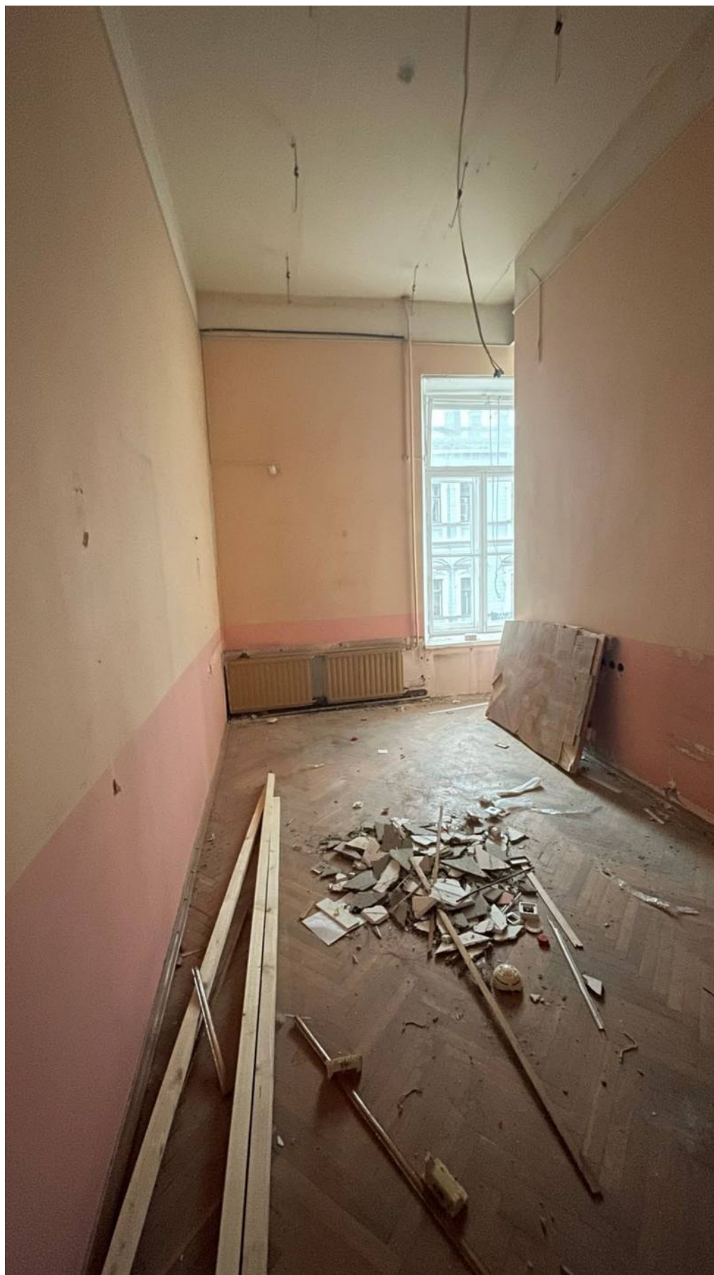
188. Фрагмент интерьера коридора на втором этаже;
