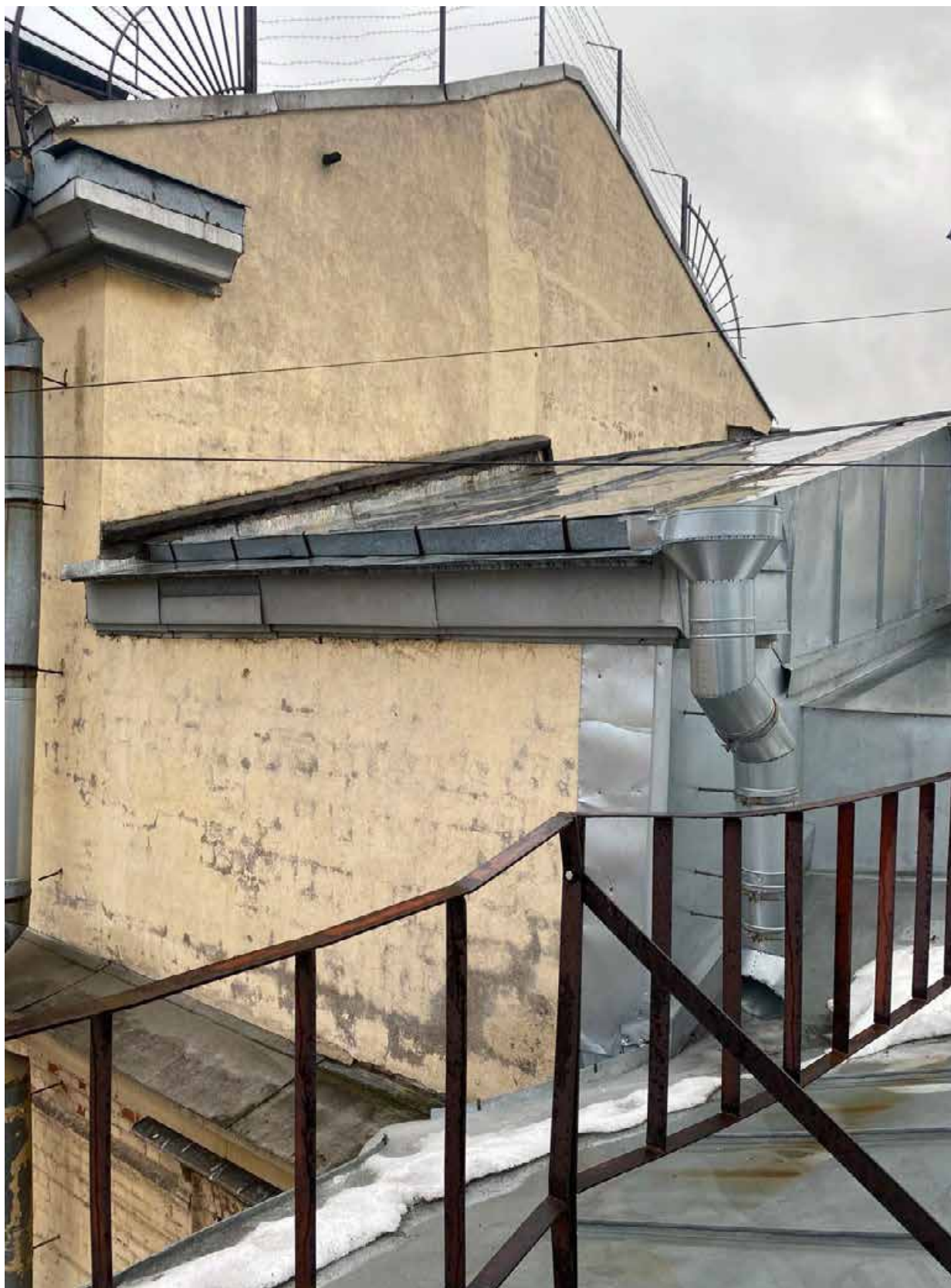
258. Крыша выявленного объекта культурного наследия «Особняк А.П. Шувалова (Е.А. Воронцовой-Дашковой)»;
