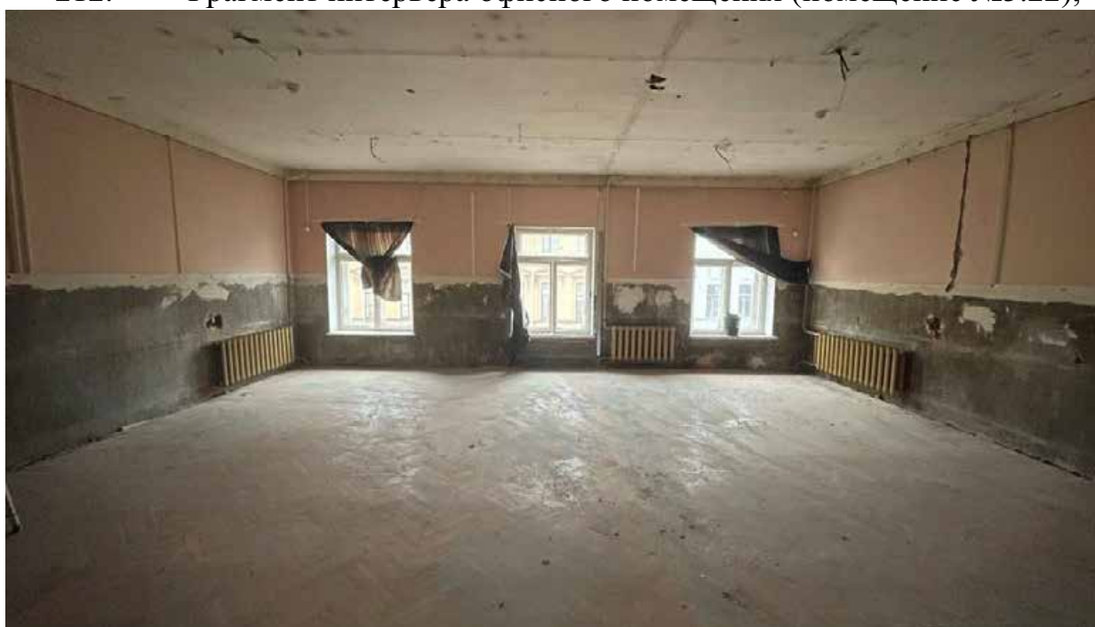
213. Фрагмент интерьера офисного помещения (помещение №3.22);
