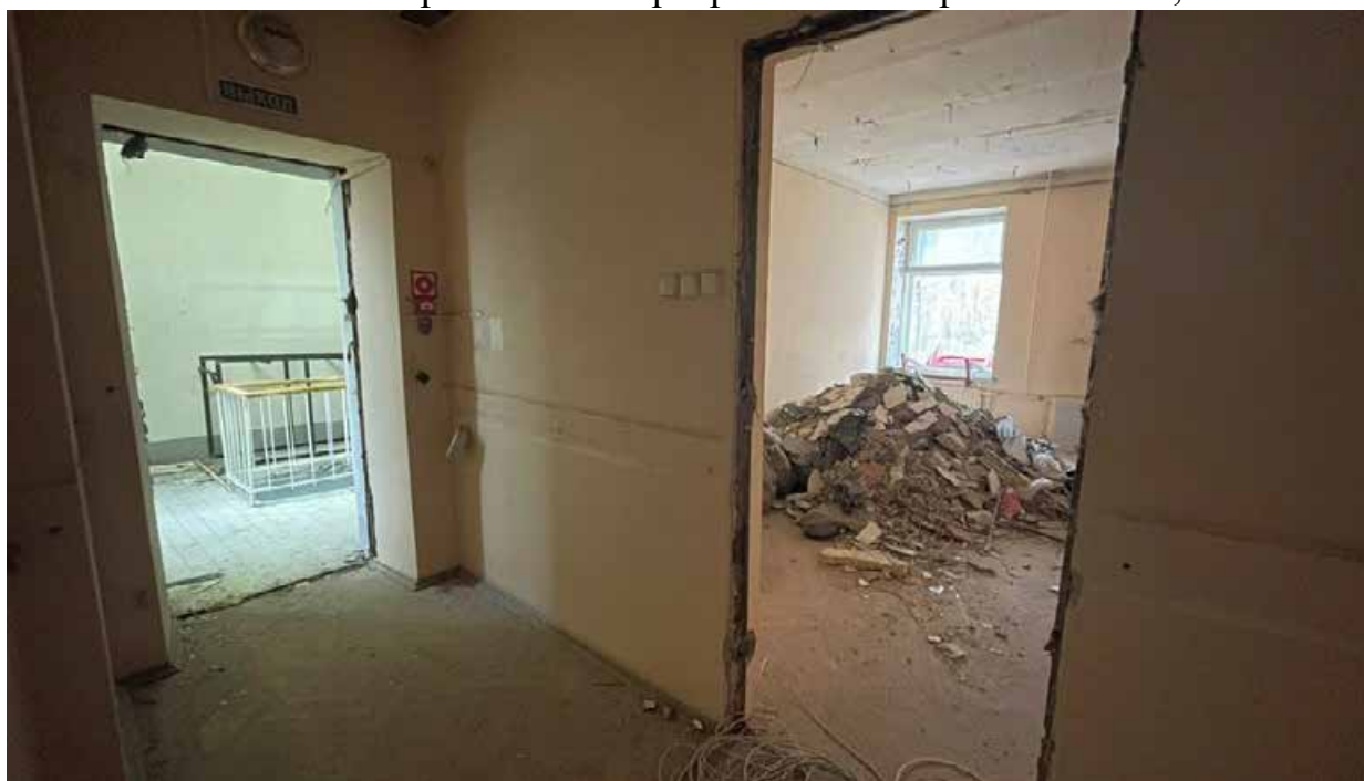
225. Фрагмент интерьера коридора на третьем этаже. Вид на эвакуационную лестницу;
