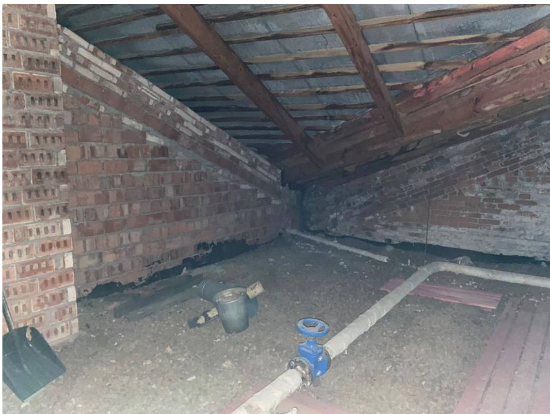
255. Фрагмент интерьера чердака;
