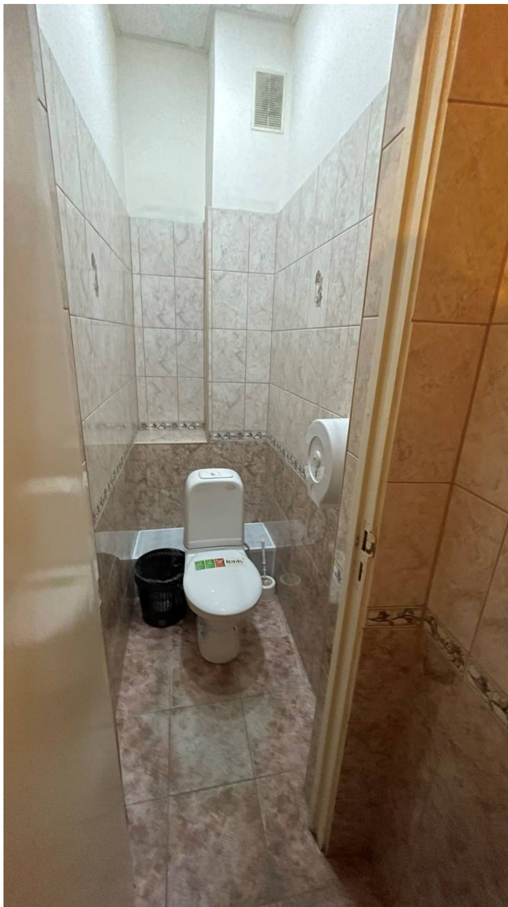
238. Фрагмент интерьера санузла;
