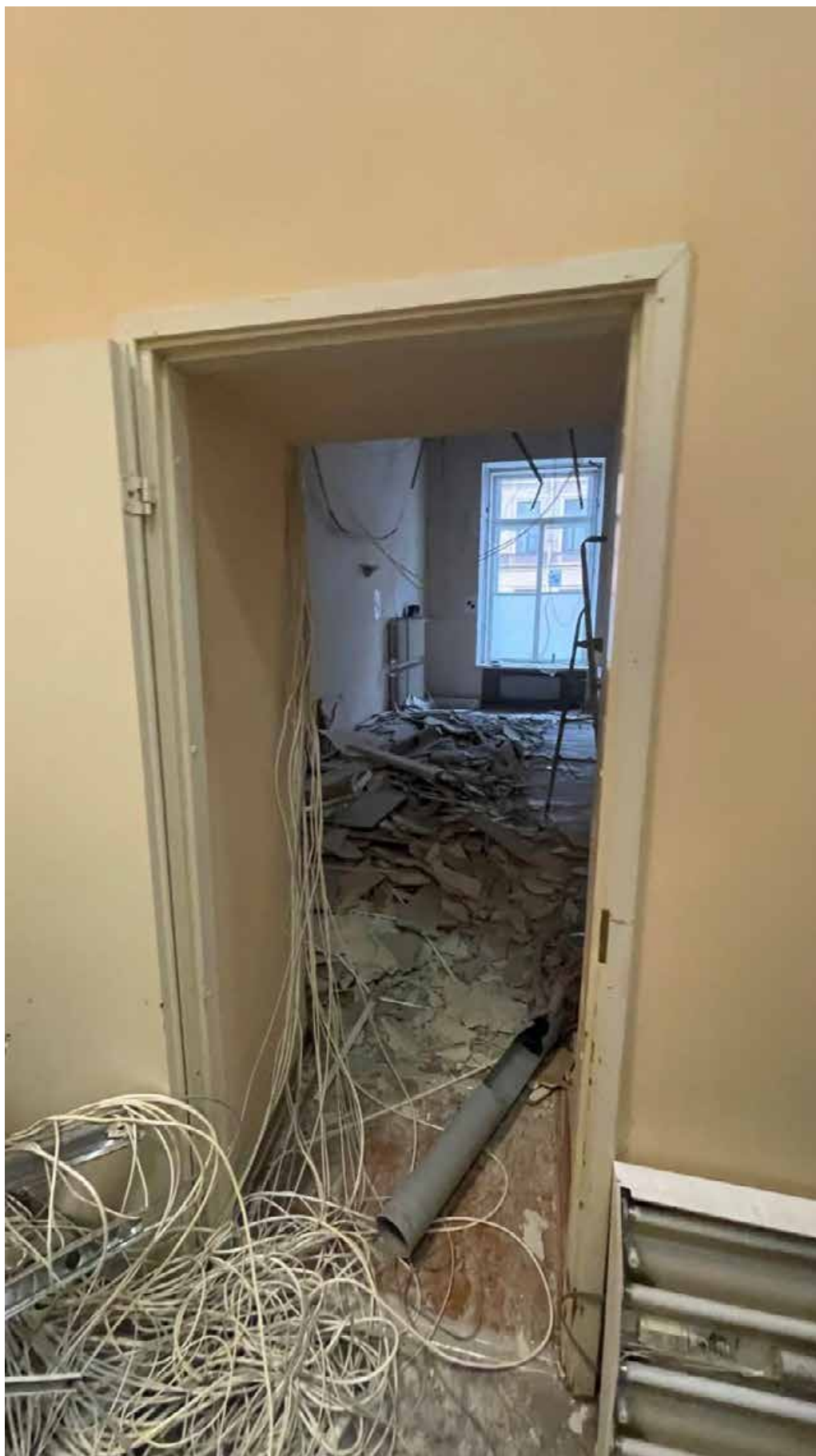
64. Фрагмент интерьера помещений №1.36 и 1.37;
