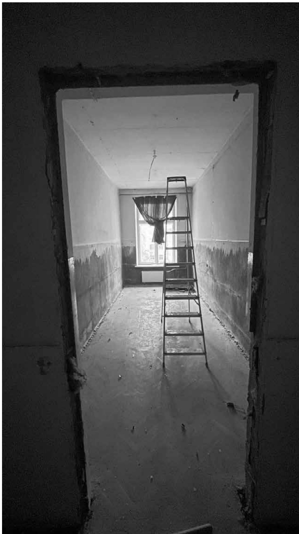
220. Фрагмент интерьера офисного помещения (помещение №3.8);
