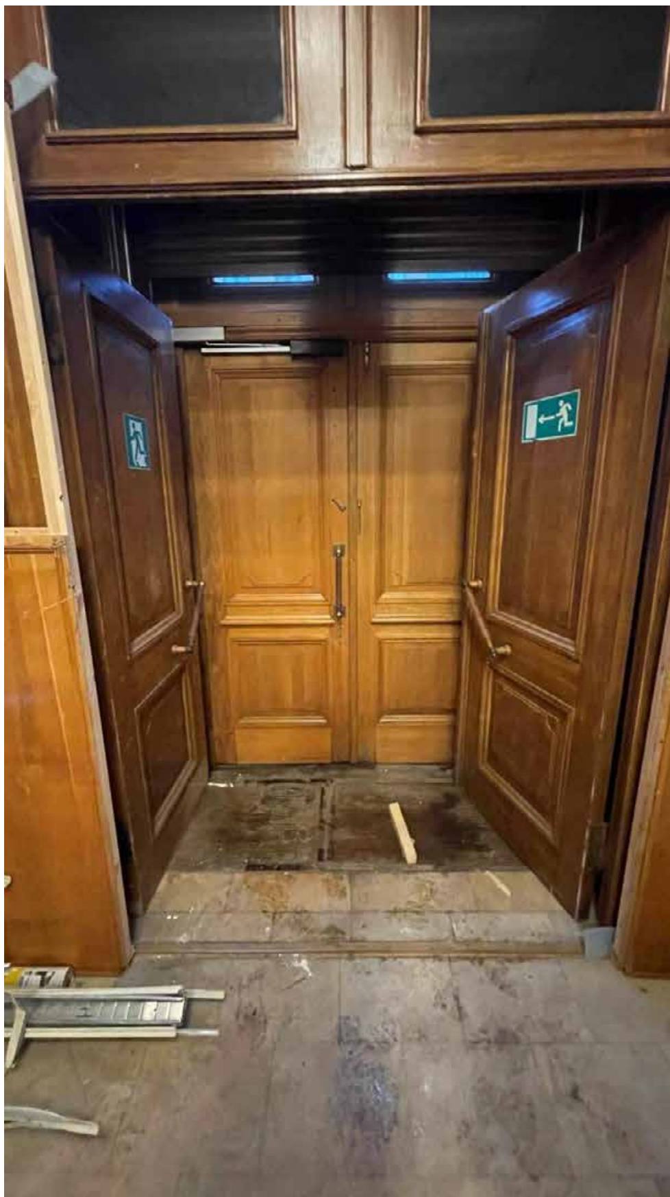
19. Вид на входную дверь в помещении;
