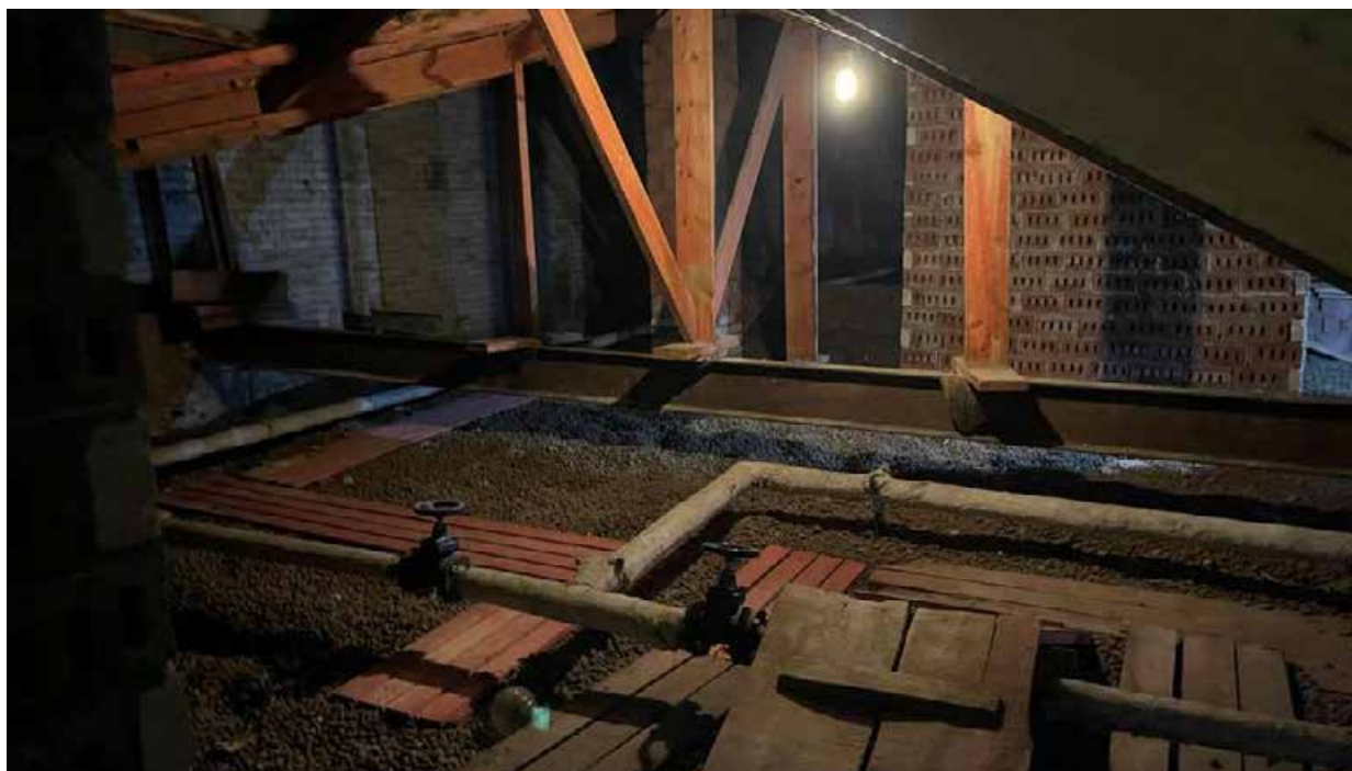
252. Фрагмент интерьера чердака;
