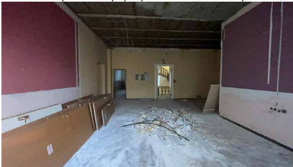
174. Фрагмент холла на втором этаже;
