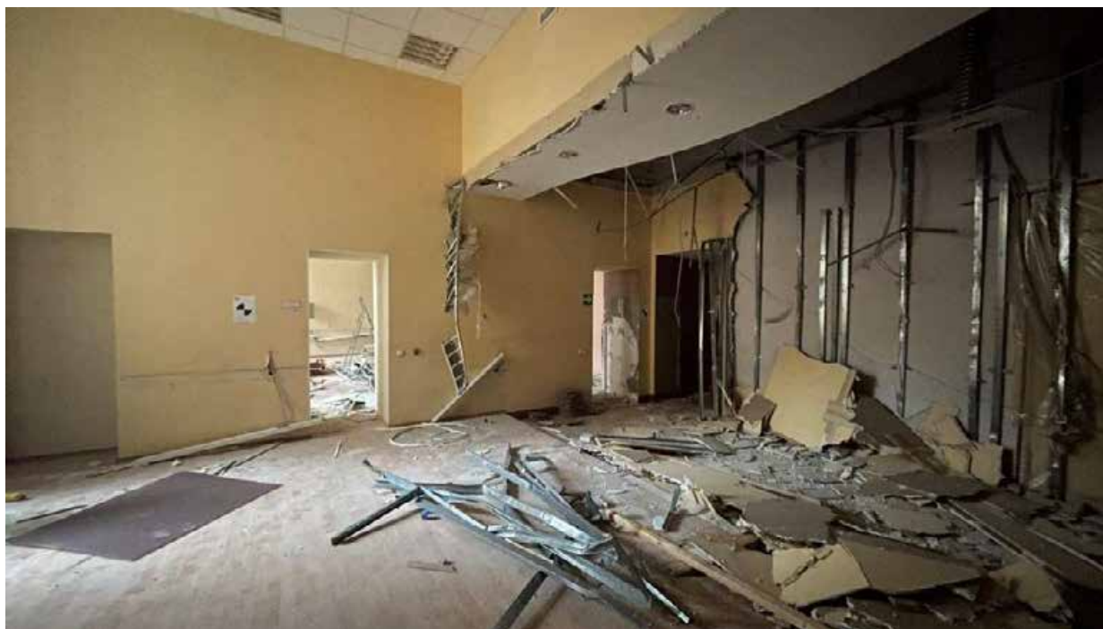
40. Фрагмент интерьера операционного зала (помещение №1.8);
