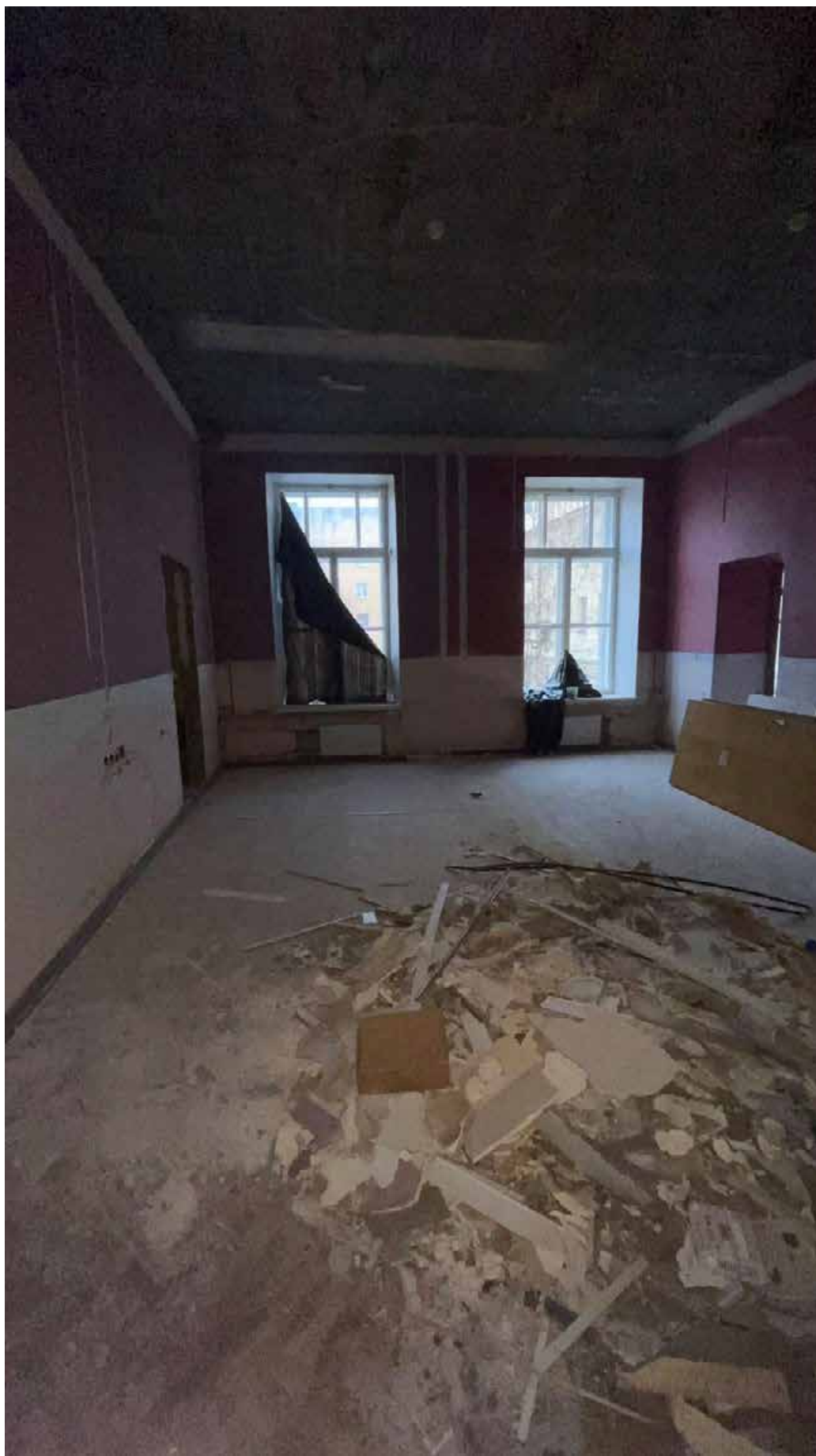
177. Фрагмент холла на втором этаже;
