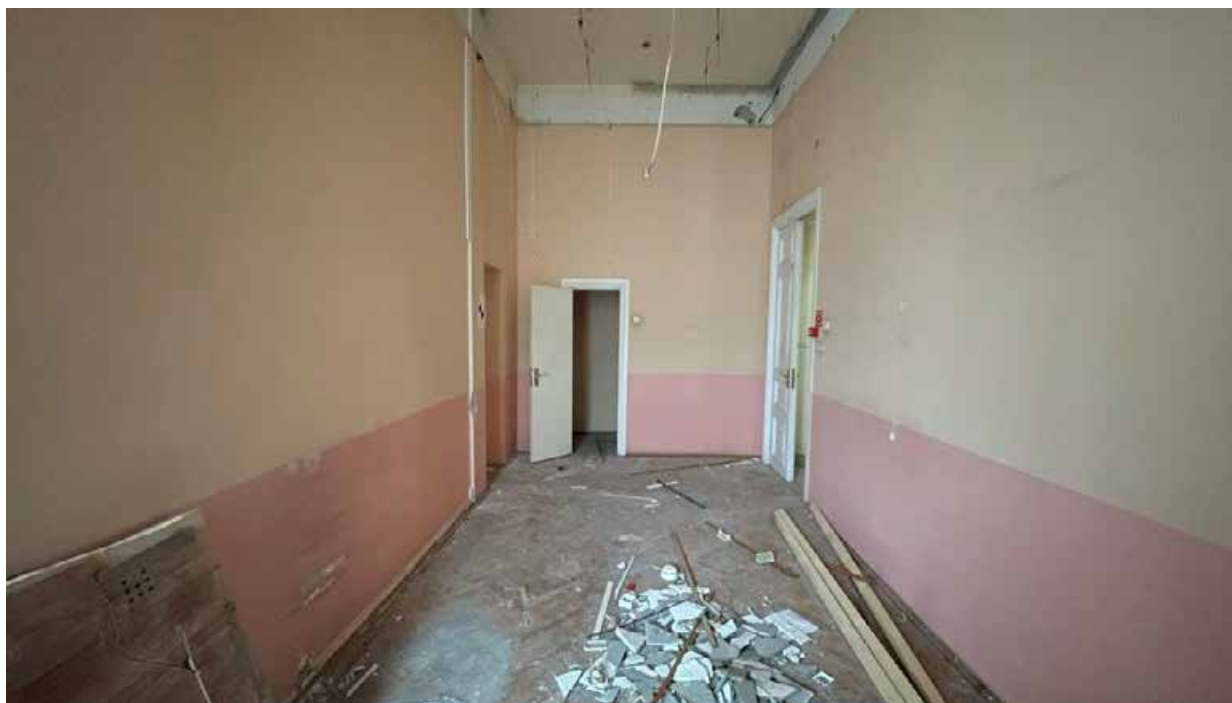
197. Фрагмент интерьера коридора на втором этаже;
