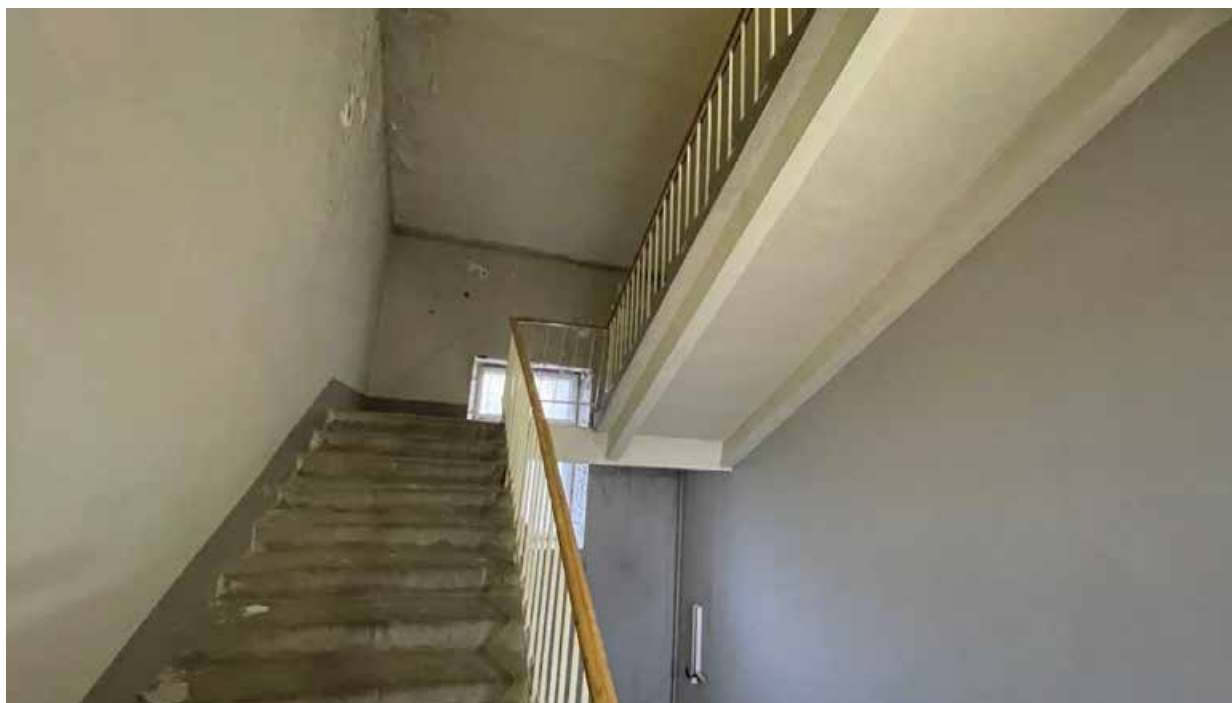
250. Фрагмент интерьера эвакуационной лестницы;
