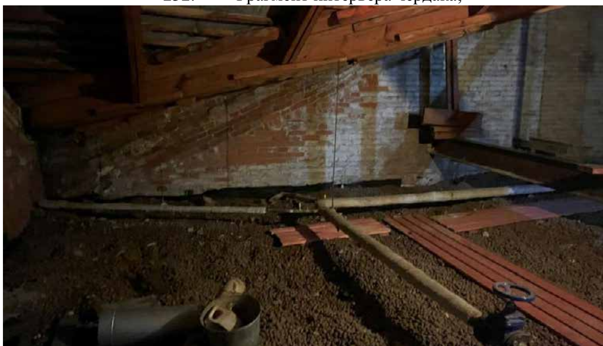
253. Фрагмент интерьера чердака;
