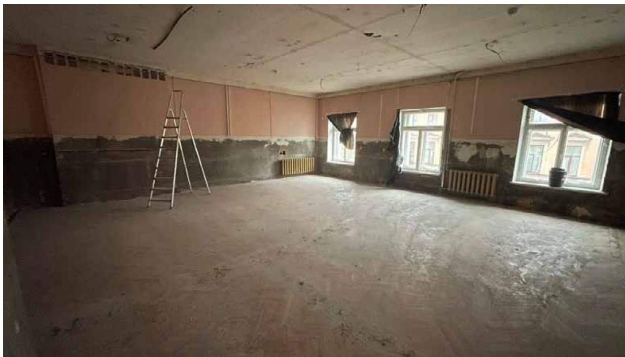
212. Фрагмент интерьера офисного помещения (помещение №3.22);
