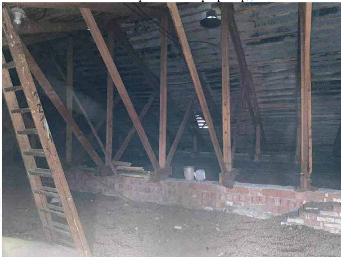
256. Фрагмент интерьера чердака;
