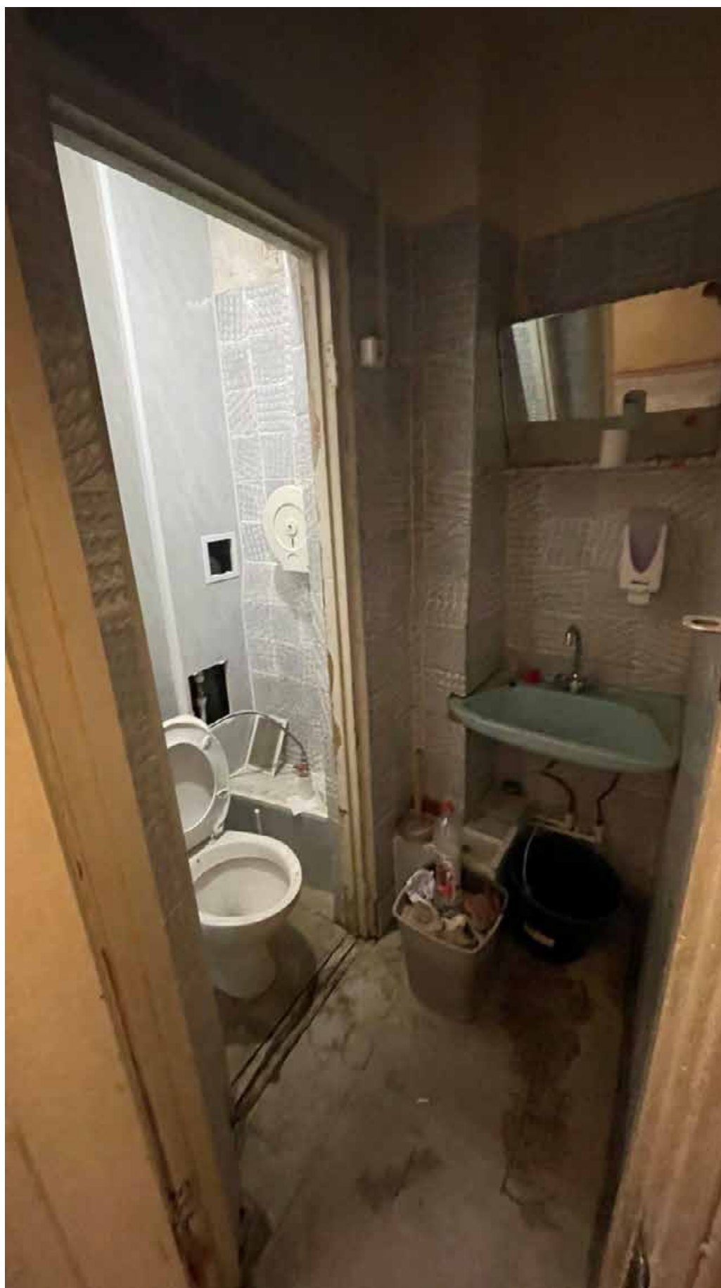
66. Фрагмент интерьера санузла;
