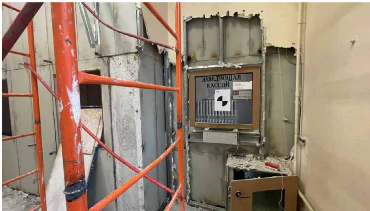
60.Фрагмент интерьера холла (помещение №1.42);
