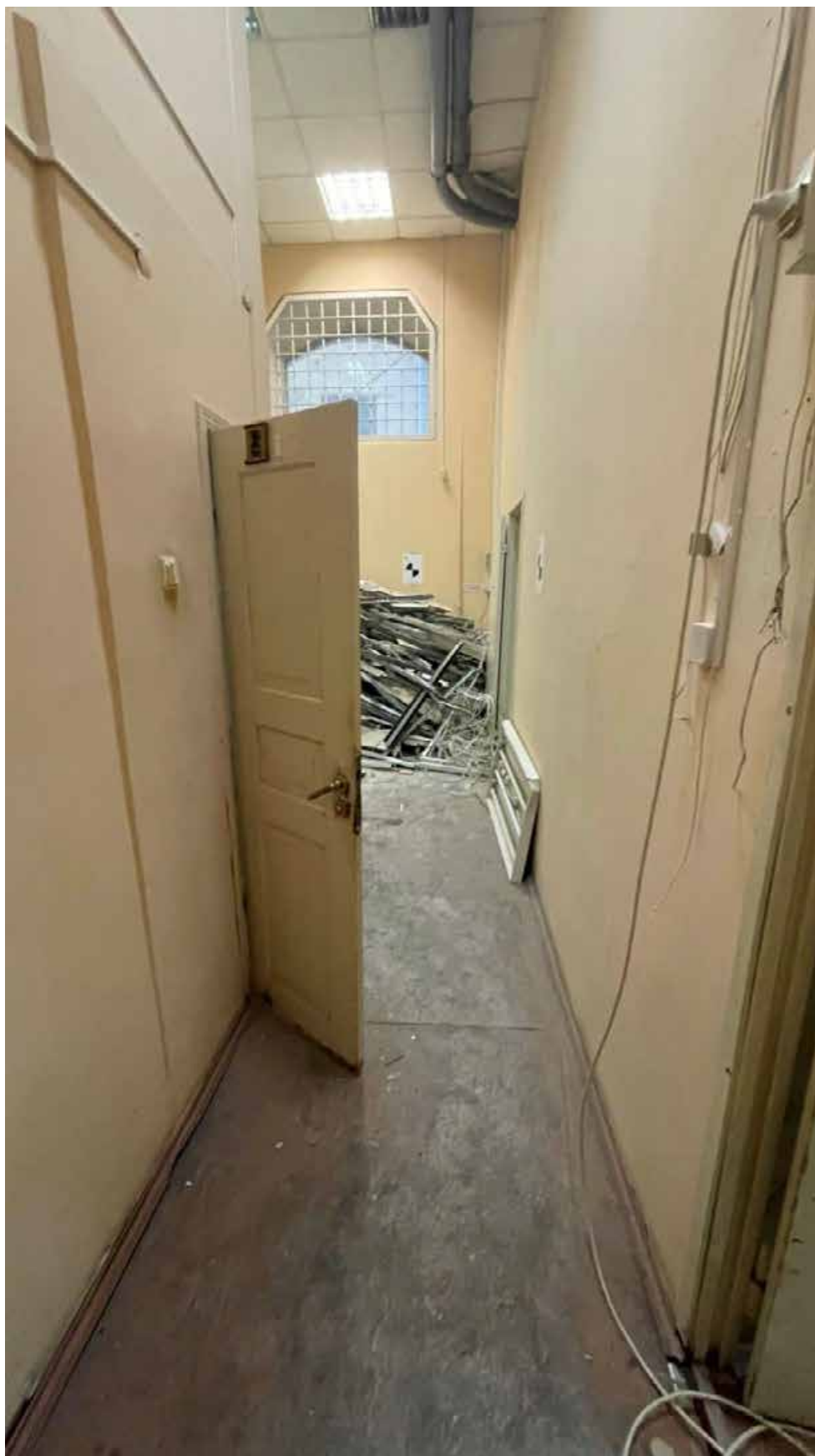
70. Фрагмент интеръера холла (помещение №1.30);
