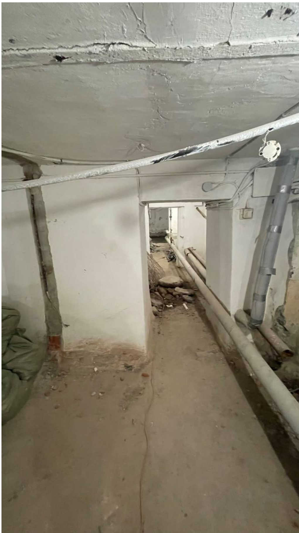
94. Фрагмент интерьера коридора (помещение №0.20);
