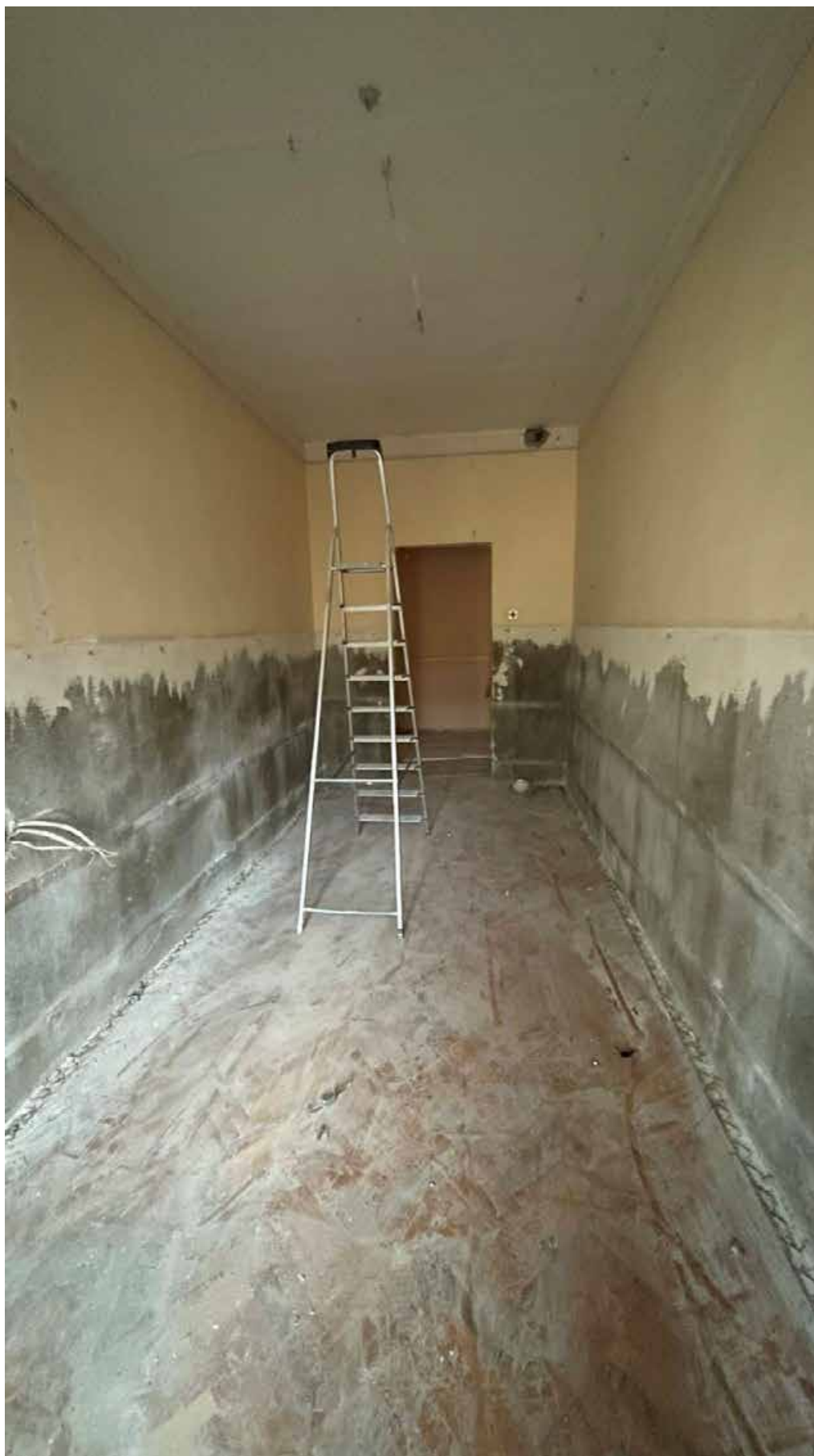
221. Фрагмент интерьера офисного помещения (помещение №3.8);
