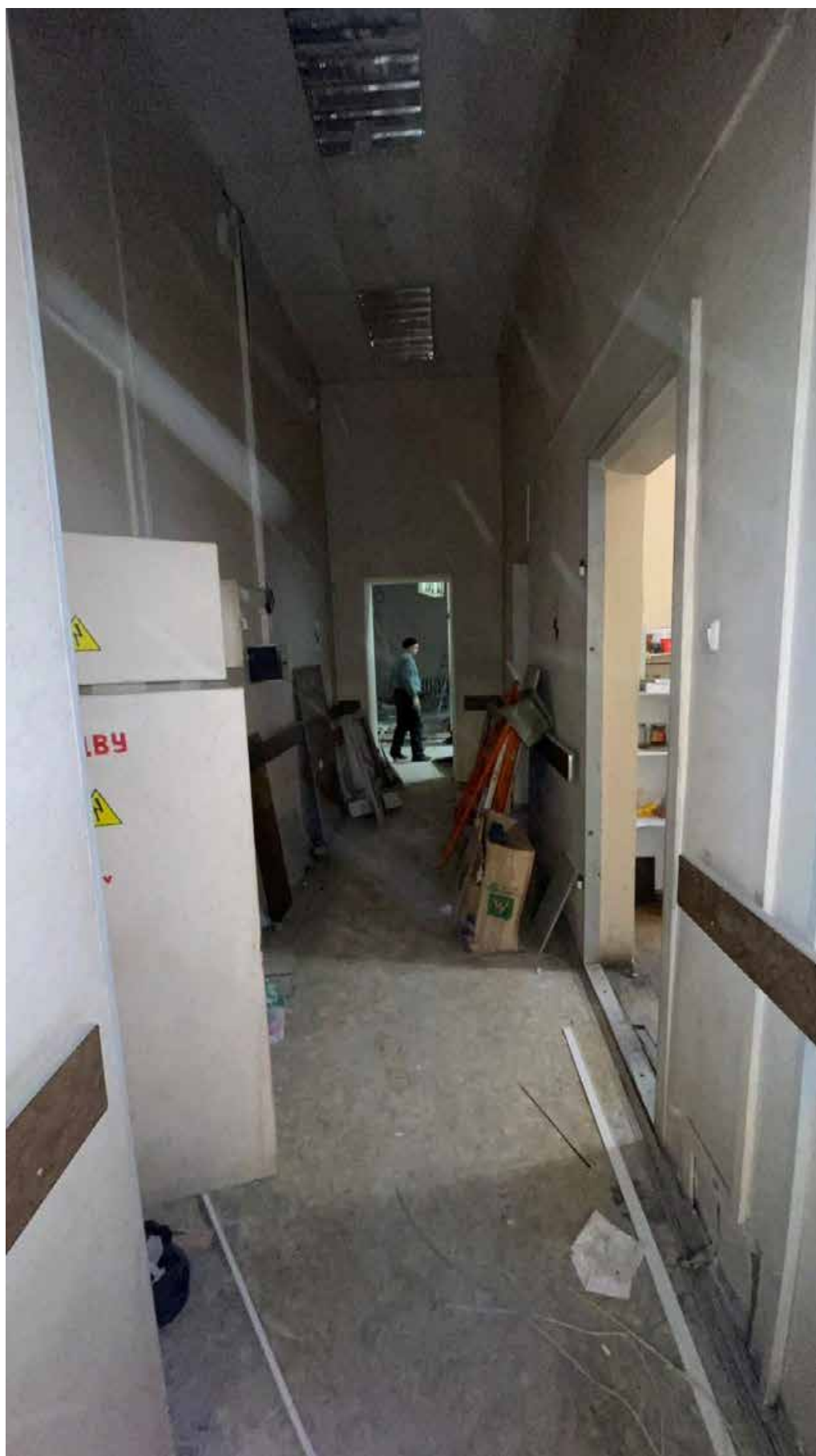
52. Фрагмент интерьера коридора №6 (помещение №1.43);
