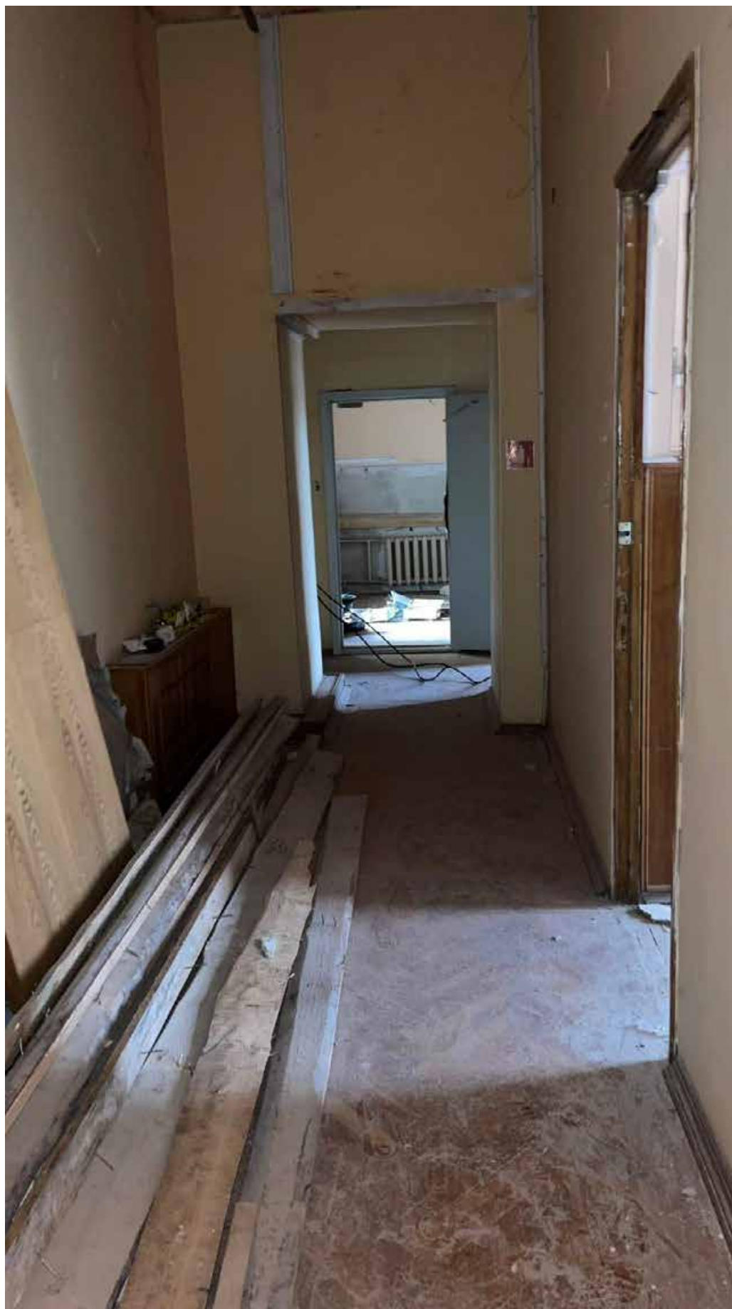
143. Фрагмент интерьера коридора на втором этаже;
