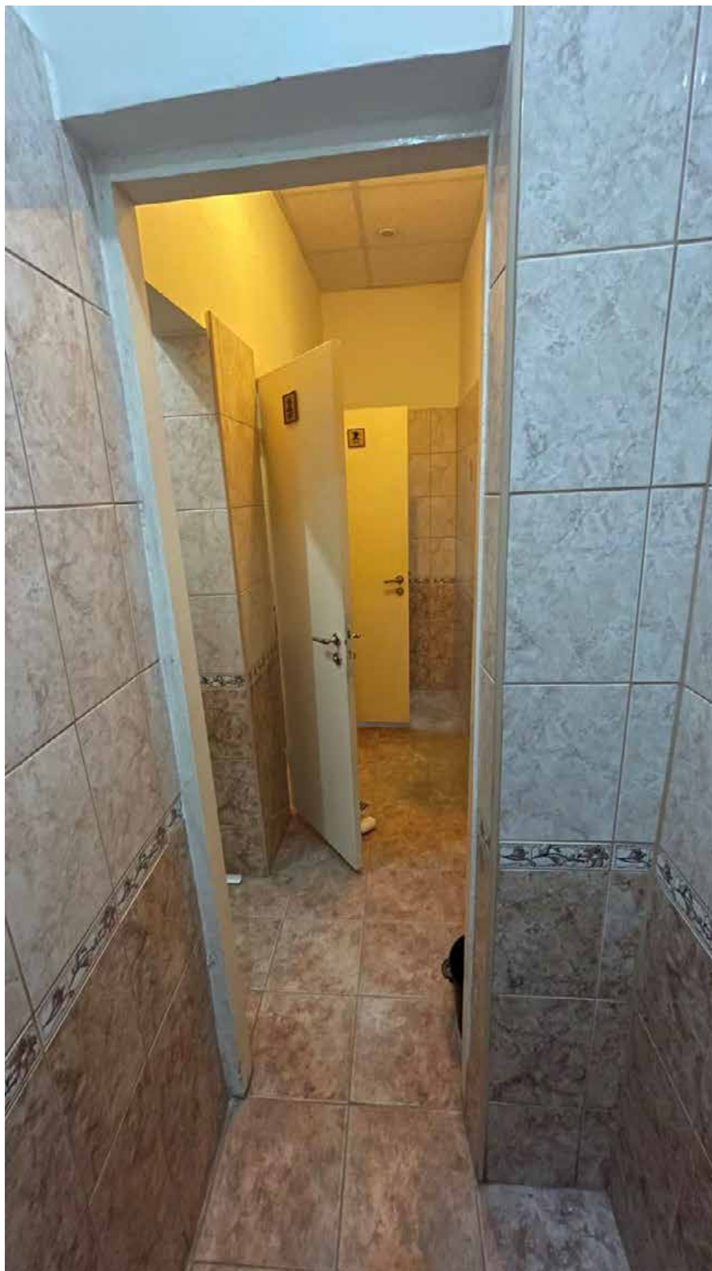
235. Фрагмент интерьера санузла;
