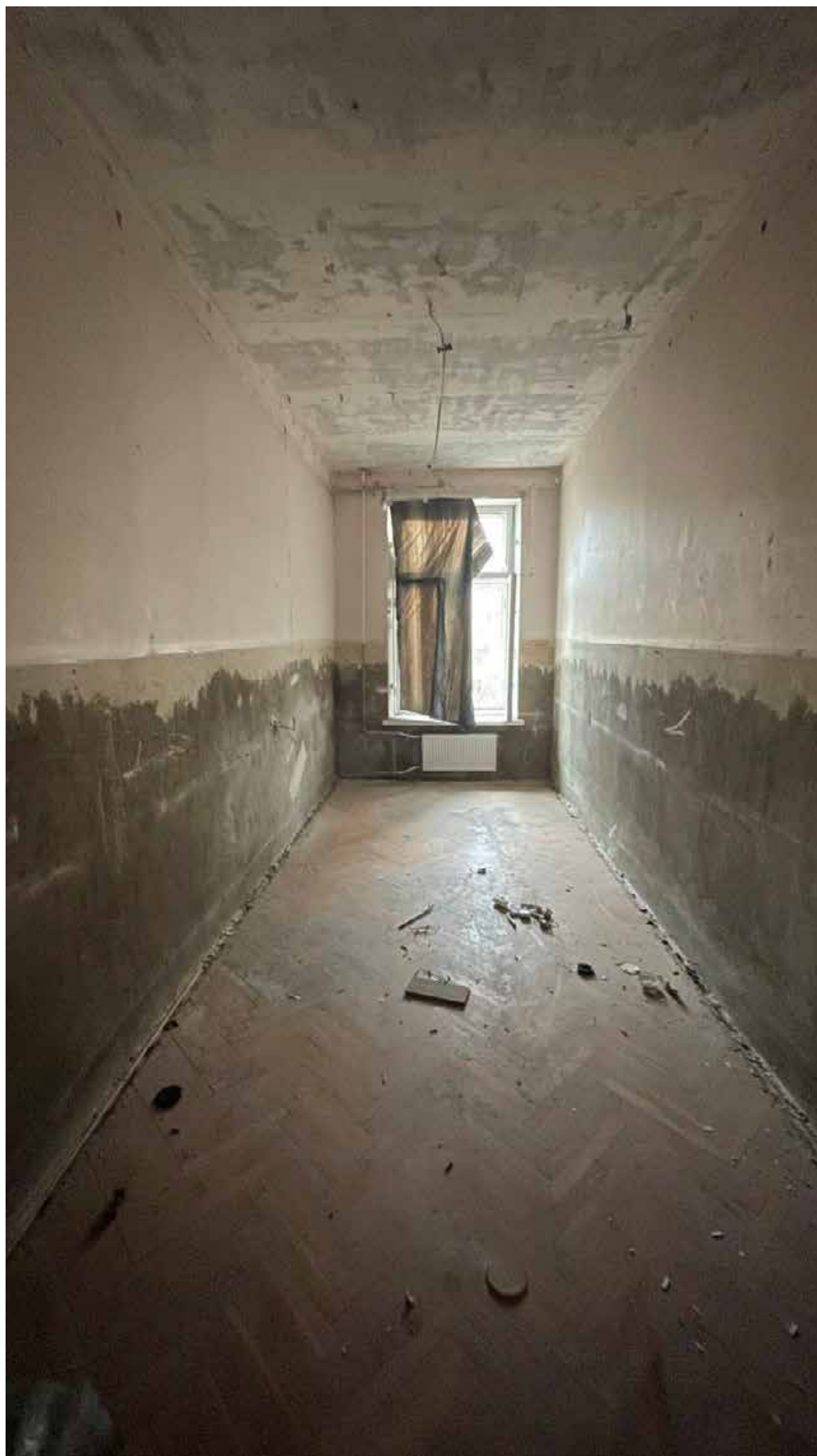
218. Фрагмент интерьера офисного помещения (помещение №3.7);
