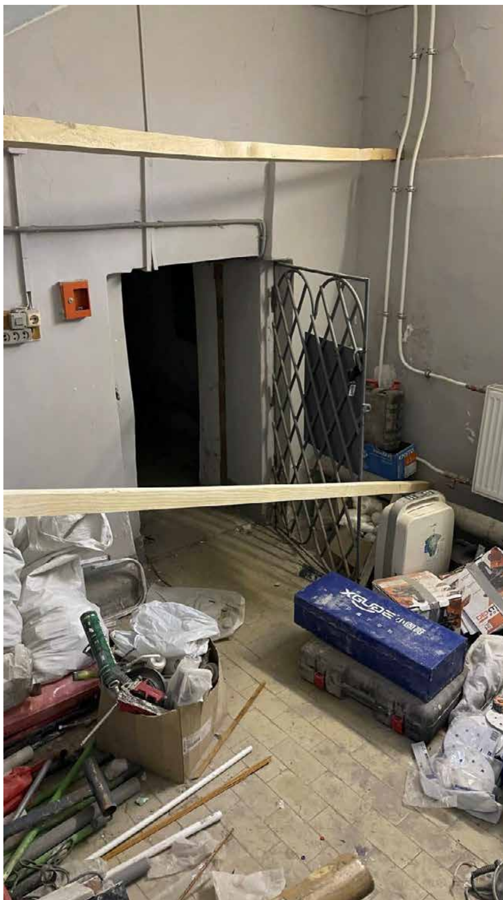
86. Вид на вход в подвал;
