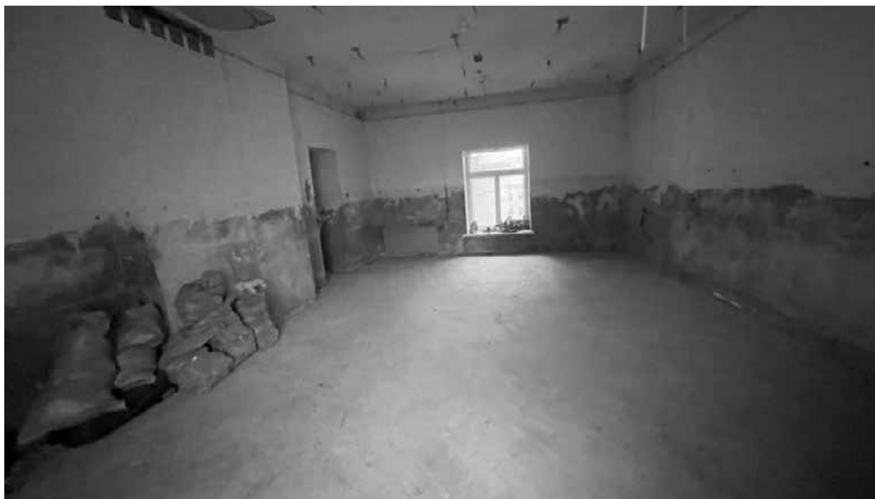
248. Фрагмент интерьера офисного помещения на третьем этаже;
