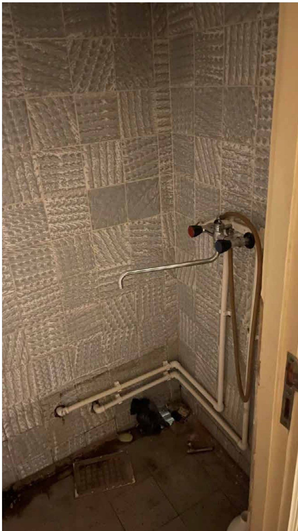
69.Фрагмент интерьера душевой;
