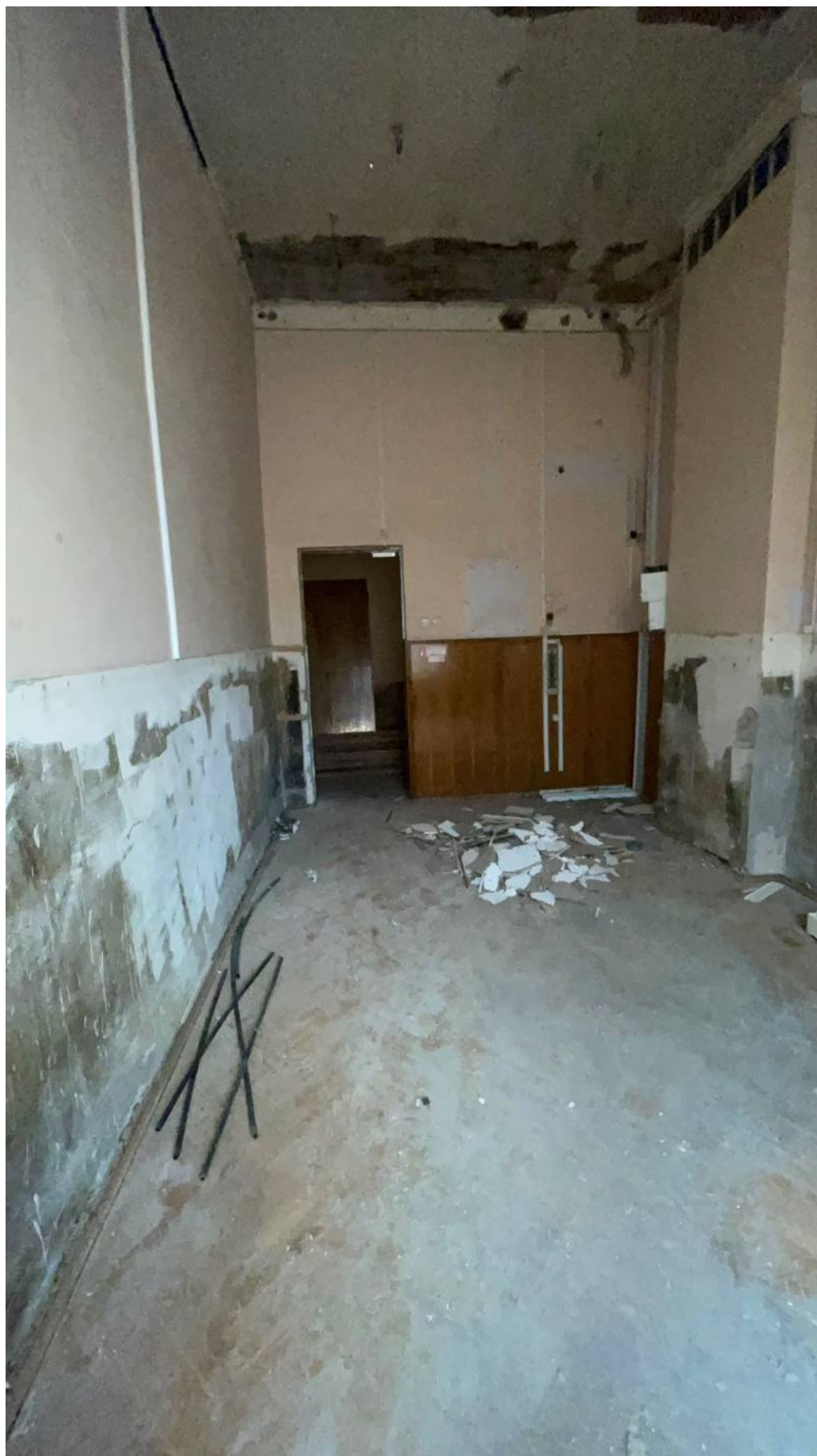
148. Фрагмент офисного помещения;
