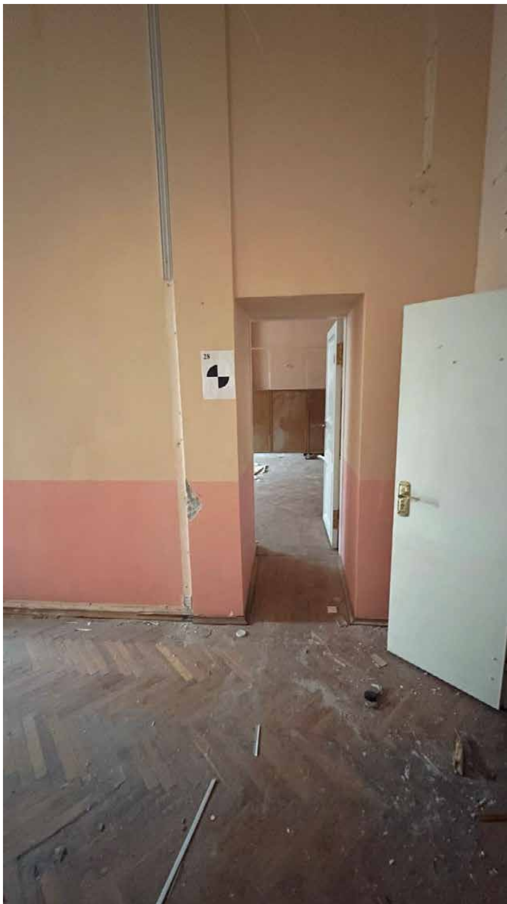
189. Фрагмент интерьера коридора на втором этаже;
