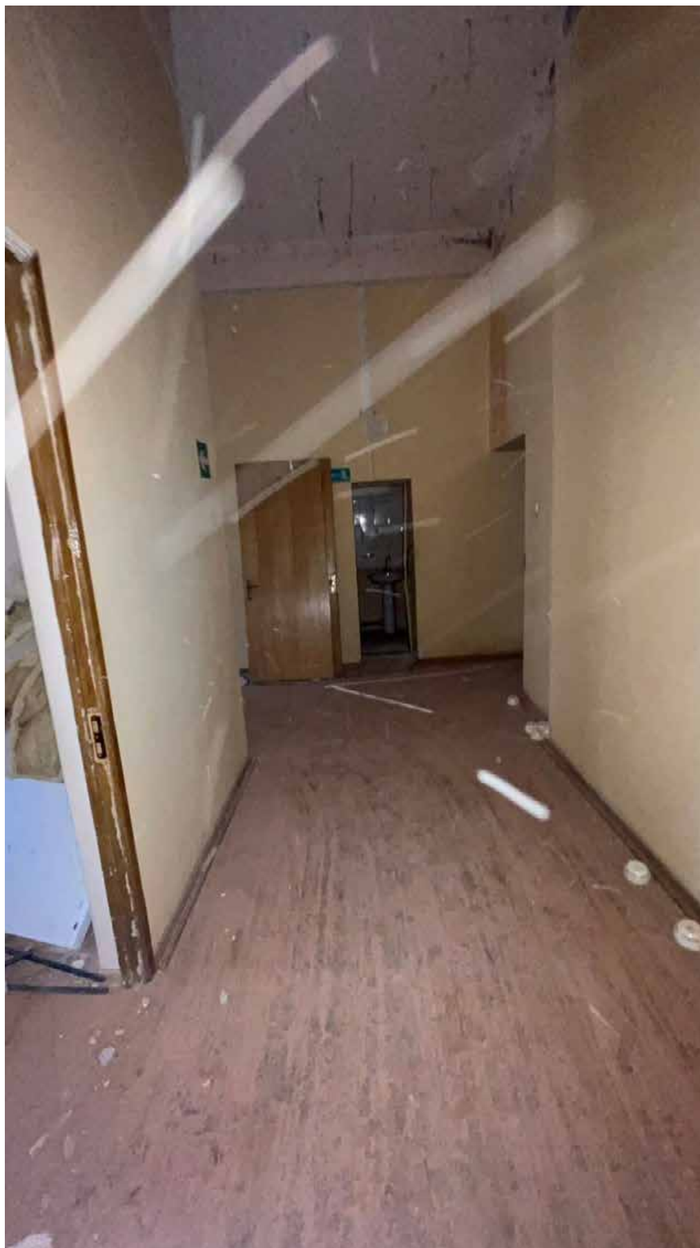
167. Фрагмент интерьера коридора на втором этаже;
