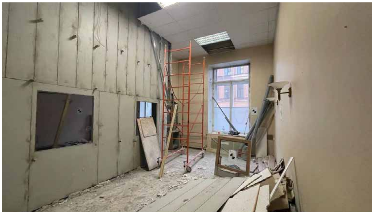
58.Фрагмент интерьера холла (помещение №1.42);
