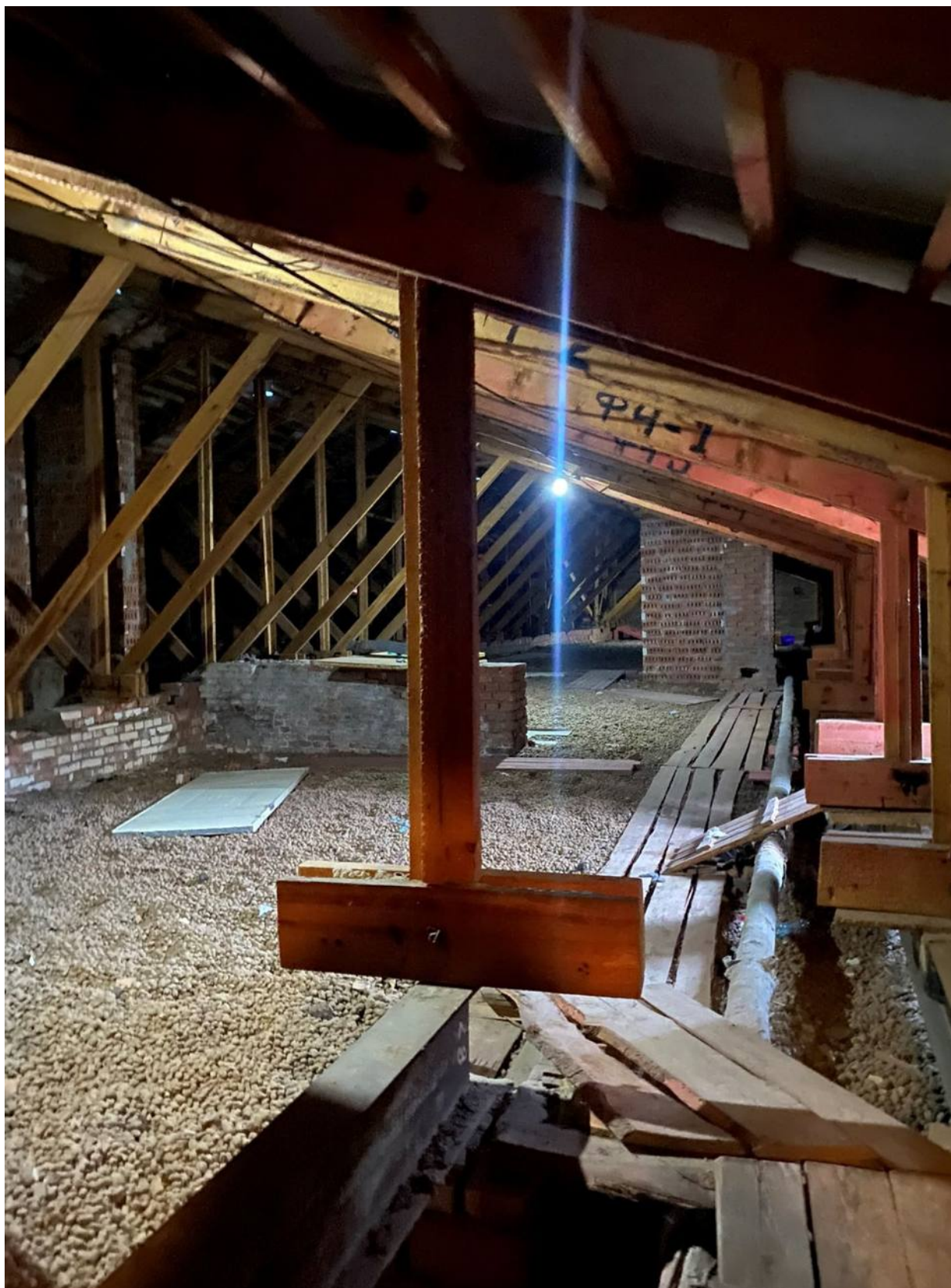
260. Фрагмент интерьера чердака;
