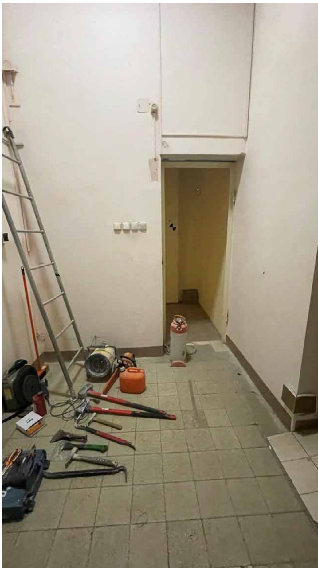
79. Помещение холла №1 (помещение №1.16);
