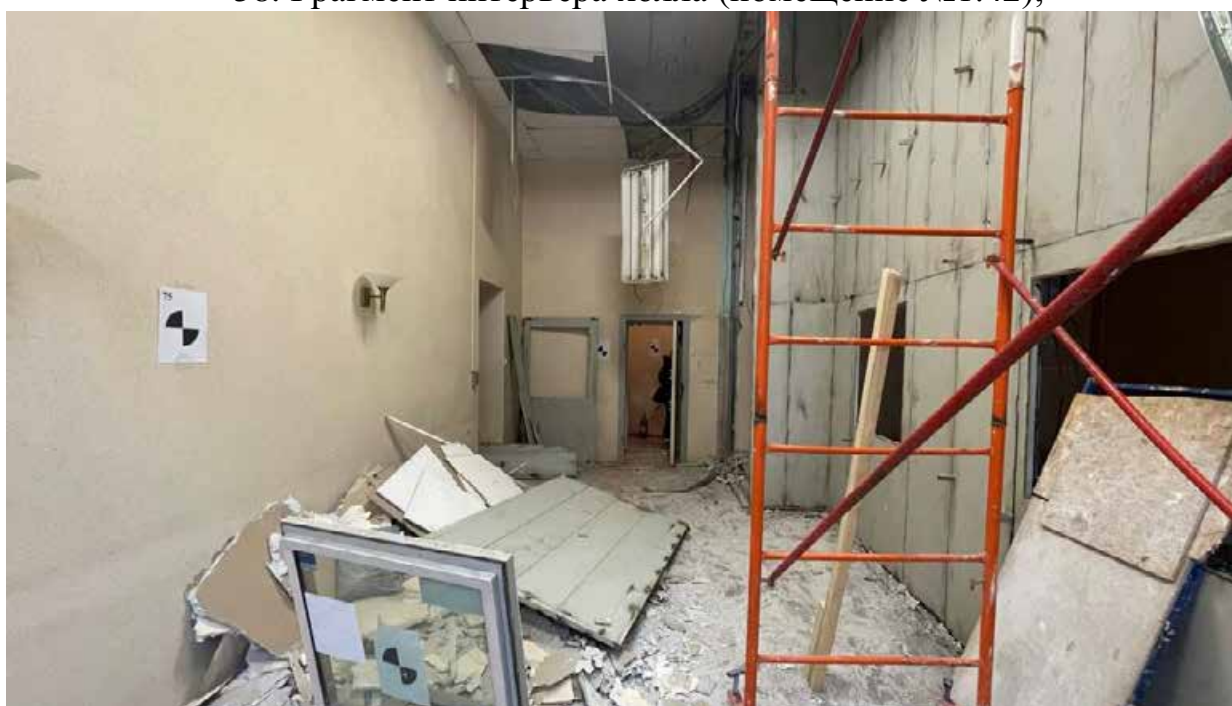
59.Фрагмент интерьера холла (помещение №1.42);
