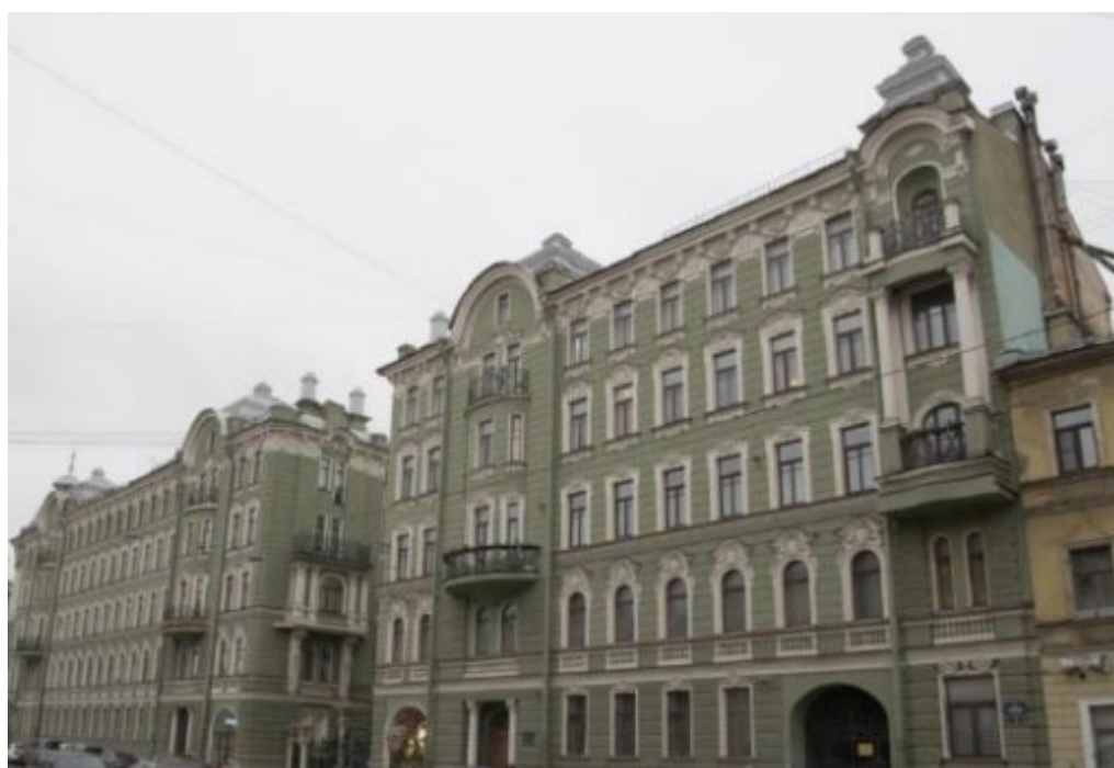
2. Лицевой фасад по ул. Ленина.
