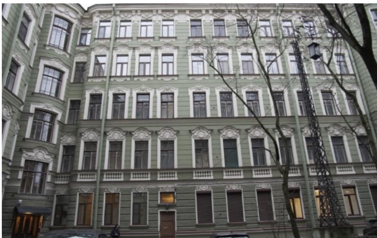
8. Фрагмент северо-восточного фасада двора-курдонера с окнами кв.№34
