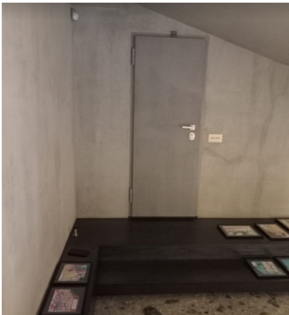
6. Фрагмент перекрытия и дверной проем.
