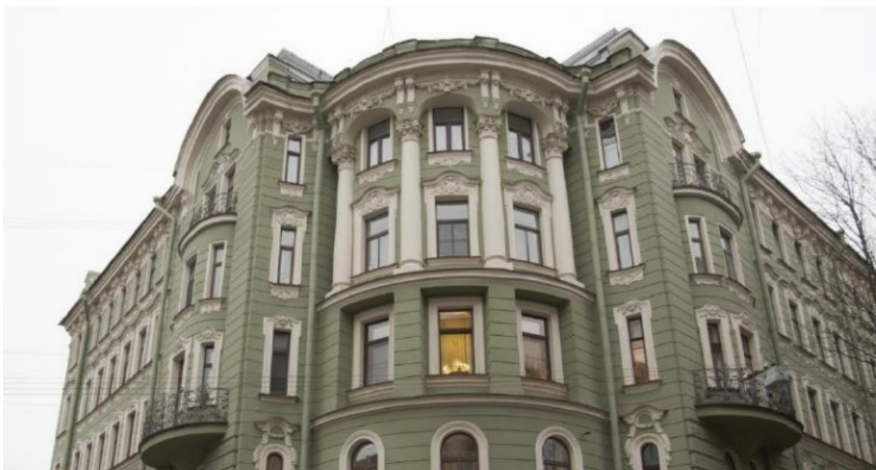
9. Фрагмент лицевого фасада по Пушкарскому переулку (центральная часть).
