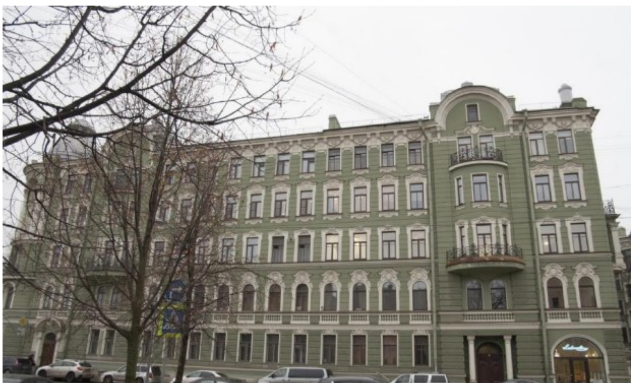
4. Лицевой фасад по ул. Ленина. Фрагмент. Левая часть фасада
