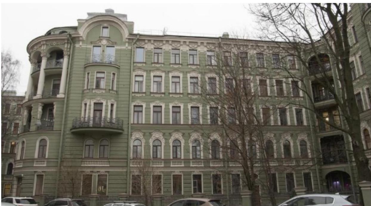
10. Фрагмент лицевого фасада по Пушкарскому переулку
