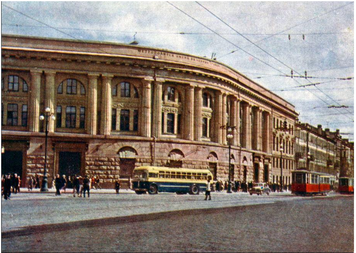
15. Наземный вестибюль станции метро «Технологический институт». Фотография из комплекта открыток «Ленинградский метрополитен им. В. И. Ленина». Фото Б. Уткина и Л. Зиверта. 1956 г.
