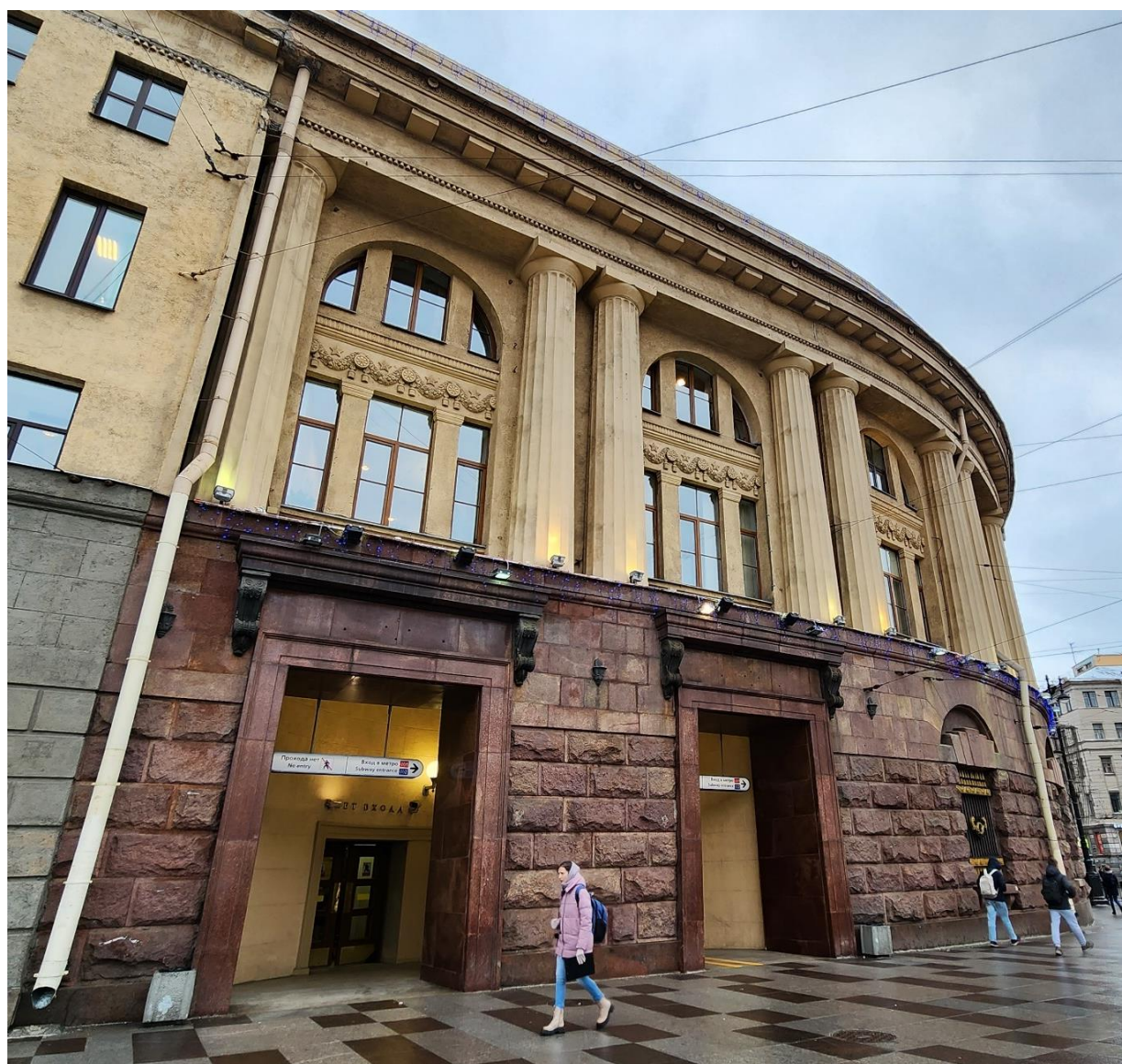
Фото 2. Фасад со стороны Загородного пр.
