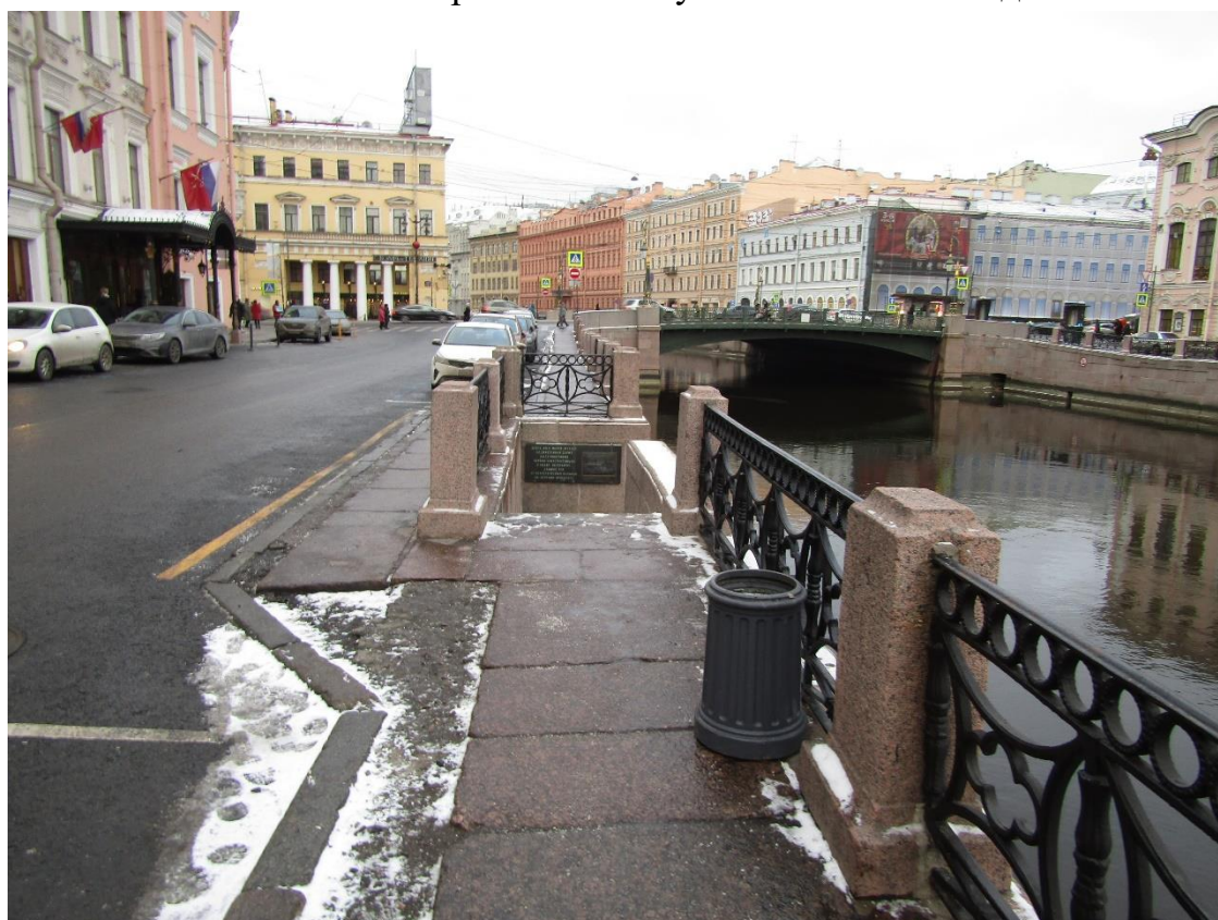
Фото 12. Вид на спуск № 9 объекта культурного наследия федерального значения «Набережные со спусками» с юга.
