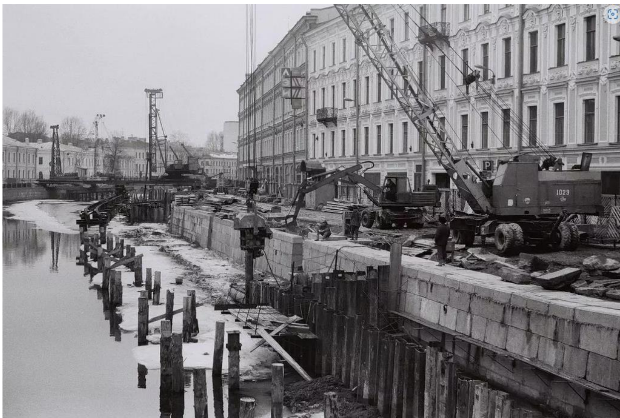
Илл. 22. Ремонт набережной реки Мойки. 1988 г. (источник: https://pastvu.com/p/129828 ).
