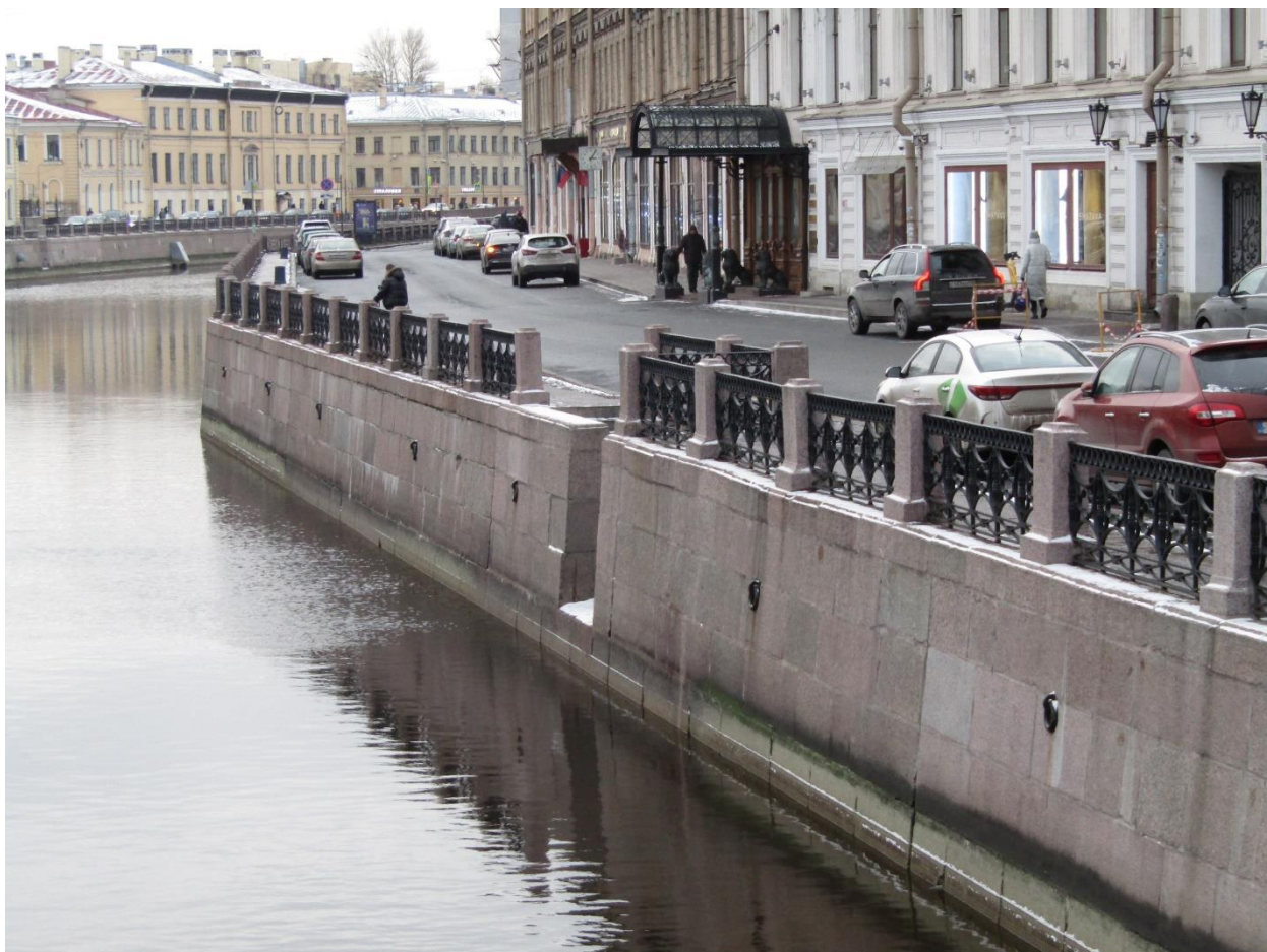
Фото 3. Вид на подпорную стенку набережной и спуск № 9 объекта культурного наследия федерального значения «Набережные со спусками» с Зеленого моста.
