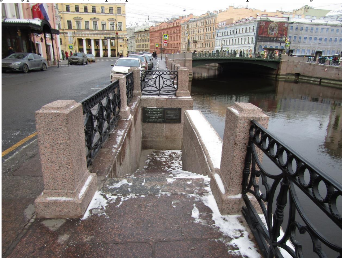
Фото 9. Вид на спуск № 9 объекта культурного наследия федерального значения «Набережные со спусками» с юга.
