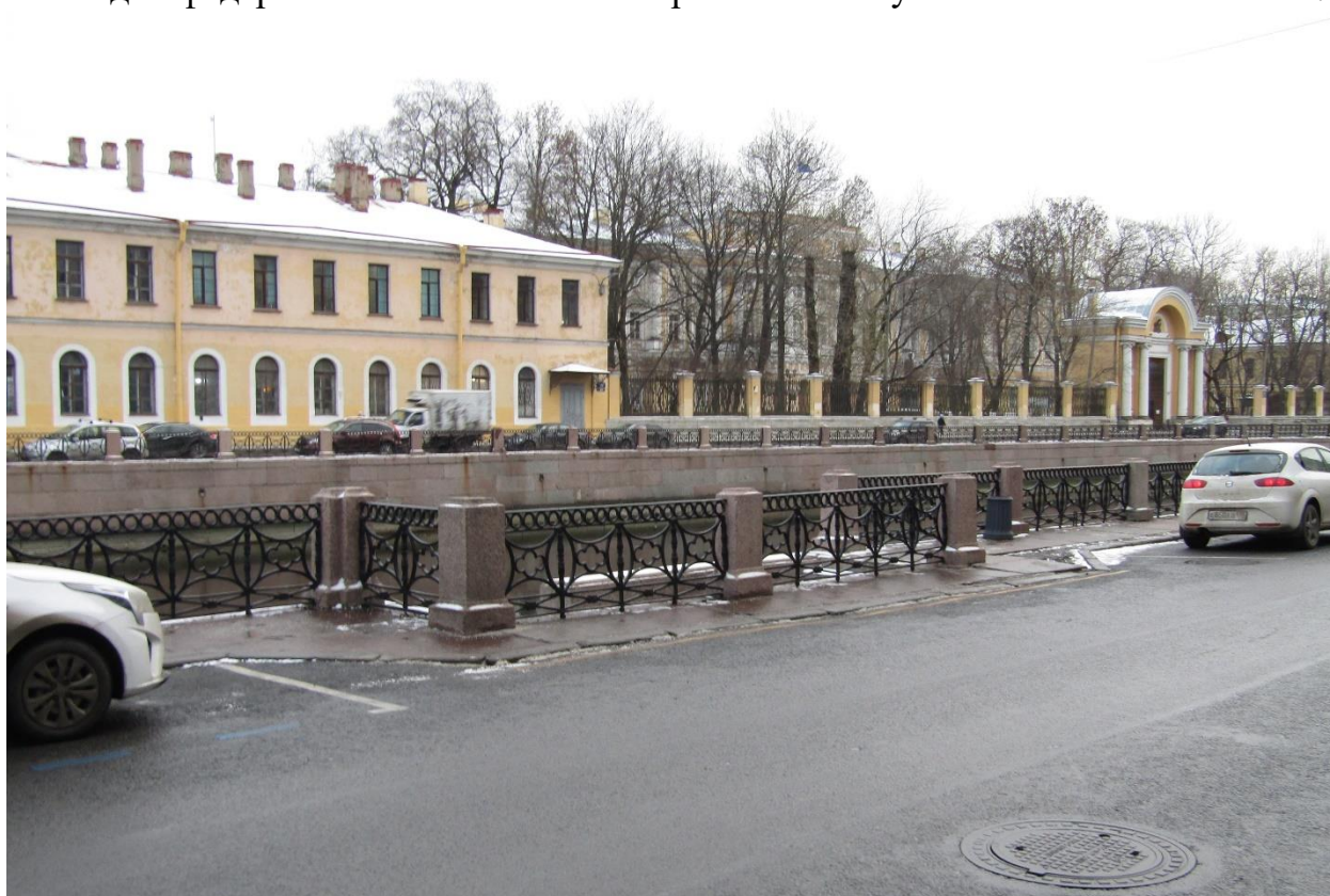
Фото 4. Вид на спуск № 9 объекта культурного наследия федерального значения «Набережные со спусками» с северо-запада.
