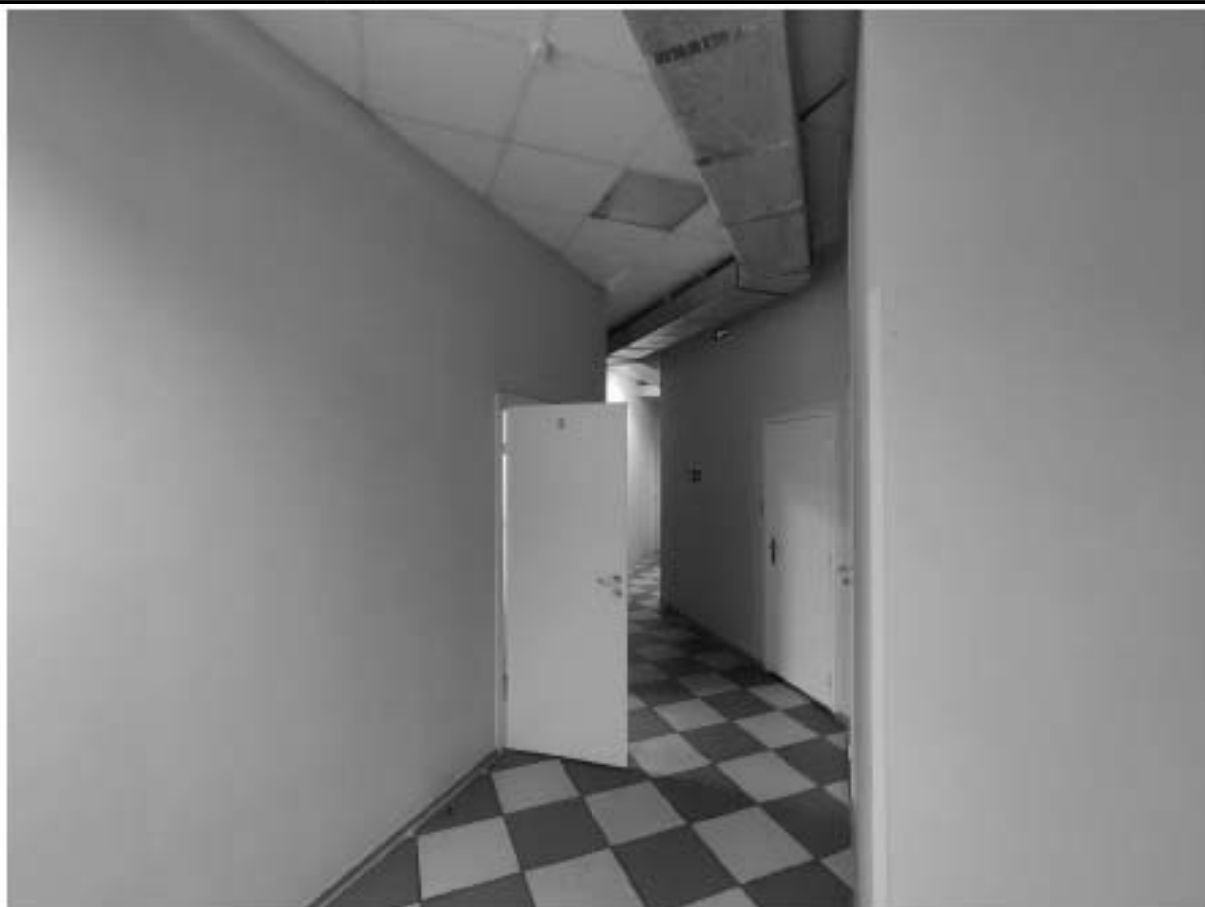
20. Фрагмент коридора (пом. 5-Н (17)).
