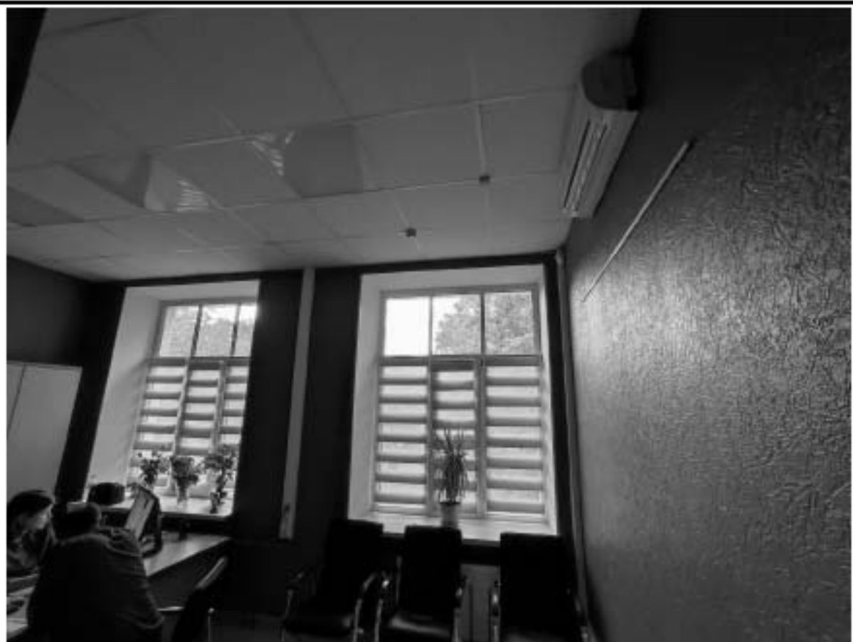
12. Общий вид пом. 5-Н (23).
