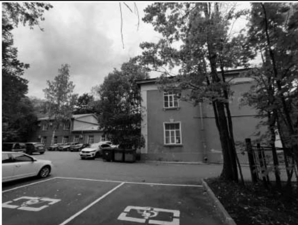
6. Общий вид торцевого фасада объекта культурного наследия регионального значения «Лазарет».
