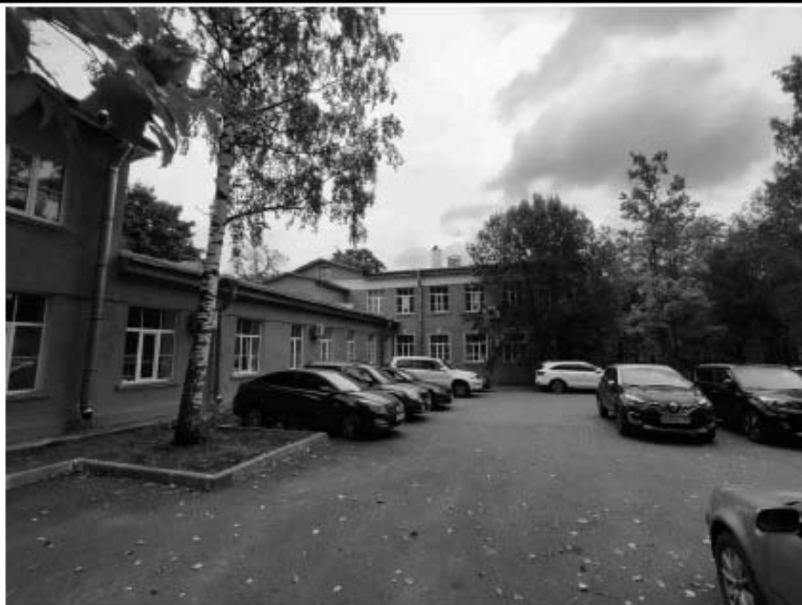
7. Фрагмент дворового фасада объекта культурного наследия регионального значения «Лазарет для офицеров».
