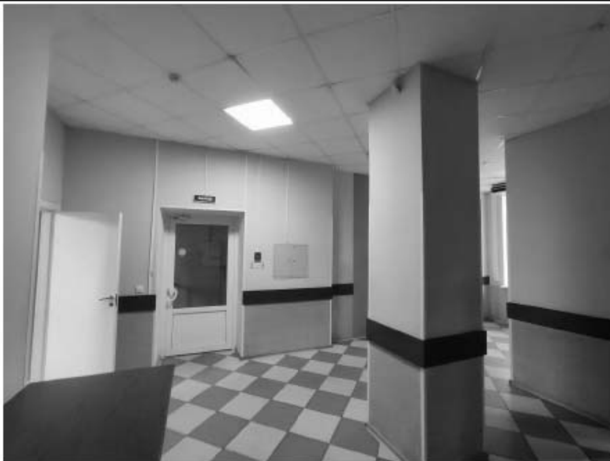
11. Общий вид пом. 5-Н (1).
