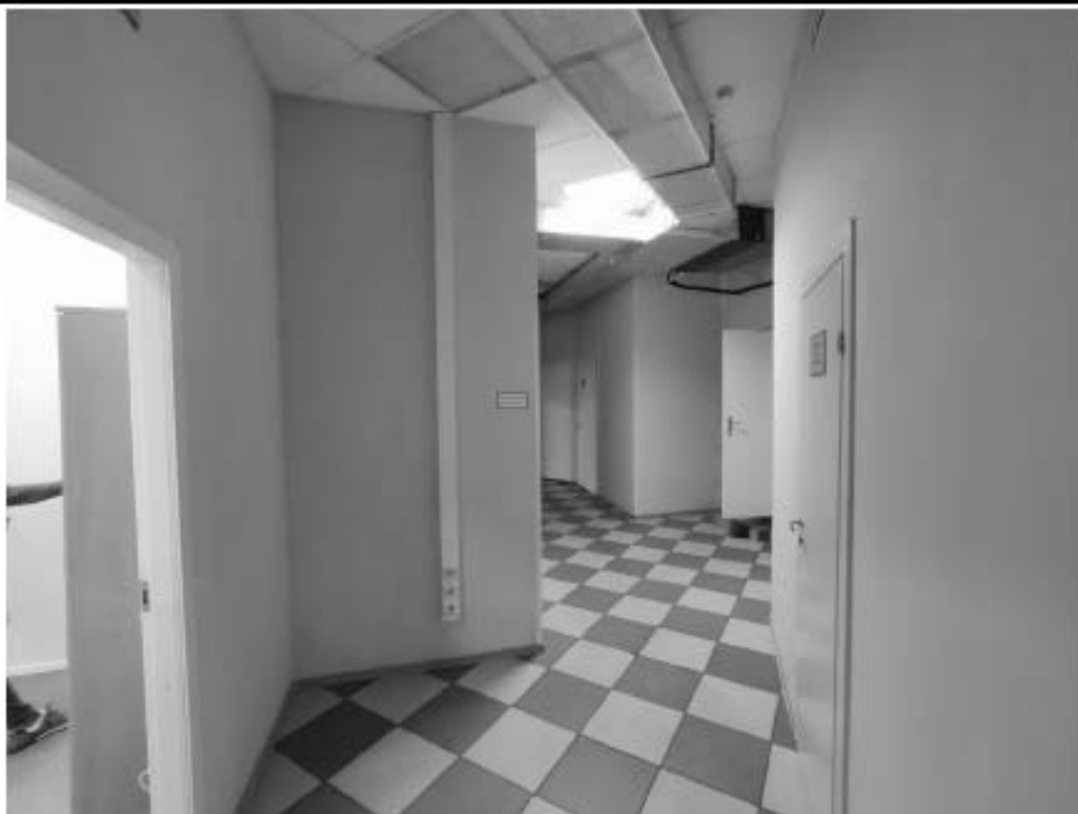
25. Фрагмент коридора (пом. 5-Н (17)).
