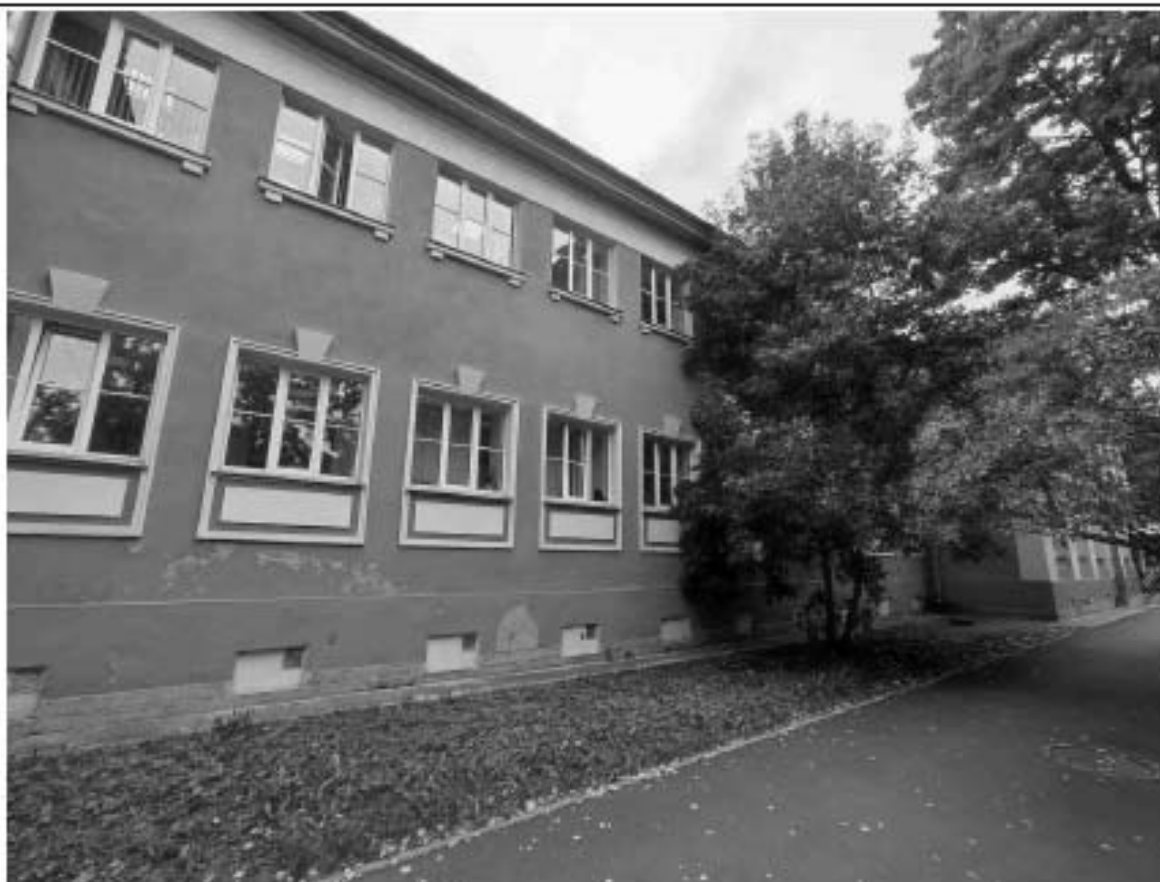
4. Фрагмент лицевого фасада по Софийскому бульвару объекта культурного наследия регионального значения «Лазарет для офицеров».
