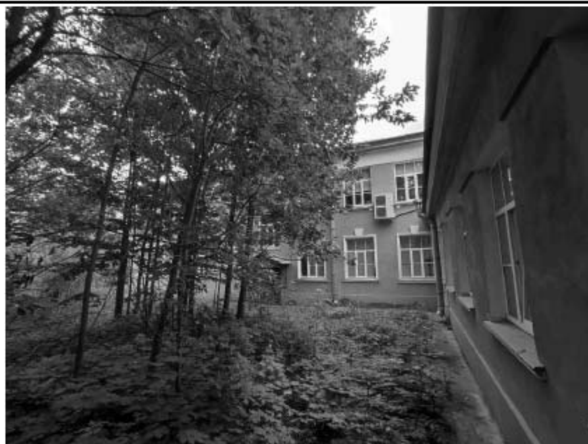
8. Фрагмент дворового фасада объекта культурного наследия регионального значения «Лазарет для офицеров».
