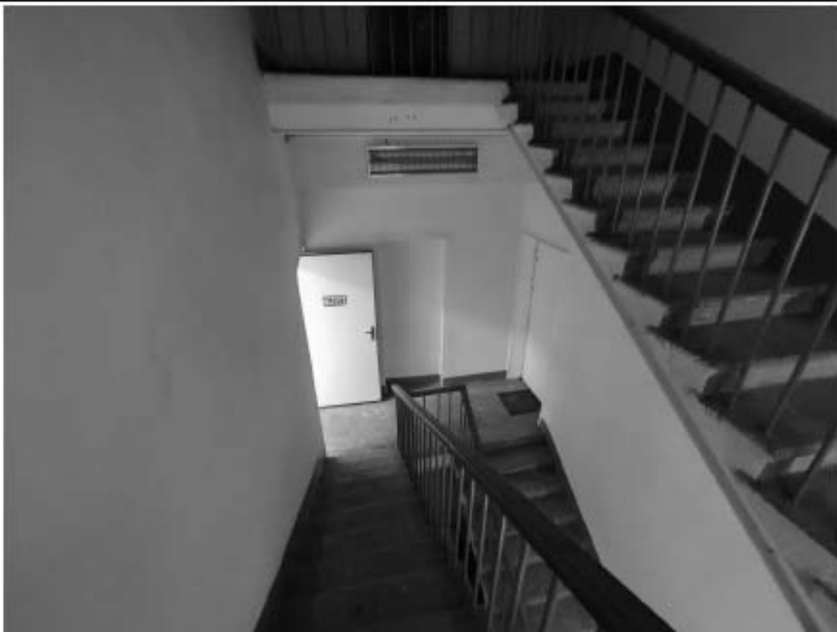
31. Общий вид площадки лестницы 1ЛК в уровне 2-го этажа.
