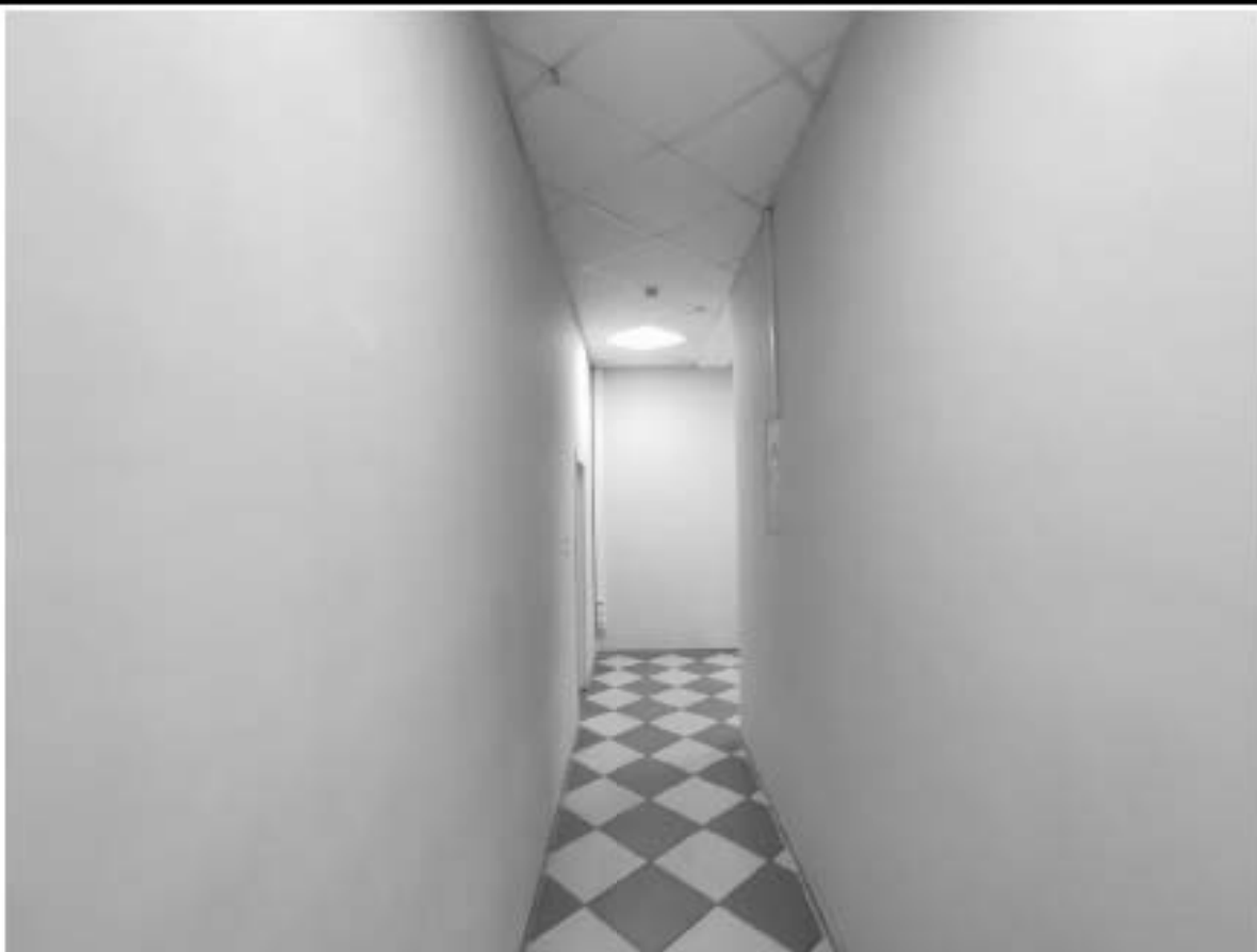
29. Фрагмент коридора (пом. 5-Н (17)).
