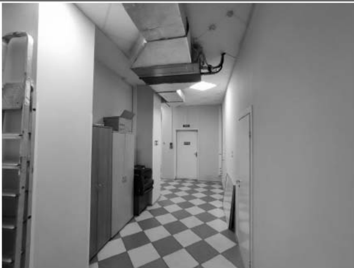
34. Фрагмент коридора (пом. 5-Н (17)).
